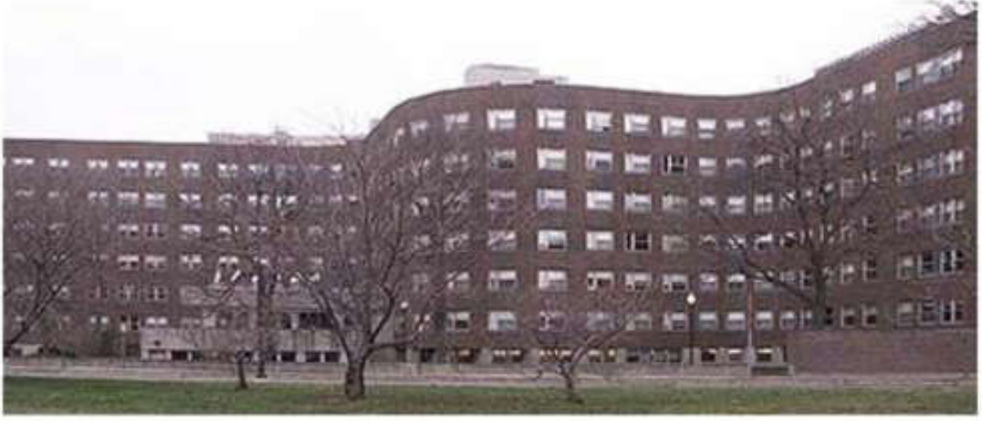
Şekil 2.86: Çizgisel Tasarım Örneği, Baker House
