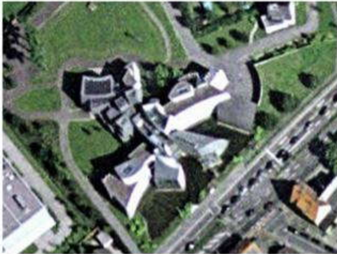
Şekil 2.92: Salkımsal Tasarım Örneği, (EMR) Communication and Technology Center
