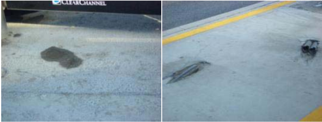
Şekil 3.19 İstasyonlarda pürüzler, ayak ve durak montaj izi ve borular Mayıs 2010
