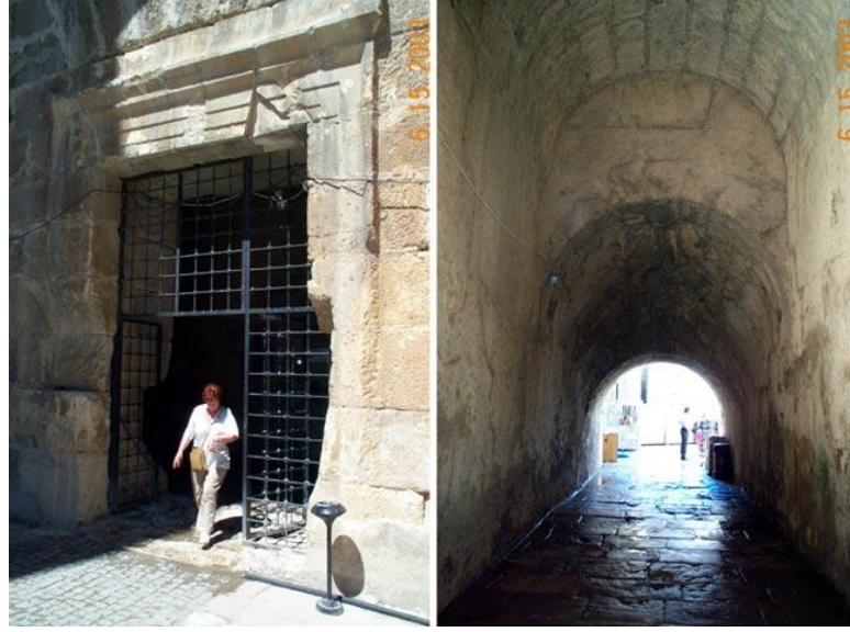
Resim 3.21 Aspendos Tiyatrosunda orkestranın iki yanında bulunan “aditus maximus”. Solda tiyatronun dışından görünüşü; sağda giriş kapısından içeriye bakış. 503
