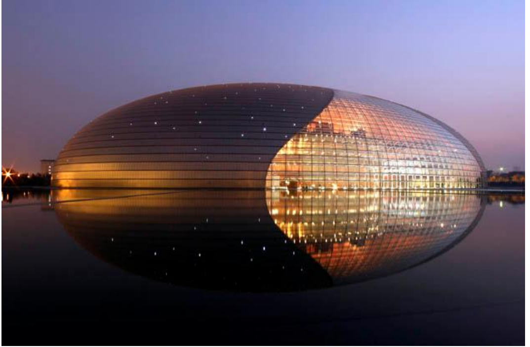
Resim 2.1 “National Grand Theatre of China” Dış görünüş. 179 Tiyatro yapısının anıtsal boyutu.
