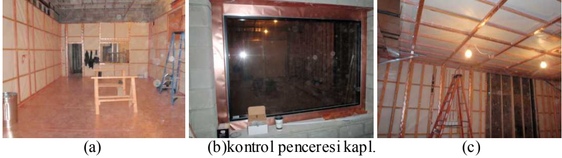
Şekil 3.36: MR (Bakır Levha) RF Kalkanı (Michigan State University VTH) 151
