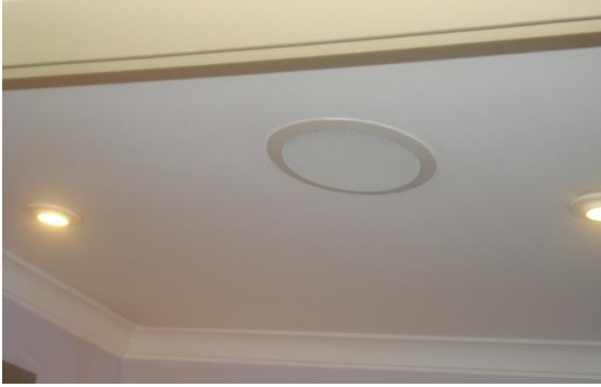
Şekil B.2. Yatak odasında kullanılan sesli anons cihazı (Sunar, 2010)
