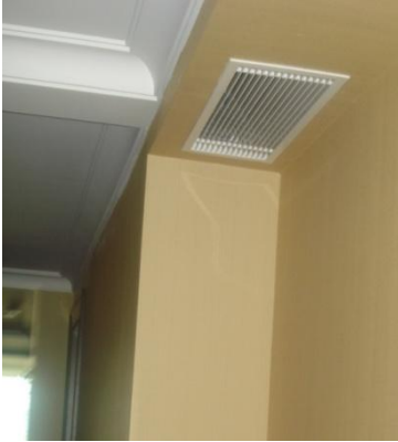
Şekil A.4. Koridorlardaki basınçlandırma elemanları (Sunar, 2010)
