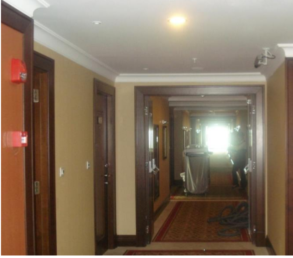
Şekil A.3. Yatak katında kullanılan ışıklı uyarı ve yangın ihbar butonları (Sunar, 2010)
