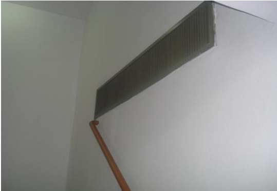
Şekil B.3. Yangın merdivenleri basınçlandırma (Sunar, 2010)
