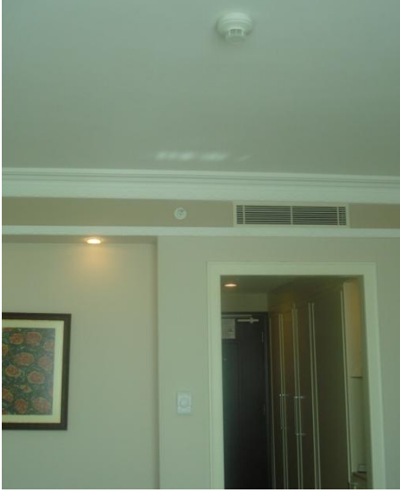
Şekil A.1. Odalarda kullanılan optik duman dedektörü (Sunar, 2010)
