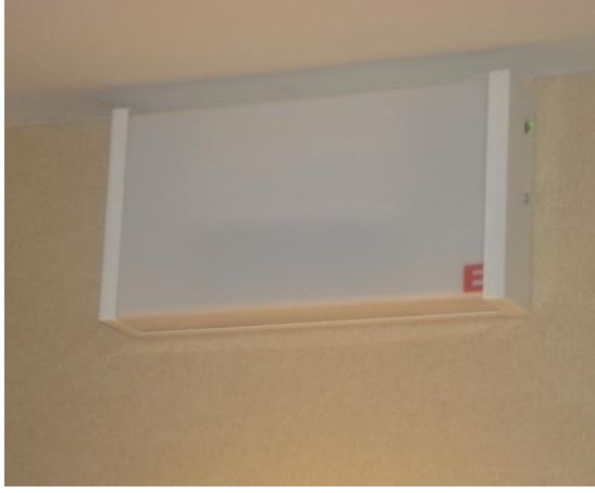
Şekil B.8. Koridorlarda kesintide yanan acil durum armatürü (Sunar, 2010)
