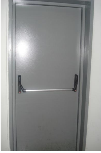
Şekil 3.33. Yangın kapısı ve bileşenleri (Sunar, 2010)
