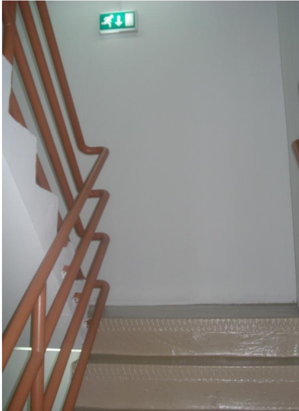
Şekil B.5. Yangın merdivenleri (Sunar, 2010)
