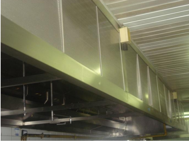
Şekil B.11. Mutfakta kullanılan gaz dedektörü (Sunar, 2010)
