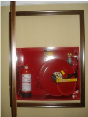
Şekil A.5. Yangın dolabı (Sunar, 2010)
