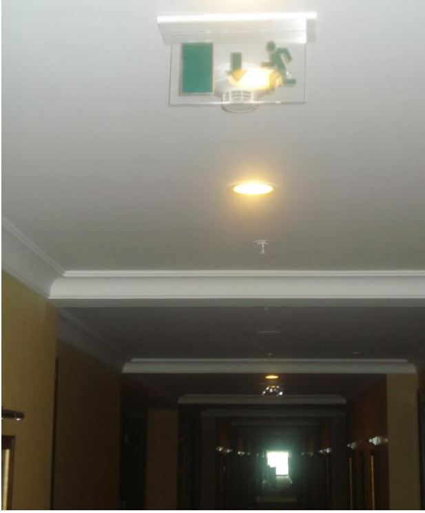
Şekil A.10. Yatak katında kullanılan yönlendirme işaretleri (Sunar, 2010)
