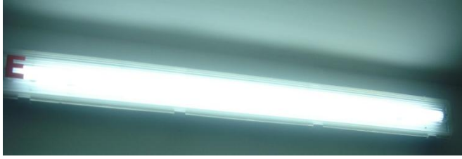
Şekil B.9. Yangın merdivenlerinde kullanılan sürekli yanan acil durum armatürü (Sunar, 2010)
