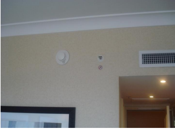
Şekil B.1. Yatak odasında kullanılan optik duman dedektörü ve sprinkler (Sunar, 2010)
