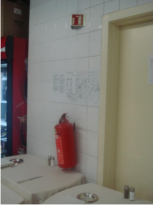
Şekil B.14. Mutfakta kullanılan taşınabilir söndürücüler(Sunar, 2010)
