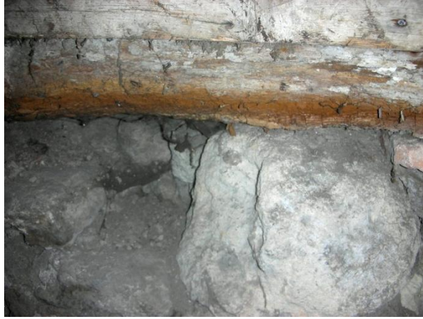
Resim A.2 Nem ve böceklenmeye bağlı olarak çürümüş bir taş duvar hatılı (Fotograf: Dışkaya)
