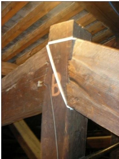
Resim 4.25 Palazzo Vecchio çatı (Fotograf: Dışkaya)
