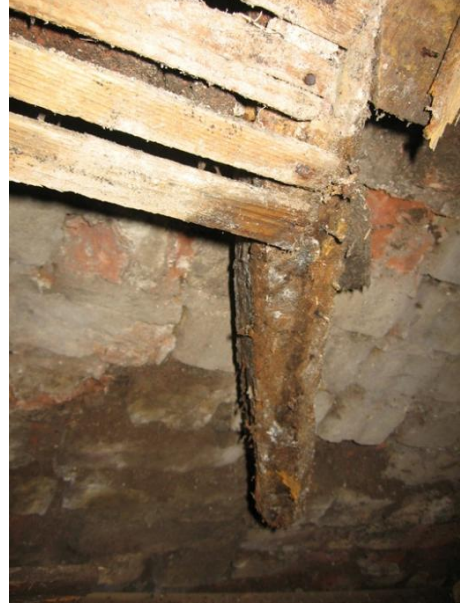
Resim A.12 a, b, Dikme tabanında nem etkisi ile oluşan çürüme ve böceklenme (Foto: Kurultay)
