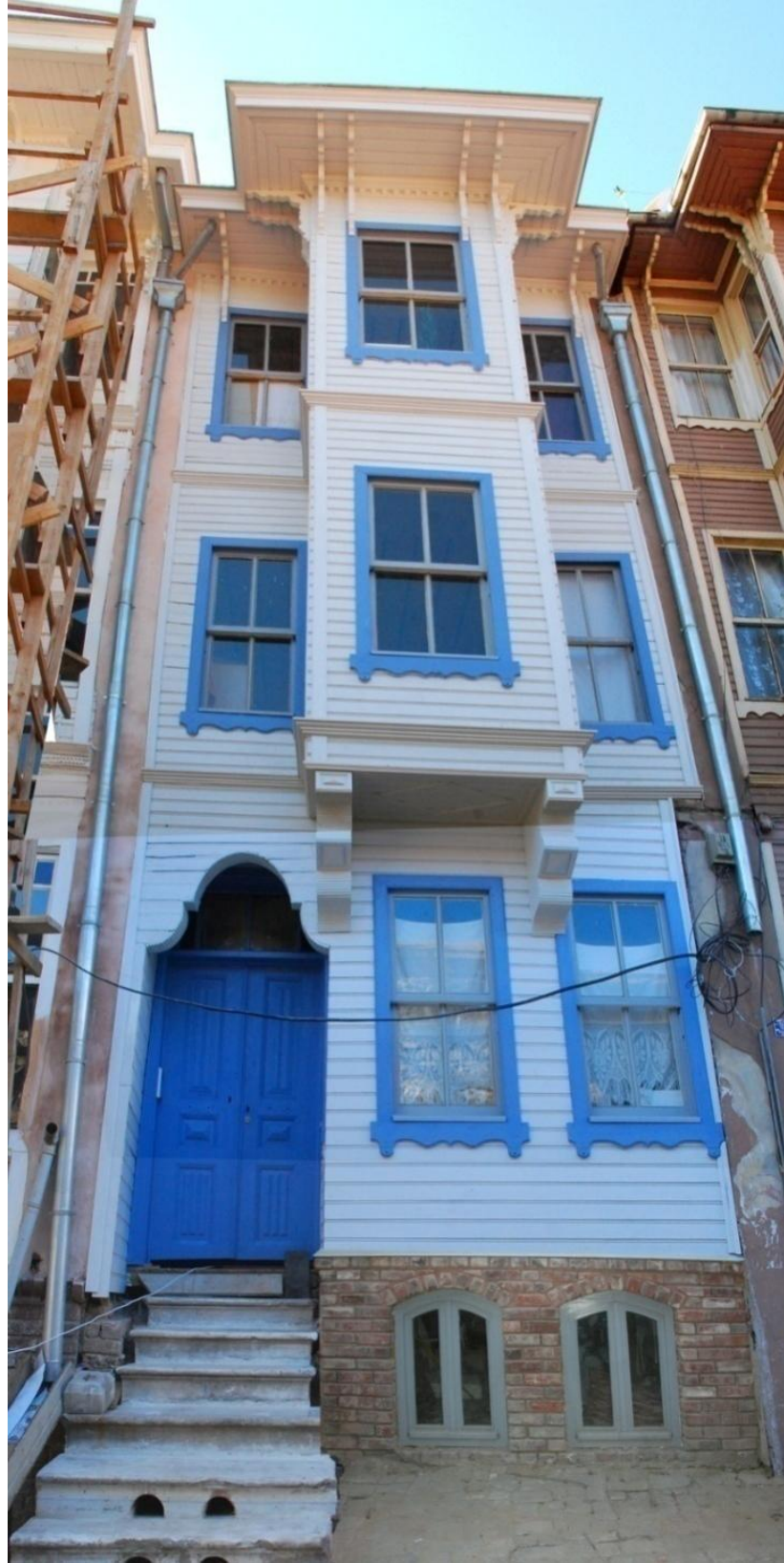
Resim 5. 2 Demirtaş Mahallesi 13 Numarada Yer Alan Yapı (Fotograf: Dışkaya)
