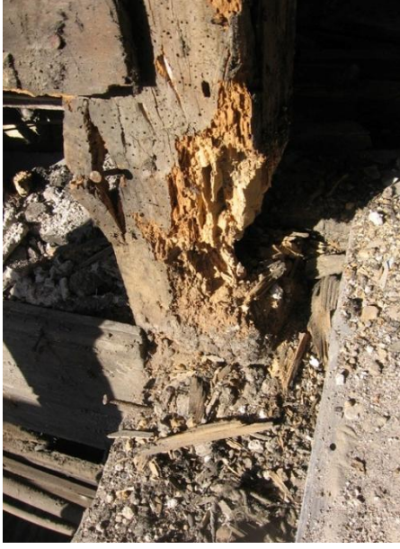
Resim A.12 a, b, Dikme tabanında nem etkisi ile oluşan çürüme ve böceklenme (Foto: Kurultay)
