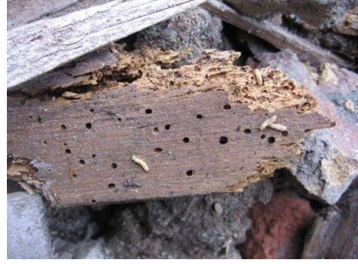
Resim B.7 Anobium Punctatum (mobilya bir böceği) uçma delikleri ve larvaları (Fotograf: Kurultay)
