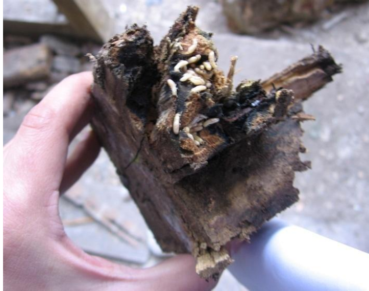
Resim B.8 Nem ve ısı etkisi ile böceklenmiş bir taşıyıcıda larvalar (Fotograf: Kurultay)
