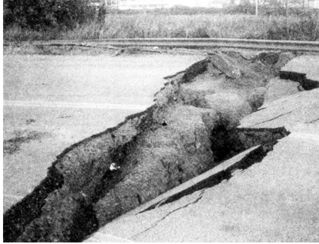
Resim 3.1 Sapanca'da TEM yolu üzerindeki fay çatlakları (Taymaz, 1999)
