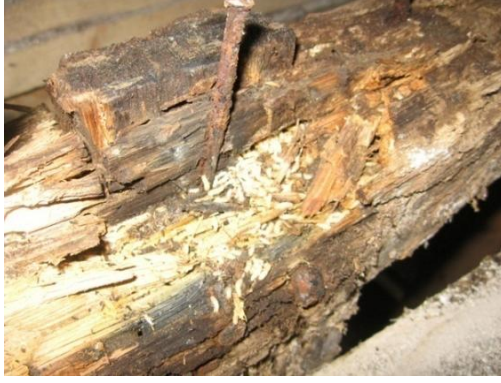
Resim B.6 Larva istilasına uğramış ahşap dikme (Fotograf: Kurultay)
