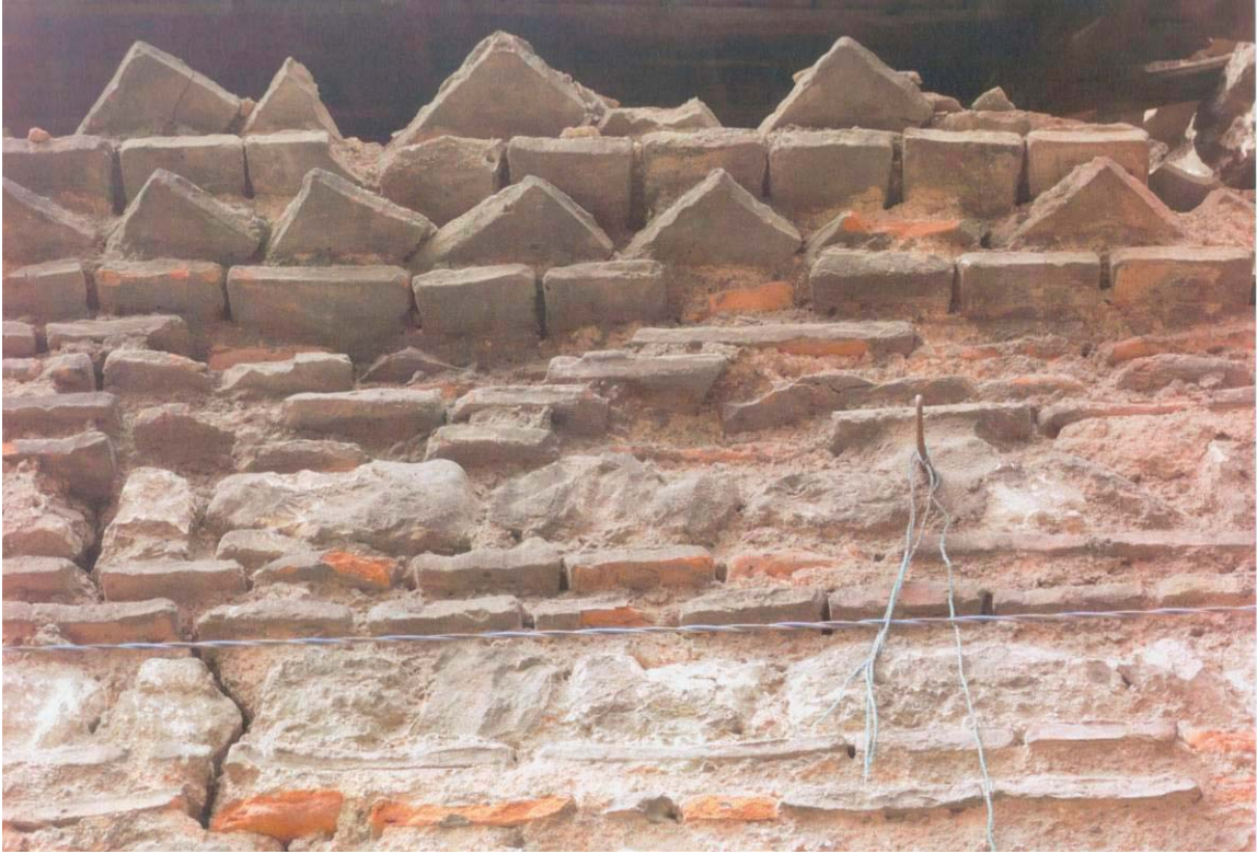
Foto C.40 Cerrahbaşı İshak Kazgani Sadi Sıbyan Mektebi Kubbesinde Kirpi Saçak
