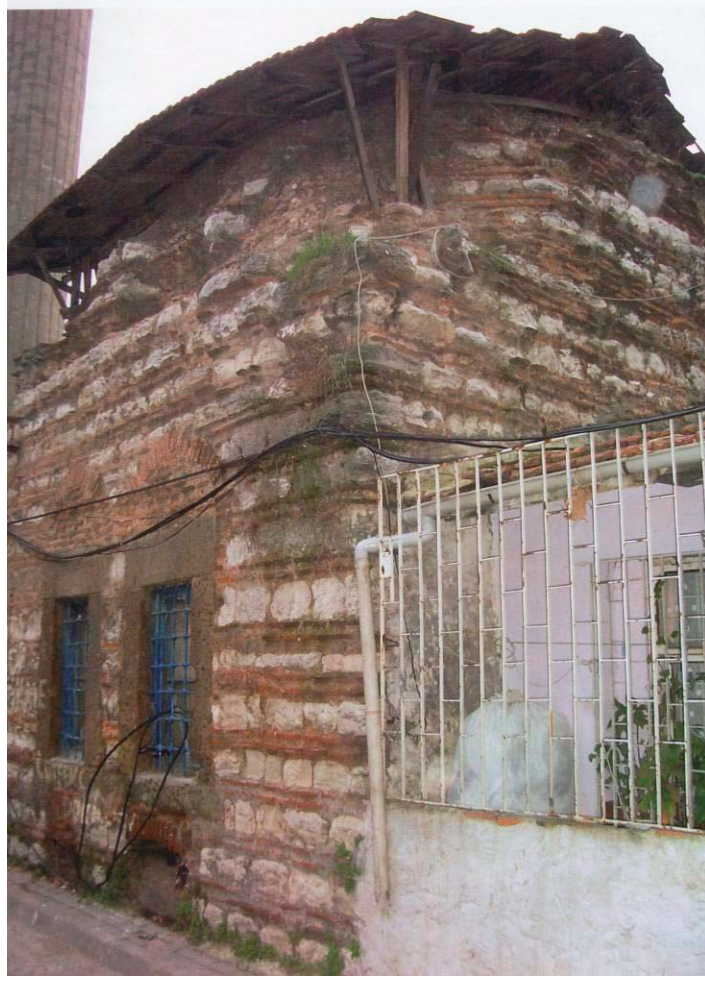
Foto C.23 Cerrahbaşı İshak Kazgani Sadi Sıbyan Mektebi Kuzey-Batı Cephesi
