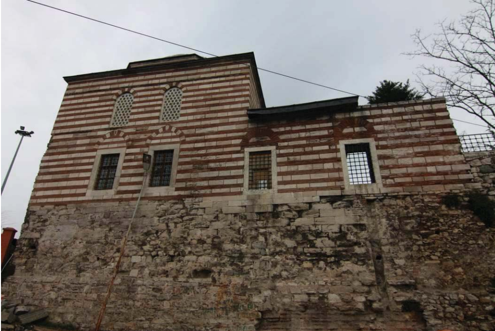
Foto 5.91 Yavuz Sultan Selim Sıbyan Mektebi Batı Cephesi
