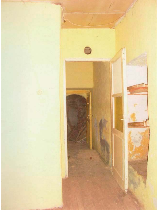
Foto C.7 Cerrahbaşı İshak Kazgani Sadi Sıbyan Mektebi Zemin Kat Muhdes Bölme Duvarı
