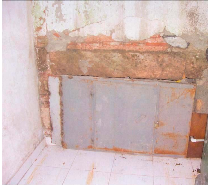
Foto C.20 Cerrahbaşı İshak Kazgani Sadi Sıbyan Mektebi Bodrum Kat Penceresinde Demir Kapak
