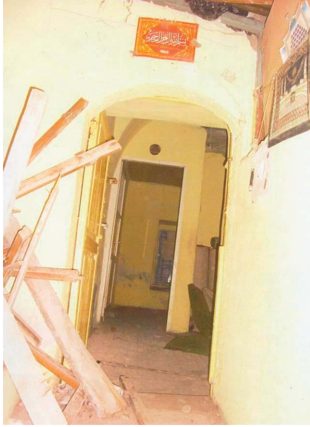
Foto C.17 Cerrahbaşı İshak Kazgani Sadi Sıbyan Mektebi Güney-Batı Cephesi Zemin Kat Giriş Kapısı
