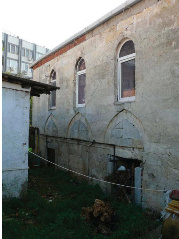
Foto 5.107 Piri Mehmet Paşa Sıbyan Mektebi Kuzeydoğu Cephesi
