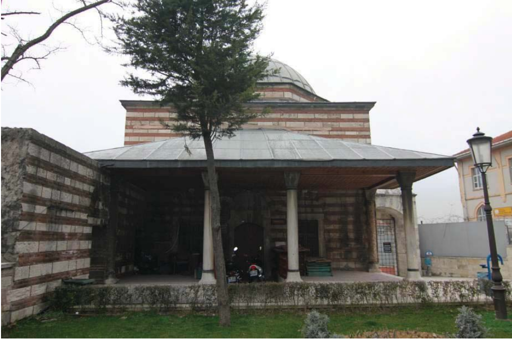
Foto 5.90 Yavuz Sultan Selim Sıbyan Mektebi Ön Görünüşü (Güney Cephesi)
