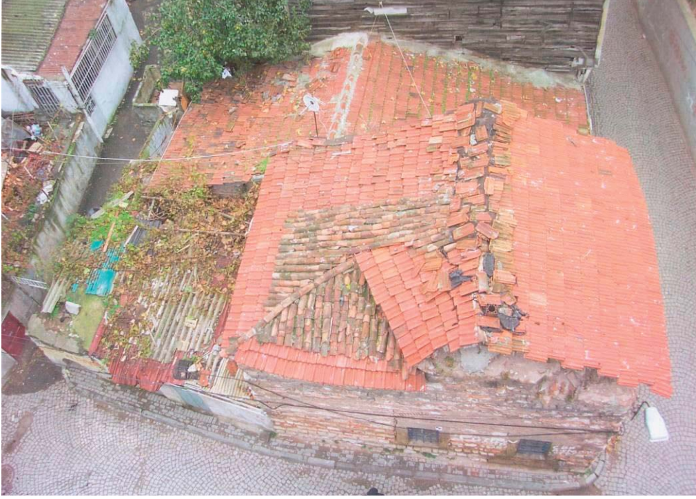
Foto C.37 Cerrahbaşı İshak Kazgani Sadi Sıbyan Mektebi ve Çeşmesi Çatısı
