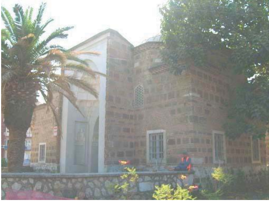
Foto 5.44 Hafsa Sultan Sibyan Mektebi Görünüŧü
