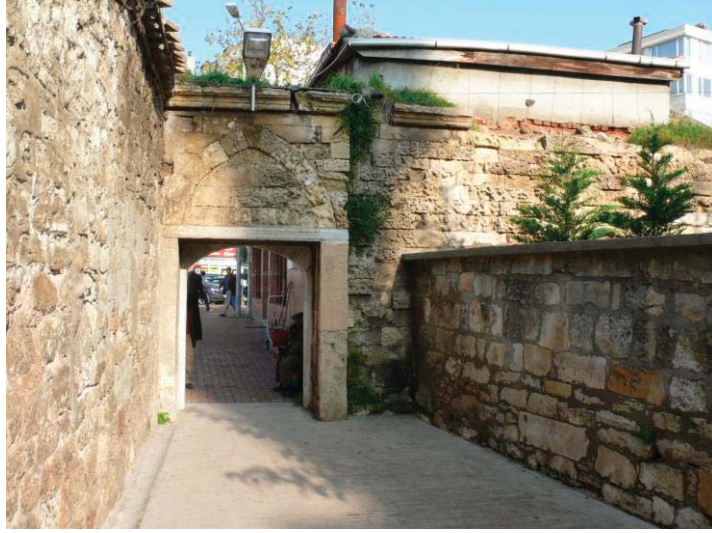
Foto 5.111 Piri Mehmet Paşa Külliyesi Kapısı
