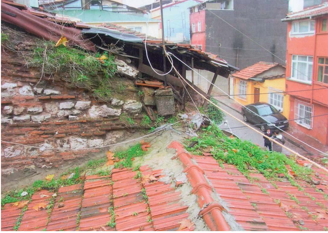
Foto C.41 Cerrahbaşı İshak Kazgani Sadi Sıbyan Mektebinin Çatısında Bitkilenme ve Bozulmalar
