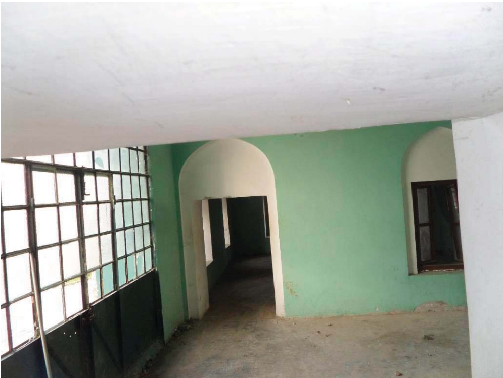
Foto 5.19 Sitti Hatun Sıbyan Mektebi Derslikler Arası Geçiş Kapısı
