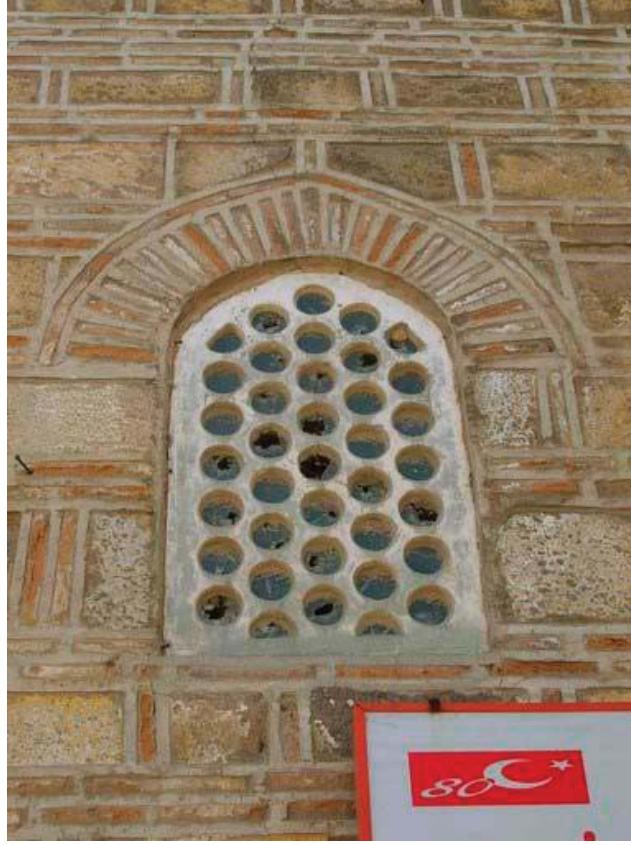
Foto 5.48 Hafsa Sultan Sıbyan Mektebi Tepe Pencereleeri
