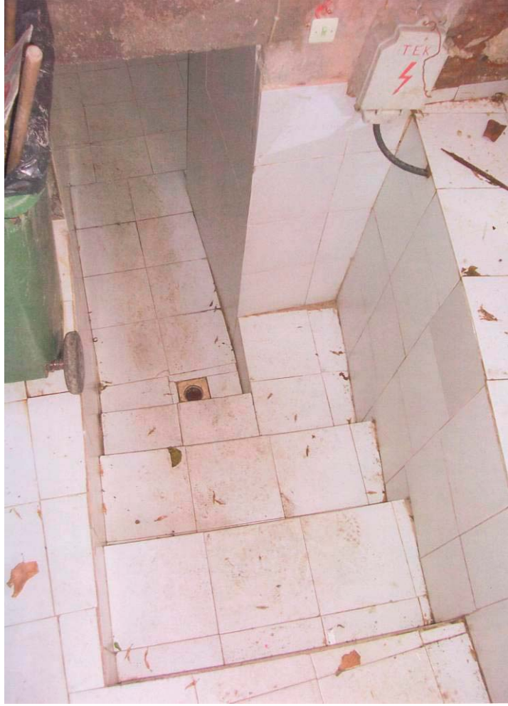
Foto C.19 Cerrahbaşı İshak Kazgani Sadi Sıbyan Mektebi Bodrum Kat Muhdes Giriş Kapısı
