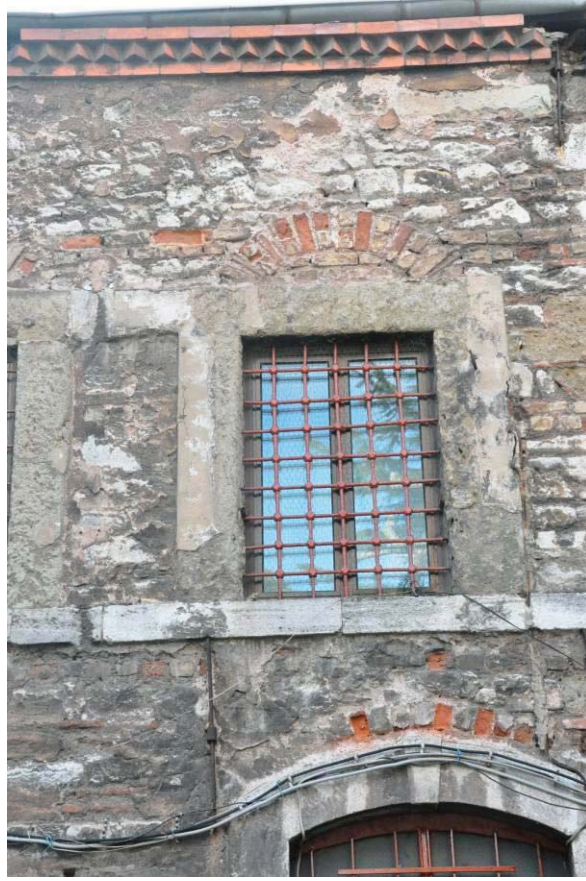
Foto 5.65 Atik Ali Paşa Sıbyan Mektebi Yan Cephe Penceresi ve Kirpi Saçaklar
