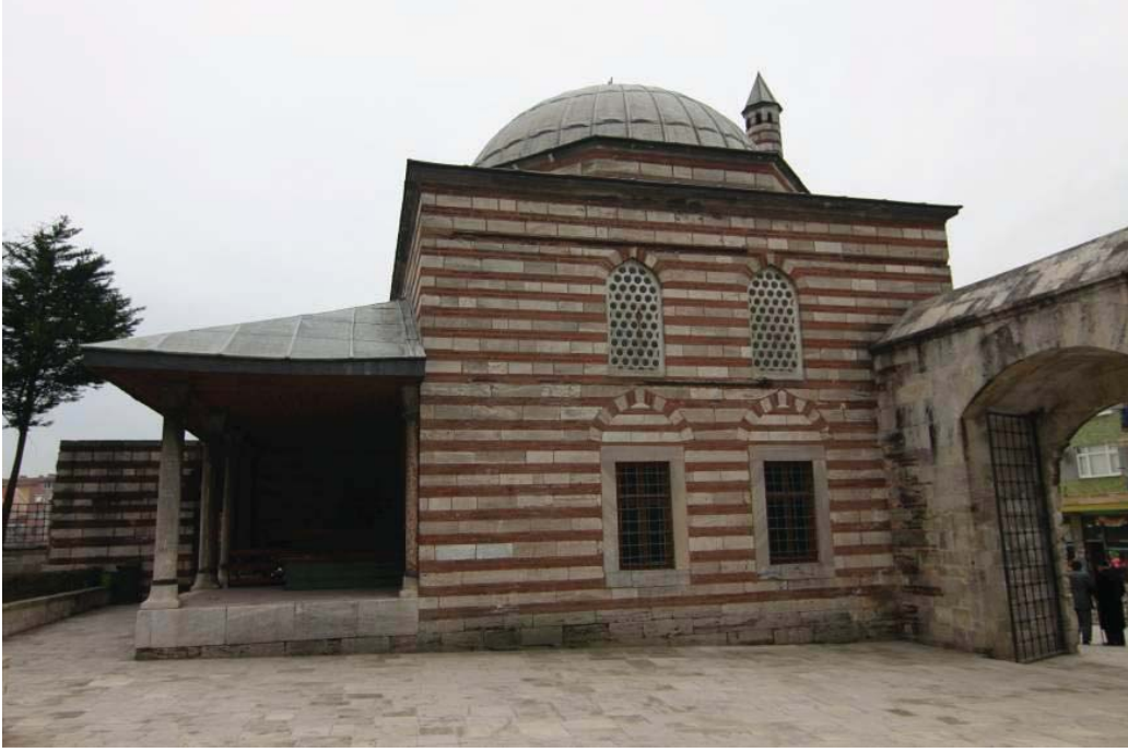
Foto 3.18 Yavuz Sultan Selim Külliyesi Sıbyan Mektebi
