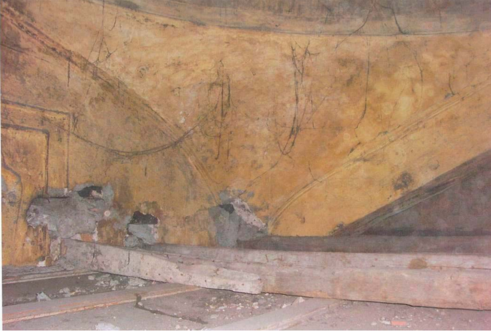
Foto C.38 Cerrahbaşı İshak Kazgani Sadi Sıbyan Mektebi Kubbesinde Bozulmalar
