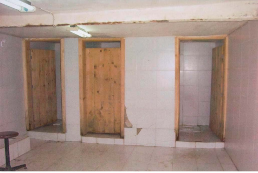
Foto C.5 Cerrahbaşı İshak Kazgani Sadi Sıbyan Mektebi Bodrum Kat Tuvaletler Ve Çelik Putrelle Güçlendirilmiş Döşeme
