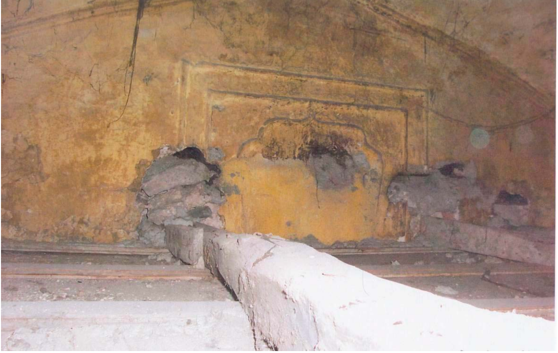
Foto C.39 Cerrahbaşı İshak Kazgani Sadi Sıbyan Mektebi Kubbesinde Bozulmalar
