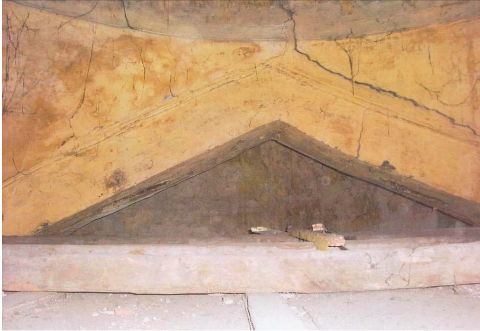
Foto C.32 Cerrahbaşı İshak Kazgani Sadi Sıbyan Mektebi Kubbesini Taşıyan Sivri Kemerler
