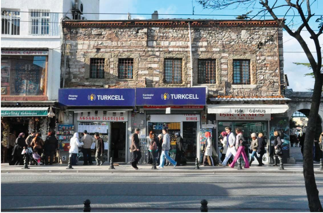
Foto 5.61 Atık Ali Paşa Sıbyan Mektebi Yeniçeri Caddesi Görünüşü
