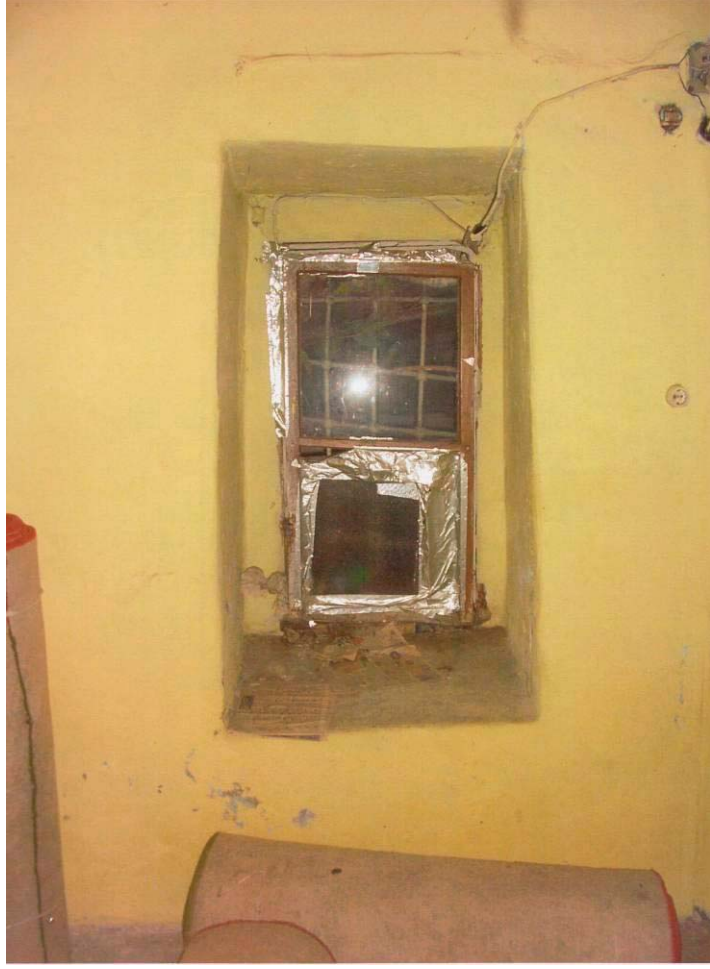
Foto C.9 Cerrahbaşı İshak Kazgani Sadi Sıbyan Mektebi Zemin Kat Penceresi
