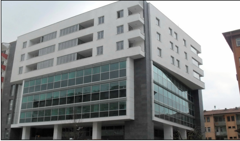
Şekil 2.25. Bazaltın cephe kaplama malzemesi olarak kullanımı [39].
