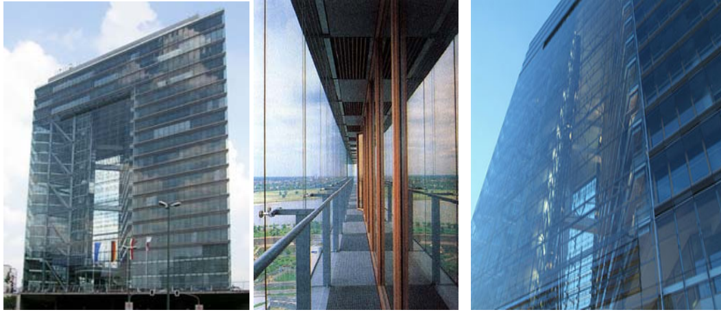
Şekil 4.37. Koridor Tipi Çift Cephe – Stadttor Binası, Düsseldorf – Almanya 176
