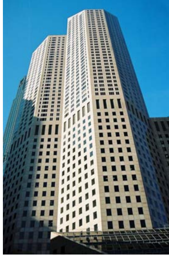
Şekil 3.56. One Magnificent Mile Binası
