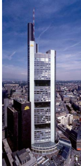
Şekil 4.6. Commerzbank Genel Müdürlük Binası, Frankfurt-Almanya
