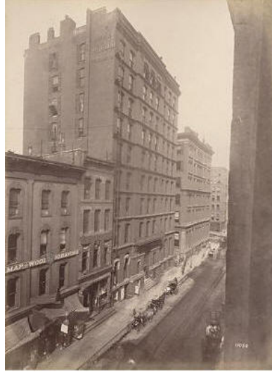
Şekil 3.19. Montauk Block Ofis Binası
