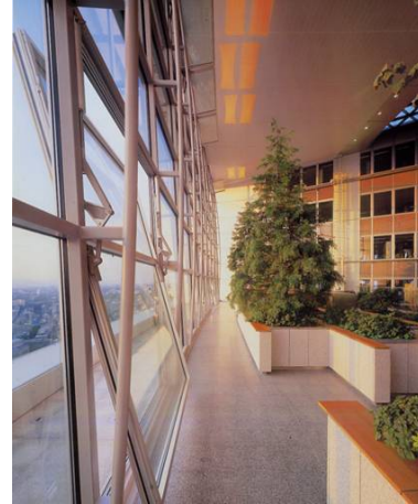
Şekil 4.50. Gökbahçeye bakan cephelerden temiz havanın yapı içerisine alınması 189
