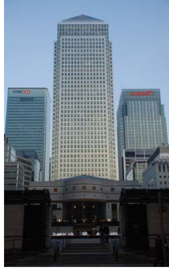
Şekil 3.59. Canary Wharf Kulesi
