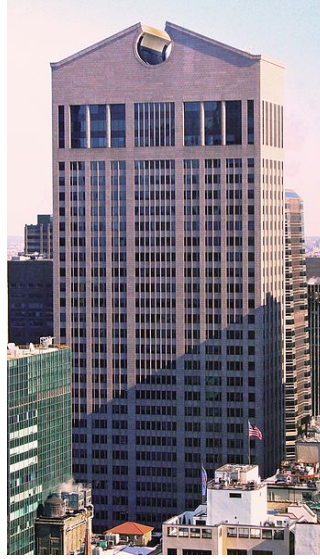
Şekil 3.55. AT&T Binası, New York
