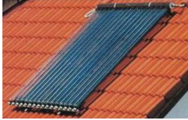
Şekil 2.19. Yapıda Güneş Kolektörünün Uygulanışı 36
