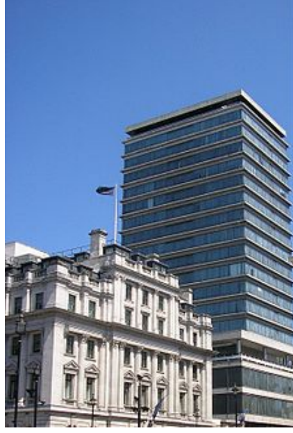
Şekil 3.44. New Zealand House
