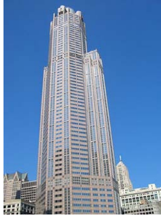
Şekil 3.49. 311 South Wacker Drive Binası
