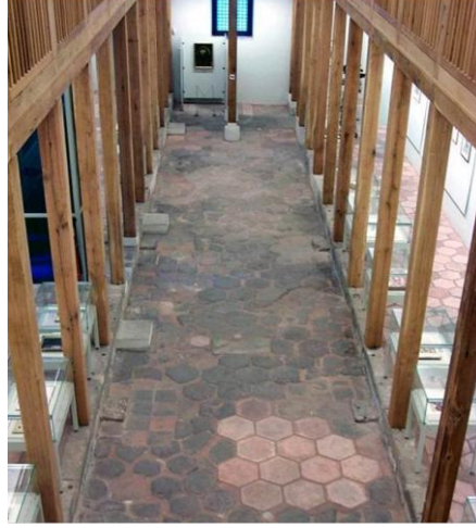
5.94 Restorasyon sonrası Hazine Koğuşu'nun döşemesi, Fotoğraf: Ayşe Orbay Mimarlık Limited, 2001.
