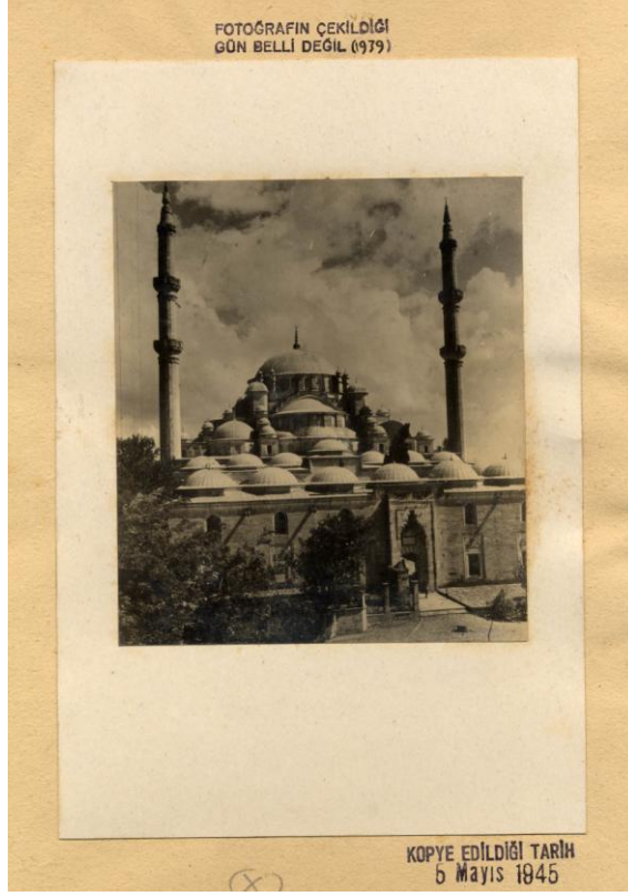
5.26 Taş külahlı minareyi gösteren bir cephe fotoğrafı, 1939, Kaynak: Encümen Fotoğraf Arşivi, 1945.
