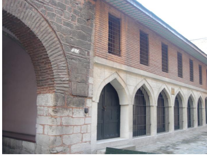
5.73 Helvahane kapısı ve yanında yer alan yeni binalar, Fotoğraf: Coşkun, Aralık, 2006.
