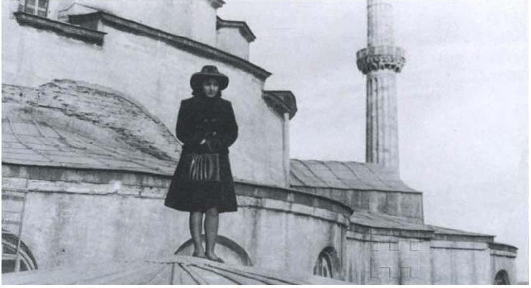
5.9 Mimar Cahide Tamer onarım sırasında Ayasofya'nın yan kubbe örtülerinin üstünde,1956, Kaynak: Sanal Mimarlık Müzesi,
