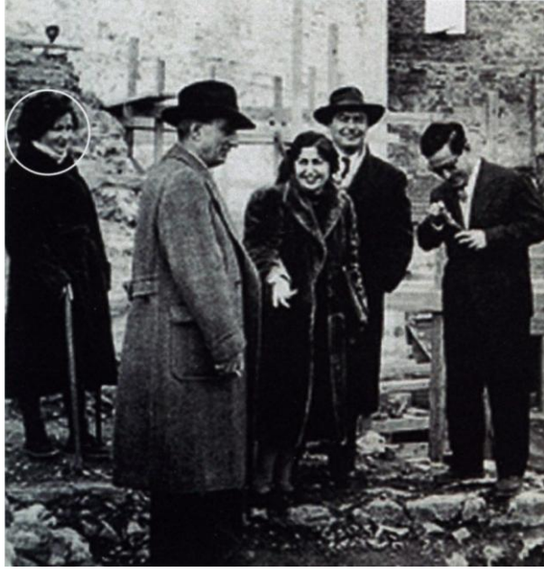
4.15 Rumelihisarı restorasyonu şantiyesinde çekilmiş bir fotoğraf. Fotoğrafta işaretli kişi, Selma Emler; diğer bayan ise Cahide Tamer'dir. Kaynak: Tanyeli, 2007.
