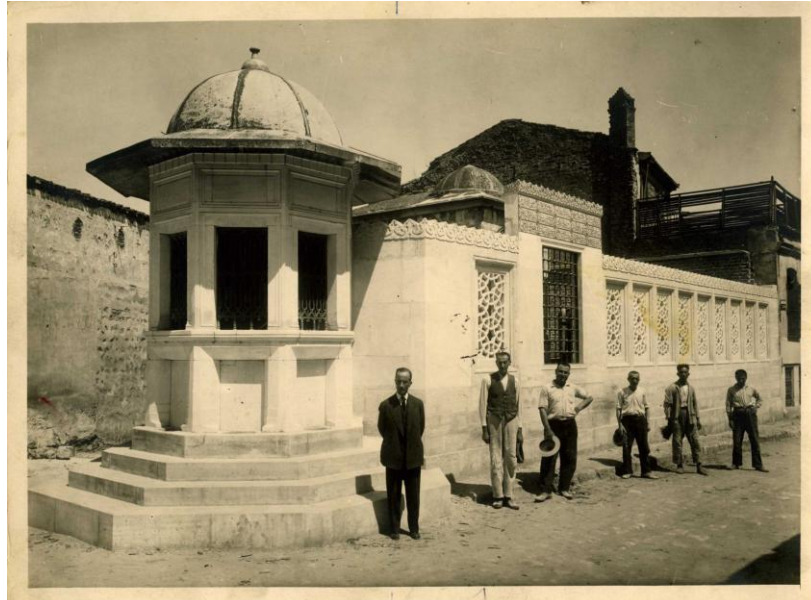
4.5 1933-1934 onarımı sonrası Mimar Sinan'ın türbesi, önde onarımı gerçekleştiren mimar Vasfi Egeli, Kaynak: Encümen Fotoğraf Arşivi, Mimar Sinan Araştırma Merkezi Arşivi, MSGSÜ.
