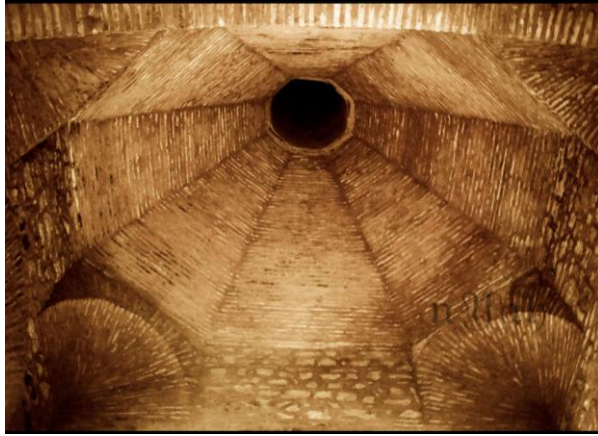
5.48 Mutfaklardan baca detayı, Fotoğraf: Ata, 2010.
