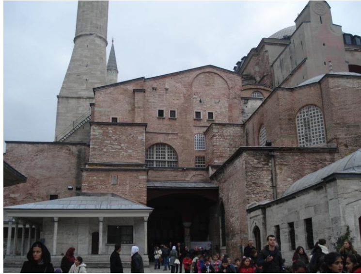
5.14 Onarımlar sonrası, Ayasofya güneybatı cephesi, Fotoğraf: Coşkun, 2011.
