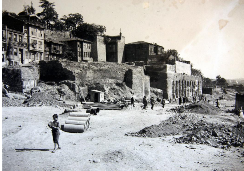
4.9 Prost'un İmar Planı'na uyularak Atatürk Bulvarı'nın açılması sırasında gerçekleştirilen yıkımlar, Kaynak: Akpınar, 2011.
