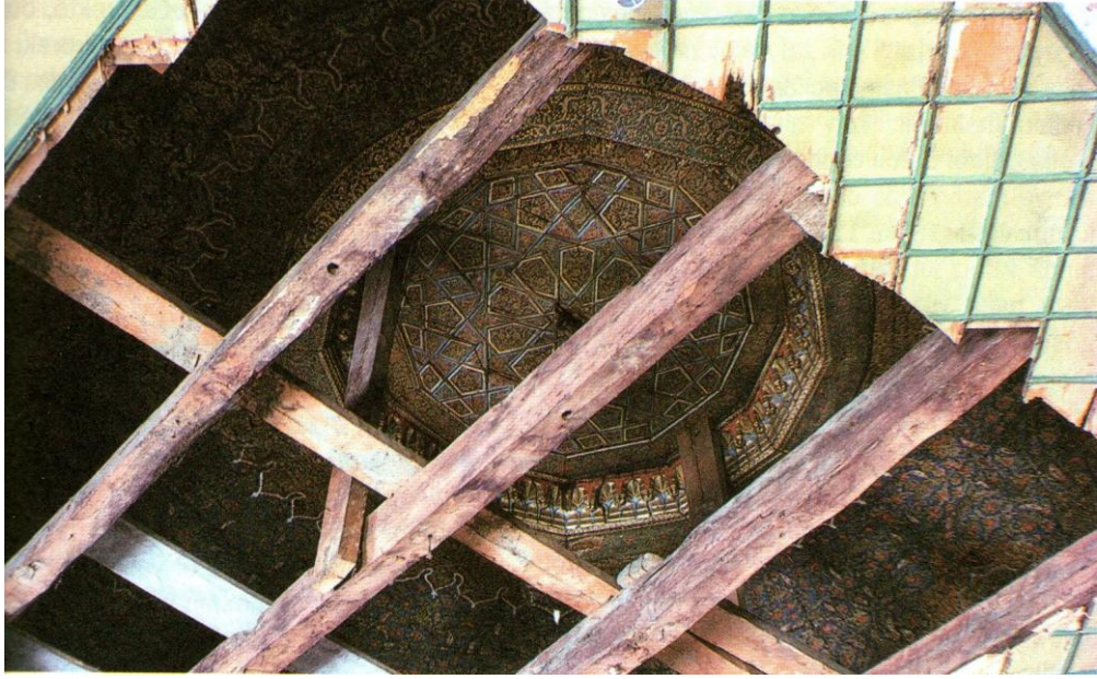
5.62 Çıtalı tavanın kaldırılmasıyla ortaya çıkan kubbeli tavan Kaynak: İTÜ Restorasyon Anabilim Dalı Arşivi, Ahunbay, 1996.
