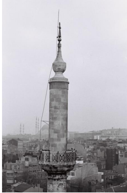
5.27 Restorasyon önesi taş külahlı minare, Kaynak: Vakıflar 1. Bölge Müdürlüğü Fotoğraf Arşivi.
