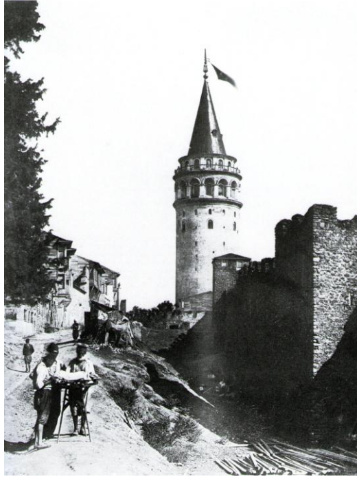
3.2 Galata Kulesi'nin kuzey cephesindeki sur ve hendek, 1870'ler civarı,
