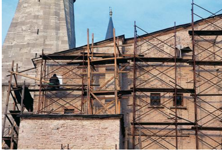
5.16 Ayasofya Güneybatı Köşesi restorasyonundan bir görüntü,
