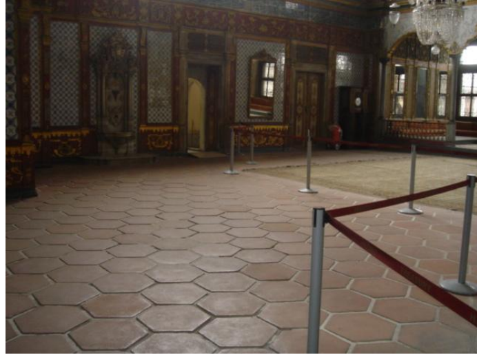
5.90 Hünkar Kasrı'nın mevcut tuğla döşemesi, Fotoğraf : Coşkun, Mart, 2006.
