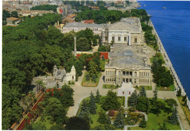
5.101 Dolmabahçe Sarayı'na güneyden bakış, Kaynak: Gürol Kara, Dünden Bugüne İstanbul Ansiklopedisi, 1994, Cilt:3, 93.
