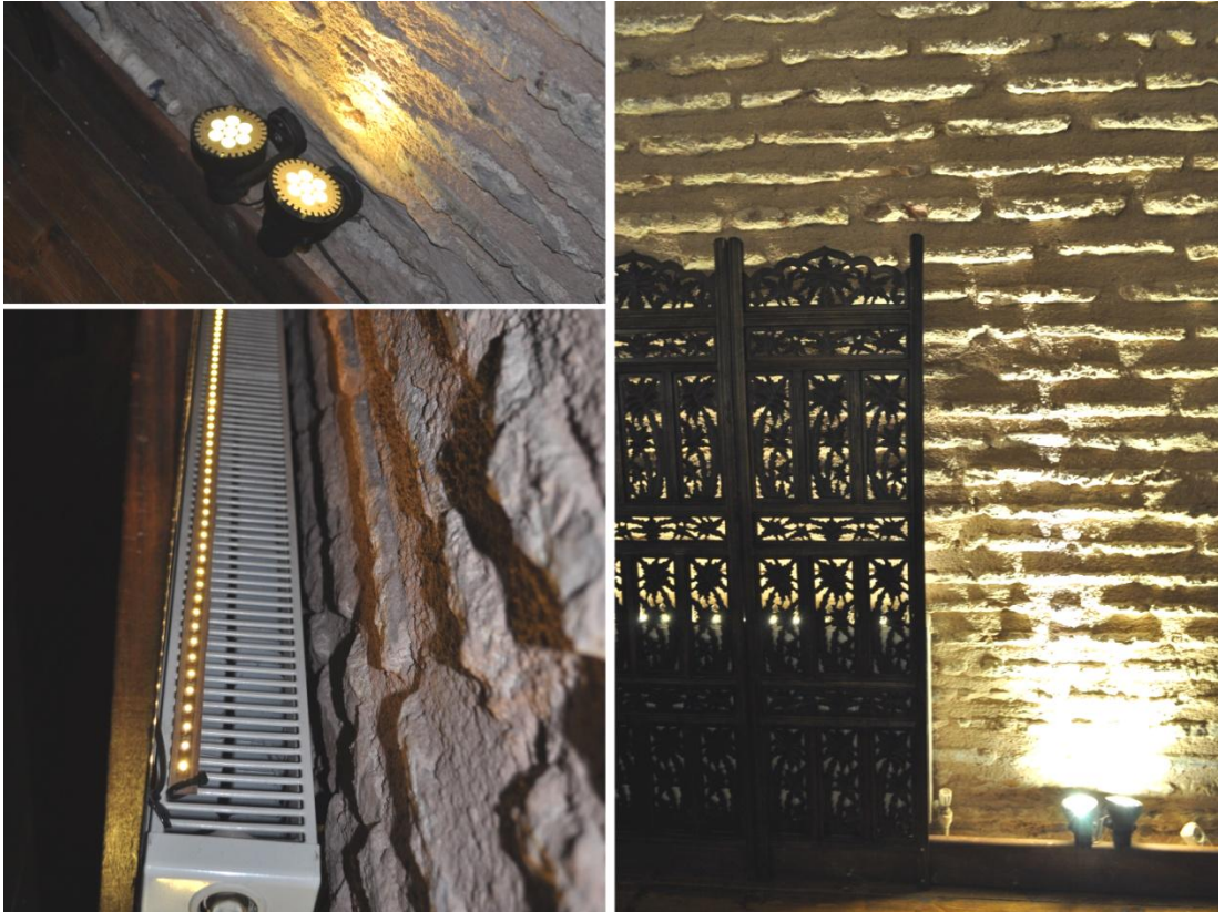
Şekil 5.22. Sarnıç yapısı duvar aydınlatması
