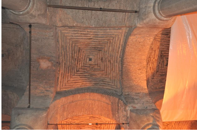
Şekil 5.3. Sarnıç yapısının tuğladan örülmüş üst örtüsü
