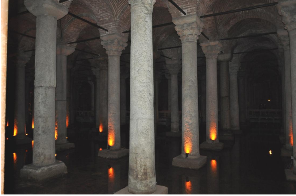
Şekil 5.38. Bazı sütunlara aydınlatma elemanı yerleştirilmemiştir
