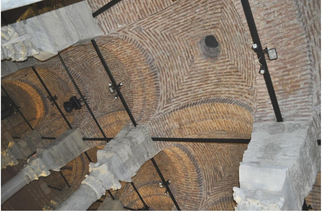
Şekil 5.20. Tuğladan örülmüş üst örtüyü oluşturan kemer tonoz sistemi
