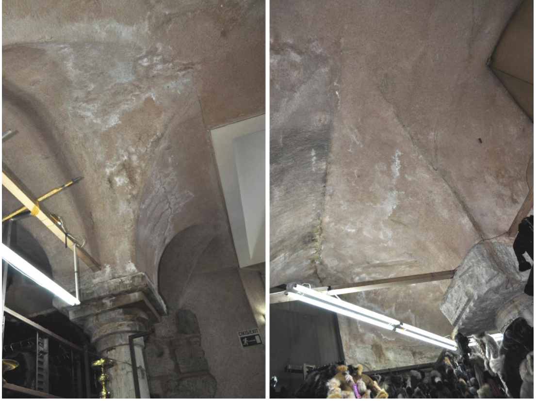
Şekil 5.11. Sıva üzerinde oluşan çiçeklenme ve biyolojik kolonizasyon
