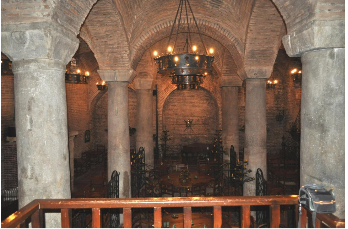
Şekil 5.13. Soğukçeşme Sokağı Sarnıcı'ndan genel görünüş
