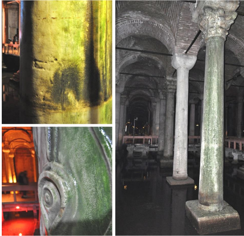
Şekil 5.27. Sütunların yüzeyinde oluşan biyolojik kolonizasyon
