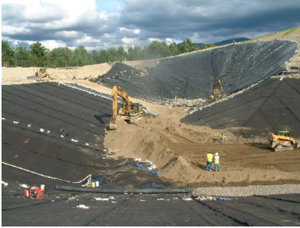
Şekil 2.47. Geomembranın saha uygulaması (www.terrafixgeo.com)
