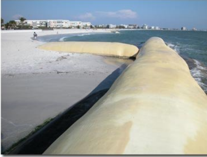
Şekil 2.59 Geotüpün Sahil Korumada Kullanılması (www.thepetitionsite.com)
