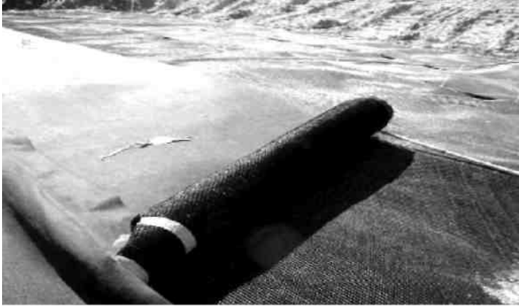
Şekil 2.45. Geonet saha uygulaması (www.istanbulteknik.com)
