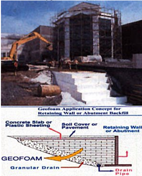
Şekil 2.57. İstinat Duvarları Arkasında Geofoam Kullanımı (www.powerfoam.net)
