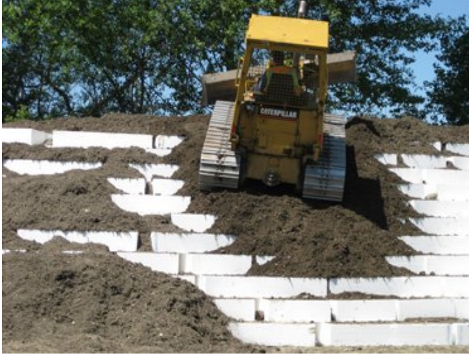
Şekil 2.58. GeoFoam ile Şev Oluşturma (www.insulfoam.com)
