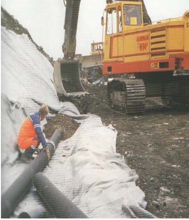
Şekil 2.37. Geotekstillerin Kullanımı (www.grupo.com.tr)
