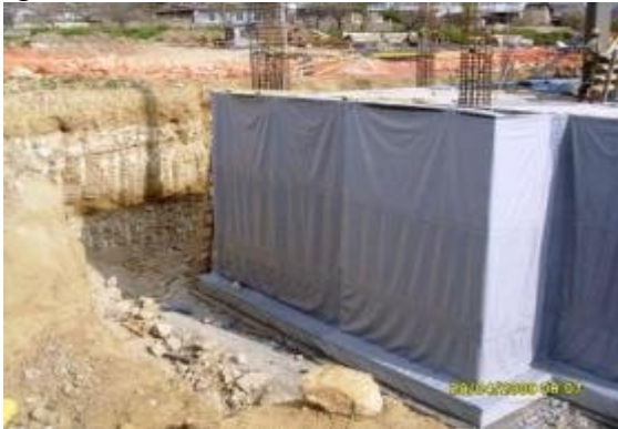
Şekil 2.48. Su deposu yalıtımı yapılması (www.isdunyasi.net)
