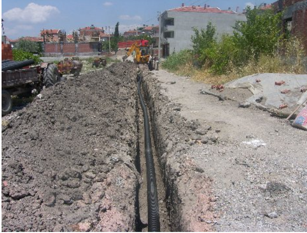
Şekil 2.54. Atık Su Taşımada Geoboru Kullanımı ( www.savastepe.bel.tr )
