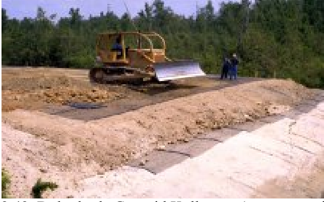
Şekil 2.42. Dolgularda Geogrid Kullanımı (www.geogrid.com)
