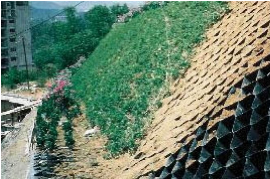
Şekil 2.62. Geohücre Uygulaması (www.geomembranes.com)
