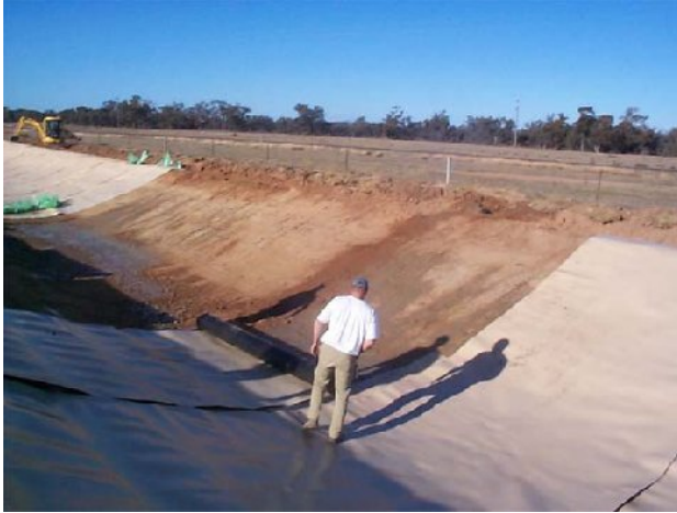
Şekil 2.52. Geosentetik Kil Kaplama Uygulaması (www.irrigation.org.au)
