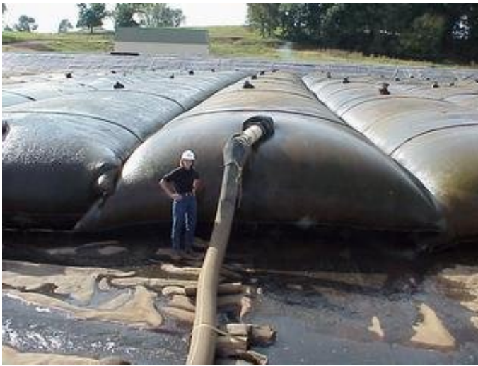
Şekil 2.60. Depolama işlemlerinde Geotüp Kullanımı (www.merchantcircle.com)
