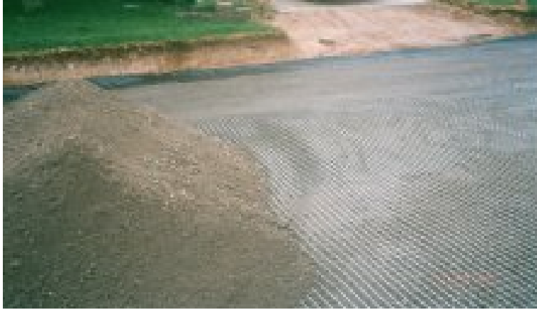
Şekil 2.41. Geogrid Uygulaması (www.geogrid.com)
