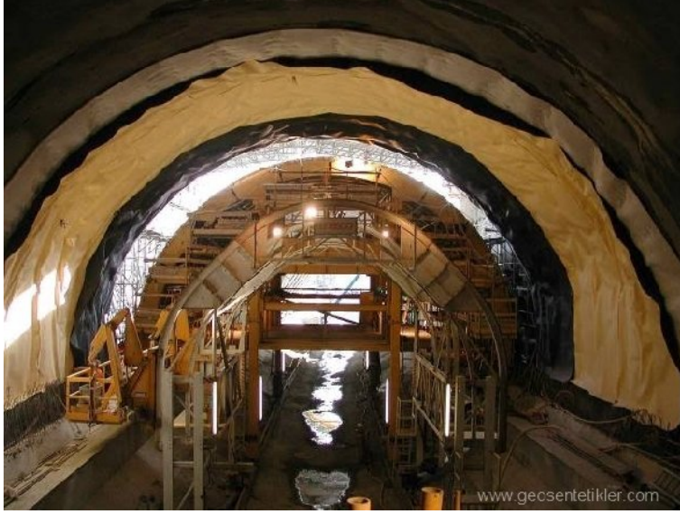
Şekil 2.55. Tünel inşaatında geokompozit kullanımı (www.geosentetikler.com)
