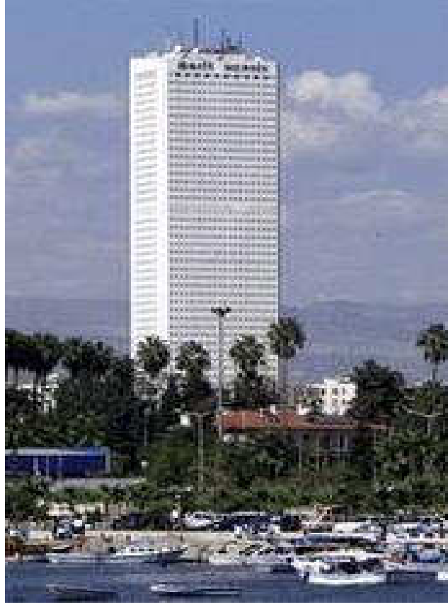
Şekil 5.8. Mersin Metropol genel görünüm
