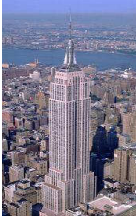
Şekil 5.21. Empire State Binası genel görünüm
