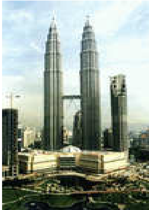
Şekil 5.15. Petronas Tower genel görünüm
