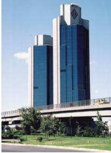
Şekil 5.1. Sabancı Center genel görünüm
