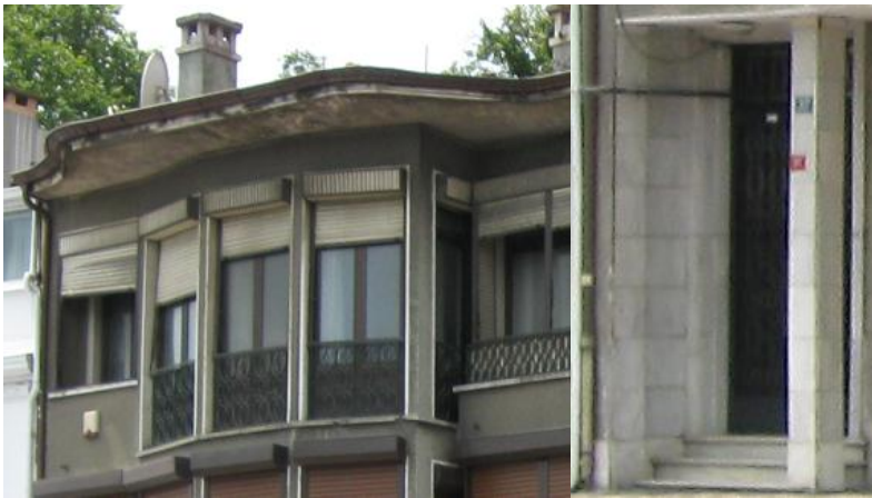
Şekil 4.163 Saçak ve apartmanın girişi
