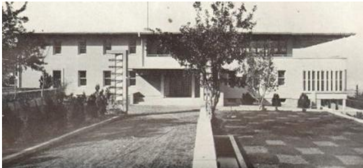
Őekil 4.9 kafesi andıran duvar 6rg6s6
