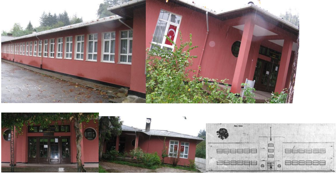
Şekil 4.130 Kılıç İlköğretim Okulu görüşler ve Üzülmez ilkokulu görünüşü
