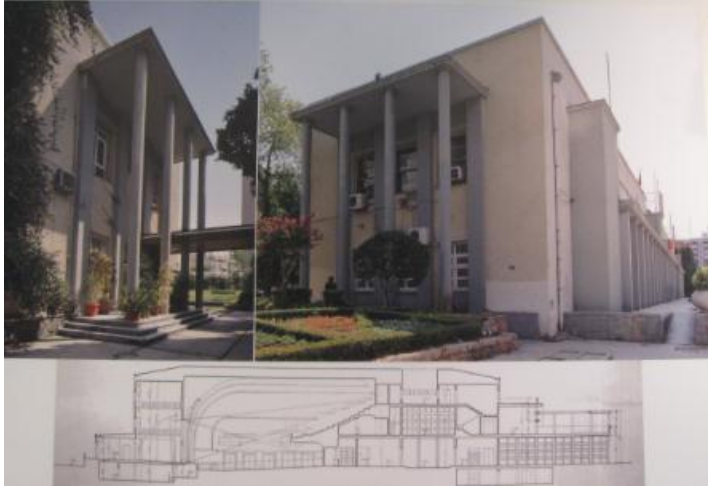
Şekil 4.41 Yapıyı hem ikiye bölen, hem de çatı kotunda birleştiren ara kesit mekânıyla alışılmadık ve ilginç bir örnek; İzmithalkevi (Tanyeli, 1992)
