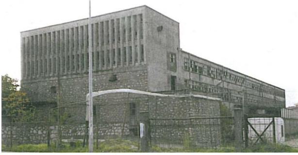
Şekil 4.173 İstanbul Porselen Fabrikası, Tuzla
