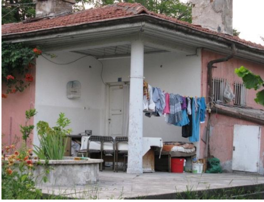
Şekil 4.96 Verandanın şimdiki kullanım hali
