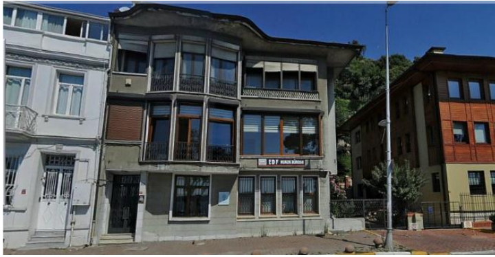
Şekil 4.161 Ferit İnal apartmanı
