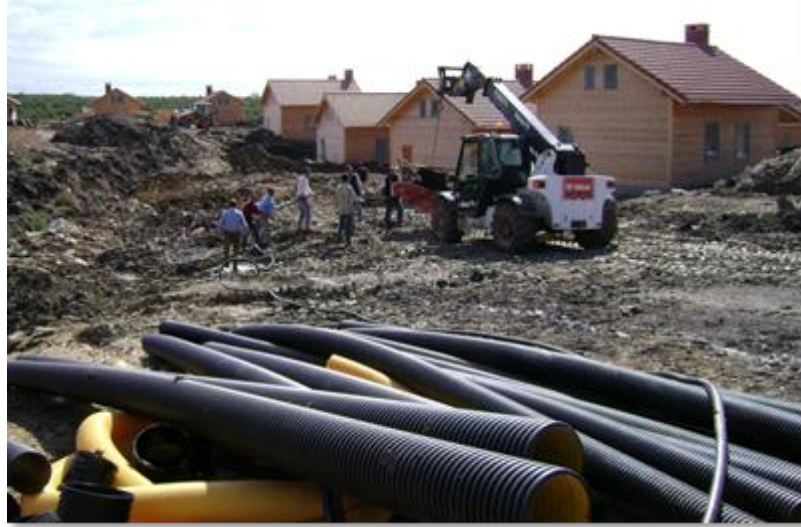
Resim 3.3.37 Alt yapı çalışmaları, arşiv 2007.
