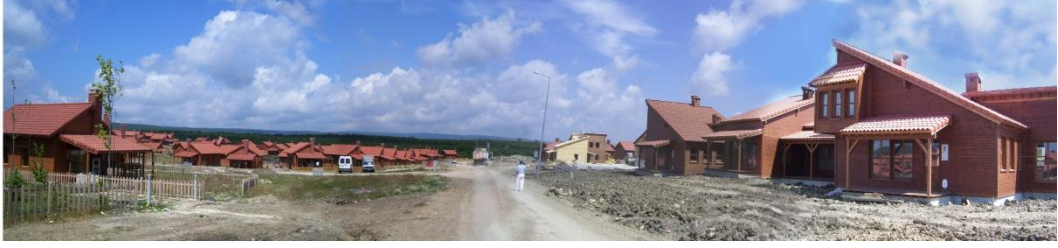
Resim 3.6.1 İmar yolundan görünüş inşaat dönemi, arşiv 2008.
