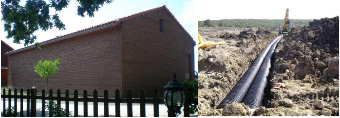
Resim 3.3.41 Su deposu ve alt yapı inşaatı, arşiv 2007
