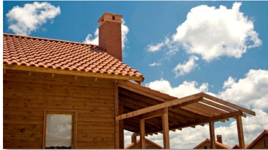
Resim 3.4.10 Çatı elemanları. Arşiv 2008
