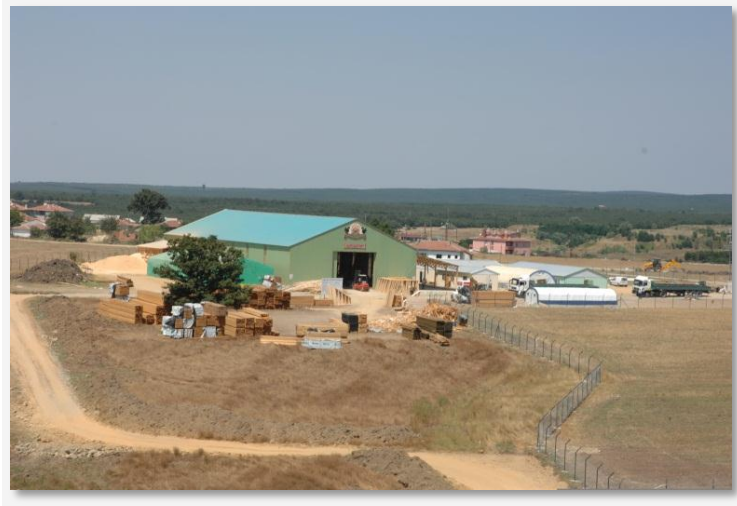
Resim 3.5.2 Üretim Tesisi. Arşiv 2007
