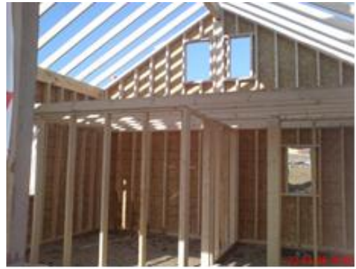
Resim 3.5.6 Sincap ev, sahada montaj aşamaları, arşiv 2007.
