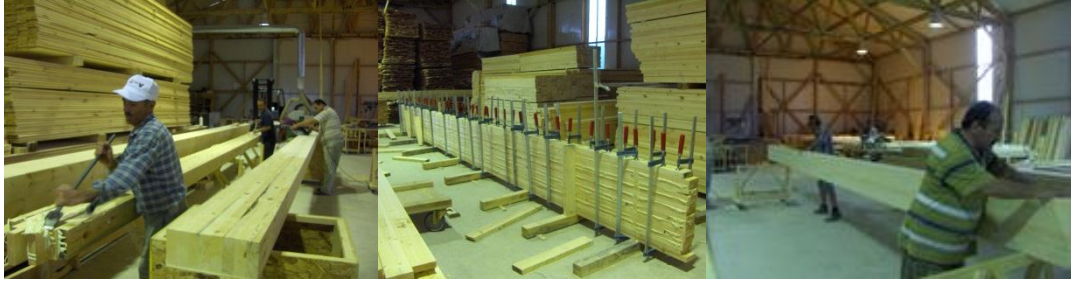
Resim 3.4.26 Fabrikada lamine kiriş imalat ünitesi.
