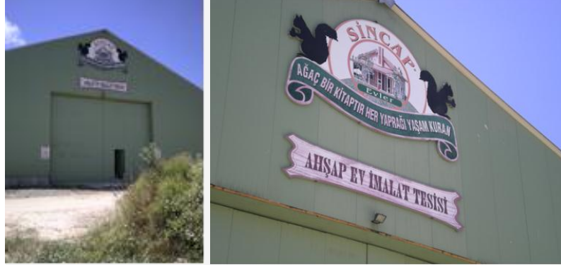
Resim 3.5.1 Fabrika giriş cephesi.
