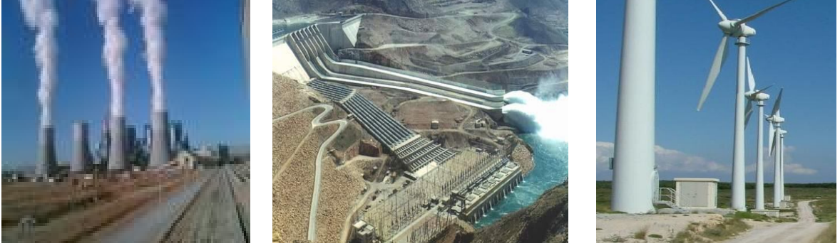
Şekil 1.3. Türkiyedeki termik, hidrolik ve rüzgar santrallerinden kesit
