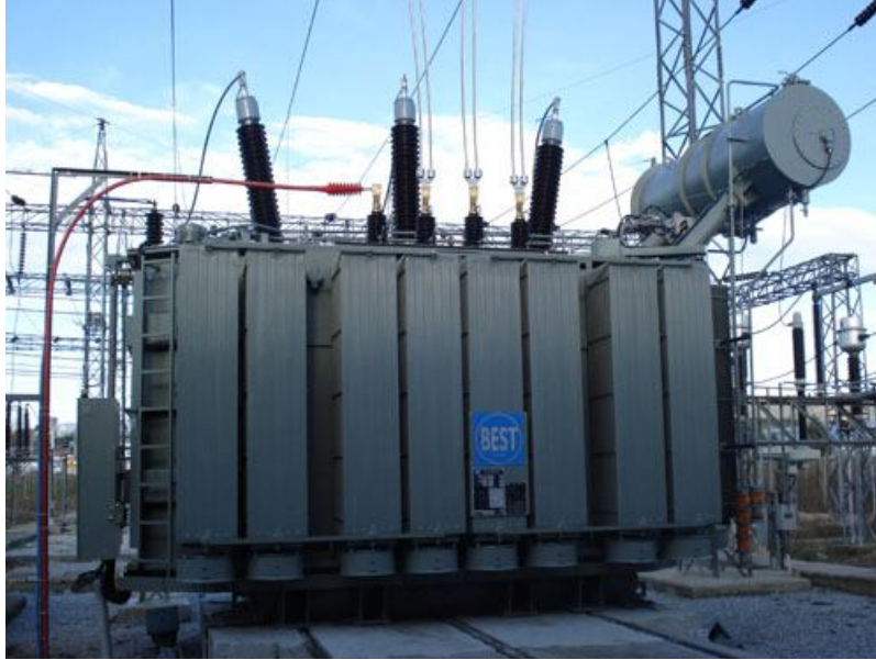
Şekil 1.4. İletim Sisteminde Kullanılan Güç Transformatorü
