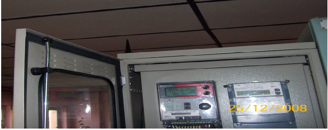
Şekil 2.8. GPRS Tabanlı Elektronik Kombi Sayaç İç Yapısı ve Öngörünümü
