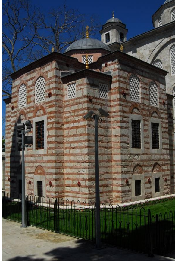
Resim E.3. Güneydoğu-Kuzeydoğu cephesi
