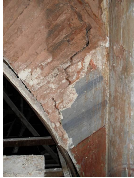
Resim 3.40. Güneydoğu kemerinin sütuna oturduğu yerden ayrılması (arka görünüş)
