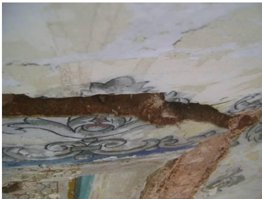
Resim 3.142. Duvar dokusundan ayrılmış kalem işli özgün horasan sıva tabakaları
