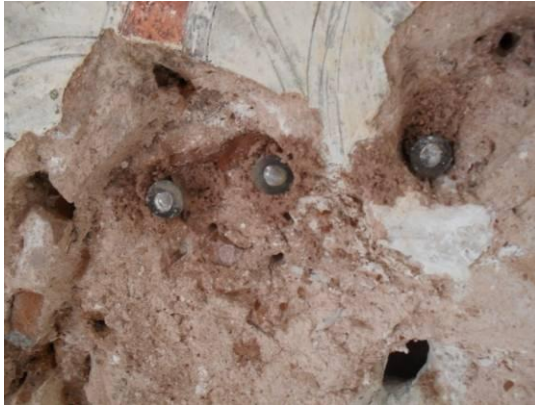
Resim 3.138. Kalem işli yüzeyde korozyona uğrayarak paslanan çivilerin çıkarılması
