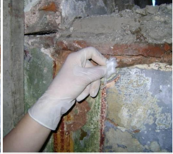
Resim 3.137. Deliğin pamukla kapatılması
