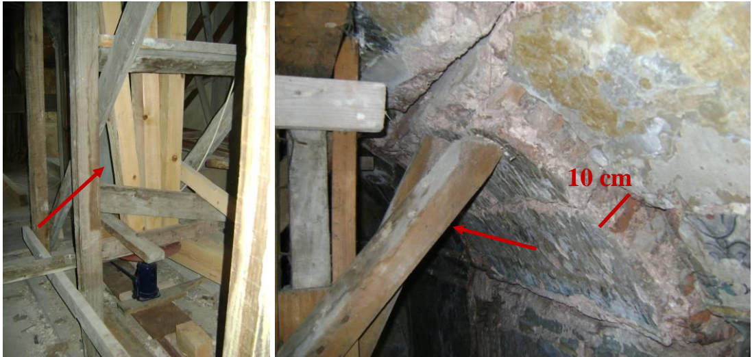
Resim 3.121. Tonz altına kriko kurulması
