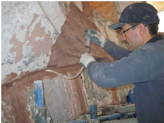
Resim 3.113. Sikadur 52 ile enjeksiyon yapılması
