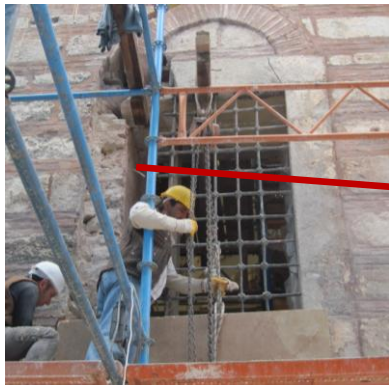
Resim 3.162. Söve üst kote çekilirken
