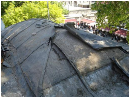
Resim 3.60. Kurşun örtünün altında çamur sıva
