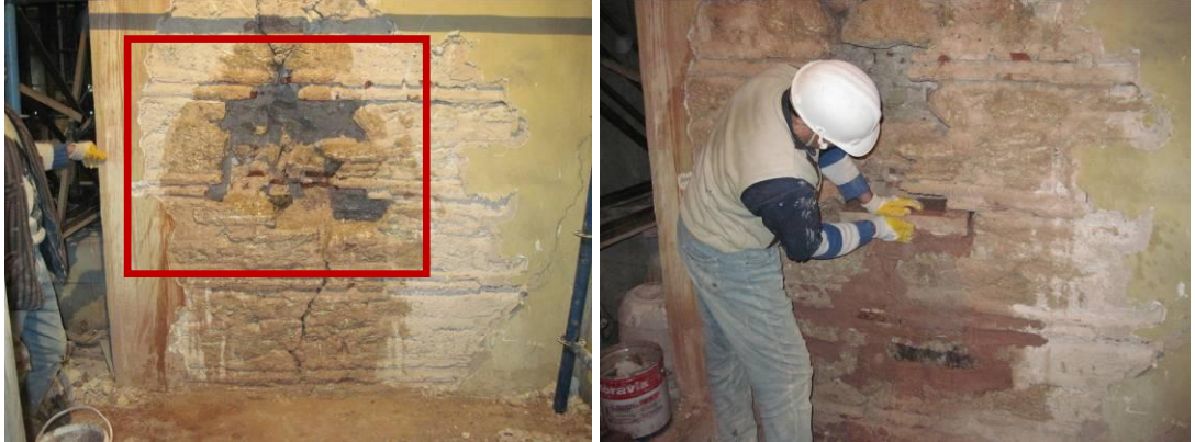
Resim 3.151. Duvarda dikiş için yapılan çürütme
