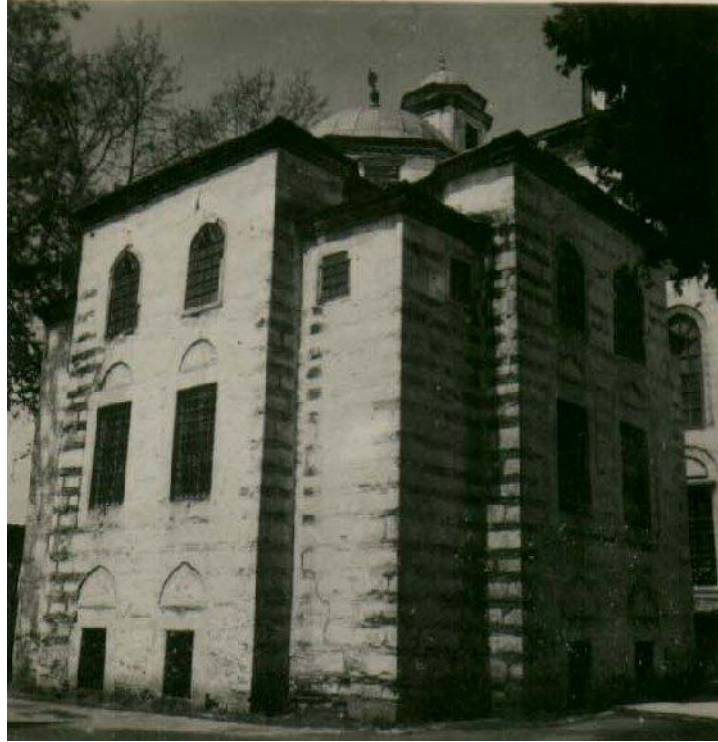
Resim C.2. Fatih Külliyesi cenaze avlusundan I. Mahmut Kütüphanesi güneydoğu cephesi (Encümen Arşivi-1940'lar)
