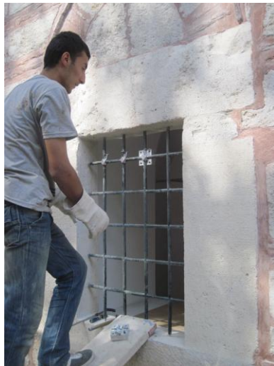
Resim 3.193. Kalıp çıkarıldıktan sonra lokma
