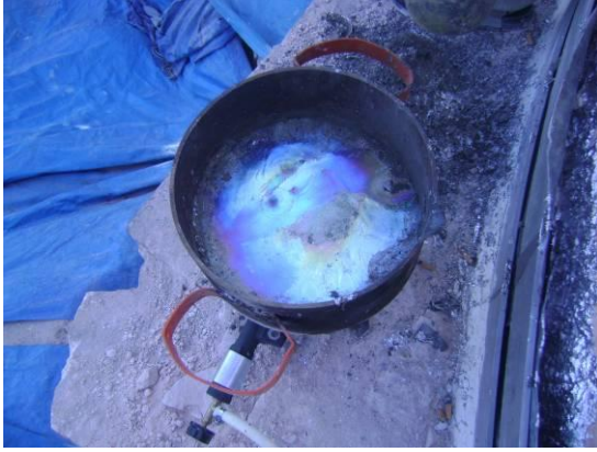
Resim 3.103. Paslanmaz çelik çemberin arkasına eritilerek kurşun dökülmesi
