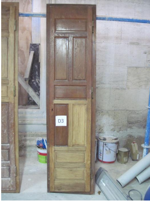
Resim 3.183. Ahşap kepenkte boya sökücü ile temizlik
