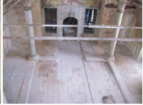
Resim 3.17. Zemin katta özgün tuğla döşeme
