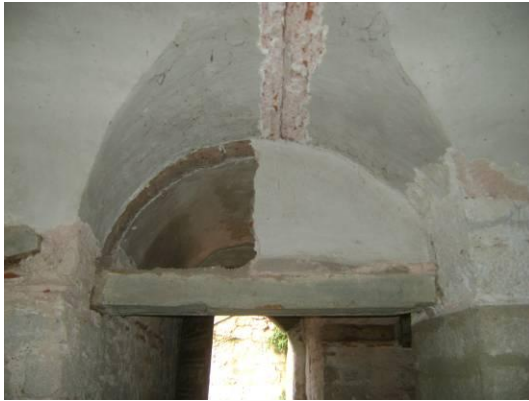
Resim 3.44. Bodrum kat ahşap gergileri
