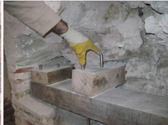
Resim 3.107. Ahşap hatılları birbirine bağlayan paslanmaz çelik zıvanalar
