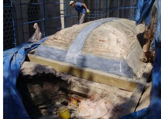
Resim 3.126. Kompresör makinesi ile çatlakların içindeki tozların ve parçacıkların temizlenmesi
