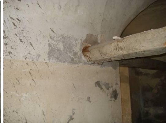
Resim 3.45. Bodrum kat ahşap gergisinin duvara girdiği nokta
