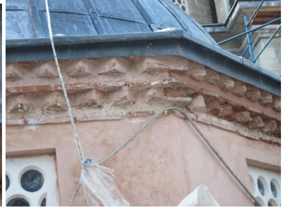
Resim 3.155. Saçakta sarkıtılan kurşun
