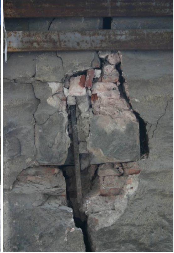
Resim 3.33. Kuzeybatı duvarında bulunan gergiyi bağlayan gizli kılıç
