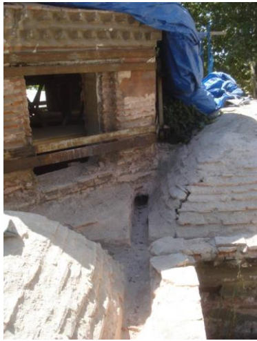
Resim 3.56. Ahşap hatılın kubbe kasnak duvarı altına girdiği yuva
