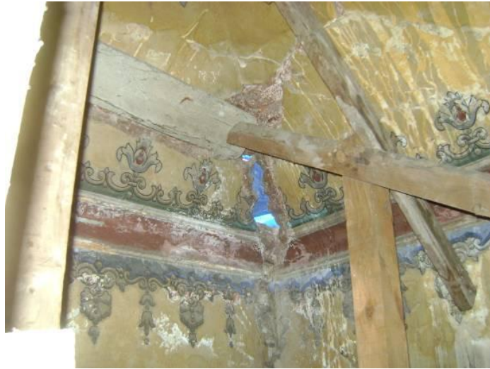
Resim 3.86. Tonoz aynalarında açılma
