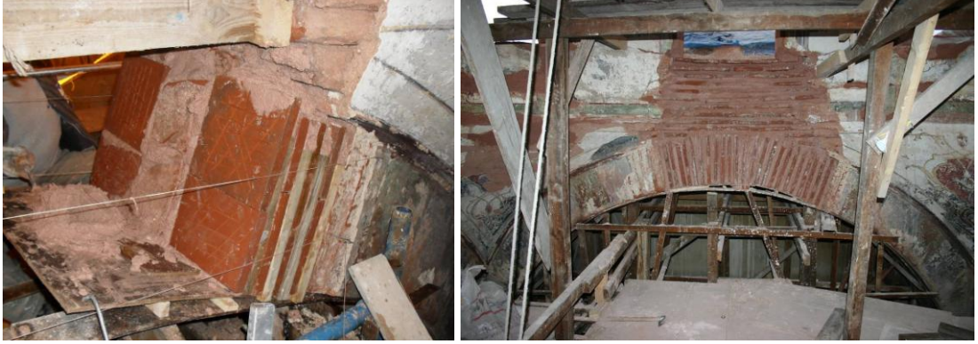
Resim 3.149. Özgün malzeme ile dikiş
