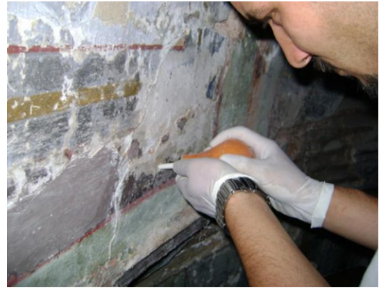
Resim 3.133. Puar ile deliğin temizlenmesi
