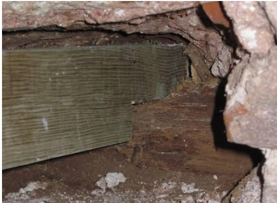
Resim 3.106. Ahşap hatılların birbirine mesnetlenmesi
