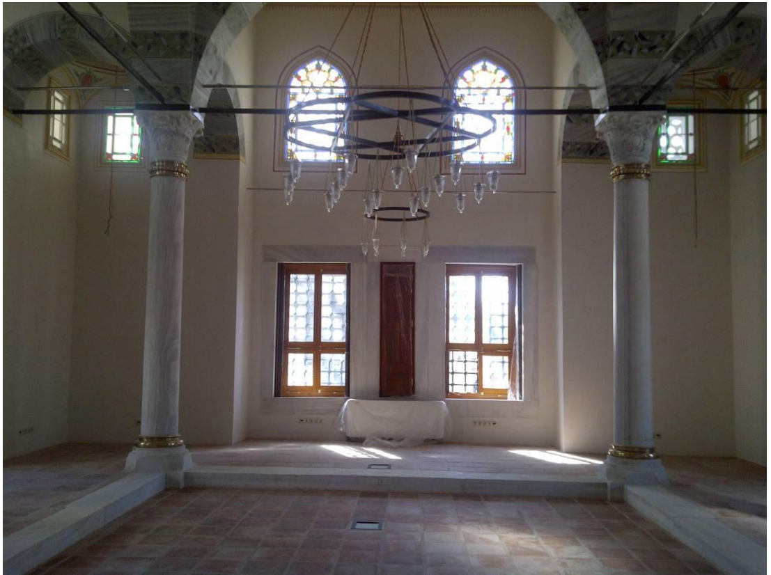
Resim E.10. Güneydoğu iç cephesi
