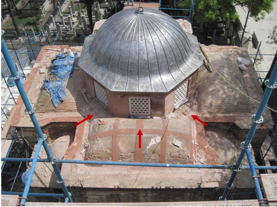
Resim 3.153. Kasnak pencereleri altına konulan kurşun levhalar
