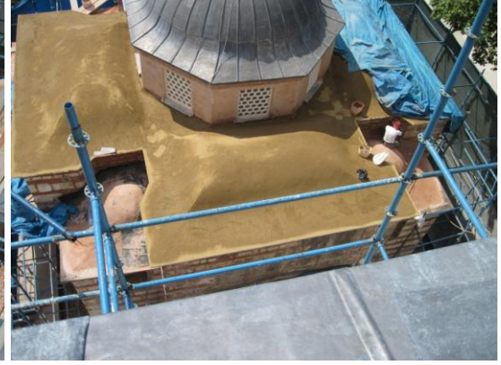
Resim 3.170. Üst örtüde çamur sıva yapımı
