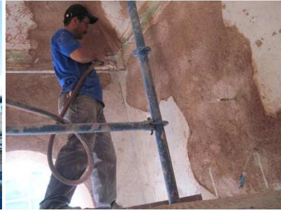
Resim 3.91. Albaria I. 200 kireç esaslı harcı ile yapılan enjeksiyon
