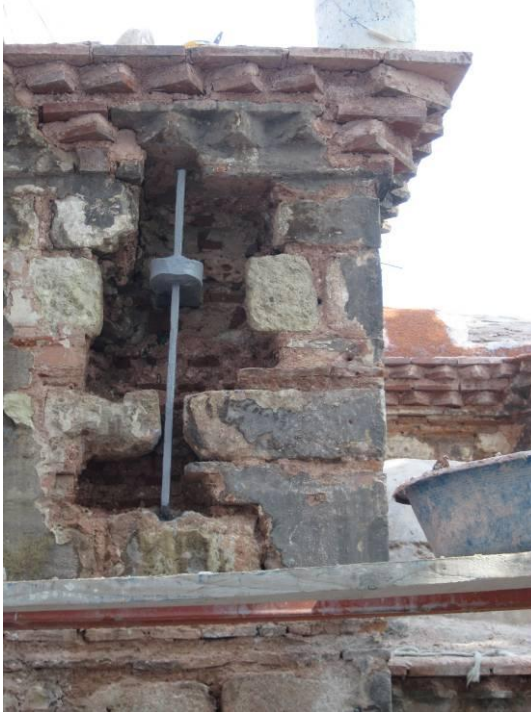
Resim 3.7. Duvar gergisi ve gizli kılıçlı mesnetleme
