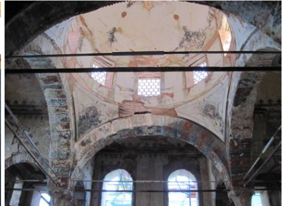
Resim 3.114. Sağlamaştırma işlemi bittikten sonra kemerin son durumu
