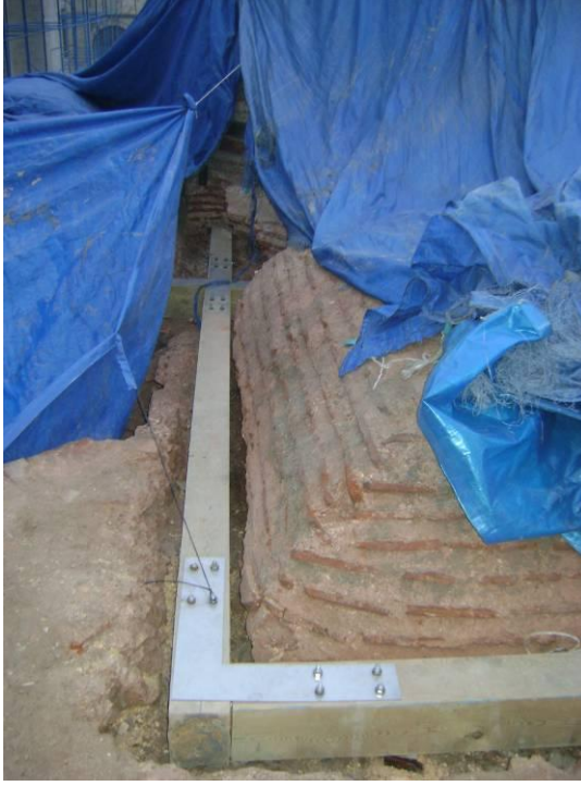
Resim 3.117. Paslanmaz çelik levha ve bulonlarla iki ahşap hatılın birbirine bağlanması
