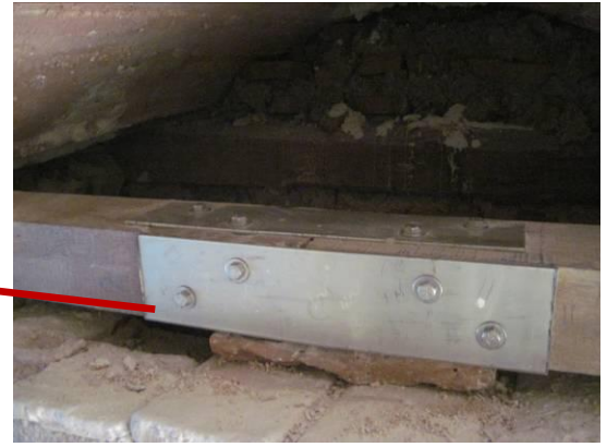
Resim 3.109. Ahşap hatılları bağlayan levha ve bulonlar
