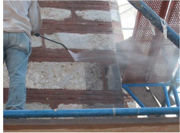
Resim 3.157. AB 57 sonrası su ile yıkama
