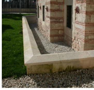
Resim 3.199. Drenaj sonrası kütüphane
