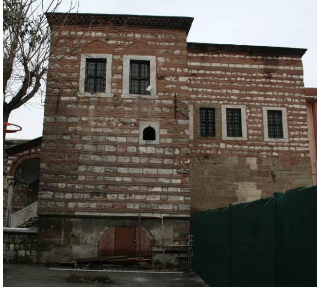
Resim 2.3. Şehit Ali Paşa Kütüphanesi yan cephesi
