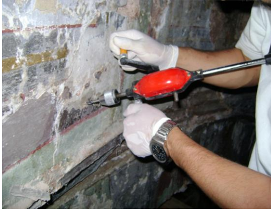
Resim 3.132. Sağlamaştırma yapılacak duvara el matkabı yardımıyla delik açılması
