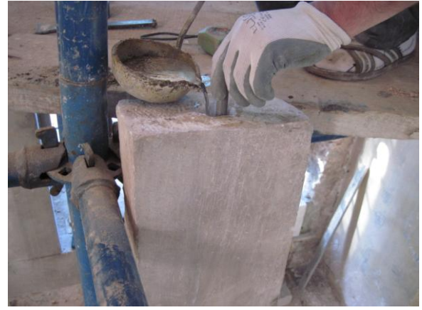
Resim 3.180. Zıvanaya kurşun dökülmesi
