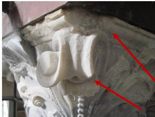
Resim 3.72. Sütun başlığındaki süslemelerde meydana gelmiş kırıklar
