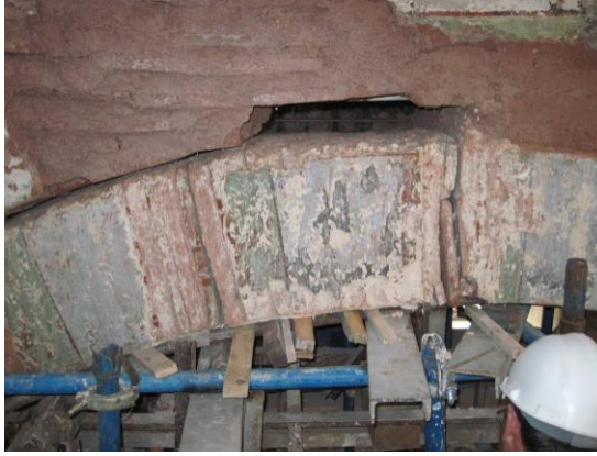
Resim 3.111. Kriko ile özgün kotuna kaldırılan kemer
