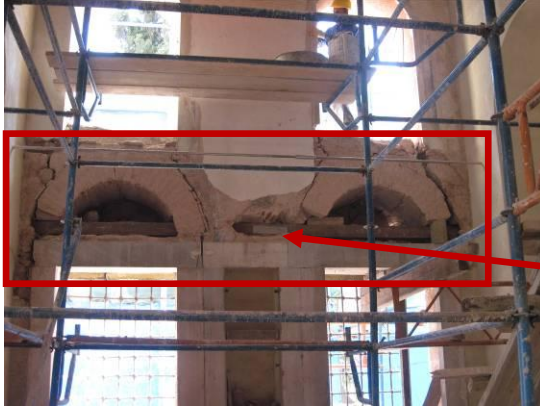
Resim 3.108. Kemer aynası içinde ahşap hatıl
