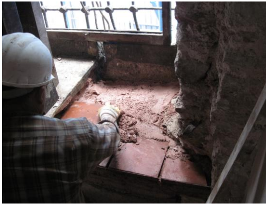
Resim 3.175. Pencere altı duvarda onarım
