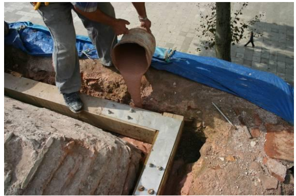
Resim 3.120. Kapatma için dökülen horasan harçlı şerbet
