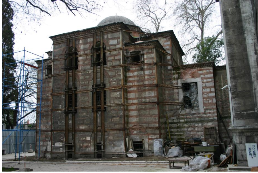
Resim 3.19. Restorasyon öncesi kütüphanenin durumu
