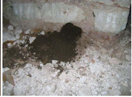
Resim 3.29. Paye altındaki yuvalardan çıkan toz halindeki ahşap hatıl parçaları
