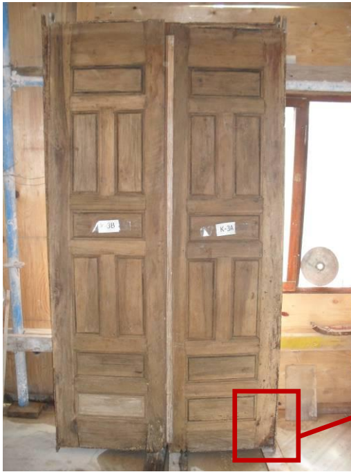
Resim 3.77. Boya tabakası alınmış kepenkte çürümüş bölüm
