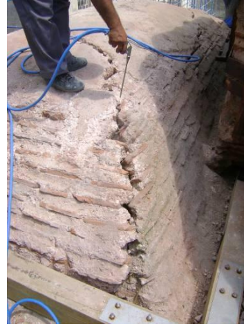
Resim 3.126. Kompresör makinesi ile çatlakların içindeki tozların ve parçacıkların temizlenmesi
