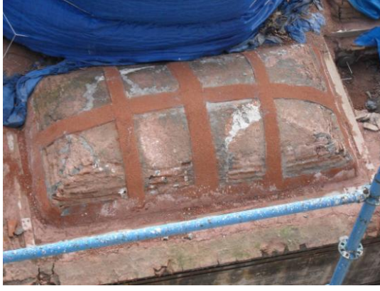
Resim 3.129. Karbon elyaf uygulaması sonrası tonoz
