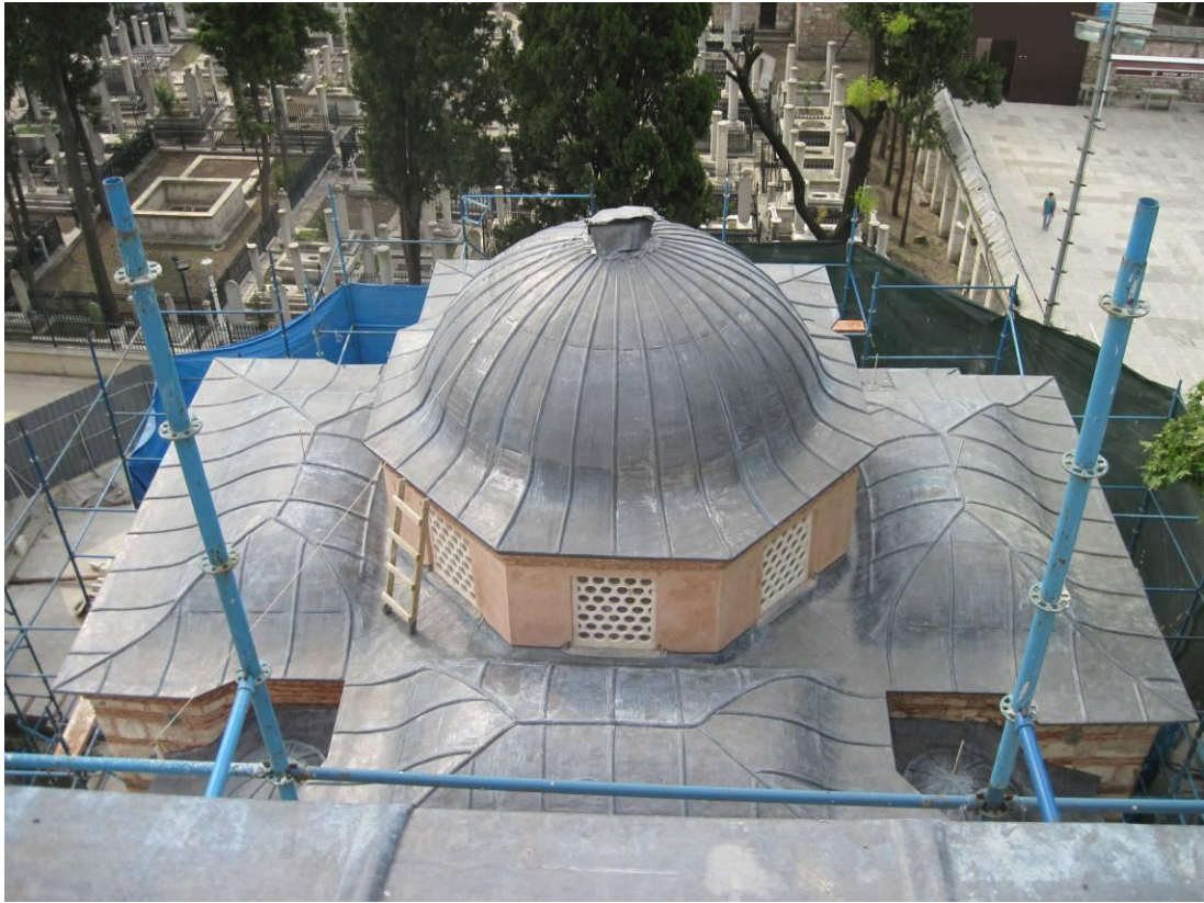
Resim 3.131. Horasan siva, çamur siva ve kurşun yapımı bittikten sonra tonozlar
