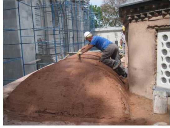
Resim 3.130. Tonozda horasan siva yapımı
