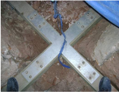
Resim 3.119. Paslanmaz çelik levhalarla yapılan köşe bağlantısı ve bağlama işlemi
