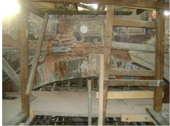
Resim 3.40. Güneydoğu kemerinin sütuna oturduğu yerden ayrılması (arka görünüş)
