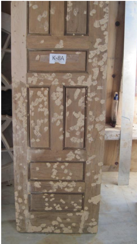
Resim 3.185. Kurt deliklerinin macun ile kapatılması
