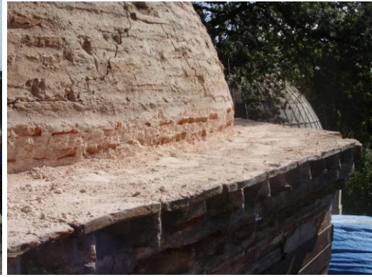
Resim 3.99. Kubbe eteğindeki horasan harçlı moloz dolgu alındıktan sonra
