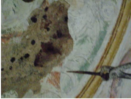
Resim 3.138. Kalem işli yüzeyde korozyona uğrayarak paslanan çivilerin çıkarılması
