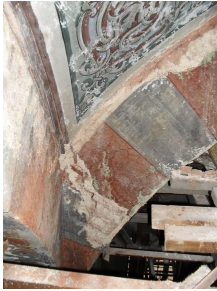
Resim 3.39. Güneydoğu kemerinin sütuna oturduğu yerden ayrılması (ön görünüş)
