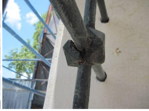
Resim 3.80. Kırılmıř lokma detayı
