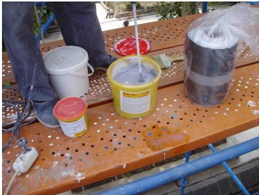
Resim 3.127. Karbon elyaf uygulaması için Sikadur hazırlanması
