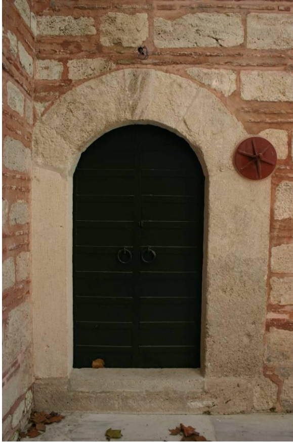
Resim E.6. Bodrum kat giriş kapısı
