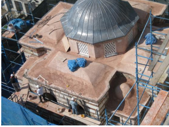
Resim 3.169. Üst örtüde horasan sıva yapımı
