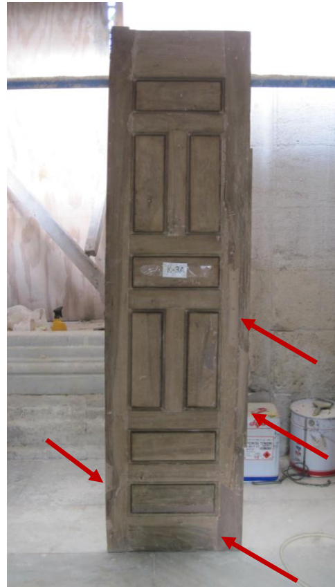
Resim 3.186. Çürümüş parçaların değiştirilmesi
