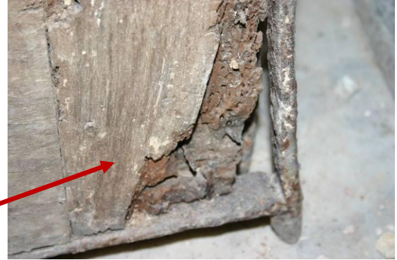
Resim 3.78. Boya tabakası alınmış kepenkte çürümüş bölüm detayı
