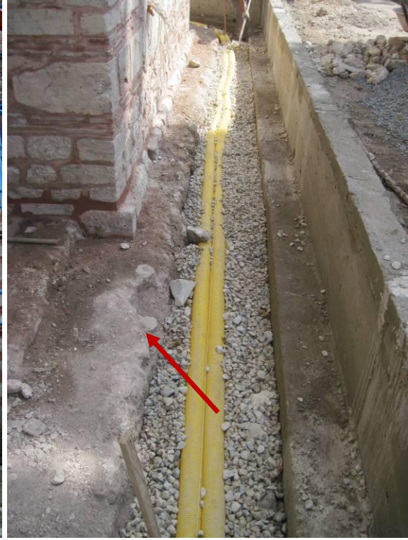
Resim 3.6. Zemin açıldıktan sonra ortaya çıkarılan su basman
