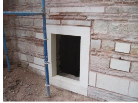
Resim 3.159. BKP-1 no.lu pencerenin taş sövesi ve duvarlardaki hasarlı taşlar onarımdan sonra
