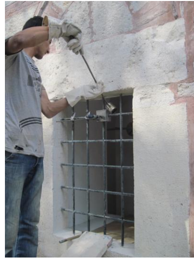
Resim 3.192. Kalıbın içine kurşun dökülmesi
