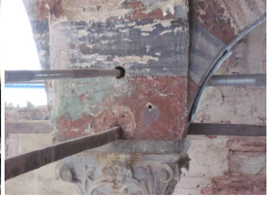
Resim 3.93. Kemerlerden geçirilen paslanmaz çelik gergiler ve sağ tarafta çelik flanş
