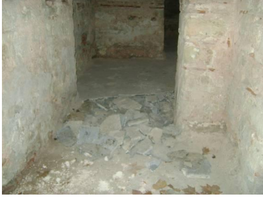
Resim 3.16. Bodrum kat zemininden sökülen şap
