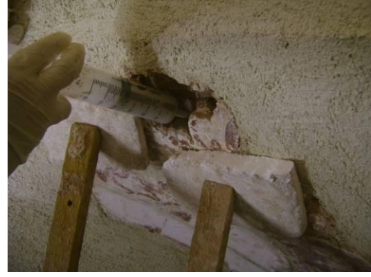
Resim 3.145. Duvardan ayrılmış sıva tabakalarına enjeksiyon yapılması
