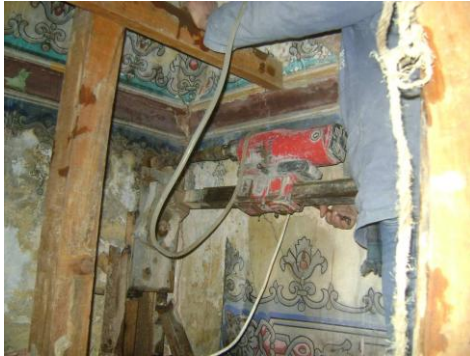
Resim 3.87. Karot ile delme işlemi esnasında
