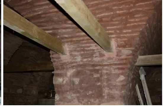
Resim 2.31. Bodrum kat duvarlarında ahşap gergilerin mesnet noktaları
