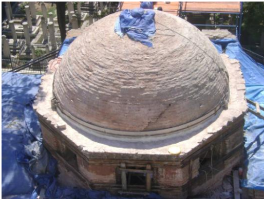
Resim 3.100. Kubbe eteğinden geçirilen paslanmaz çelik çember
