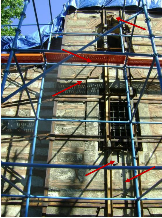
Resim 3.34. Güneydoğu cephesinde ayrılmanın izi
