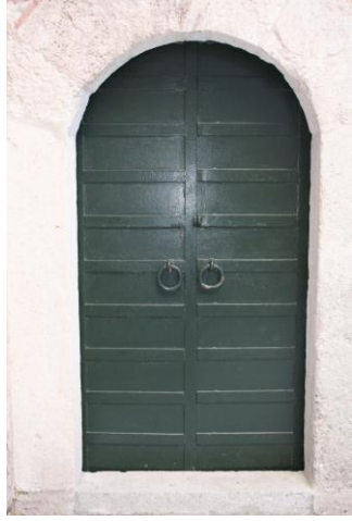
Resim 3.195. Bodrum kat giriş kapısı onarımdan sonra
