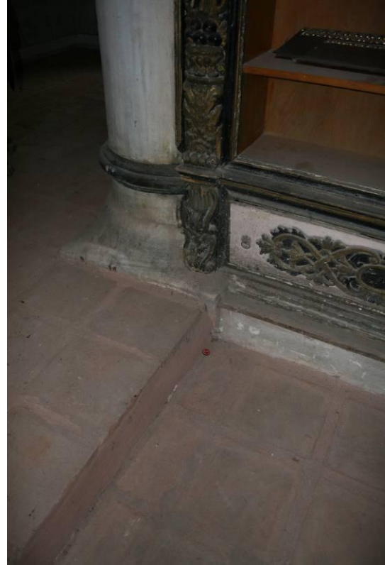
Resim 2.35. Zemin kat zemin döşemesinde kare kesitli pişmiş tuğla
