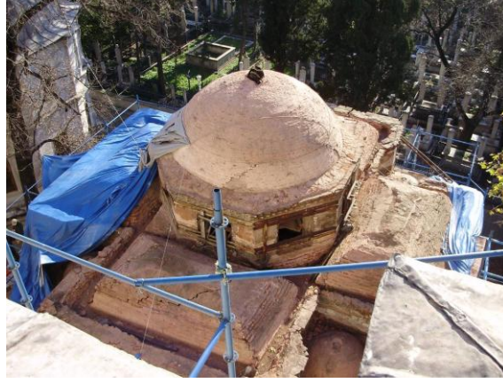
Resim 3.55. Kurşun üst örtü ve horasan dolgular alındıktan sonra ortaya çıkan ahşap hatıl yuvaları
