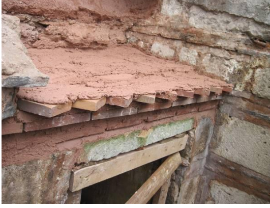
Resim 3.164. 45° açı ile yerleştirilmiş saçak tuğlaları ve horasan harcı
