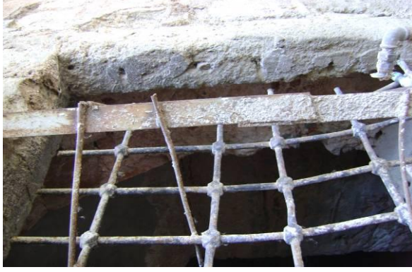
Resim 3.79. Bodrum kat pencerelerinde demir lokmalı parmaklık
