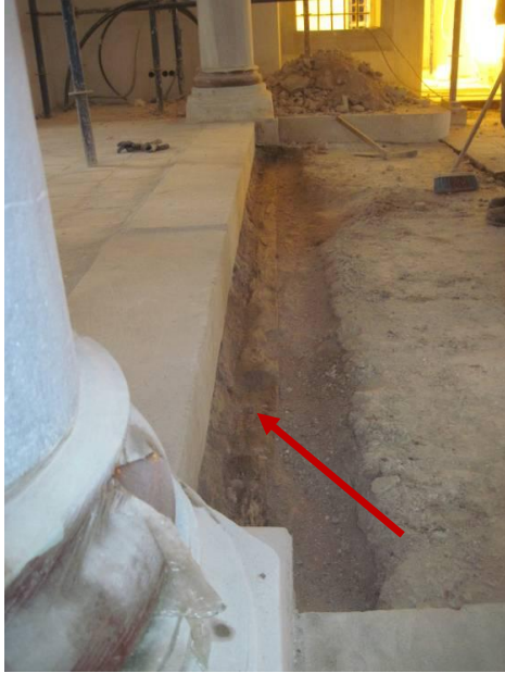
Resim 3.26. Zemin kat döşeme altında ahşap hatıl
