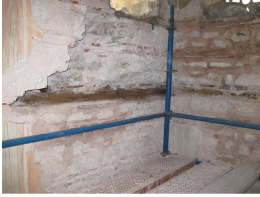
Resim 3.21. Köşe kubbe pencere alt hizasındaki ahşap hatıl yeri
