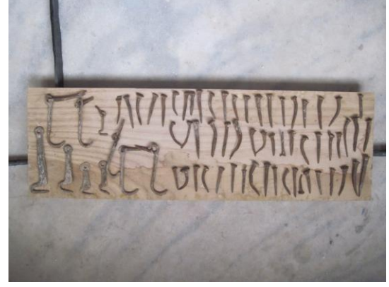
Resim 3.188. Kepenk onarımlarından çıkan paslanmış çiviler
