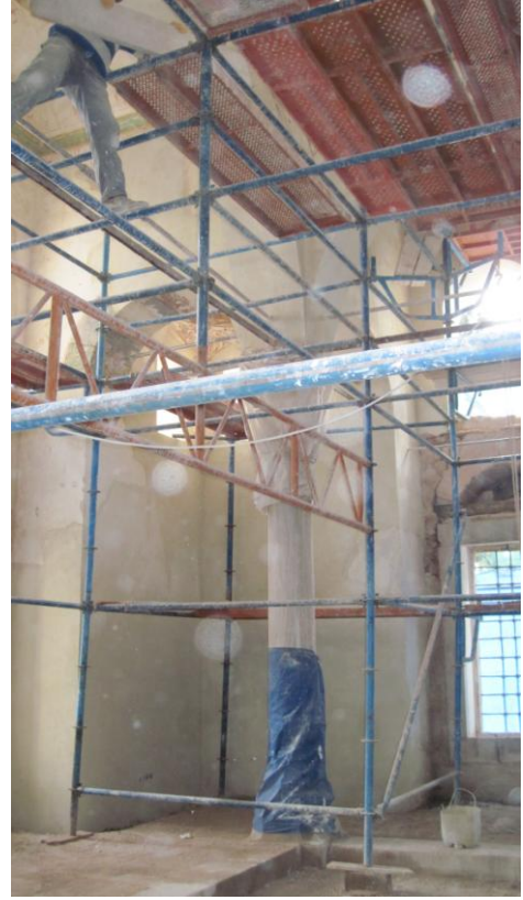
Resim 3.167. İnce horasan sıva yapımı
