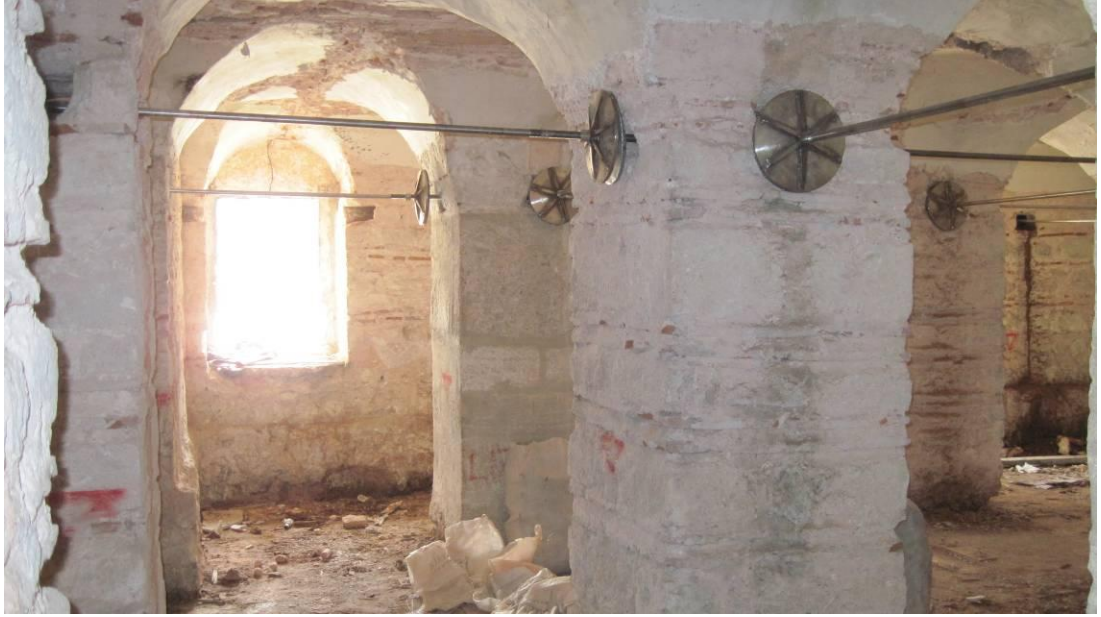
Resim 3.96. Ahşap hatlı boşluklarından geçirilen paslanmaz çelik gergiler
