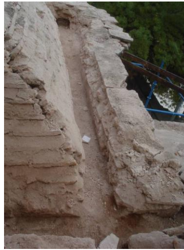
Resim 3.57. Tonoz etrafından geçen ahşap hatıl yeri
