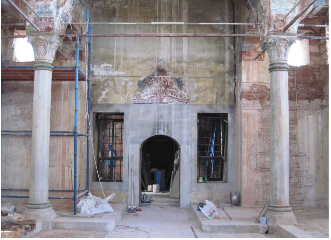
Resim D.1. Ana mekan giriş kapısı
