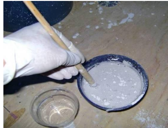
Resim 3.135. Malta 6001 enjeksiyon harcının hazırlanması
