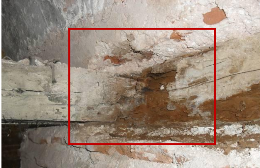
Resim 3.9. Paye içinde bindirme tekniği ile bağlanan ahşap hatıllar
