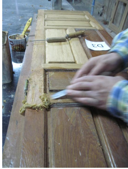
Resim 3.184. Boya sökücü ile temizlik
