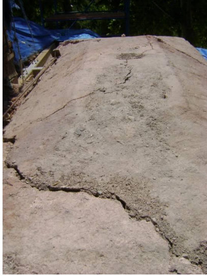
Resim 3.123. Kriko ile kaldırılarak kendi özgün kotuna getirilen tonoz parçası
