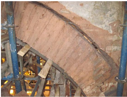
Resim 3.39. Güneydoğu kemerinin sütuna oturduğu yerden ayrılması (ön görünüş)
