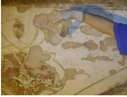
Resim 3.144. Duvardan ayrılmış sıva tabakalarına enjeksiyon yapılması
