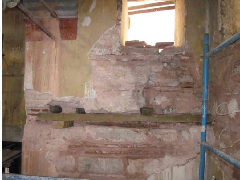
Resim 3.105. Pencere altında ahşap hatıl
