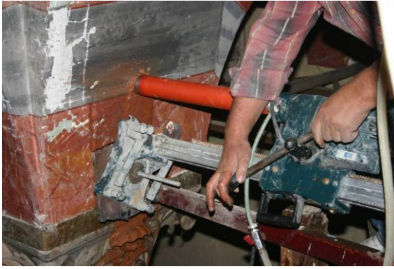
Resim 3.92. Karot makinesiyle kemerde mevcut gergi üzerine delik açılması
