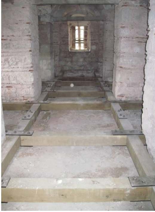
Resim 3.115. Paye altlarındaki çürümüş ahşap hatıllar yerine yapılan emprenyeli ahşap hatıl sisteminin paslanmaz çelik levha ve bulonlarla bağlanarak yerine oturtulması
