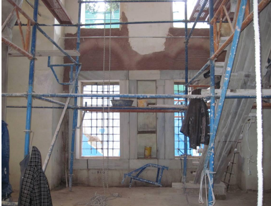
Resim 3.110. Hatıl yerleştirme işleminden sonra kendi özgün tuğla dokusuyla örülerek kapatılan kemer aynaları
