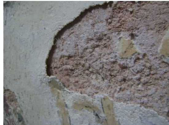
Resim 3.141. Kılcal çatlakların enjeksiyon sonrası kendi özgün sıva malzemesi ile kapatılması
