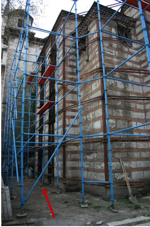
Resim 3.5. Zemin açılmadan evvel toprak altında kalmış bodrum kat
