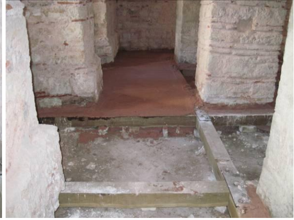
Resim 3.116. Horasan harcıyla dolgusunun yapılması
