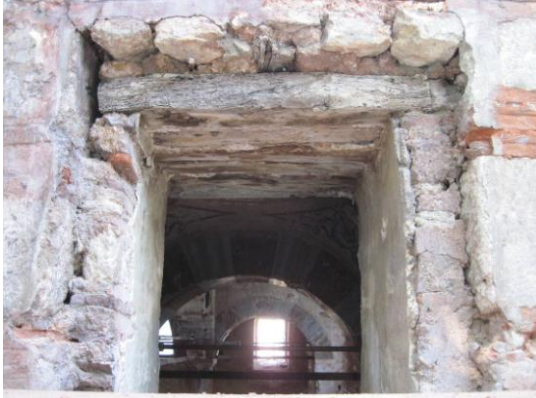
Resim 3.30. Pencere üstlerinde lento olarak ahşap hatıl
