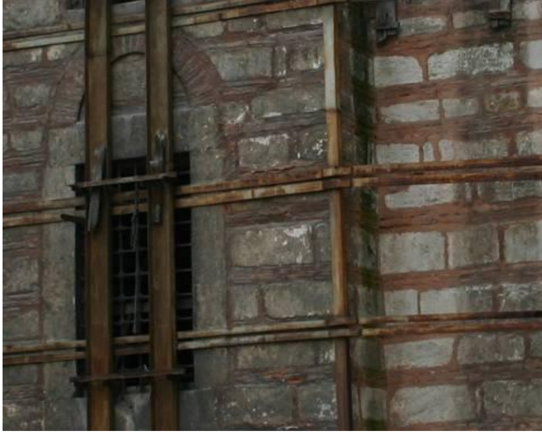
Resim 3.14. Duvar örgüsünde küfeki taşı ve söve
