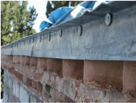
Resim 3.154. Saçakta kurşun kaplama ve çiviler
