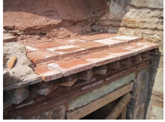
Resim 3.165. Düz olarak yerleştirilmiş saçak tuğlaları
