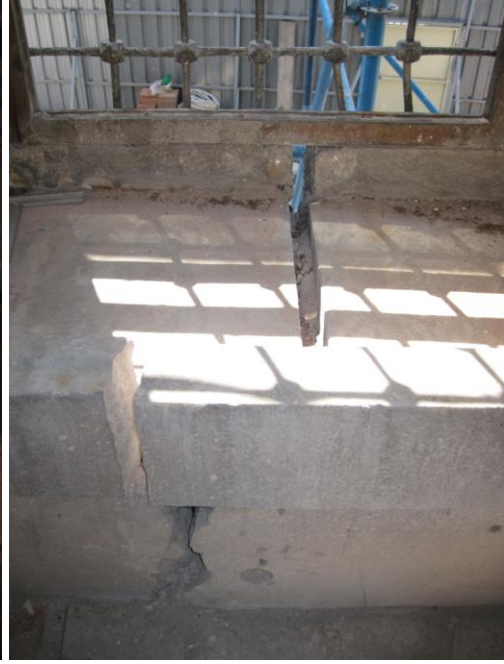
Resim 3.174. Pencere içinde ayrılma
