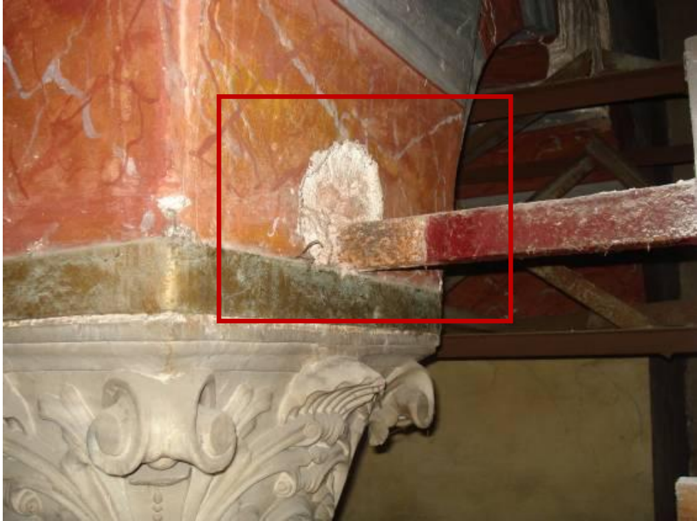
Resim 3.43. Sütun başı kemer birleşimlerinde yerinden oynamış demir gergiler
