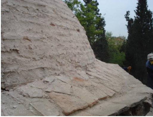
Resim 3.98. Kubbe eteğindeki horasan harçlı moloz dolgu alınmadan önce
