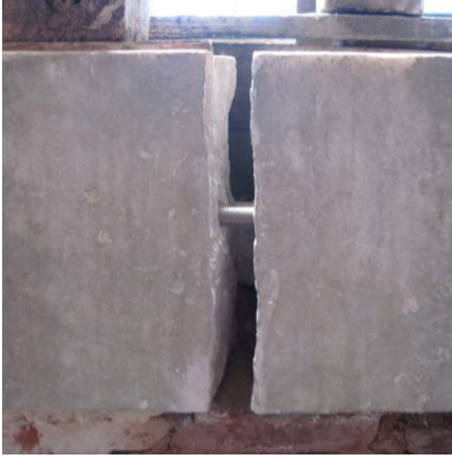
Resim 3.179. Zıvana ile söve parçalarının birbirine bağlanması
