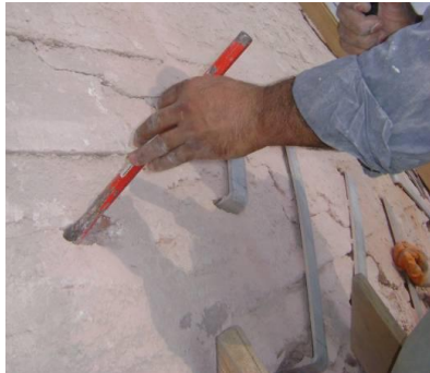
Resim 3.146. Kenetler için yuva açılması
