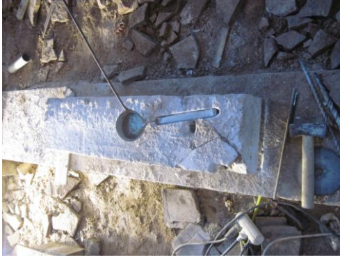
Resim 3.177. Sövedeki çatlağın kenet ile tamiri ve kurşun dökülmesi
