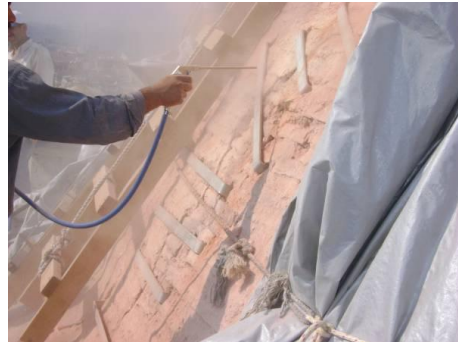
Resim 3.147. Yuvalarda kompresör ile temizlik yapılması
