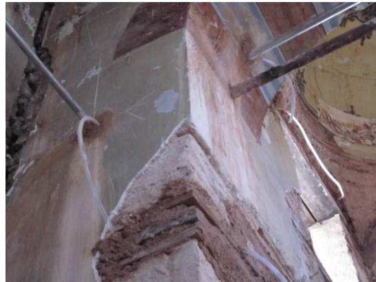
Resim 3.94. Enjeksiyon için bırakılmış hortumlar
