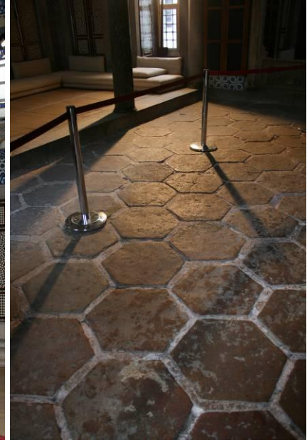
Resim 2.13. Döşemede şeshane tuğlaları
