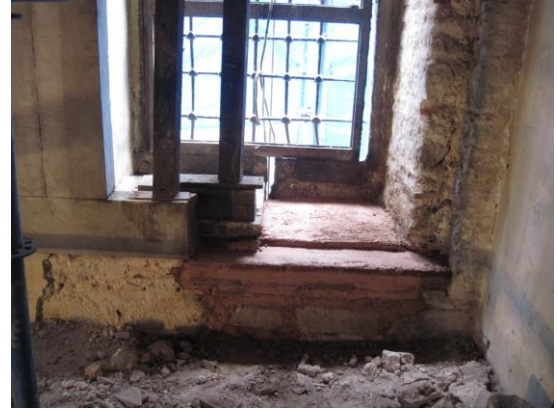
Resim 3.176. Onarım sonrası pencere altı
