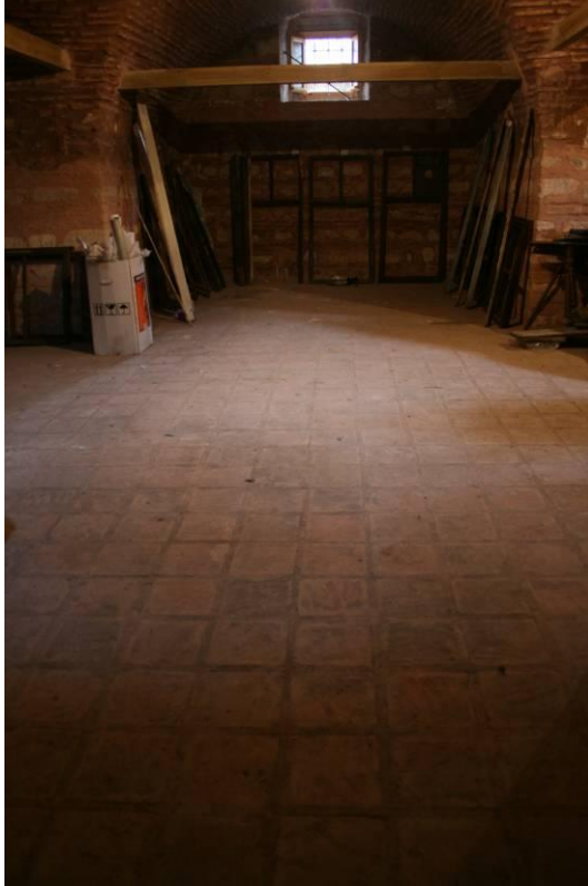
Resim 2.34. Bodrum kat zemin döşemesinde kare kesitli pişmiş tuğla
