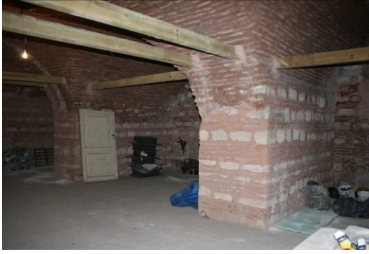
Resim 2.30. Bodrum kat duvarlarında ahşap ahşap gergiler
