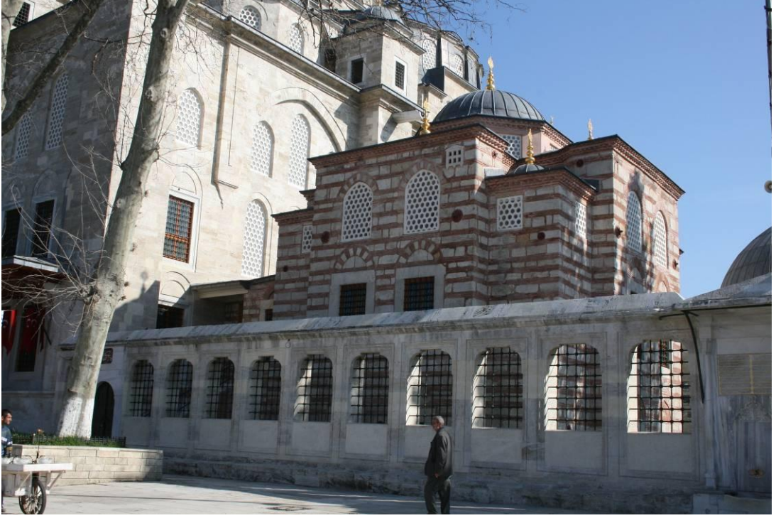
Resim E.1. Güneybatı cephesi
