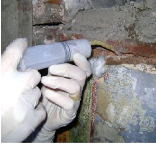
Resim 3.136. Malta 6001 enjeksiyon harcının açılan deliğe enjekte edilmesi
