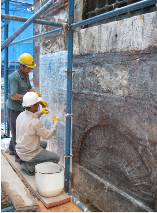
Resim 3.156. Cephede AB 57 ile temizlik yapılması
