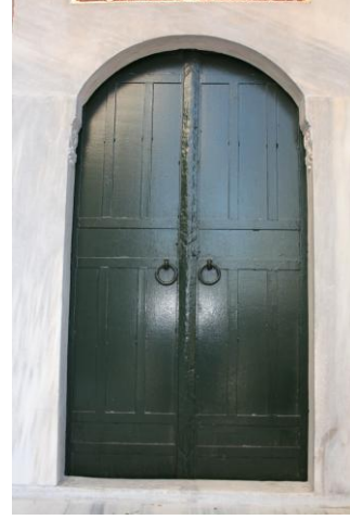
Resim 3.196. Zemin kat giriş kapısı onarımdan sonra
