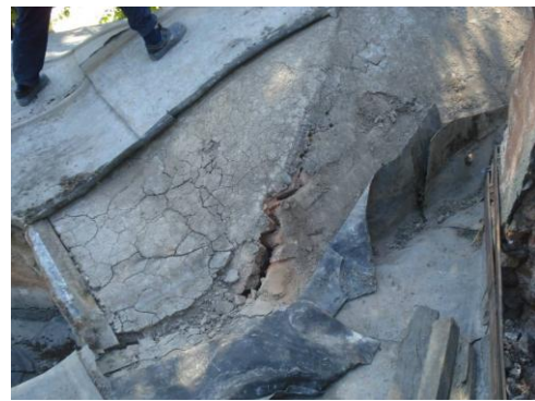
Resim 3.61. Kurşun örtünün altında çamur sıva
