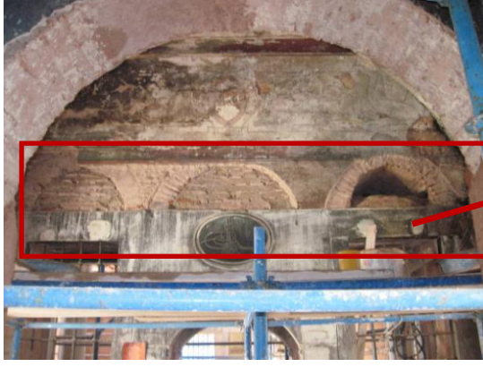
Resim 3.24. Kapı üstü kemer aynası içinde ahşap hatıl
