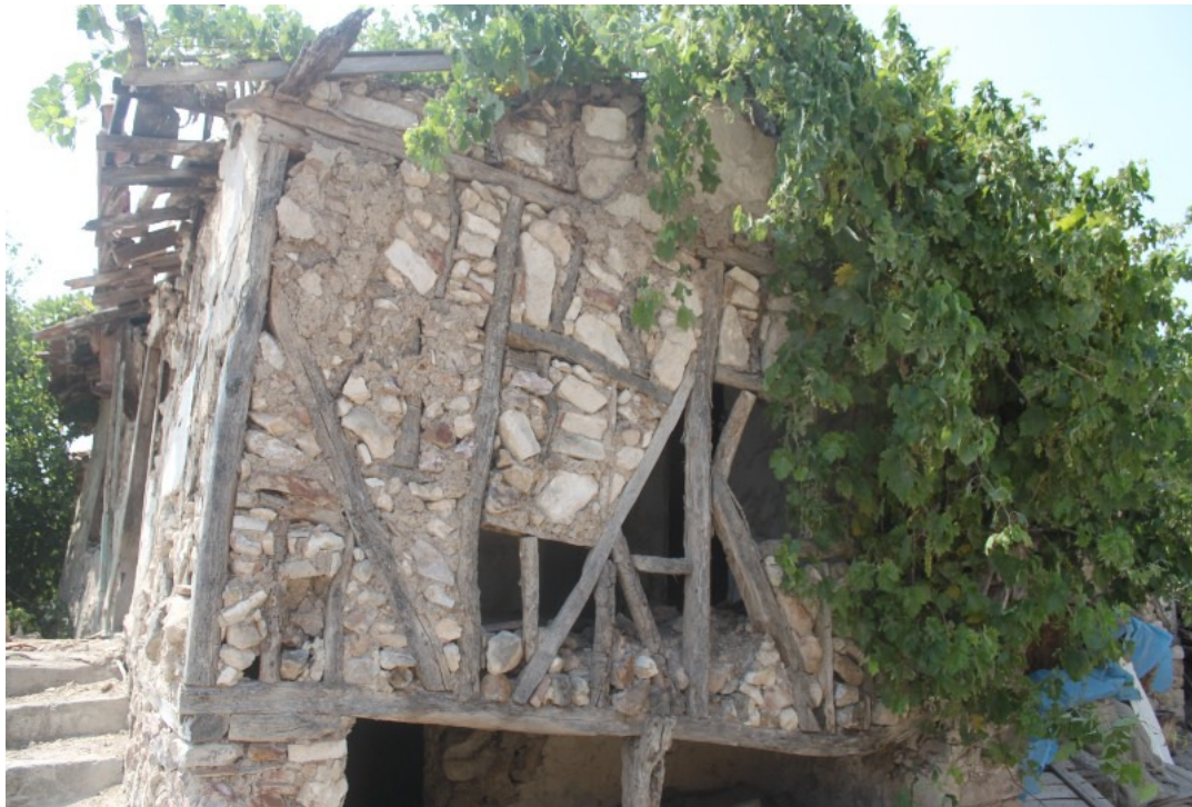
Şekil 3.178. İbroş Gamsız Evi yan cephe
