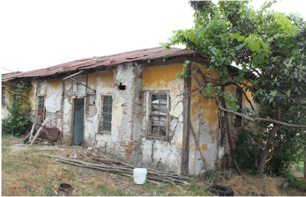
Şekil 3.57. Birol Karaçoban Evi giriş cephesi
