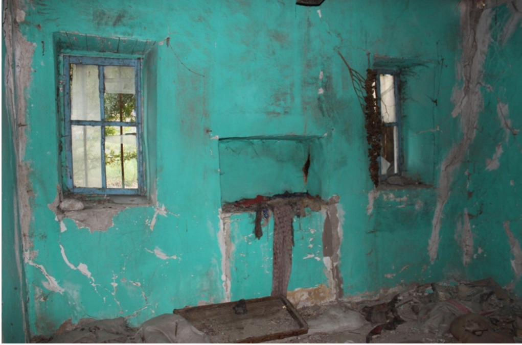
Şekil 3.116. Büyük odada yer alan kapatılmış ocak
