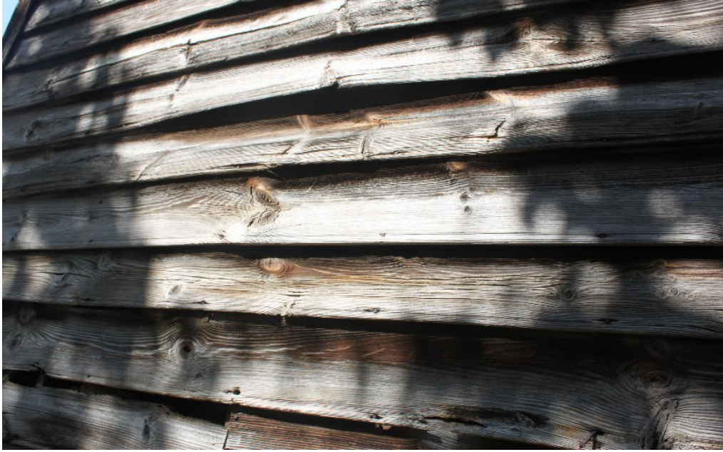
Şekil 3.231. Dış cephede yer kalan ahşap yalı baskısı uygulama
