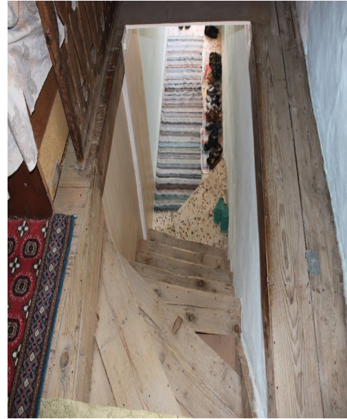
Şekil 3.225. Merdiven açıklığından görünüm
