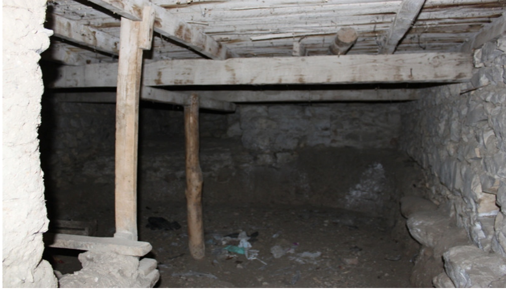
Şekil 3.122. Halil Uçkıran Evi bodrum kat görünüşü
