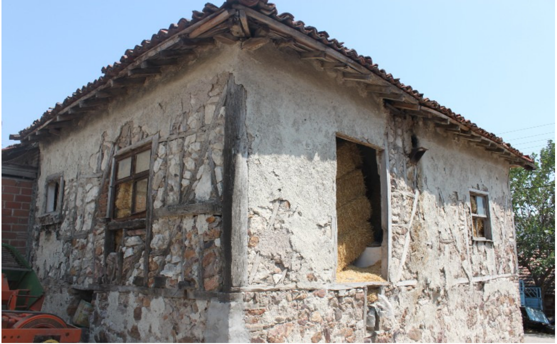
Şekil 3.183. Arif Erdem Evi'nin yan ve arka cephesi
