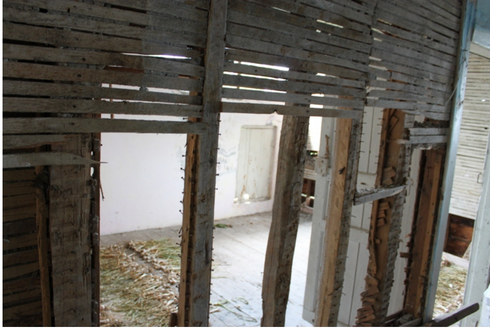
Şekil 3.50. İç duvarlarda görülen bağdadi sistem
