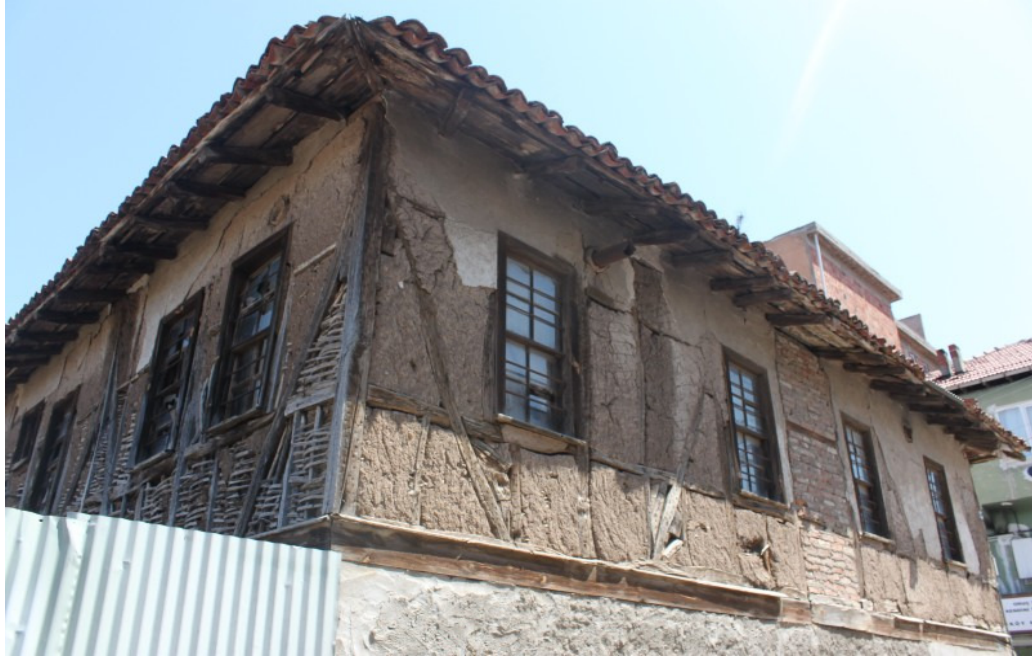
Şekil 3.208. Halil İbrahim Orhan Evi'nde sokak cephesine ve avlu cephesine bakış
