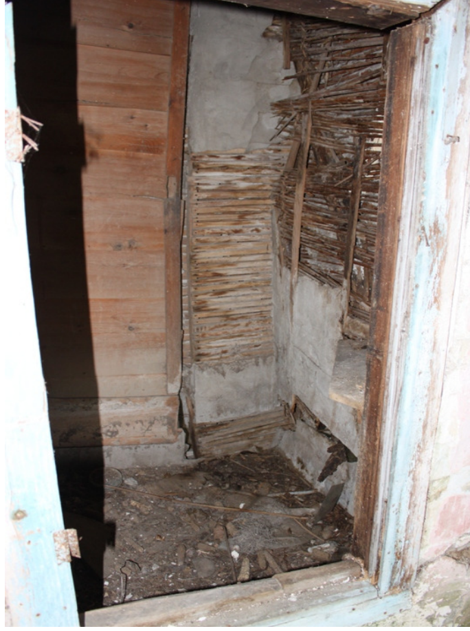
Şekil 3.20. Depo bölümünün koridora açılan kapısından görünümü
