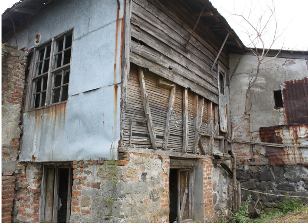
Şekil 3.26. Yapının geçirdiği yapılaşma dönemlerini gösteren yan cephe fotoğrafı
