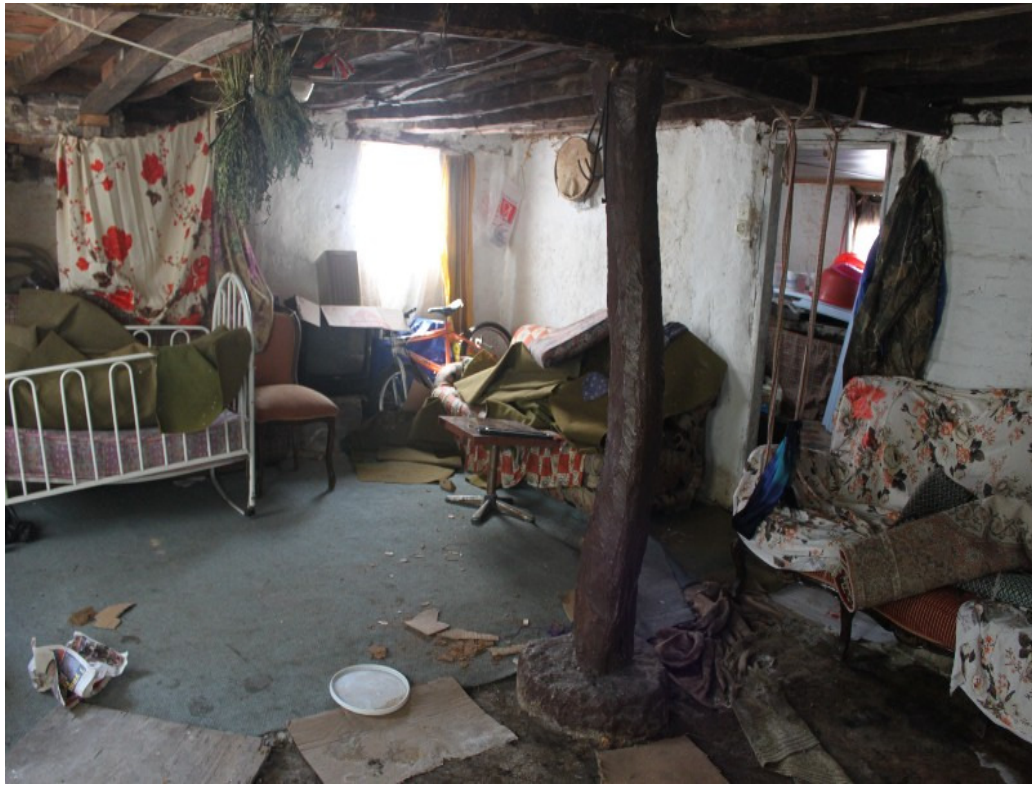
Şekil 3.216. Hasan Balta Evi giriş katta yer alan taşıyıcı ve giriş sistemi
