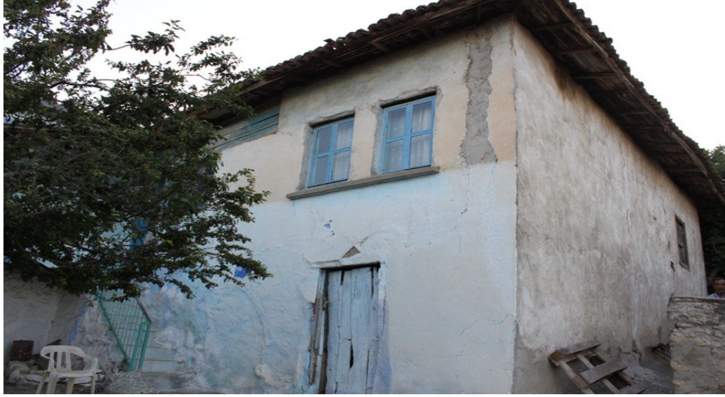
Şekil 3.111. Mustafa Boz Evi'nin giriş cephesinden görünüş
