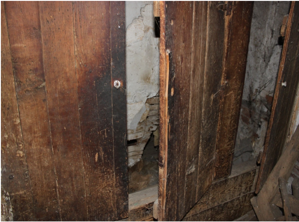
Şekil 3.97. Musandıra bölümünün banyo+yükçük kapılarının görünümü
