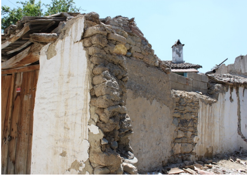
Şekil 3.150. Bozköy’de yıkım çalışmaları sonucunda ortaya çıkan inşaat malzemesi
