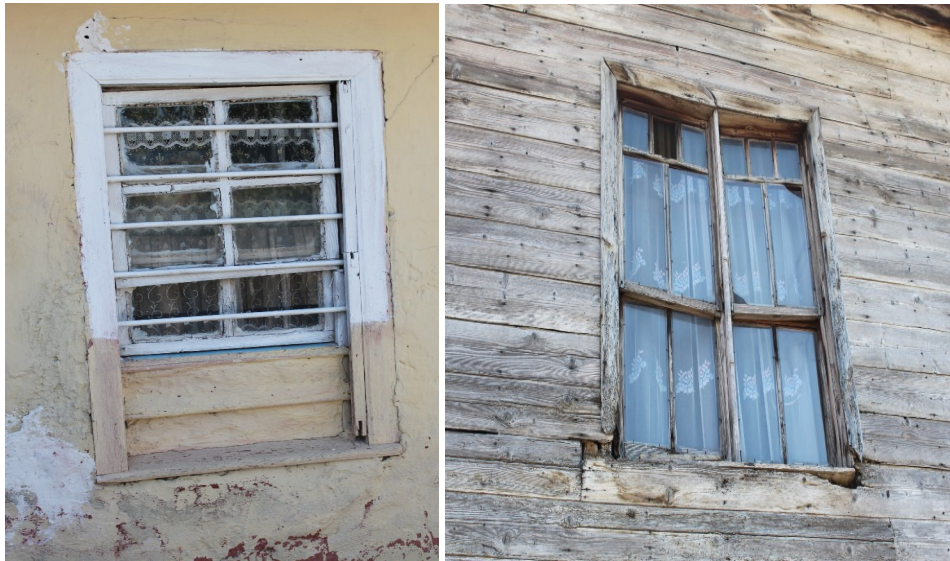
Şekil 3.230. İnönü Caddesi, No. 10'daki evin üst kat ve alt kat özgün pencere detayı
