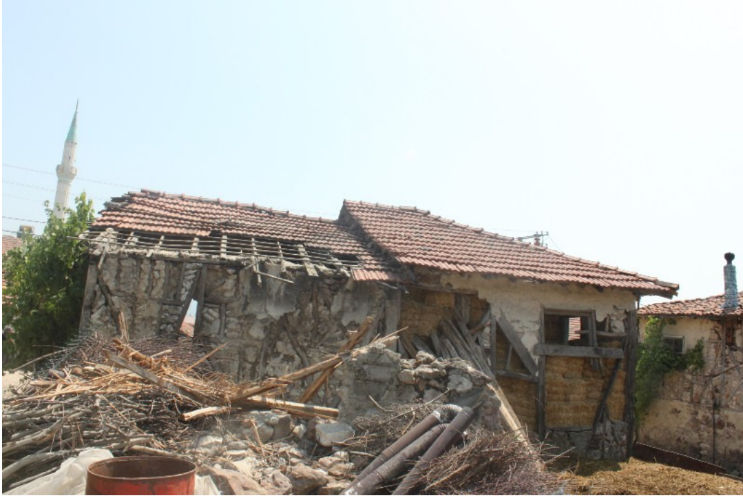
Şekil 3.179. İbroş Gamsız Evi arka cephe
