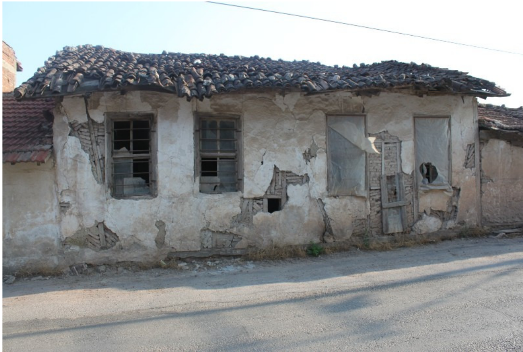
Şekil 3.202. Mümin Barak Evi'nin yol cephesinden görünümü
