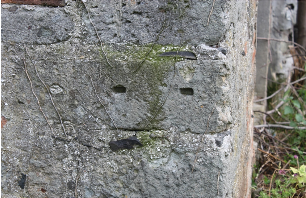
Şekil 3.28. Yapının duvarlarında kullanılan devşirme malzeme
