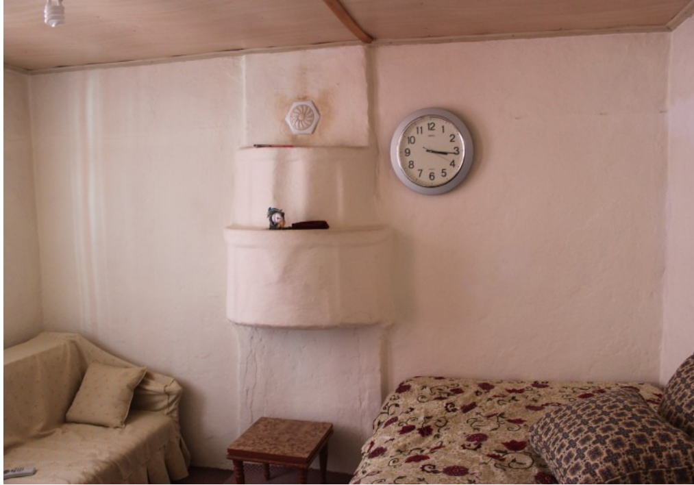
Şekil 3.221. Yol cephesinde yer alan odanın iç duvarında bulunan ocak ve yaşmağı
