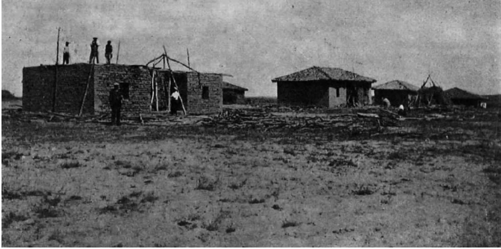
Şekil 3.271. Köy evlerinin kerpiç malzeme ile yapım sürecinden görünüm ( Sayar 1936a, syf. 50)
