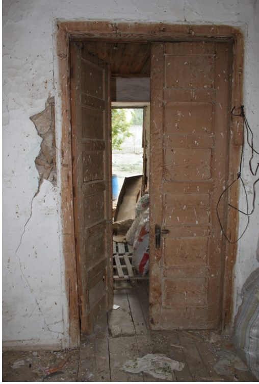
Şekil 3.119. Giriş kapısının içten görünüşü
