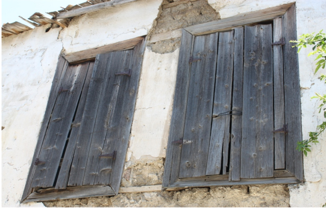
Şekil 3.146. Sokağa bakan üst kattaki odanın pencere kapakları
