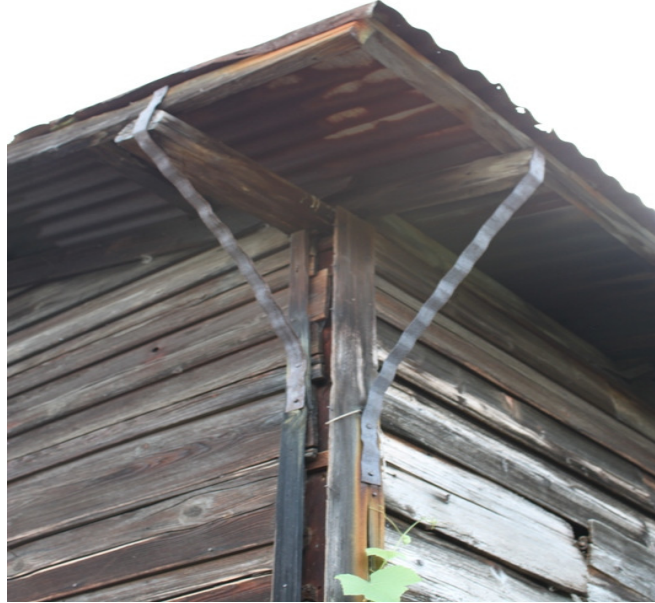
Şekil 3.36. Oluklu saç üst örtünün rüzgar etkisiyle uçmasını engellemek amacıyla çivi yardımıyla sabitlenen metal şeritler
