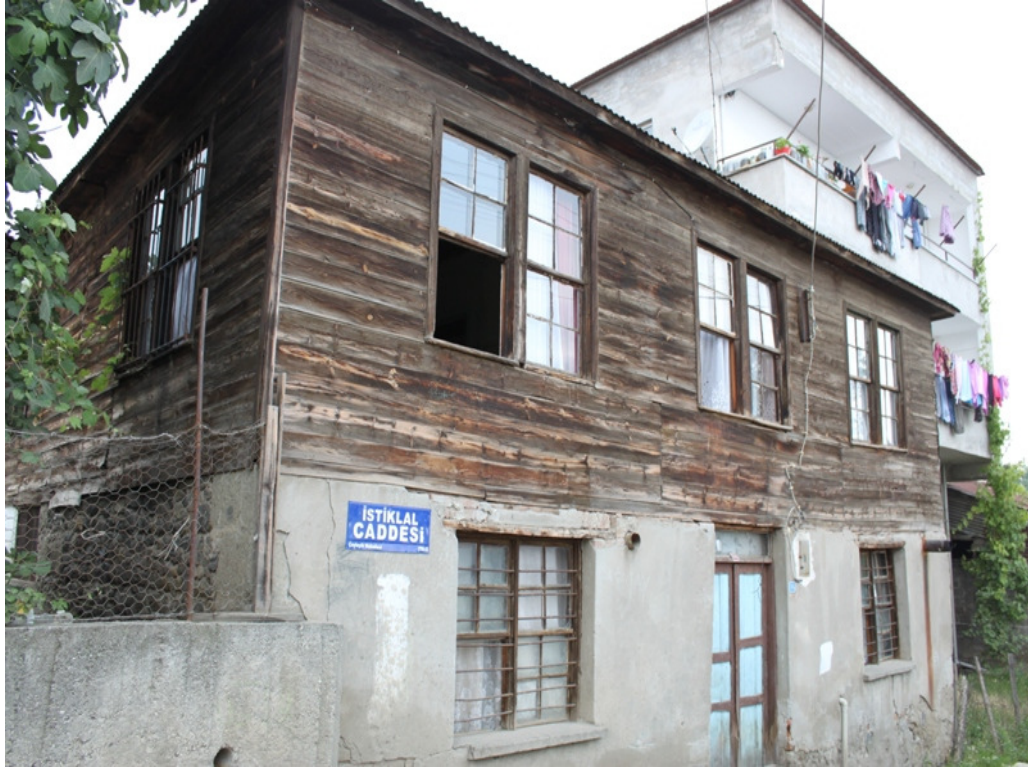
Şekil. 3.83. Cavut Osmanlar Evi, ana caddeye bakan cephe
