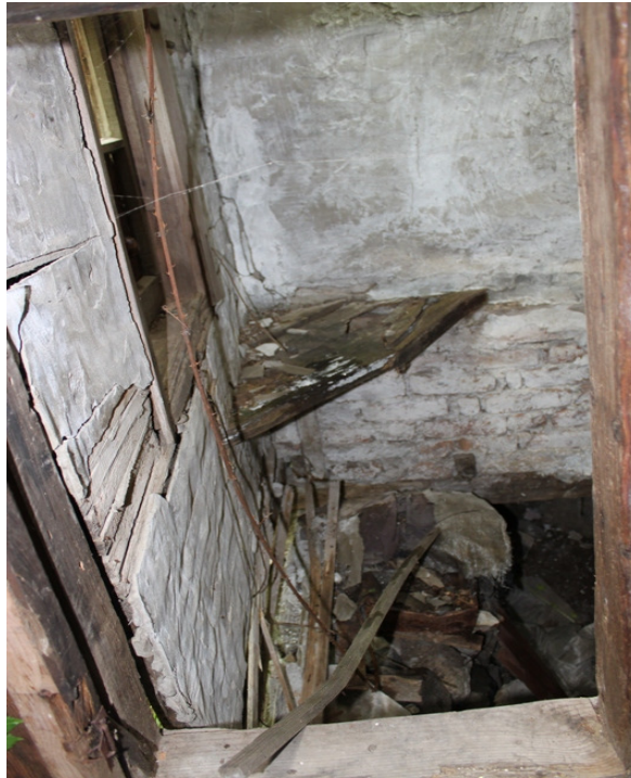
Şekil 3.19. Gusülhane / banyo bölümünün kapı açıklığından görünümü
