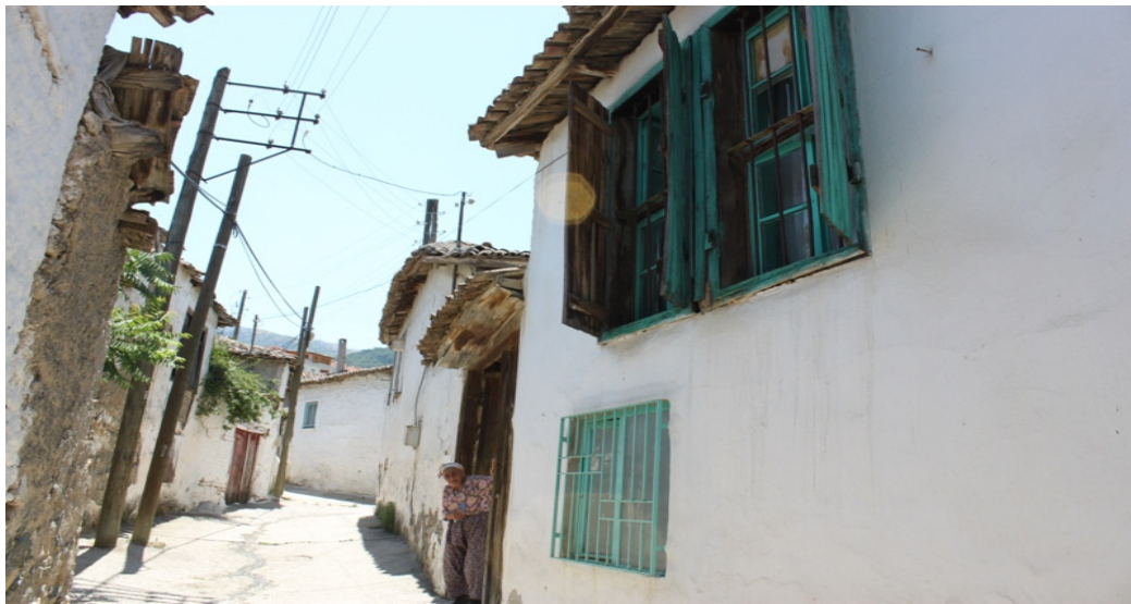
Şekil 3.142. Şevket Gülseven Evi'ne sokaktan giriş
