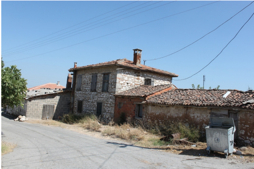
Şekil 3.158. İki katlı ve ek birimleriyle tespit edilen Rum evinin sokaktan görünümü
