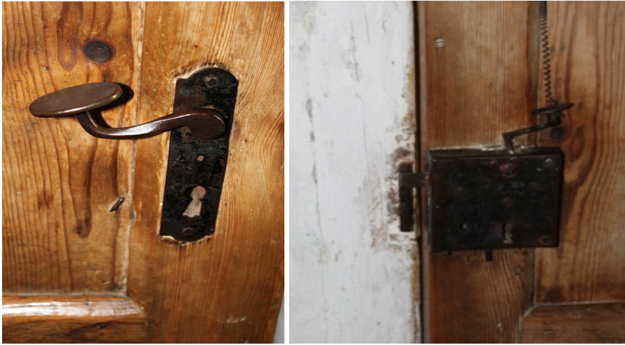
Şekil 3.38. Ahşap oda kapılarında yer alan kapı kolu ve kilit sistemi
