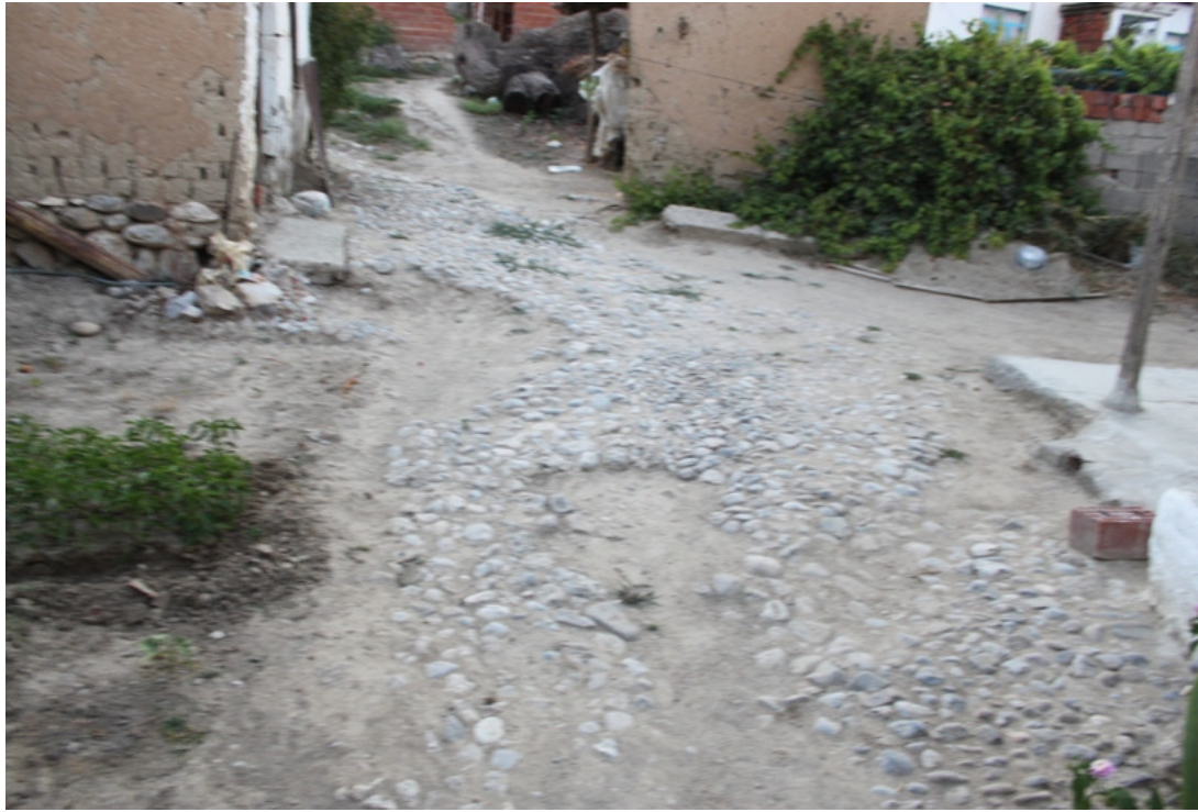
Şekil 3.138. Süleyman Karaca Evi avlu zemin taş döşemesinden görünüm
