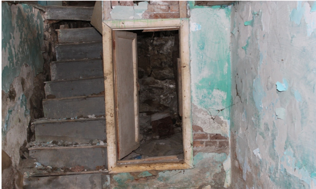
Şekil 3.55. Alt kata inen merdivenler ve bu katta tuğla ile oluşturulmuş oda düzenlemesi
