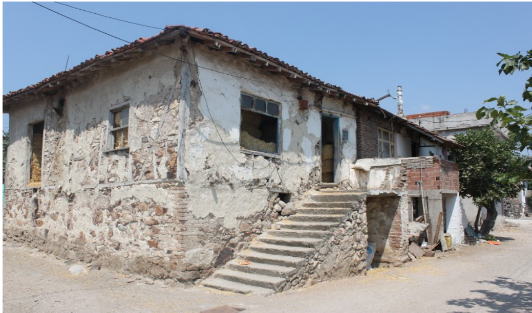
Şekil 3.182. Arif Erdem Evi'nin ön cephesi ve ek yapılar
