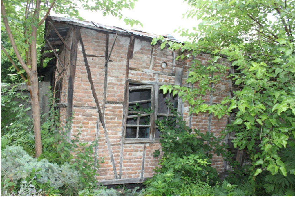
Şekil 3.27. Yapının gördüğü onarımlar sonucunda oluşan, taşıyıcı sistemin arası tuğla ile örülmüş cephe
