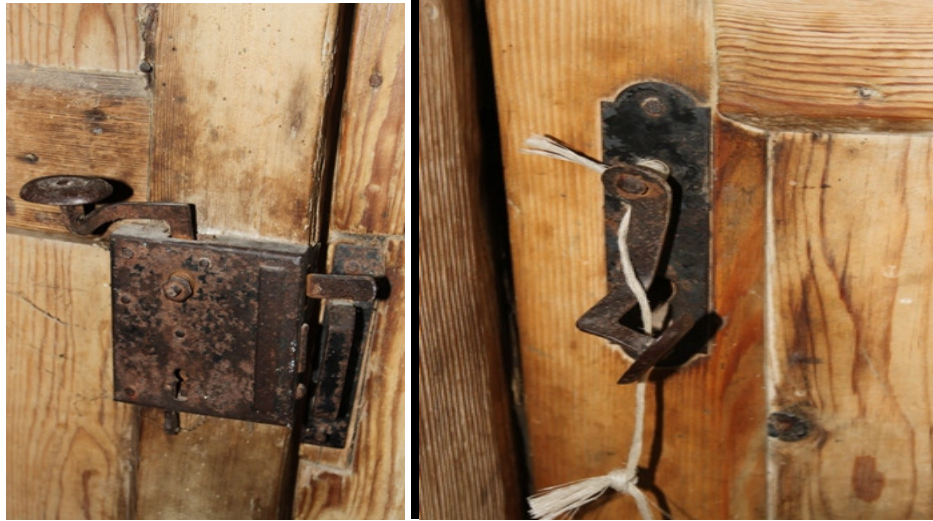
Şekil 3.65. Özgün kapı kilit kısımları
