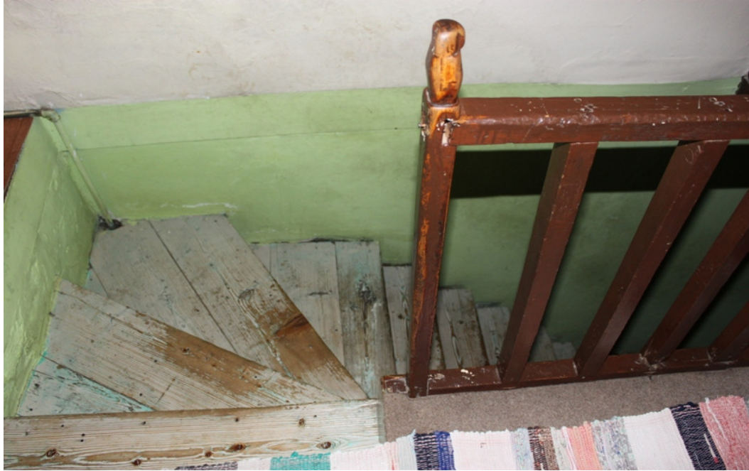
Şekil. 3.85. Cavit Osmanlar Evinde, alt kata inen merdivenler
