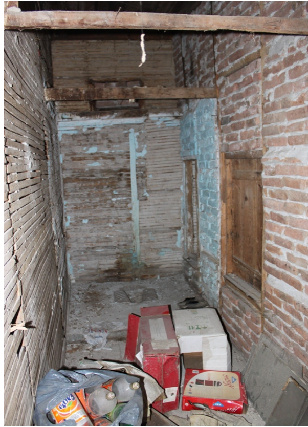
Şekil 3.46. Ara bölümlenmesi kaldırılmış banyo / gusülhane bölümü
