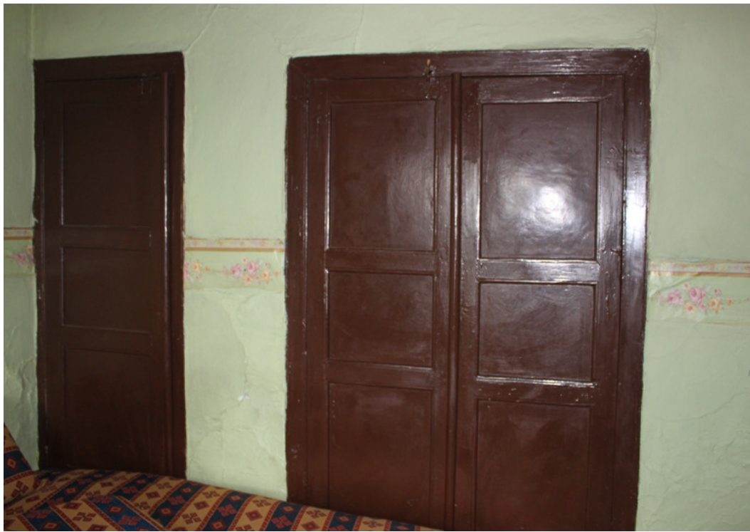
Şekil. 3.86. Musandra bölümünün ahşap giriş kapıları 78
