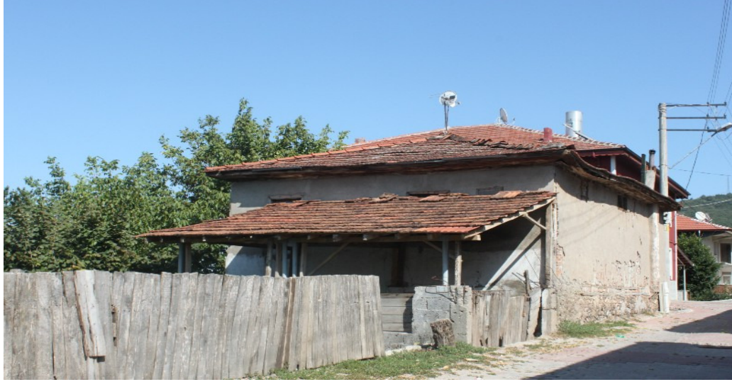
Şekil 3.217. Yavuz Akın Evi'nin yan ve yol cephesinden görünüm
