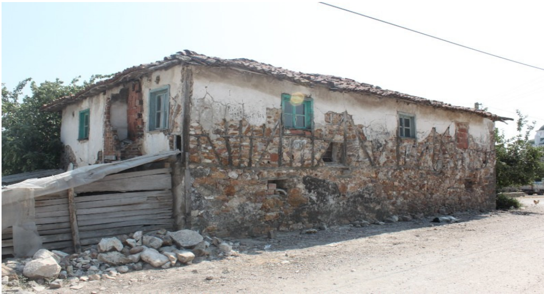
Şekil 3.193. Adil Çiçek Evi'nin sokak cephesinden görünümü
