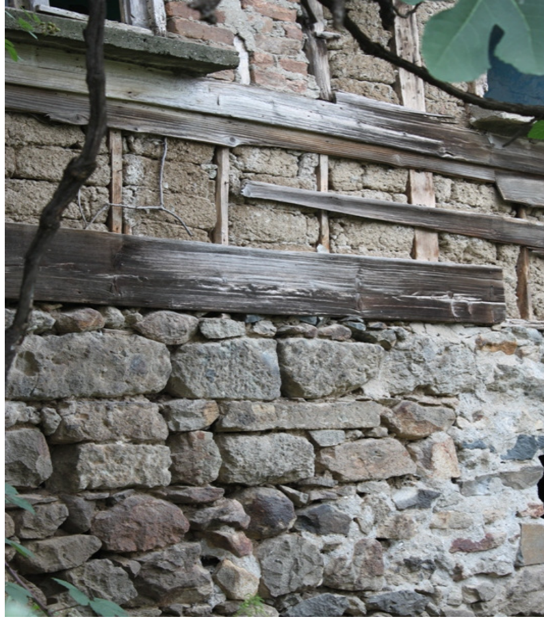
Şekil 3.74. Kazım Aydeniz Evi dış duvar detayı
