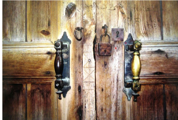
Şekil 3.210. Eve girişi sağlayan çift kanatlı kapı ve metal aksamı
