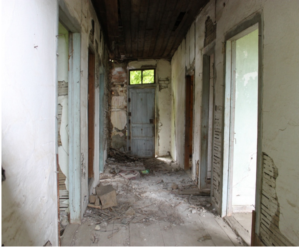
Şekil 3.17. Giriş kapısının açıldığı ve odalara geçişi sağlayan ana koridor
