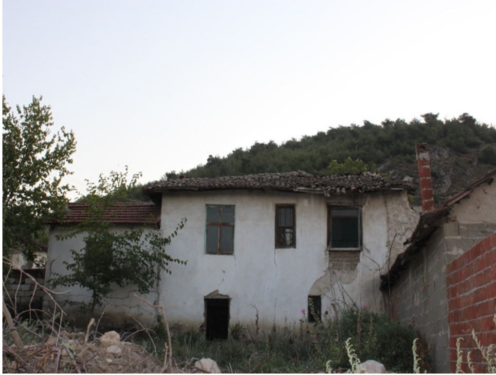
Şekil 3.113. Ümmügül Uzun Evi'nin arka cephesinden görünüm
