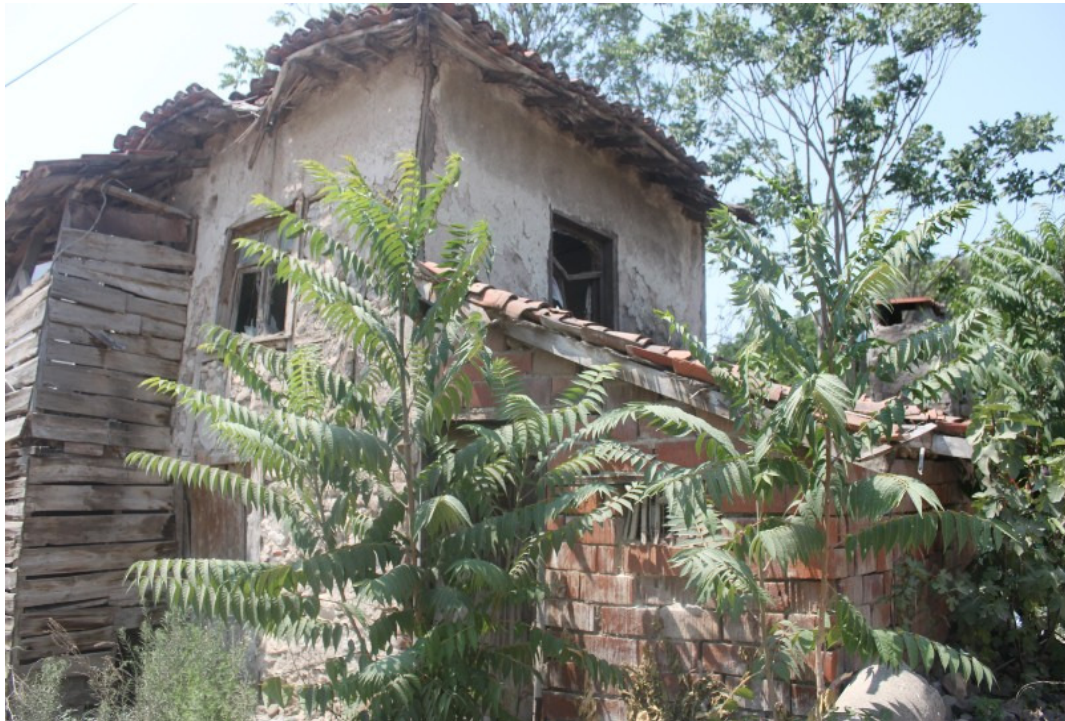
Şekil 3. 173. Ev bütünlüğüne dış cepheden eklenen yeni birim
