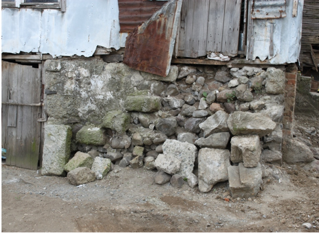
Şekil 3.90. Üç odalı plan tipindeki mübadil evinin, bodrum katında kullanılan devşirme malzeme
