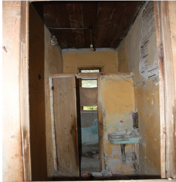
Şekil 3.60. Banyo /gusülhane bölümünün yan duvarlarla ilişkisinin kesilerek tuvalete dönüştürülmüş hali
