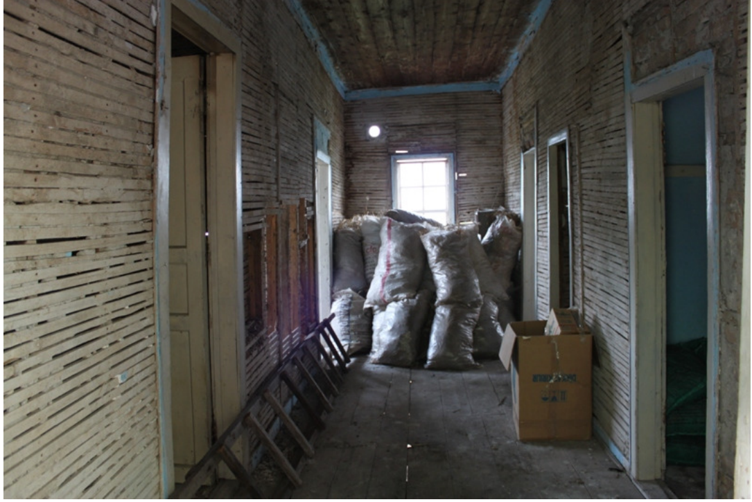
Şekil 3.45. Giriş kapısından koridor ve oda giriş kapılarına bakış
