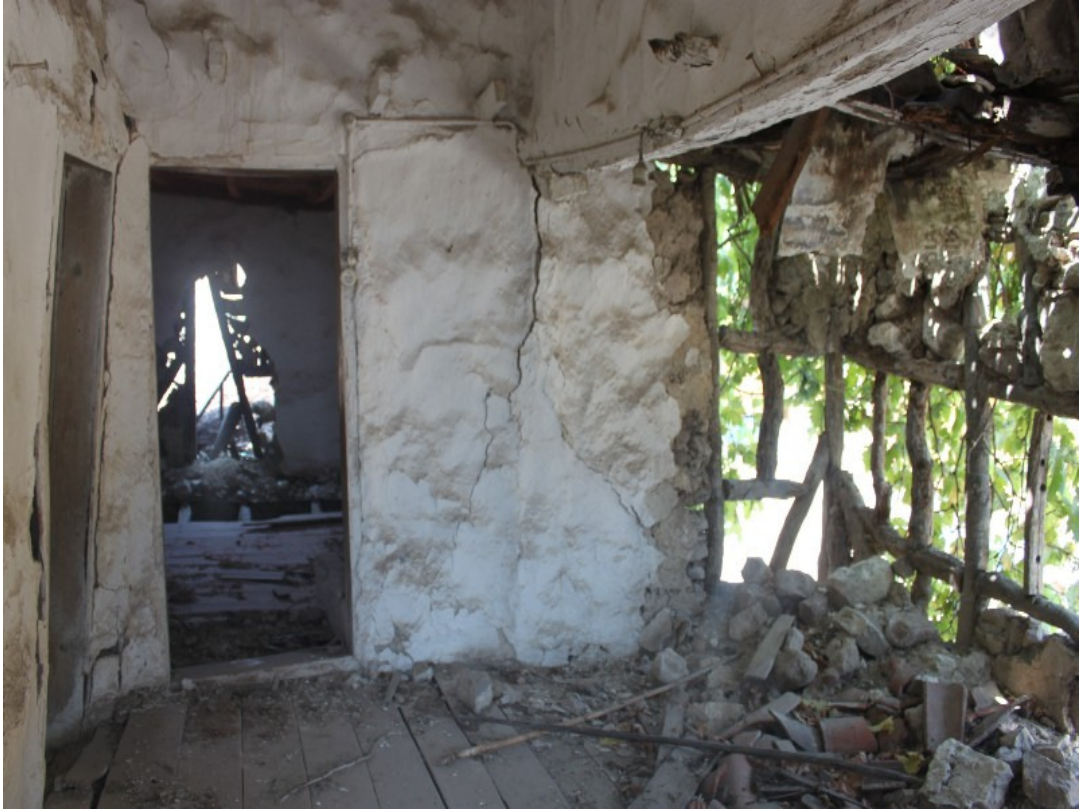
Şekil 3.180. Giriş kapısından geçildikten sonra ulaşılan ortak alan ve odaların giriş kapısı
