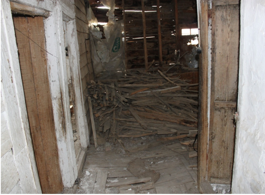
Şekil 3.96. Evin giriş bölümünden görünüm
