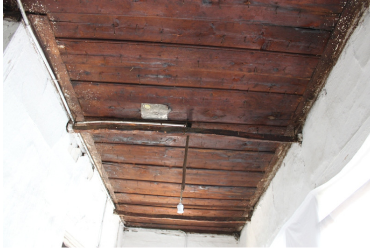
Şekil 3.33. Koridorun tavanında yer alan ahşap kaplama ve çivi başları
