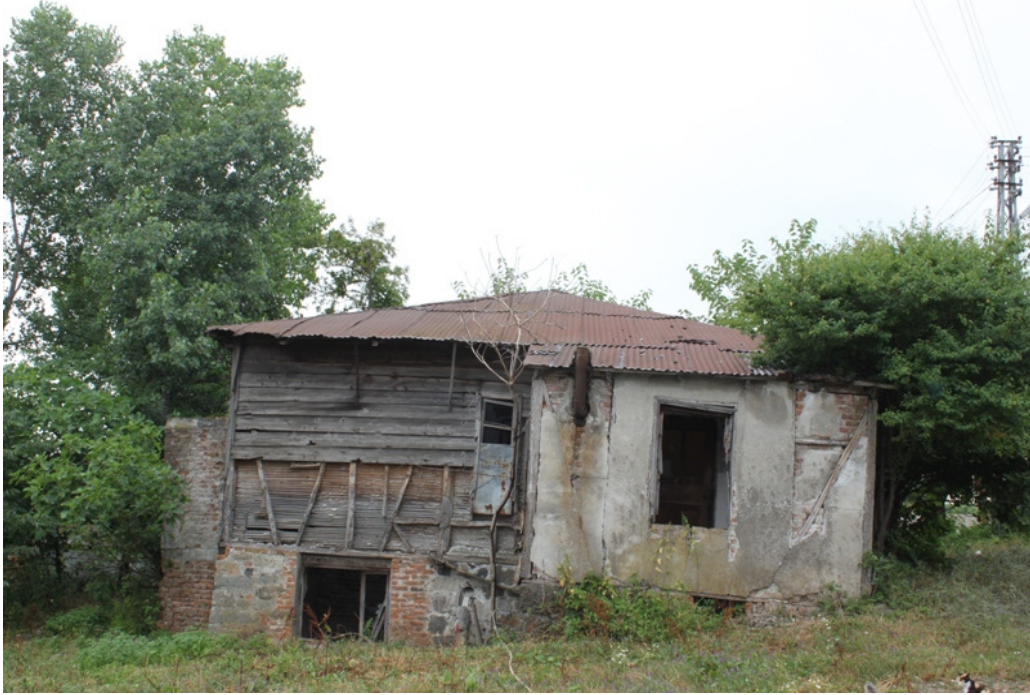
Şekil 3.15 Hacı Ahmet Evi'nin arka cephesi
