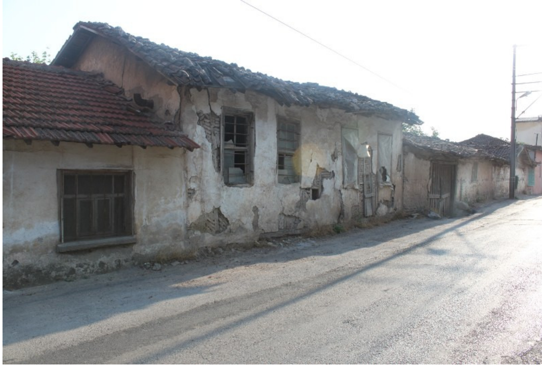
Şekil 3.201. Yolun alt kısmında yer alan Mümin Barak Evi+ahır ve samanlıktan görünüm
