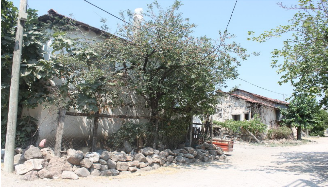
Şekil 3.184. Dört yanı yol ile çevrilmiş parsel içerisinde, sıra halinde mübadil evleri
