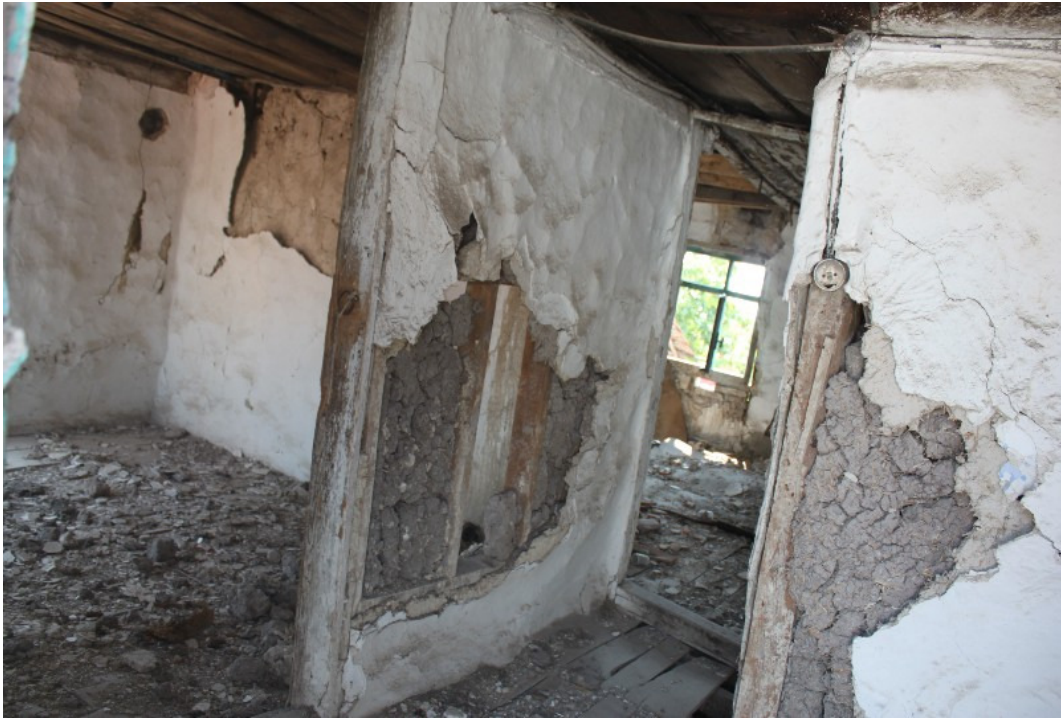
Şekil 3.191. Odaları ayıran iç duvarlar ve üçüncü odaya bakış
