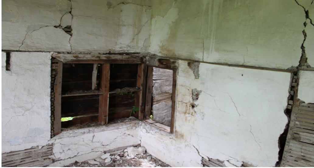
Şekil 3.18. Odadan gusülhane / banyo bölümüne geçişi sağlayan kapı
