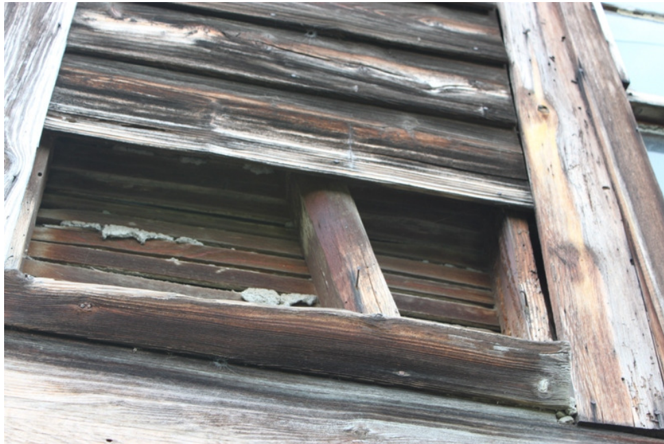
Şekil 3.51. Yalıtımsız dış cephe, ahşap karkas sistem ve iç cephede bağdadi sistemden görünüş
