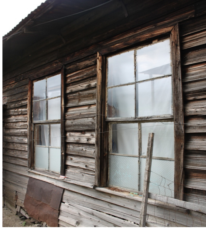
Şekil 3.37. Mustafa Bakan Evi'nin yan cephesinde yer alan özgün giyotin pencereler
