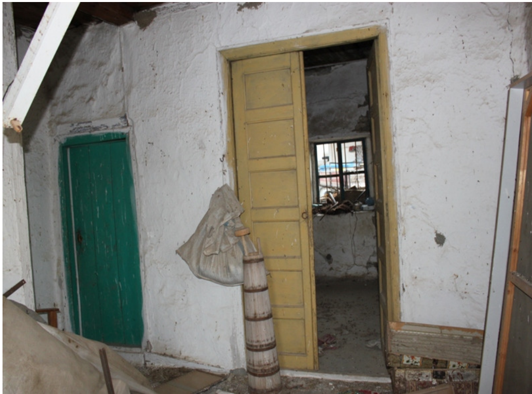
Şekil 3.126. Kapatılan tuvalet girişi ve değiştirilen mutfak ile özgün iki kapılı küçük oda kapısı
