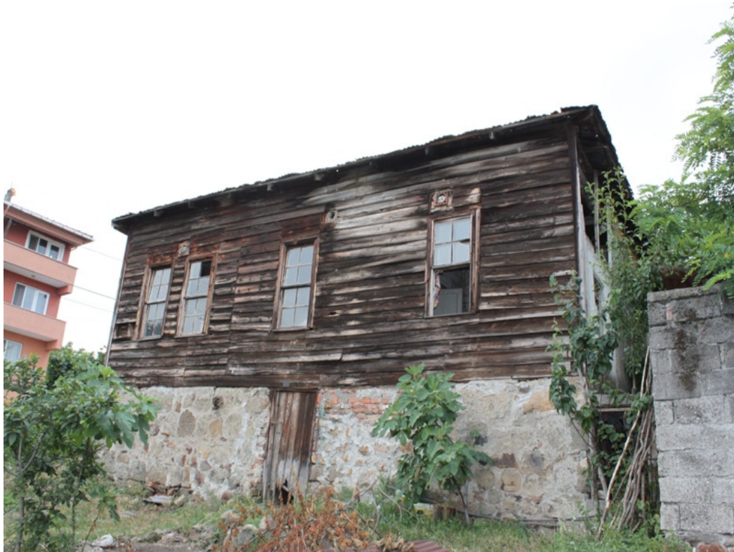
Şekil 3.44. Yapının özgünlüğünü koruyan arka cephesi
