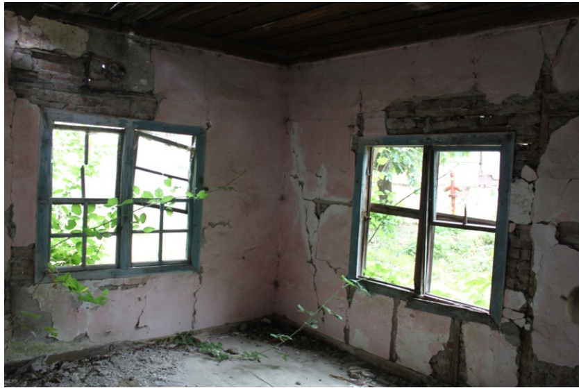
Şekil 3.21. Odalarda dışarıya açılan ikiz pencereler
