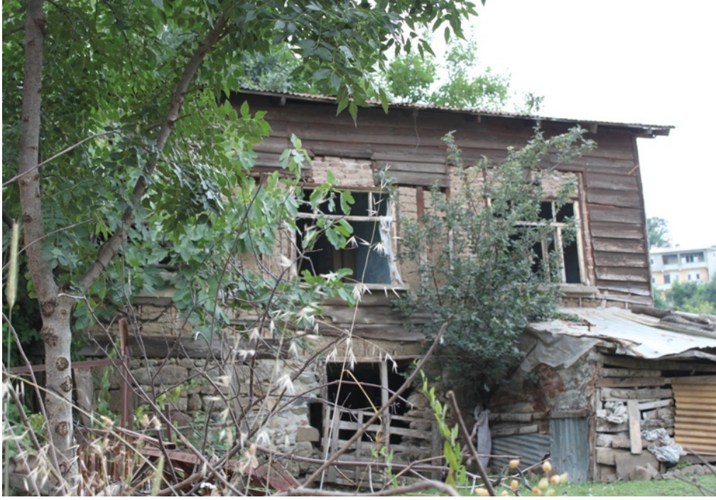
Şekil 3.68. Kazım Aydeniz Evi arka cephe
