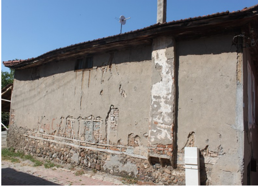
Şekil 3.219. Yavuz Akın Evi'nin yol cephesinde çatı altı pencere ve ocağın baca sistemi
