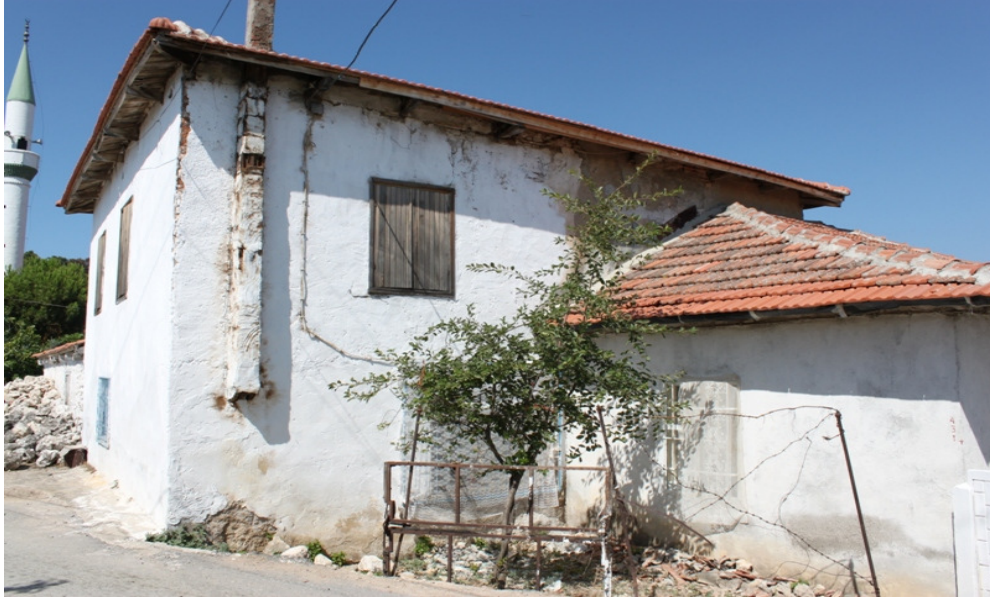
Şekil 3.155. Şevket Bayraktar Evi'nin ek birimleriyle görünüşü
