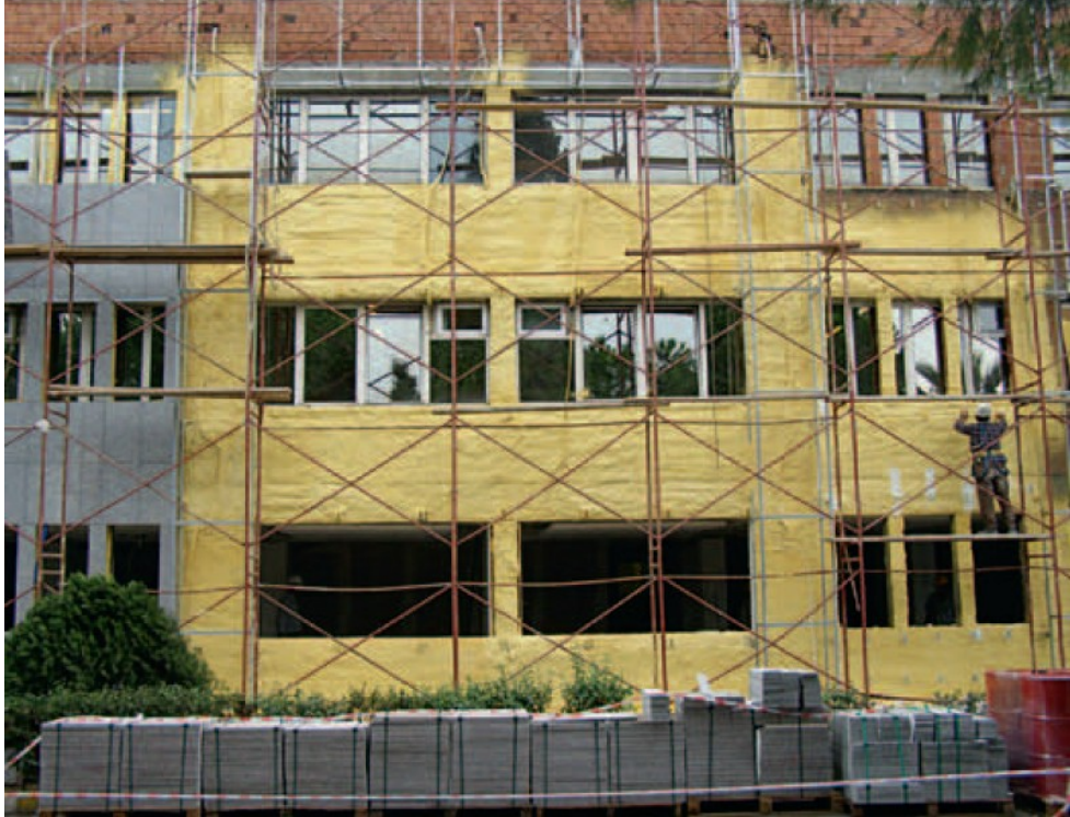
Şekil 5.15 BASF Türk Dilovası yönetim binası cephesine spreyc poliüretan köpük ısı yalıtımı ve dış cephe kaplaması uygulanması (URL-63).
