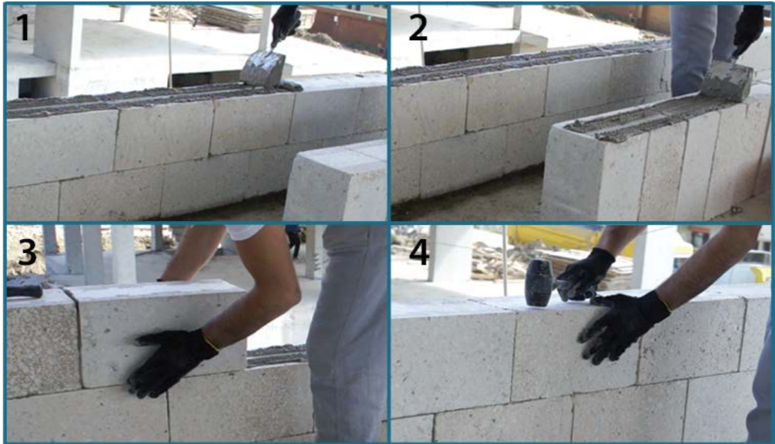
Şekil 2.4 İzoduo yalıtımlı duvar bloğu örme uygulaması (URL-5)
