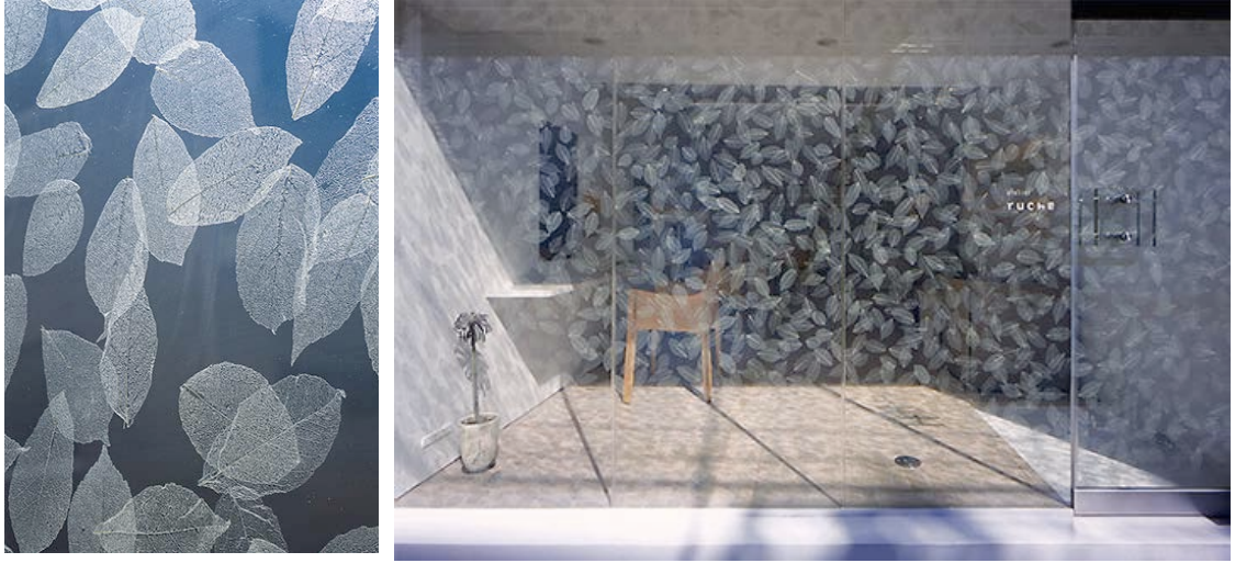
Şekil 4.65 Seramik kaplama yöntemiyle elde edilmiş cam ünitesi, Atelier Ruche, Tokyo, 2002 (URL-51).
