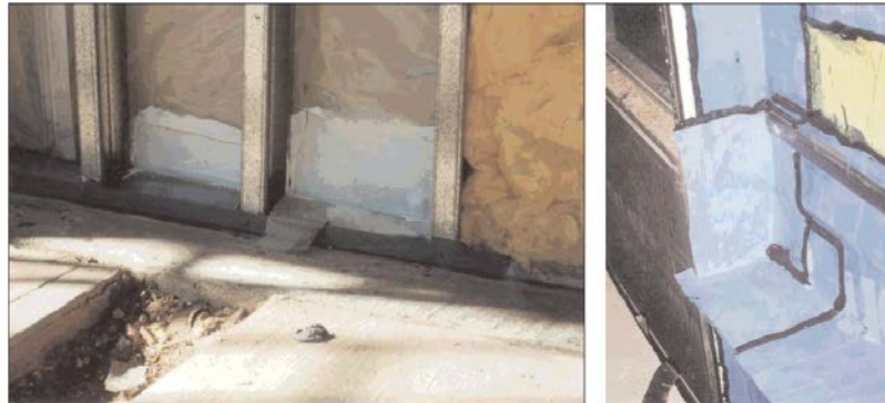
Şekil 5.11 Küf oluşumu tespit edilmiş duvara şelak bazlı astar uygulaması (URL-59)
