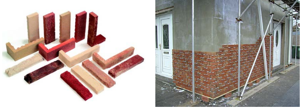
Şekil 4.53 Çeşitli plaket kaplama malzemeleri ve harçla tespit edilen bir plaket kaplama uygulaması (URL-39)
