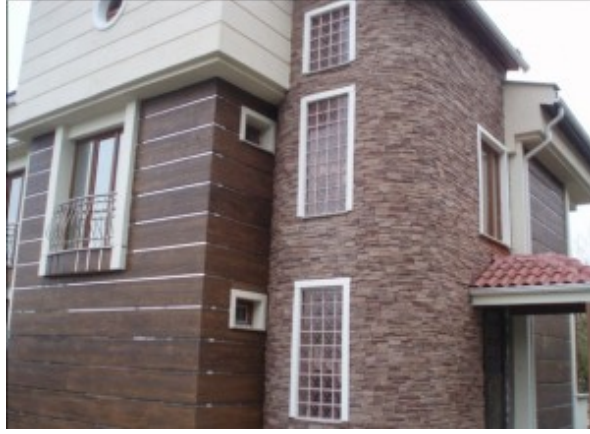
Şekil 4.61 Ahşap görünümlü çimento yonga levha uygulaması (URL-46).
