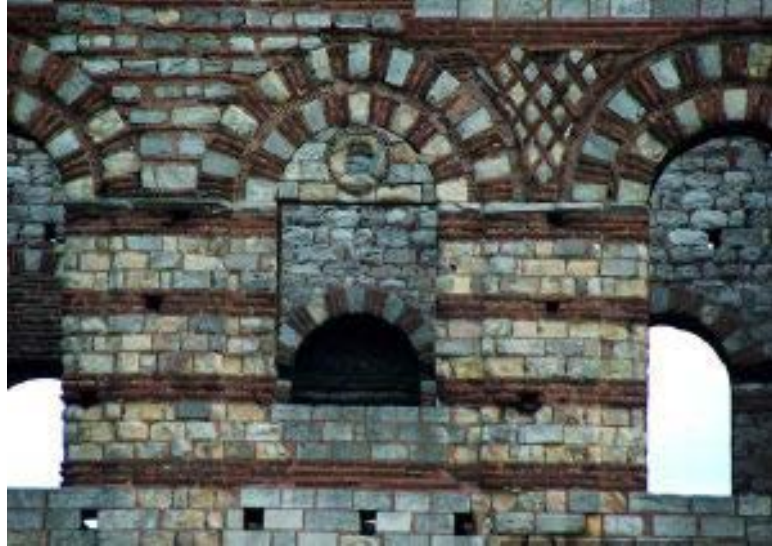
Şekil 2.1 Tek katmanlı olarak düzenlenmiş Tekfur Sarayı dış duvarları, Ayvansaray, İstanbul (URL-4)
