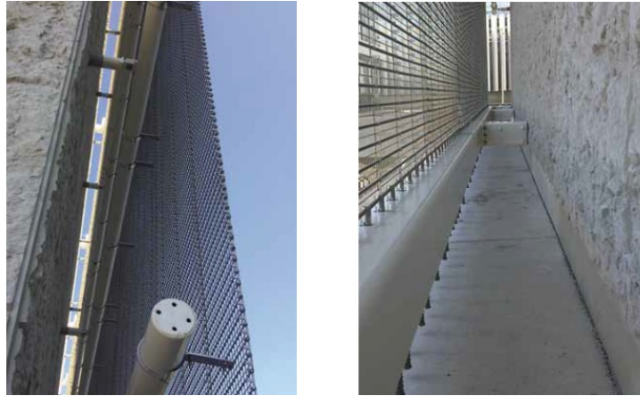
Şekil 4.63 Led cephe kaplaması, Ziggo Dom, Amsterdam (URL-48)
