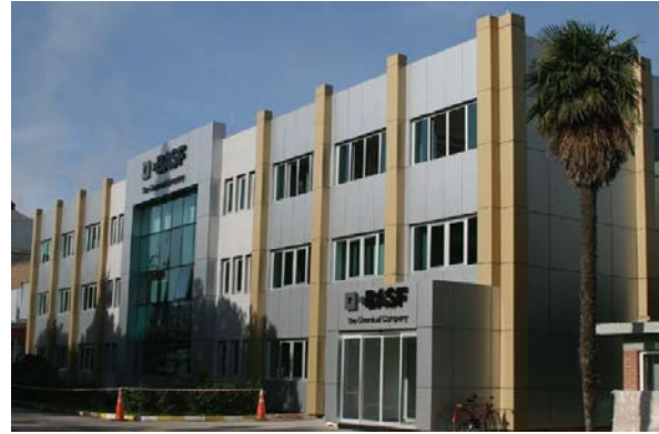
Şekil 5.14 Solda proje künyesi; sağ üstte binanın yenileme geçirmeden önceki görünüşü; sağ altta binanın yenilemeden sonraki görünüşü (URL-60)
