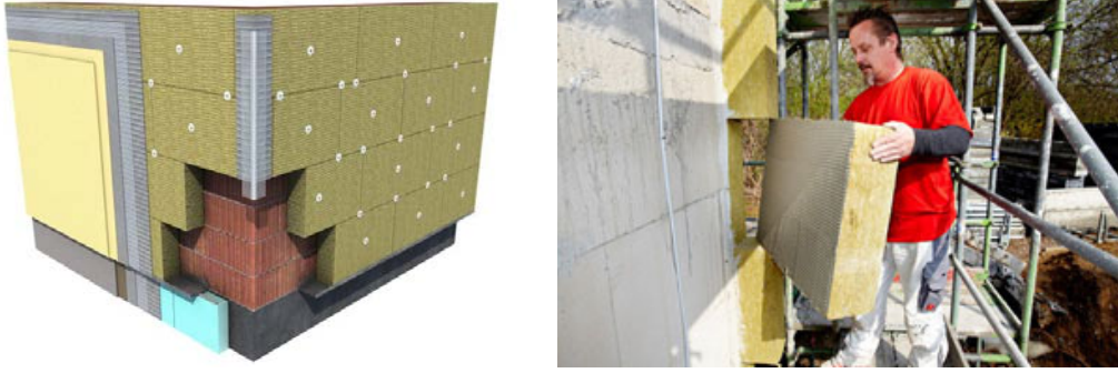
Şekil 4.46 Taşyünü yalıtım malzemesi uygulaması (URL-32)
