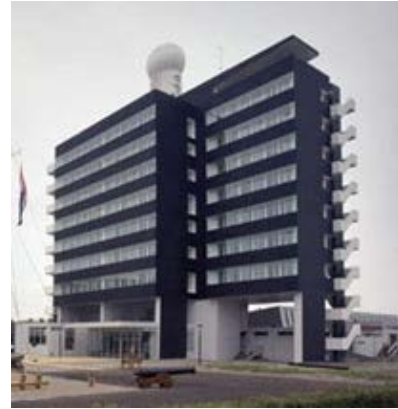
Şekil 5.6 Solda proje künyesi; sağ üstte binanın yenileme geçirmeden önceki görünüşü; sağ altta binanın yenilemeden sonraki görünüşü (URL-58)
