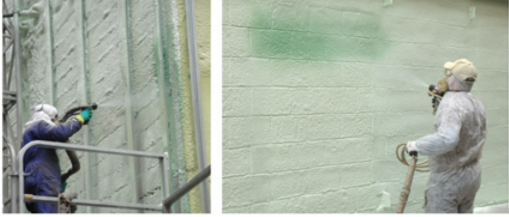
Şekil 4.45 Kapalı hücreli poliüretan köpük uygulaması (URL-31)
