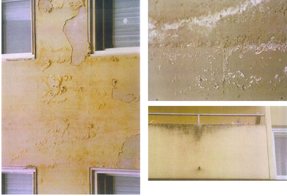
řekil 3.10 Dıř cephede su etkisiyle oluřan deformasyonlar (kabarma, ieklenme ve kf ) (URL-12)
