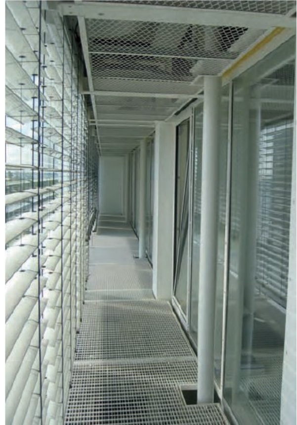
Şekil 5.7 Solda, ikinci kabuk, havalandırma boşluğu ve mevcut kabuk ilişkisini gösteren kesit; sağda, uygulamadan sonra ikinci kabuk ile mevcut kabuk arasındaki havalandırma boşluğundan görünüm (Baker, 2009).
