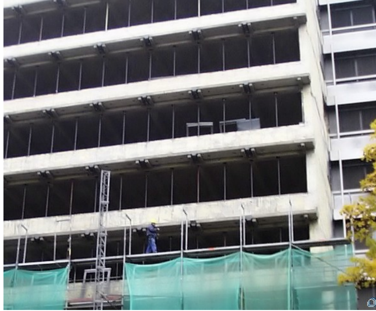
Şekil 5.20 Fotoğrafta sağda, yenileme çalışmaları başlamamış ve özgün cephesi hala korunan bina; solda yenileme çalışmalarına hazırlık olarak cephesindeki pencereler ve balkonlar kaldırılmış olan bina (URL-66).
