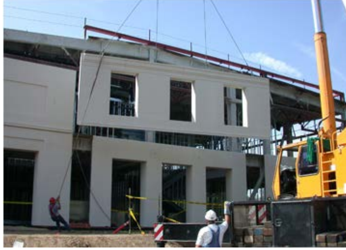
Şekil 2.5 Huntington kütüphanesi yapımında kullanılan prekast cephe panelleri (URL-6)
