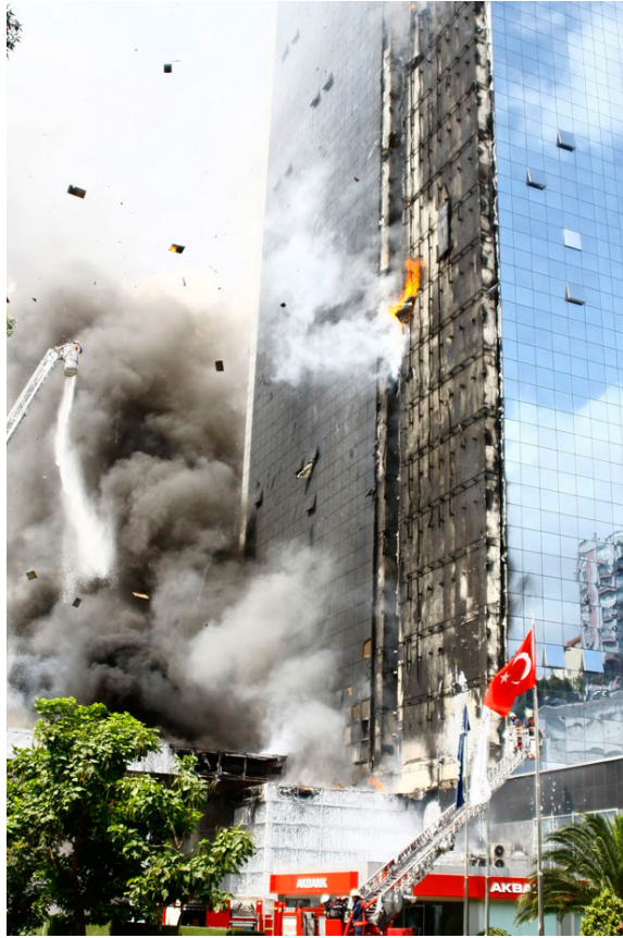
Şekil 3.13 Polat Tower yangını (URL-16)
