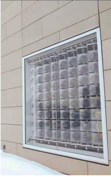
Şekil 4.76 Mimarlık Bilim ve Ekoloji Merkezi (The Center For Architecture Science And Ecology) tarafından geliştirilmiş, yoğunlaştırılmış entegre güneş sistemi (Wang, 2010)
