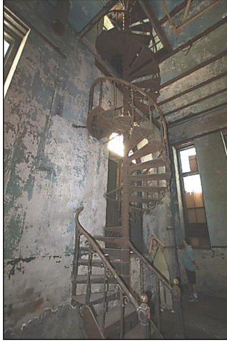
Şekil 4.11. Rainer Cold Depo Binasına Ait Servis Merdiveni ( http://www.vintageseattle.org/wp-content/uploads/2007/08/int_rainier_03.jpg )
