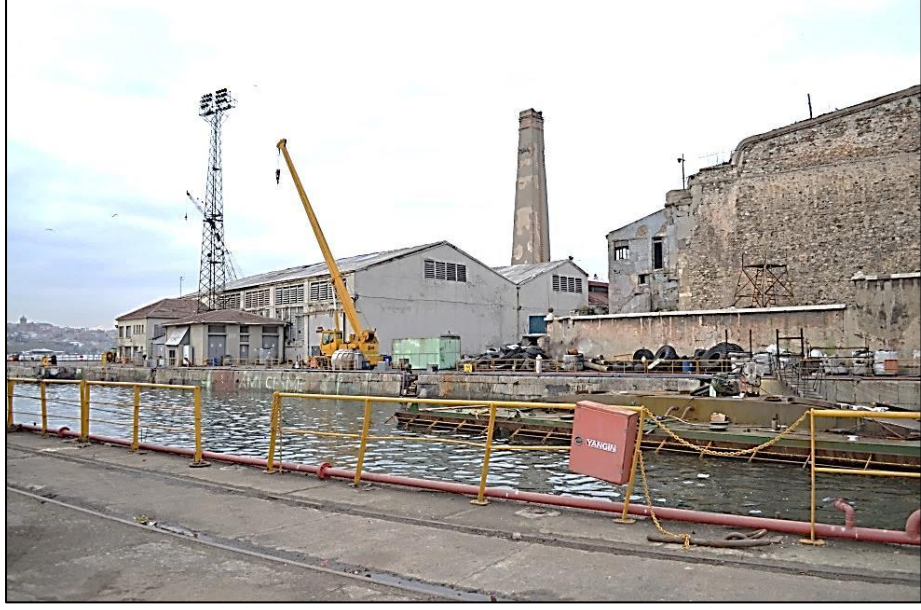
Şekil 3.50. Haliç Tersanesi 1 No'lu Havuz (Esin Sarıman Özen Arşivi)
