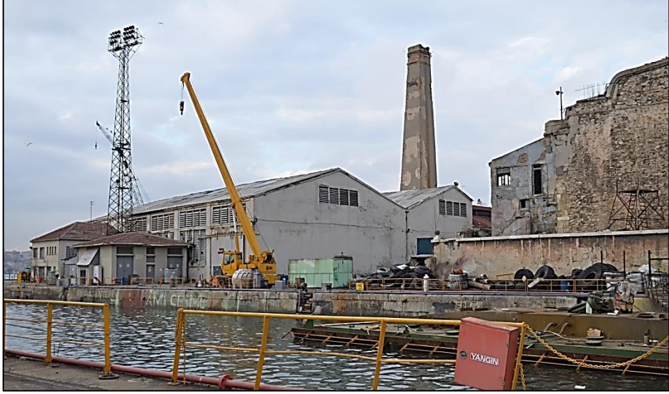
Şekil 5.34. Haliç Tersanesi Yat Fabrikası Mevcut Arka Cephe (Esin Sarıman Özen Arşivi)
