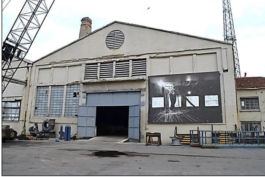
Şekil 4.13. Halic Tersanesi 'Yat Fabrikası' Cephesi (Esin Sarıman Özen Fotoğraf Arşivi)
