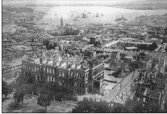
Şekil 3.46. 19. yüzyıla ait yangın geçirmiş bir tuğla yapı ve Haliç panoraması http://www.yapi.com.tr/Yazdir/turkiyede-kent-planlamasi-dusuncesinin-gelisimi-61110
