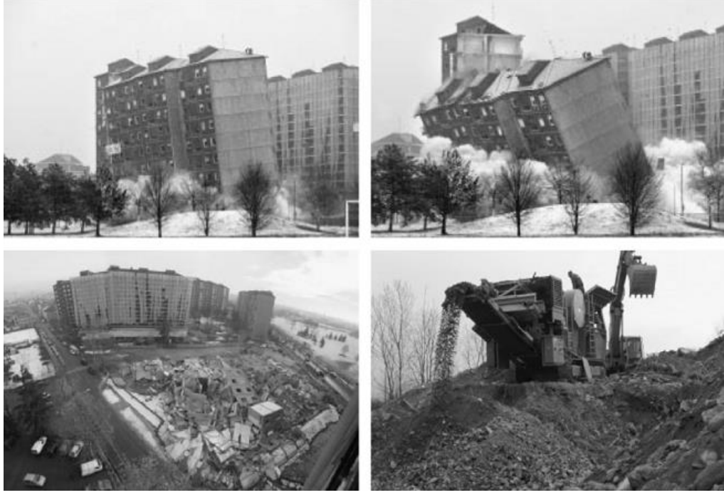
Şekil 4.3. Patlayıcı Kullanılarak Yıkım Çalışmasının Yapılması ve Geri Kazanım (Blengini, 2009)
