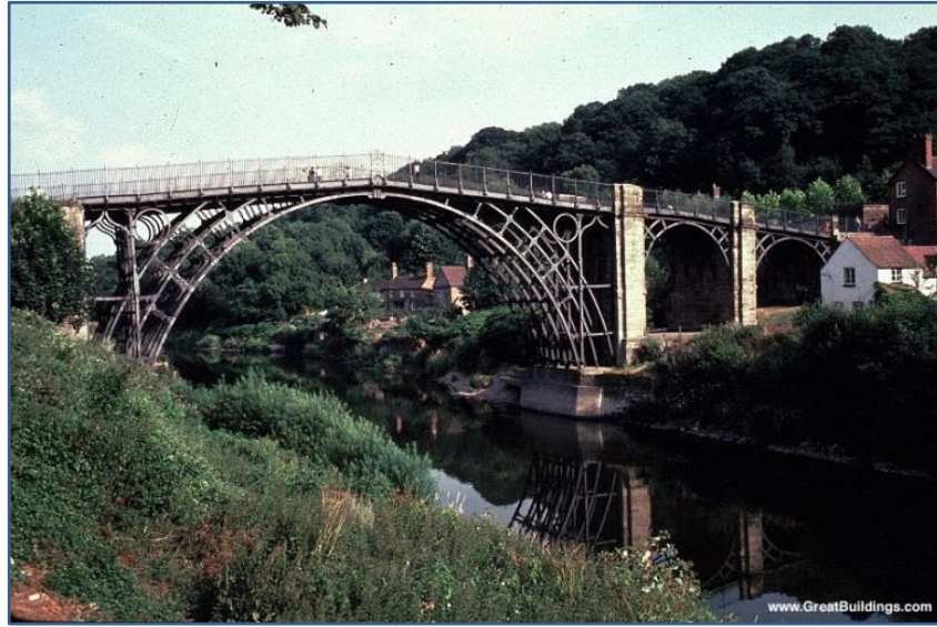
Şekil 2.1. Pik Demir Kullanılarak Yapılan İlk Köprü Coalbrookdale Köprüsü (URL-5)
