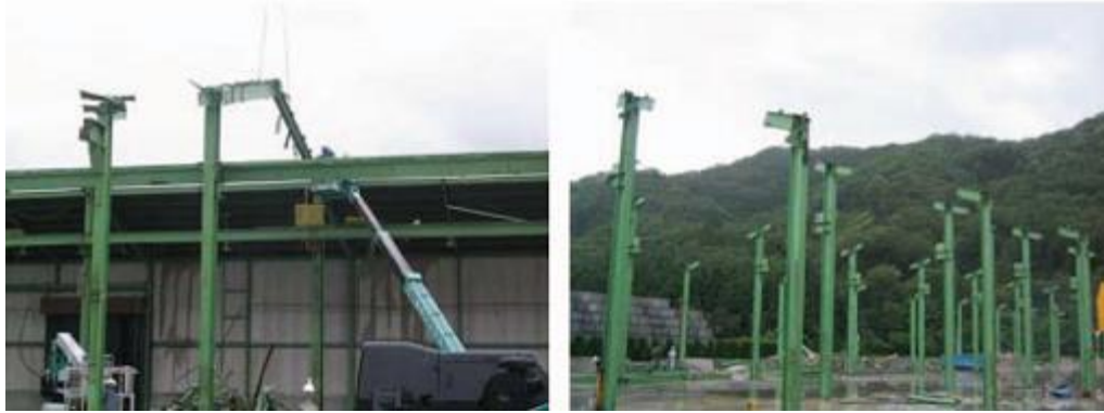
Kirişlerin Sökümü Sonrası
