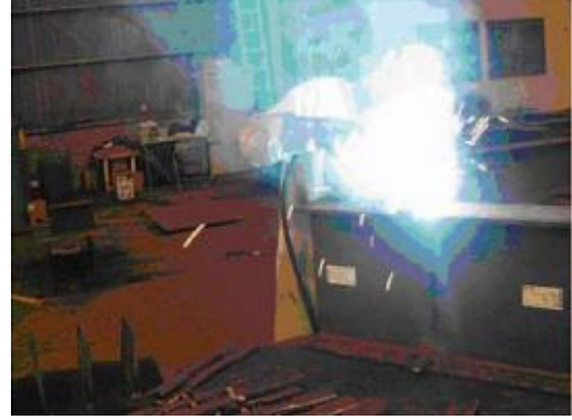
Şekil 4.15. Çelik kirişlerin Kaynak Yapılarak Birleştirilmesi (Fujita ve Iwata, 2008)
