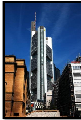
Resim 2: Commerzbank Genel Merkez Binası
