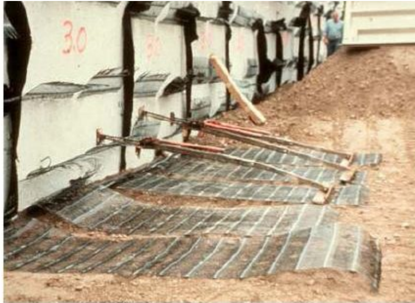
Şekil 3.10. Geotekstil donatılı istinat duvarı (Roven-Fransa, 1971)
