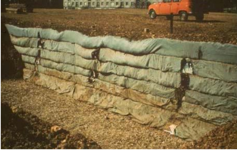
Şekil 3.9. Geotekstil donatılı istinat duvarı (Roven – Fransa 1971)
