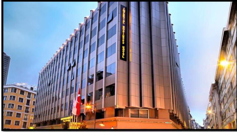
Şekil 4.3.9. İmperial hotel bomonti bina görünüşü (URL-10,2016)
