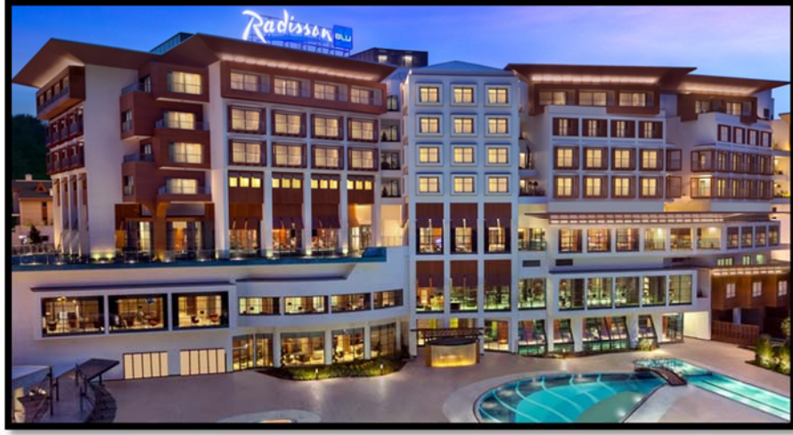
Şekil 4.3.12. Radisson blu hotel & spa tuzla bina görünüşü (URL-11, 2016)
