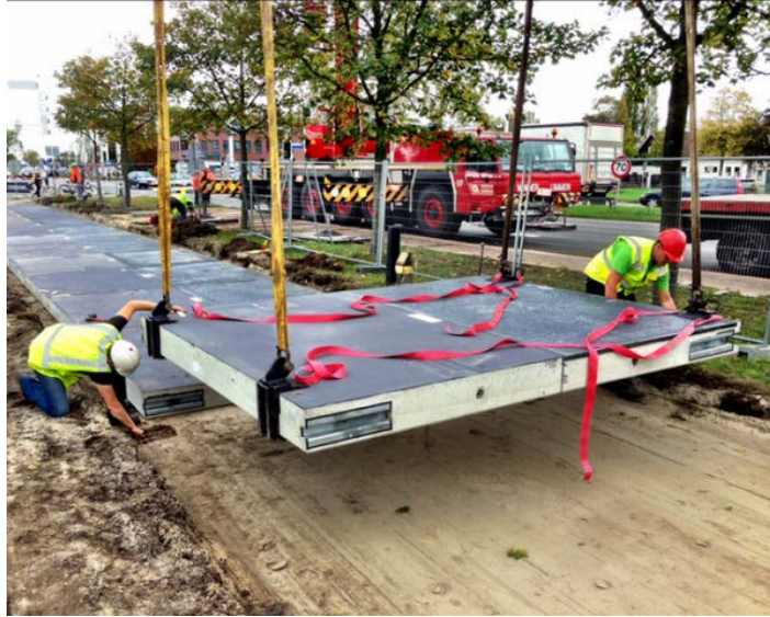
Şekil 4.58 Güneş Enerjili Yol Döşenmesi [158]
