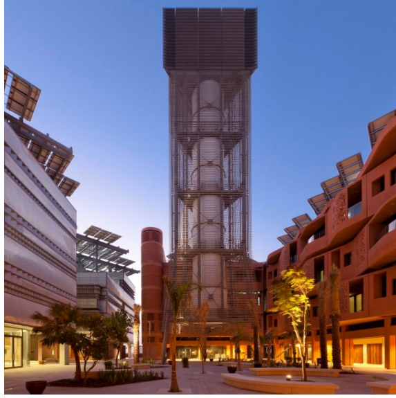
Şekil 3.66 Masdar City Rüzgâr Kulesi [126].
