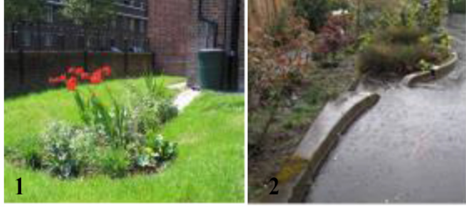
Şekil 3.24. Yağmur Oluğuna Yakın Konumlandırılmış Konut Bahçesinde Yer Alan Bir Yağmur Bahçesi Örneği (1), Yol Kenarında Yer Alan Bir Yağmur Bahçesi Örneği (2) [64].
