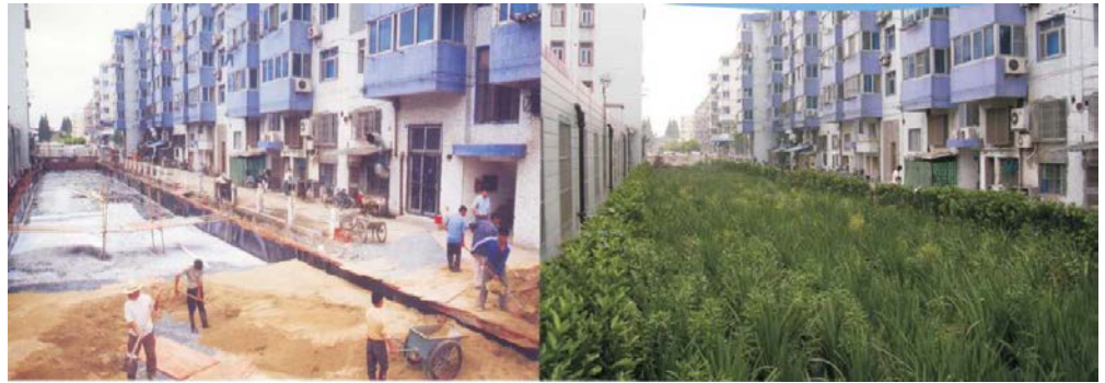
Şekil 3.33 Şangay HuaXin Yerleşim Bölgesinde Yapılandırılmış Sulak Alan Uygulama Öncesi ve Sonrası [81].
