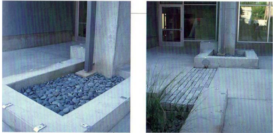
Şekil 3.35 Portland Öğrenci Konutları Yağmur Suyu İniş Detayları [75].
