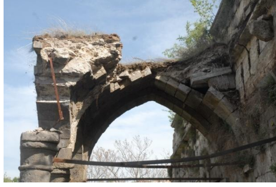
Şekil 71: Kilisenin Kuzey Cephesindeki Batı Bölümü Üstünde Bulunan Konsollar [59]
