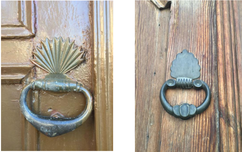
Şekil 3.38. Kapı gövdesi ile 'C' şeklinde buluşan kapı tokmakları (Envanter No:14-36)
