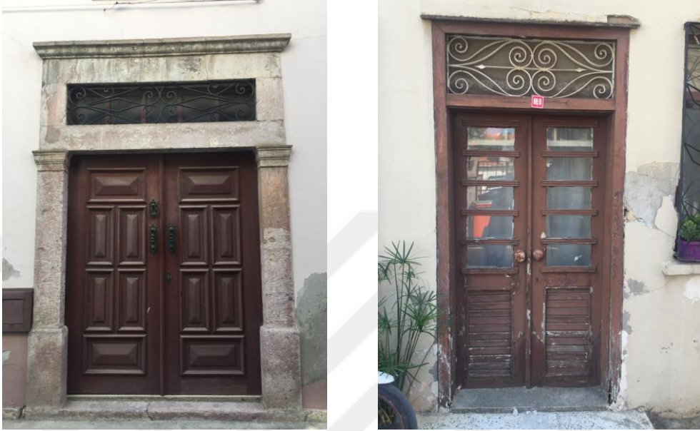
Şekil 3.19. Cephe ile aynı düzlemde kapılar (Envanter No:5-13)
