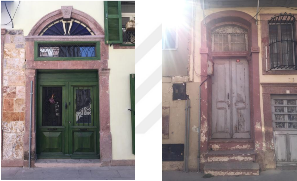
Şekil 3.16. Niş içinde yer alan kapılar (Envanter No:31-38)
