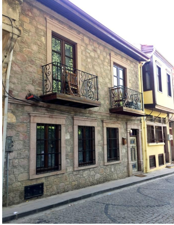
Şekil 2.11. Sarımsak taşı kullanılan cephe (Envanter No:44)
