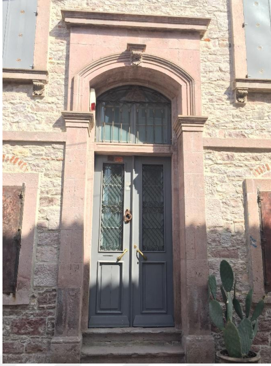
Şekil 2.14. Giriş kapısı (Envanter No:26)
