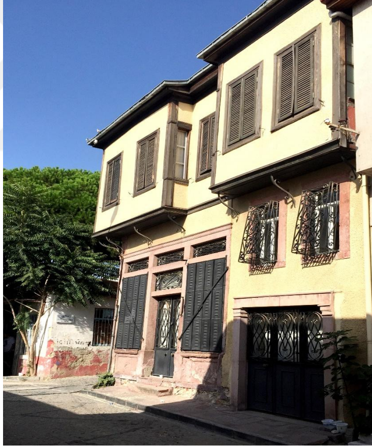
Şekil 2.20. Saçağı bulunan ev (Envanter No:66)
