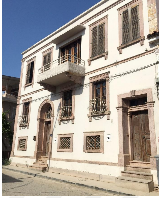
Şekil 2.15. İki giriş kapısı bulunan ev (Envanter No:57)
