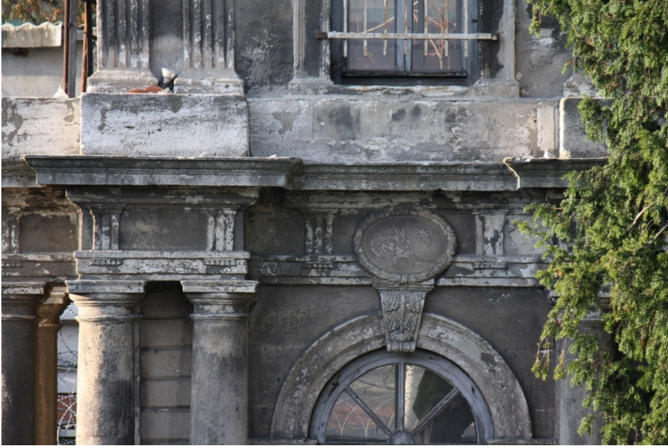
Resim 4.14. Nusretiye Saat Kulesi Abdülmejid Tuğrası ve Cephe Görünüm, 2012 (Kaynak: Gürsu, L.T.)
