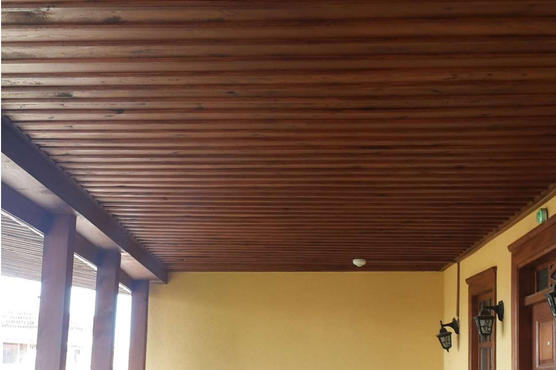
Şekil 3. 19: Döşeme üzeri ahşap kaplanması. (Niğdeli fotoğraf arşivi).
