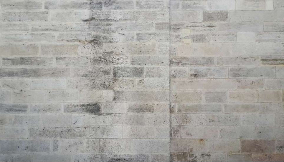
Şekil 3. 3: Kesme taş duvar. (Niğdeli fotoğraf arşivi).
