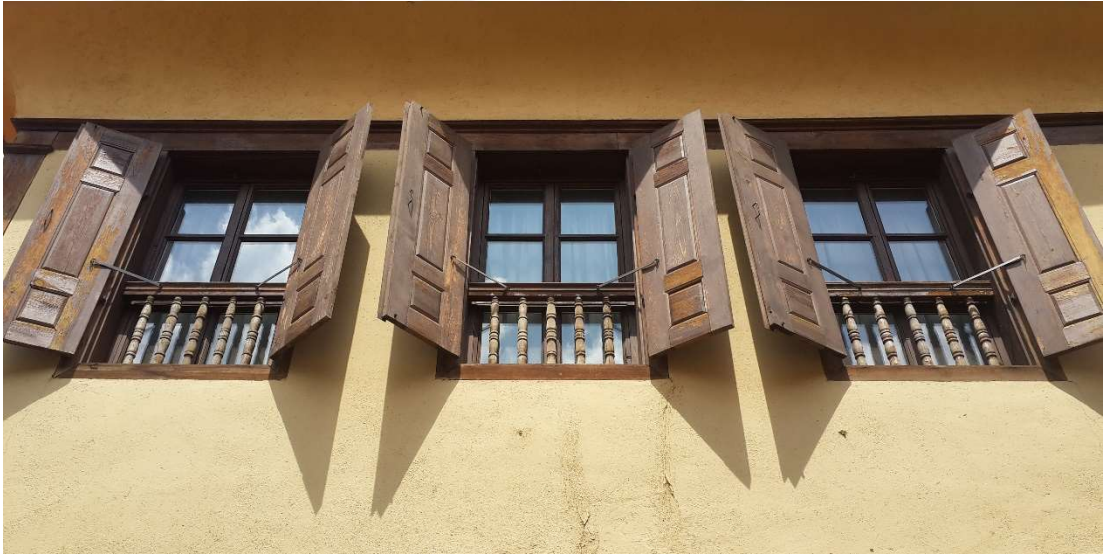
Şekil 3. 38: Ahşap kepenk kullanımı. (Niğdeli fotoğraf arşivi).
