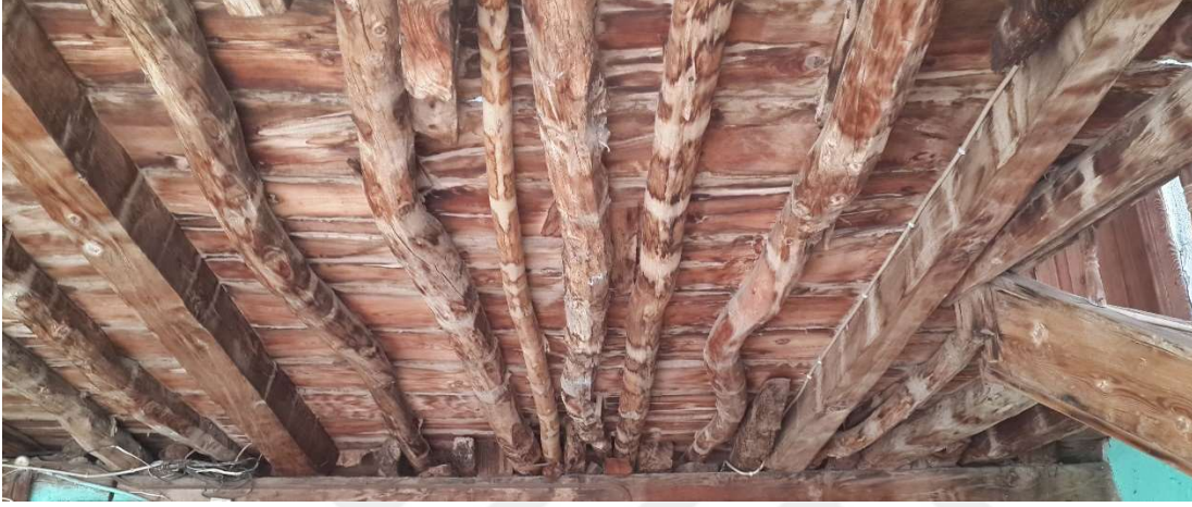
Şekil 3. 18: Nervürlü döşeme örneği. (Niğdeli fotoğraf arşivi).
