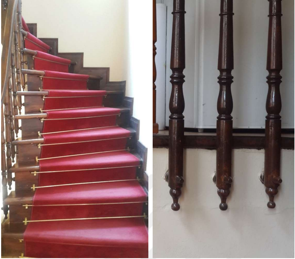
Şekil 4. 64: Merdiven kullanımı ve korkuluk-duvar bağlantısı. (Niğdeli fotoğraf arşivi).
