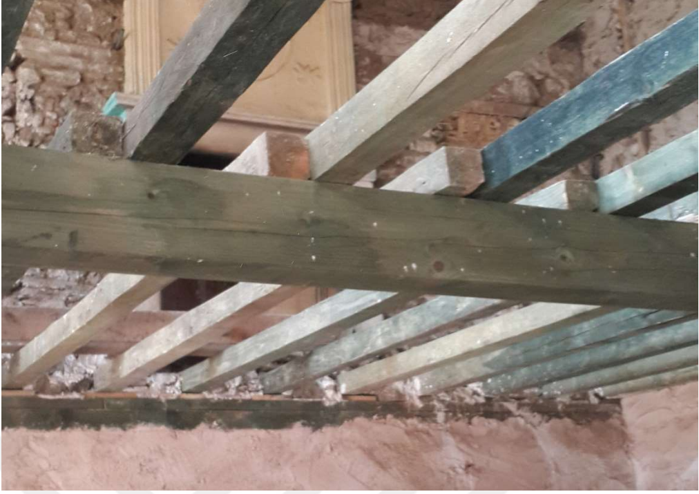
Şekil 3. 16: Döşeme kirişlemesi. (Niğdeli fotoğraf arşivi).
