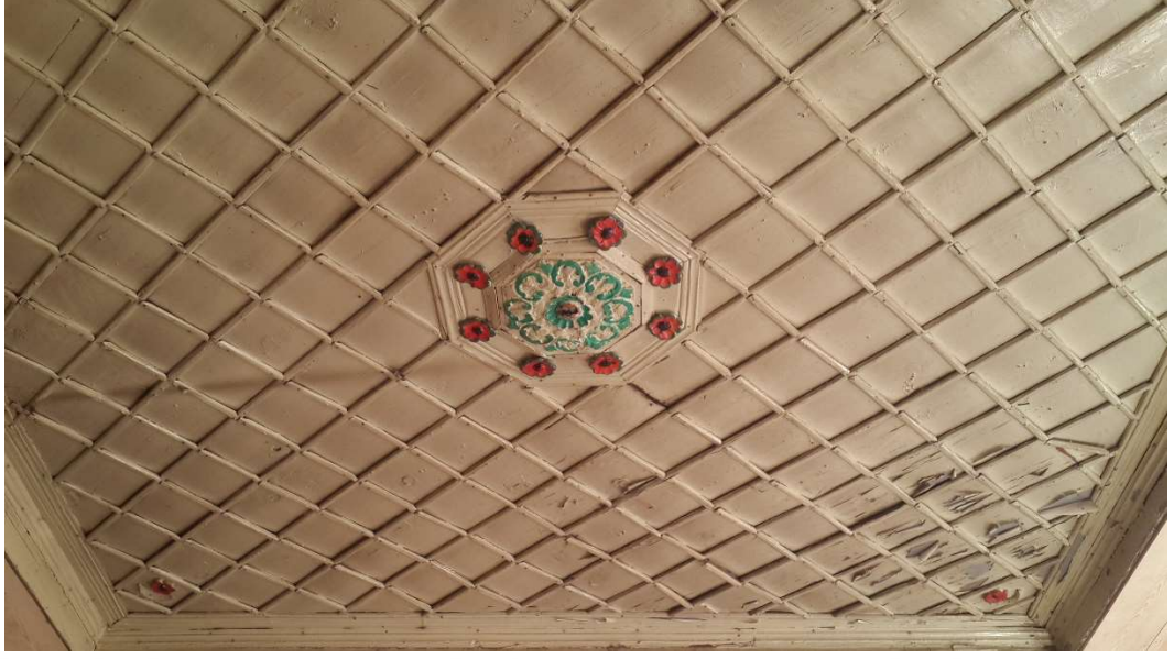
Şekil 3. 29: Çıtalı tavan örneği. (Niğdeli fotoğraf arşivi).
