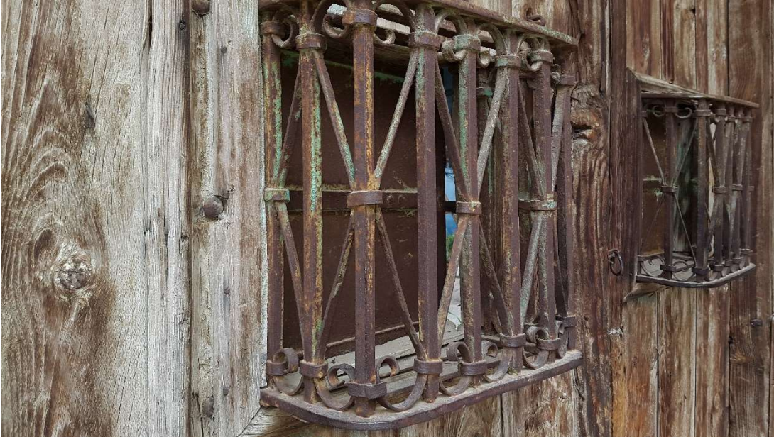
Şekil 3. 83: Metal kapı gözetleme penceresi. (Niğdeli fotoğraf arşivi).
