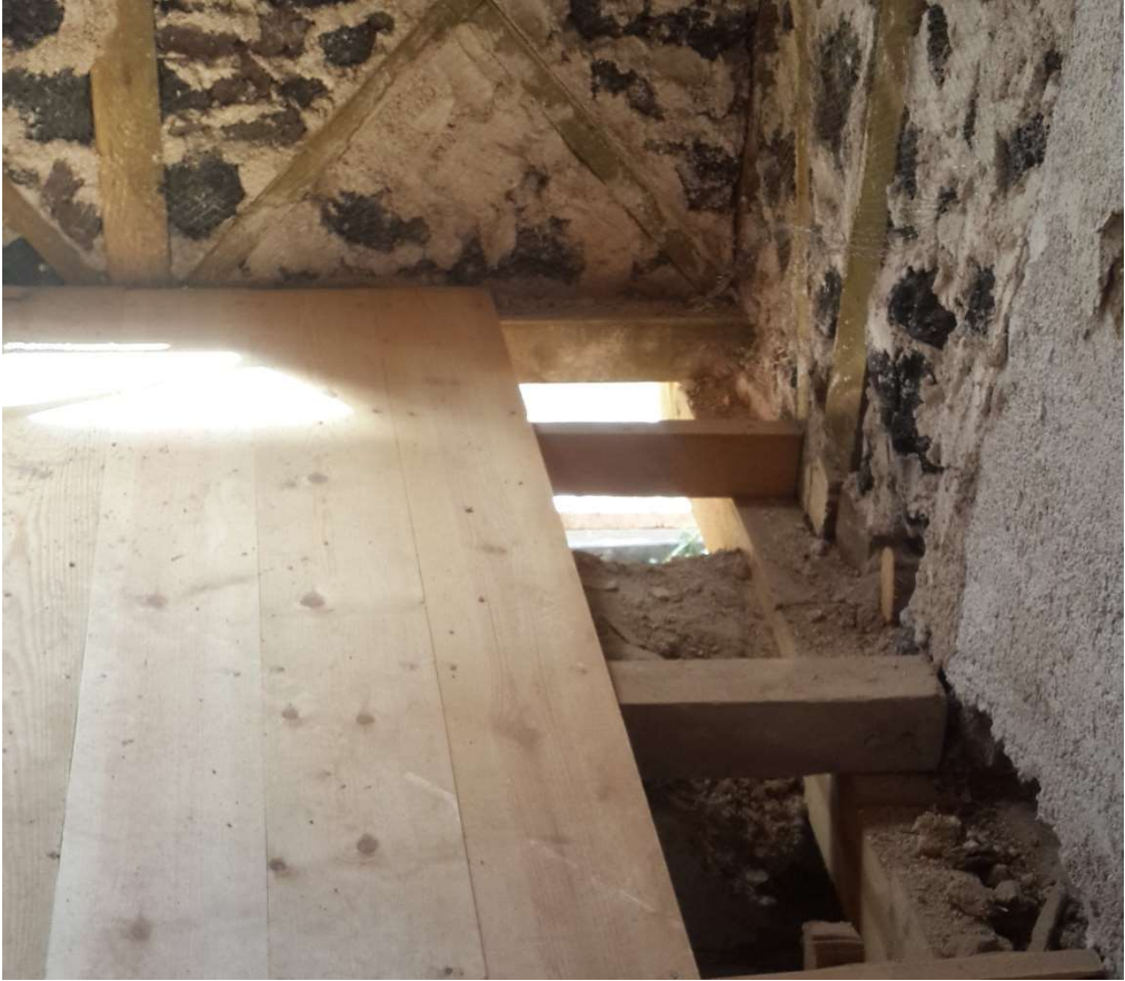
Şekil 3. 17: Döşeme kirişlerinin üzerine kaplama tahtalarının çakılması. (Niğdeli fotoğraf arşivi).
