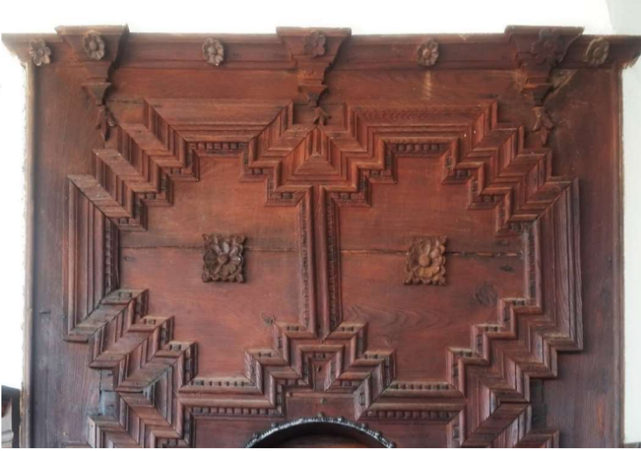
Şekil 3. 51: Kapı üzerinde başlık kullanımı. (Niğdeli fotoğraf arşivi).
