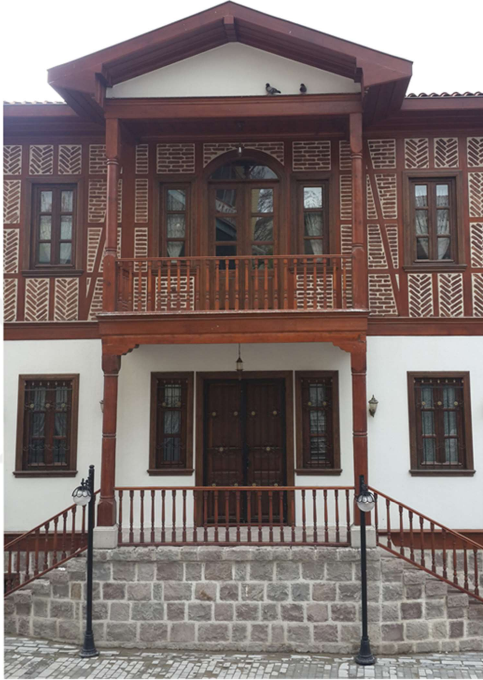
Şekil 3. 9: Tuğla dolgulu ahşap karkas sistem. (Niğdeli fotoğraf arşivi).
