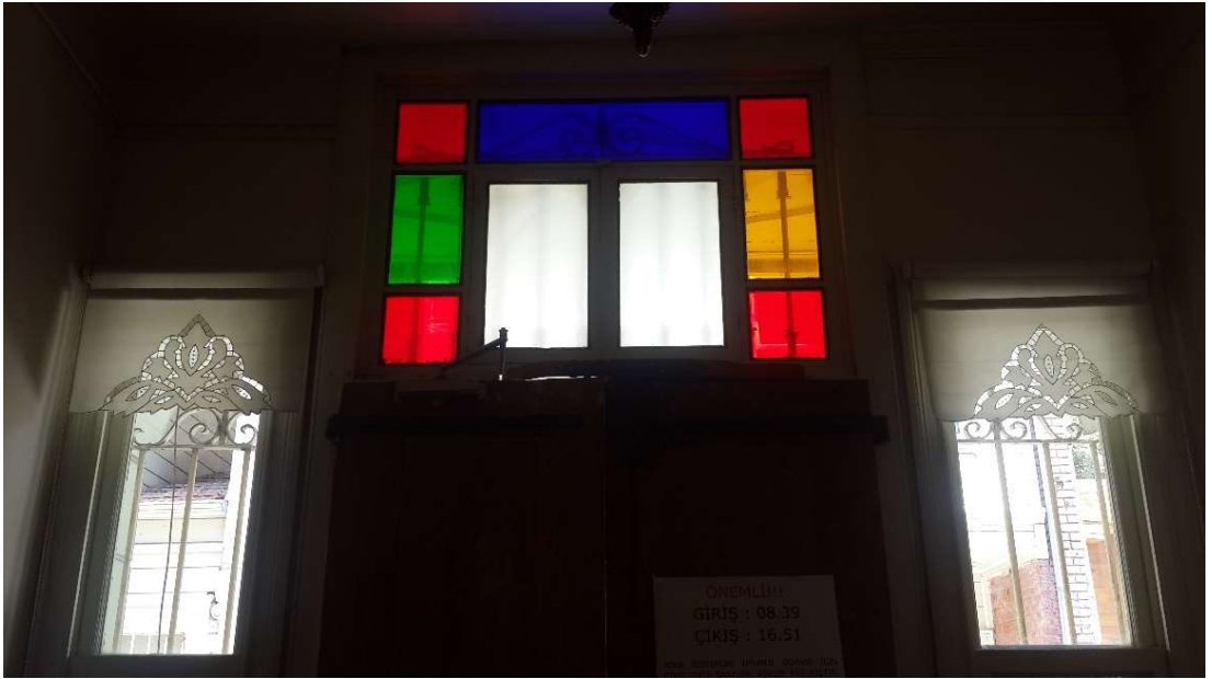
Şekil 4. 62: Giriş tepe penceresinde vitray kullanımı. (Niğdeli fotoğraf arşivi).
