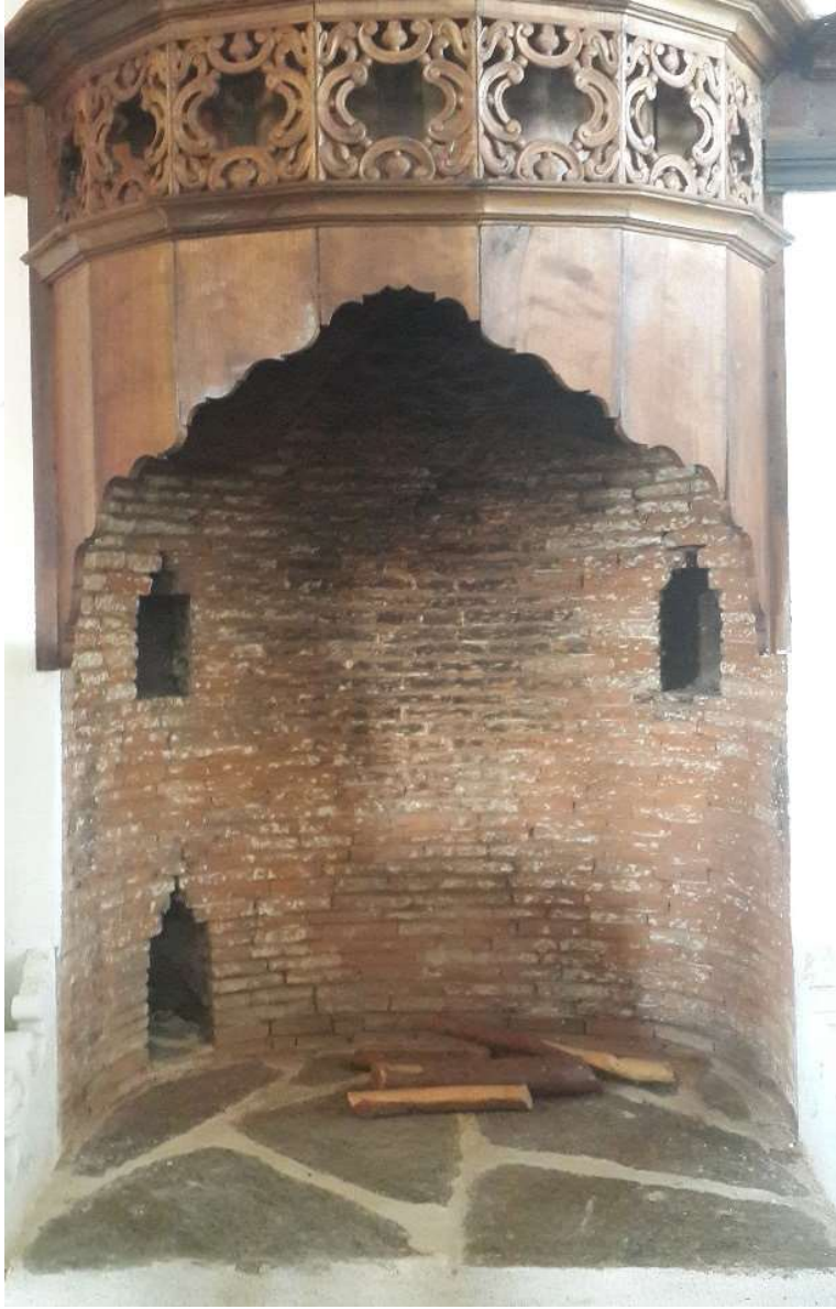
Şekil 3. 73: Ocak içinde tuğla kullanımı. (Niğdeli fotoğraf arşivi).
