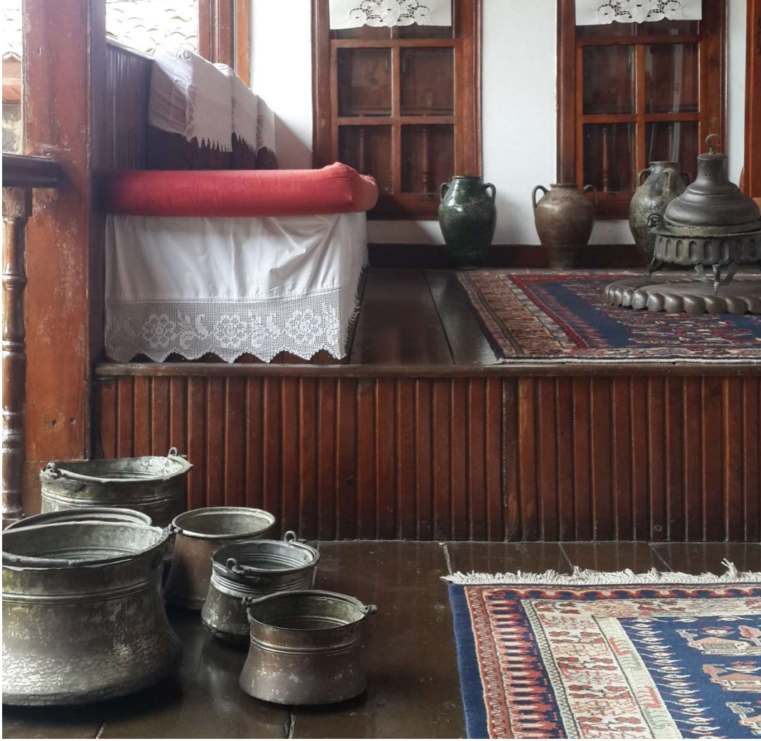
Şekil 3. 21: Döşemenin oturma elemanı sediri oluşturması. (Niğdeli fotoğraf arşivi).
