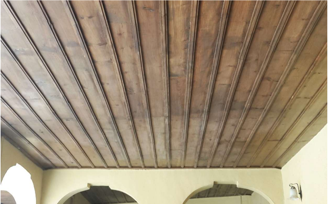
Şekil 3. 26: Düz kaplamalı tavan. (Niğdeli fotoğraf arşivi).
