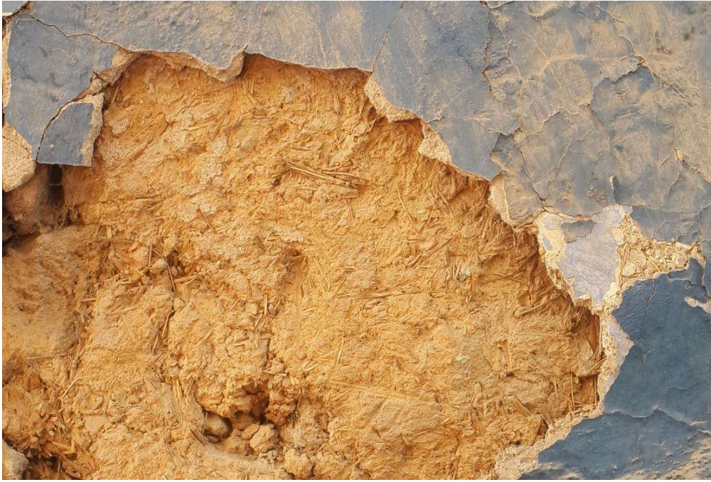
Şekil 3. 14: Toprak harç kullanımı. (Niğdeli fotoğraf arşivi).
