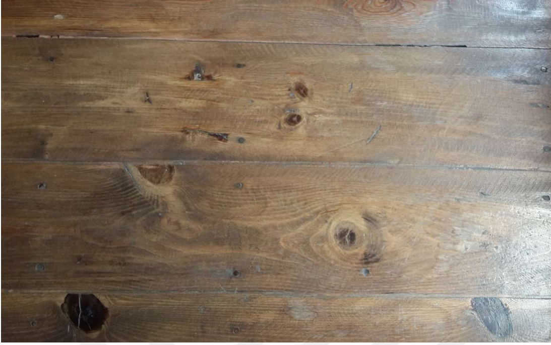
Şekil 4. 19: Döşeme uygulaması. (Niğdeli fotoğraf arşivi).
