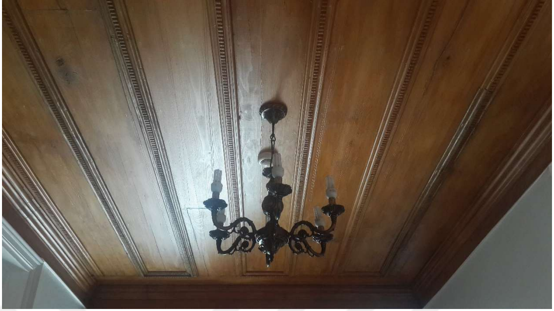
Şekil 4. 38: Çıtalı tavan uygulaması. (Niğdeli fotoğraf arşivi).
