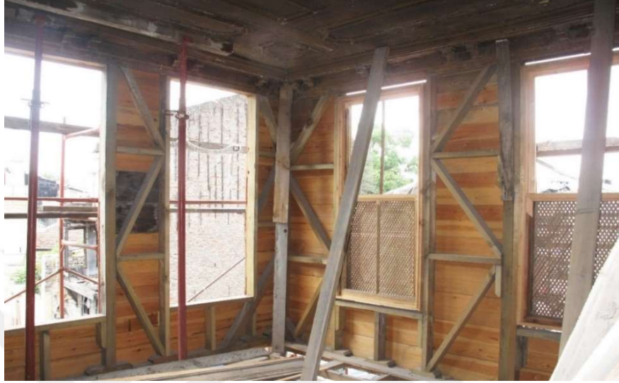
Şekil 4. 33: Restorasyon sırasında ahşap taşıyıcı sistem. (KUDEB fotoğraf arşivi).
