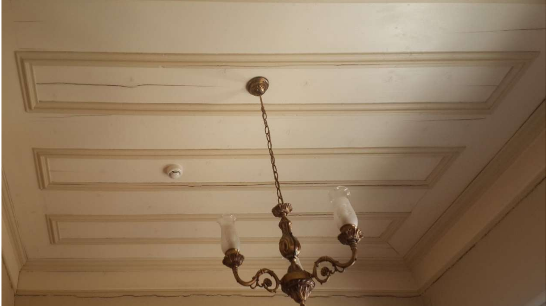
Şekil 4. 54: ıtalı tavan uygulaması. (Niğdeli fotoğraf arşivi).
