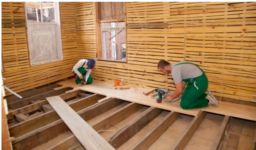
Şekil 4. 34: Döşeme kaplamalarının montajı. (KUDEB fotoğraf arşivi).
