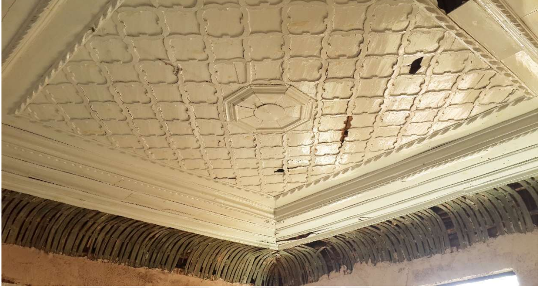
Şekil 3. 33: Tavan kenarlarının bağdadi yardımıyla konkav şekillendirilmesi ve göbek kullanımı. (Niğdeli fotoğraf arşivi).
