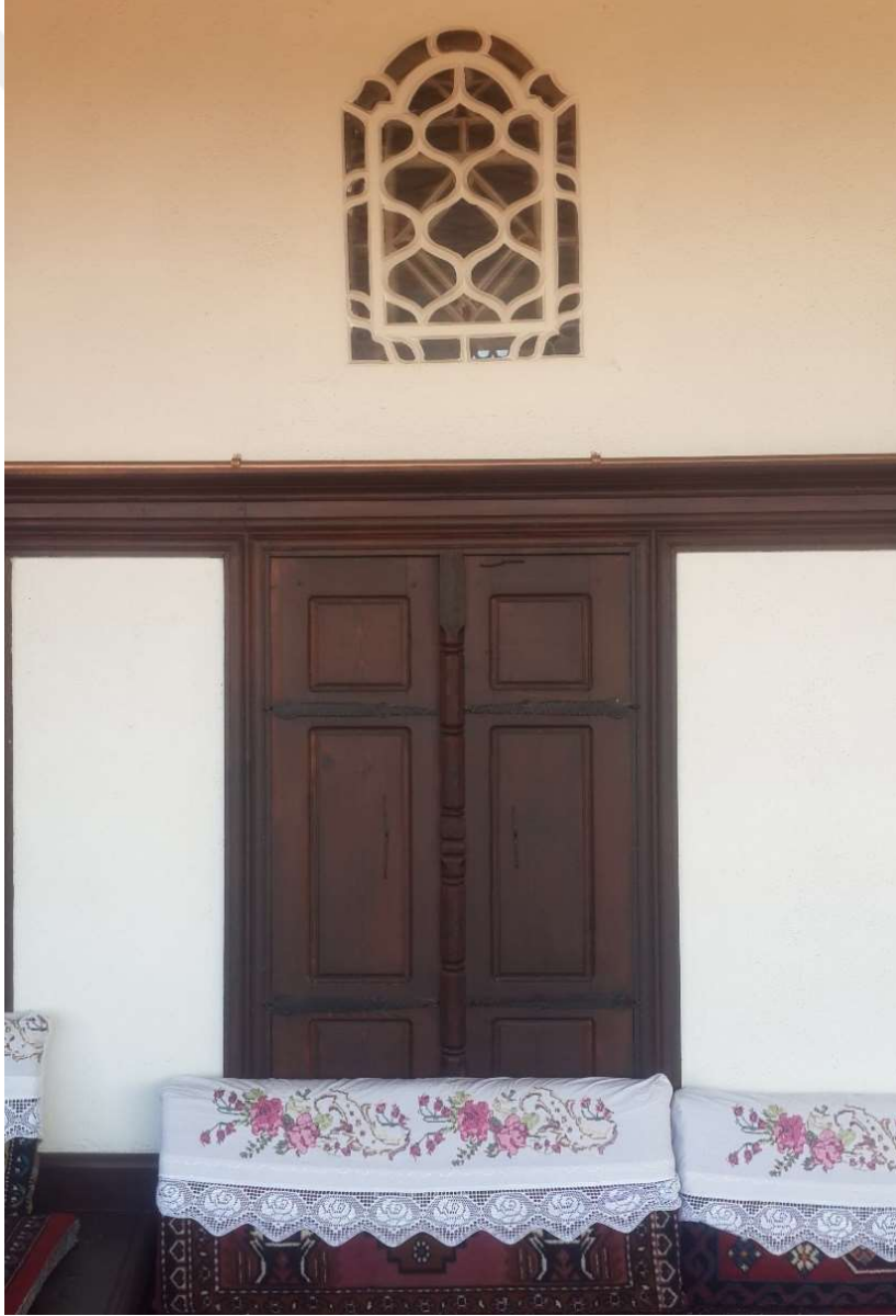
Şekil 3. 37: Ahşap pencere ve üzerinde alçı tepe penceresi kullanımı. (Niğdeli fotoğraf arşivi).
