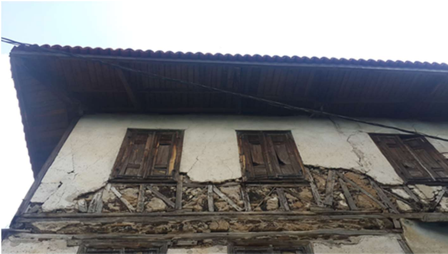
Şekil 3. 8: Taş dolgulu ahşap karkas sistem. (Niğdeli fotoğraf arşivi).
