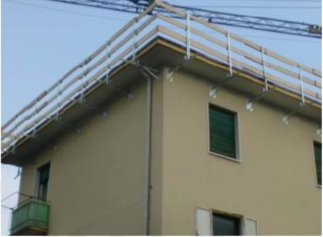
Şekil 3.3: B Sınıfı Geçici Kenar Koruma Sistemi Örneği
