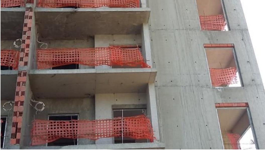
Şekil 3.5: Türkiye’de inşaat işyerlerinde döşeme, platform ve konsol kenarlarında kullanılan korkuluk örneği.
