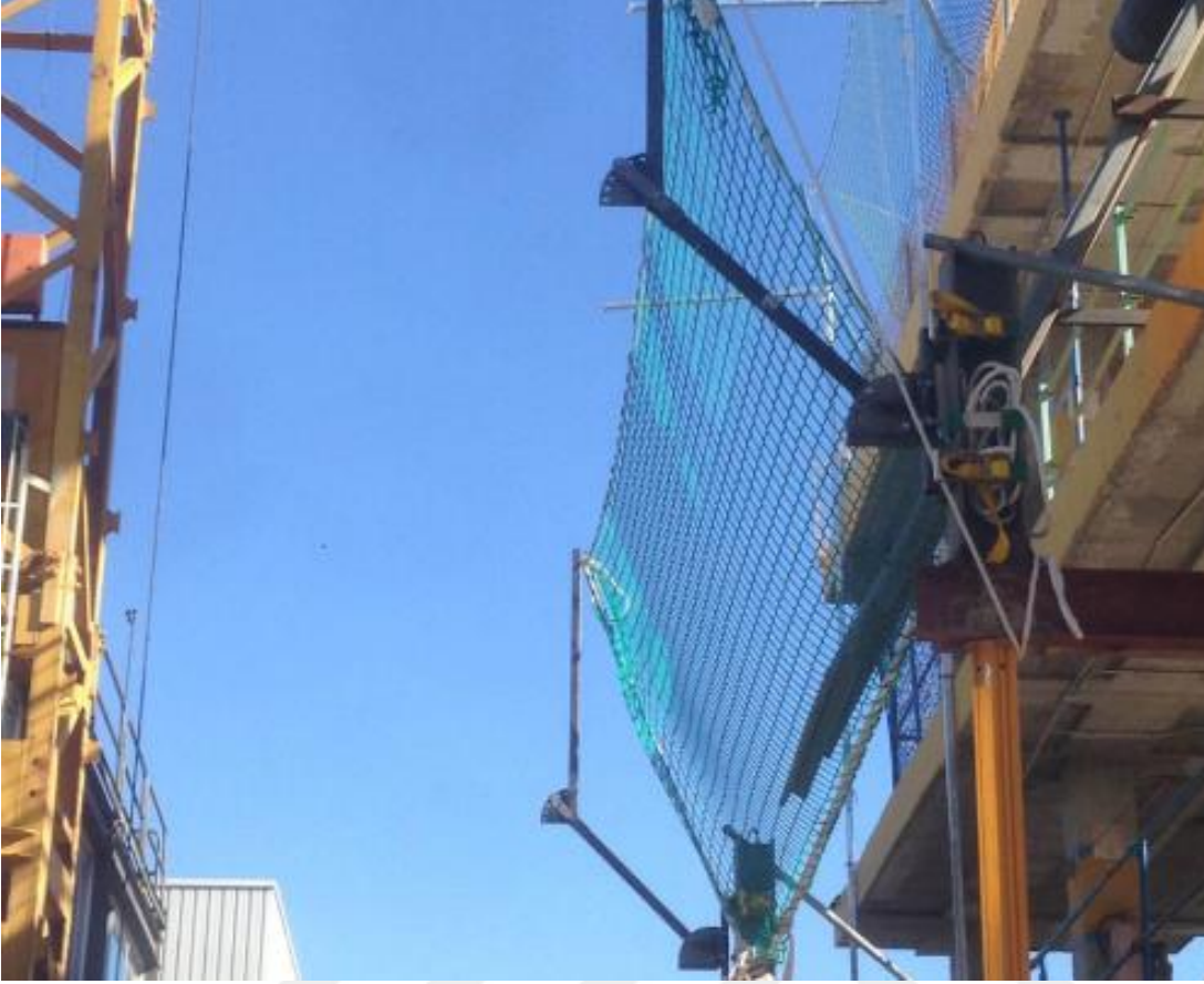
Şekil 3.4: C sınıfı geçici kenar koruma sistemi örneği.
