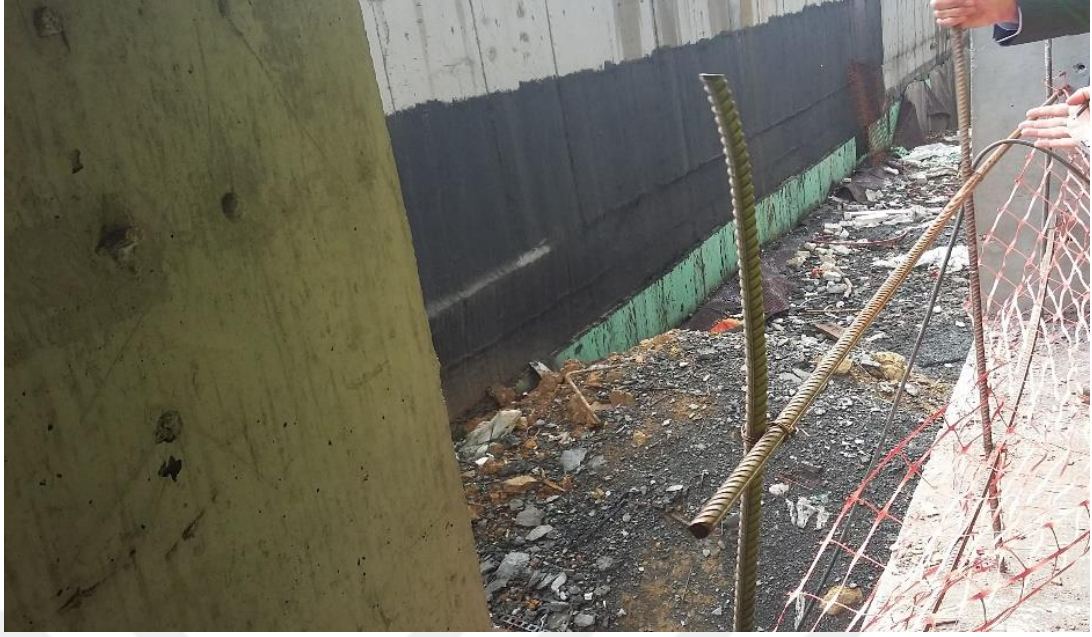
Şekil 3.6 : İnşaat demirleriyle imal edilen uygunsuz korkuluk örneği.
