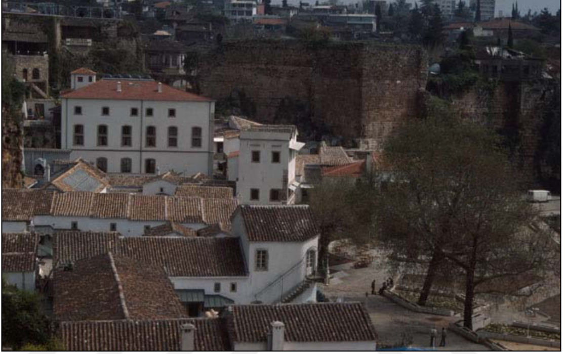
Şekil 3.40: Yat Limanı Onarım Sonrası 1983 (AKVKBKM arşivi)
