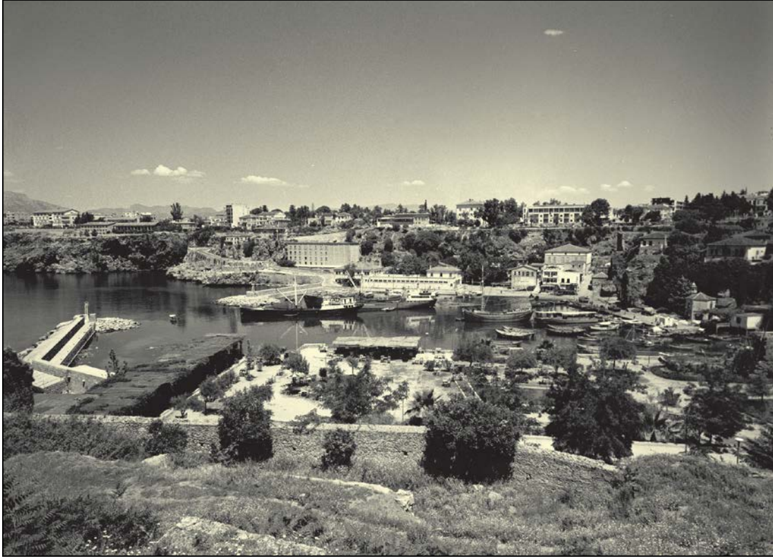
Şekil 3.14: Liman mendireği ve yapıları (ABBKBM Arşivi)
