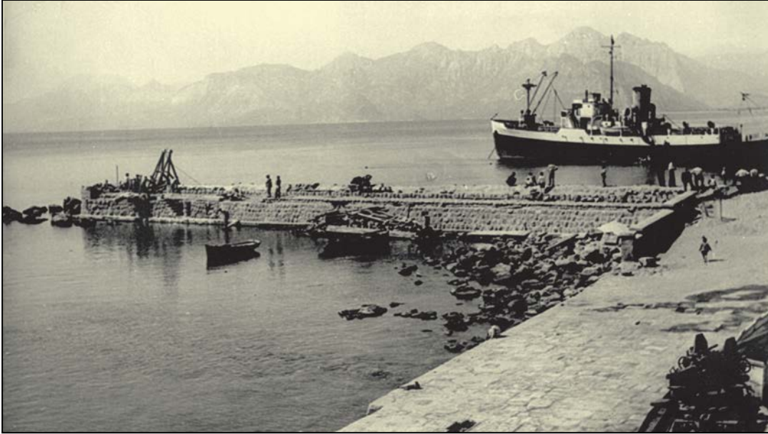
Şekil 3.12: Limanda Mendirek inşaatı (ABBKBM Arşivi)
