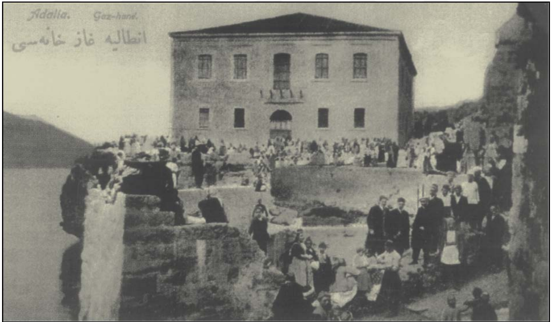
Şekil 3.13: Yıkılmadan Önce Gazhane binası (ABKBM Arşivi)
