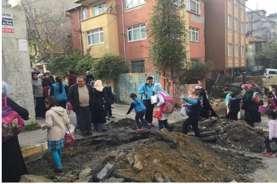
Şekil 2.8. Kazı çalışmalarından örnek fotoğraflar
