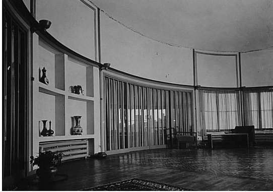
Şekil 4.92. Ağaoğlu Konutu, Yemek Odasına Geçiş için Düzenlenmiş Sürgü Cam Kapılar. SALT SHE A., [TSHEPA01602001].
