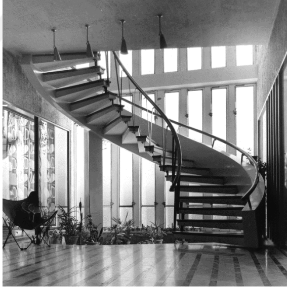
Şekil 4.8 Barut Evi, merdiven, Onat Arşivi.
