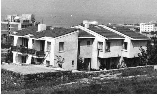
Güney ve Doğu cephelerinden görünüm
