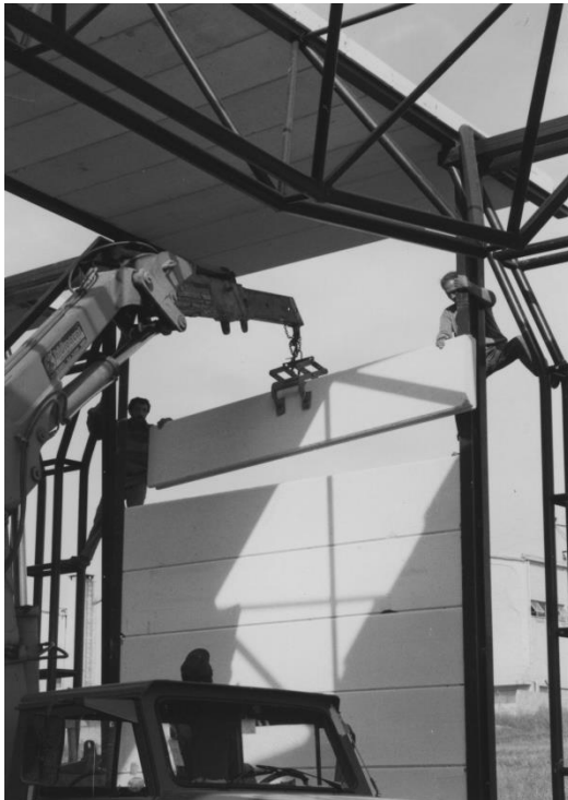
İnşaat Fotoğrafları (Onat Arşivi)
