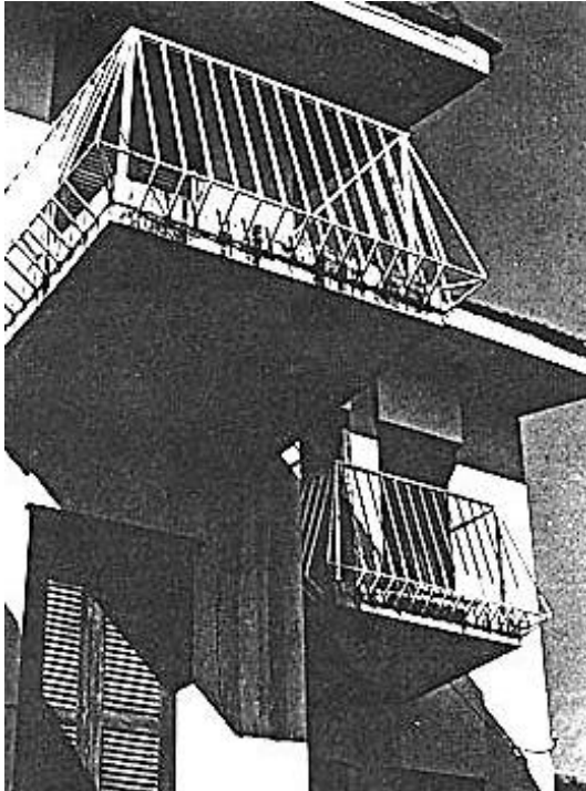
Dış cephe detayı (Onat Arşivi)
