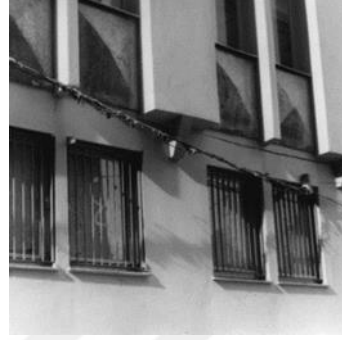
Sokak Cephesinden Detay
