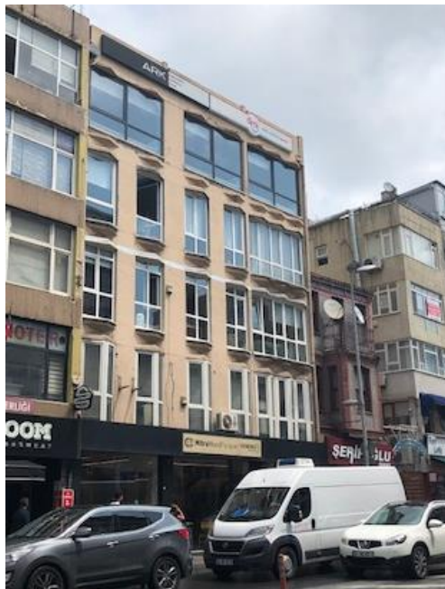
Yapının mevcut hali ( Mayıs 2018)
