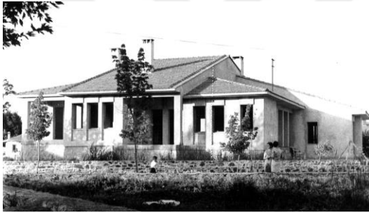
Cepheleden görünüm (Onat Arşivi)
