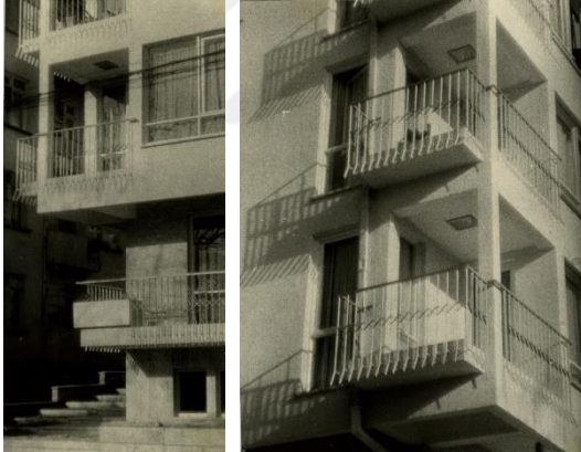
Sokak ve Giriş Cephesinden Detay
