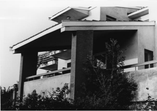
Güney Cephe Terası
