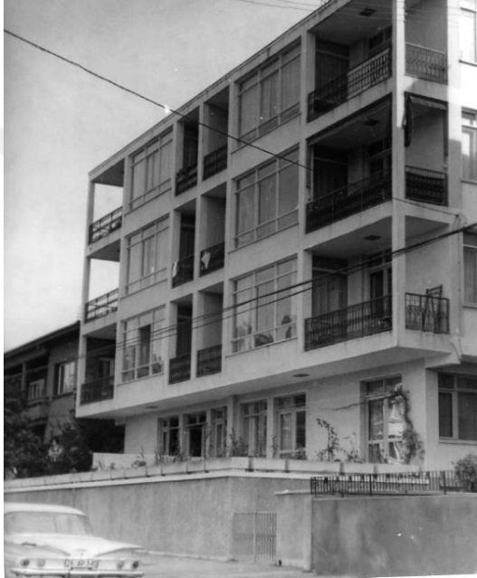
Sokak Cephesi (Onat Arşivi)
