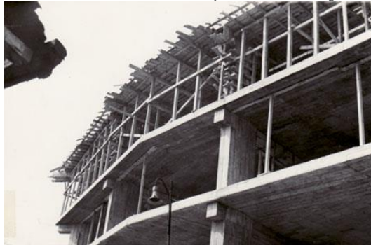
İnşaat fotoğrafları (Onat Arşivi)
