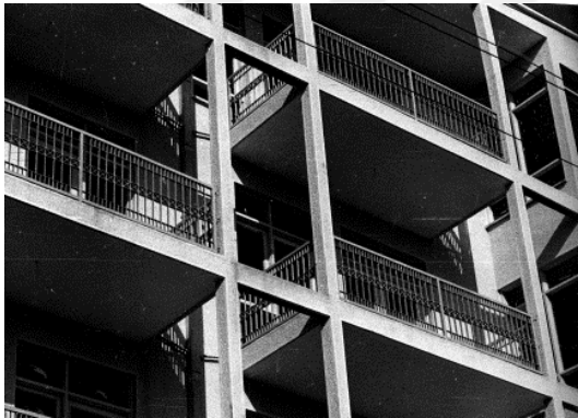
Sokak Cephesinden Detay
