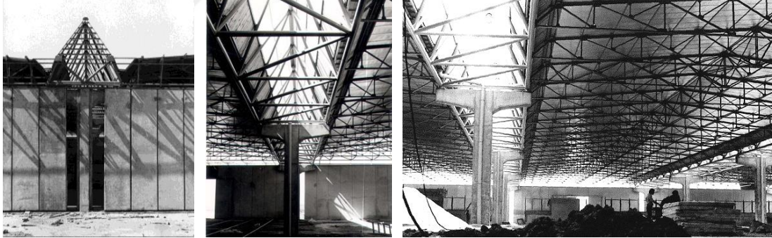
Şekil 4.44 Beko Elektronik Aletler Fabrikası, T kolonlar ve ışıklıklar, Onat Arşivi.
