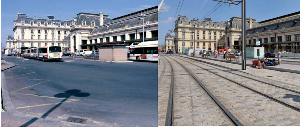
Şekil 4.40 : Saint Jean Tramvay İstasyonu eski hali (solda), Brochet-Lajus-Pueyo Mimarlık Ofisi tarafından tasarlanmış hali (sağda), (©J r mie Buchholtz).
