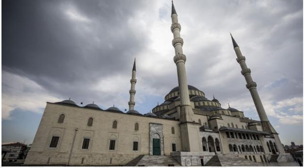
Resim 1: Kocatepe Camii, Genel Görünüm 130
