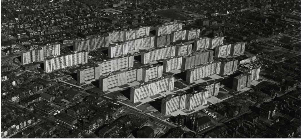
Şekil 2.4: Pruitt – Igoe toplu konut projesi. (URL-3)
