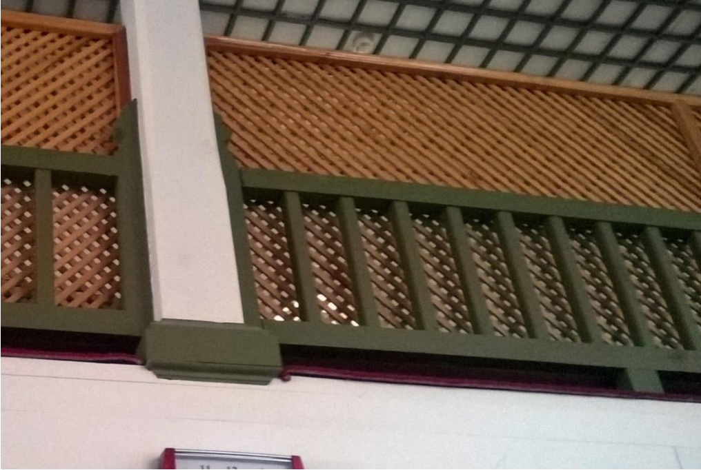
Şekil 5.42 : Sinan Paşa Camisi mahfil katı korkulukları uygulama sonrası durumu (Ö.E.a.).
