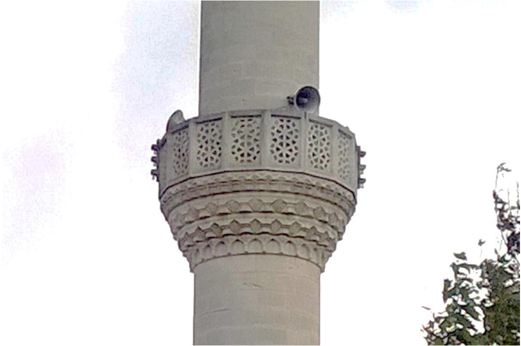
Şekil 5.20 : Sinan Paşa Camisi minare uygulama sonrası durumu (Ö.E.a.).
