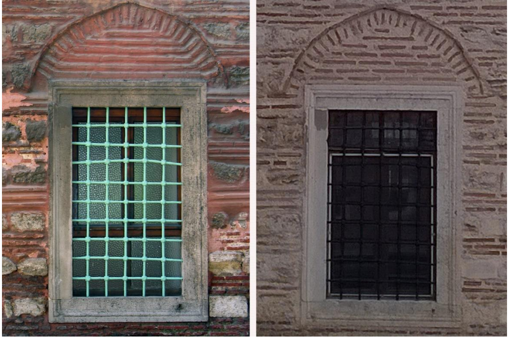
Şekil 5.36 : Sinan Paşa Camisi alt pencere dışı uygulama öncesi ve sonrası durumu (Ö.E.a.).
