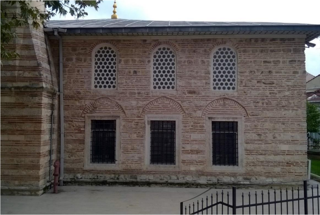
Şekil 5.54 : Sinan Paşa Camisi cephesi uygulama sonrası durumu (Ö.E.a.).
