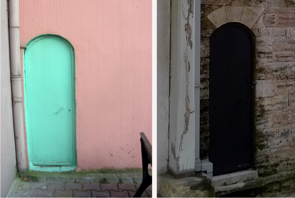
Şekil 5.18 : Sinan Paşa Camisi minare kapısı uygulama öncesi ve sonrası durumu (Ö.E.a.).
