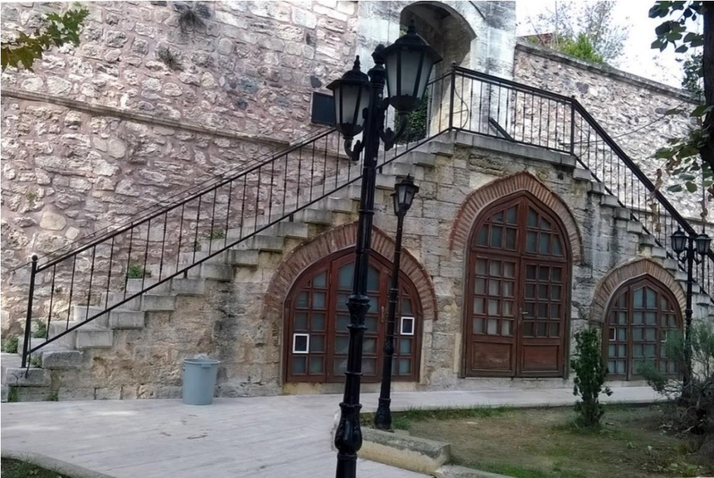
Şekil 5.46 : Sinan Paşa Camisi avlu merdivenleri uygulama sonrası durumu (Ö.E.a.).
