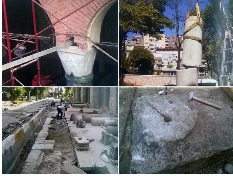
Şekil 4.36 : Piyale Paşa Camii son cemaat yeri rekonstrüksiyon aşamaları fotoğrafları (Olgun, 2007).
