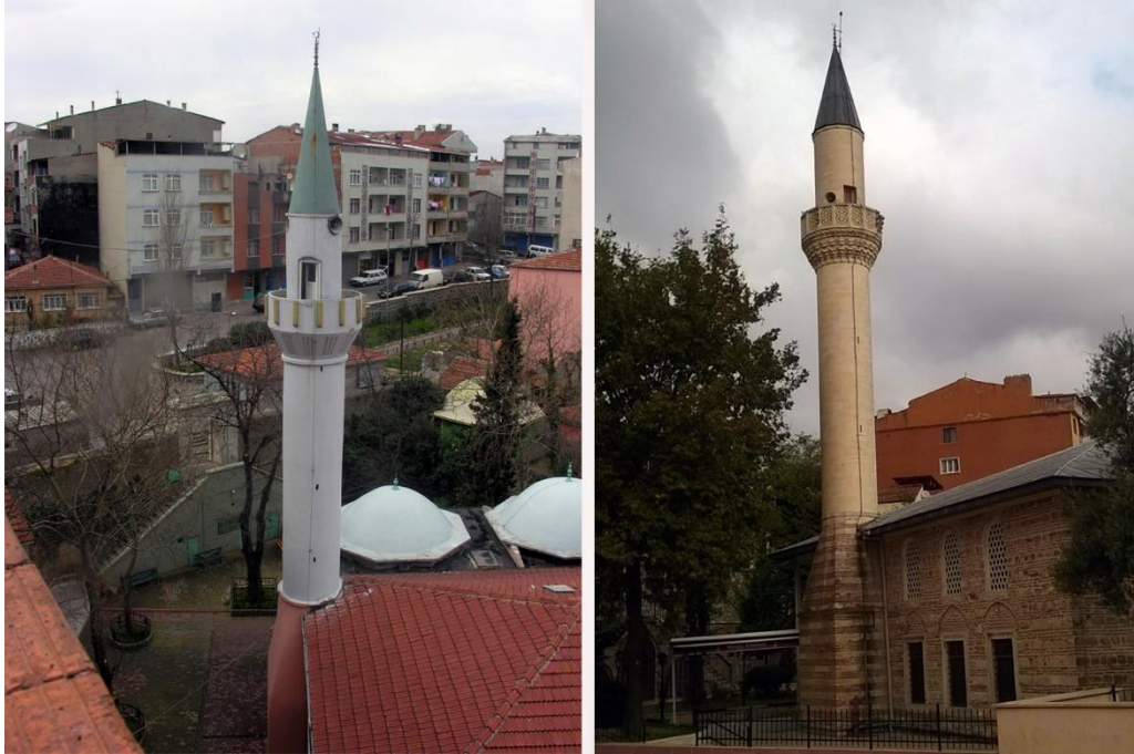
Şekil 5.16 : Sinan Paşa Camisi minare uygulama öncesi ve sonrası durumu (Ö.E.a.).
