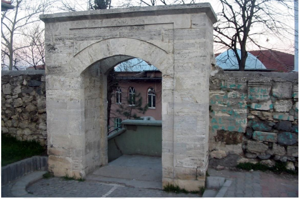
Şekil 5.43 : Sinan Paşa Camisi avlu kapısı uygulama öncesi durumu (Ö.E.a.).
