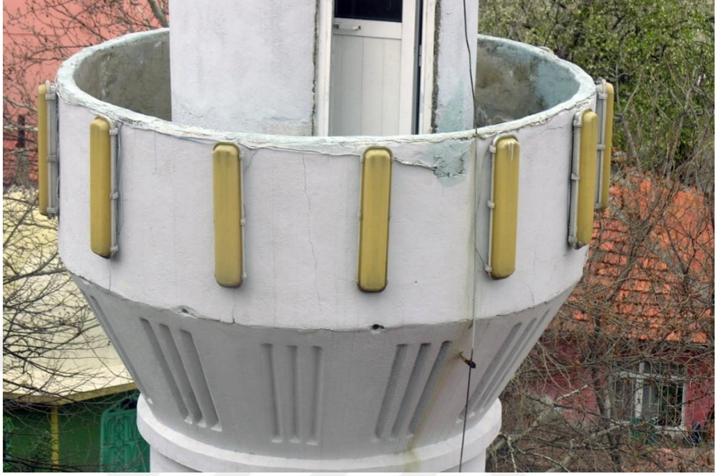
Şekil 5.19 : Sinan Paşa Camisi minare şerefesi uygulama öncesi durumu (Ö.E.a.).
