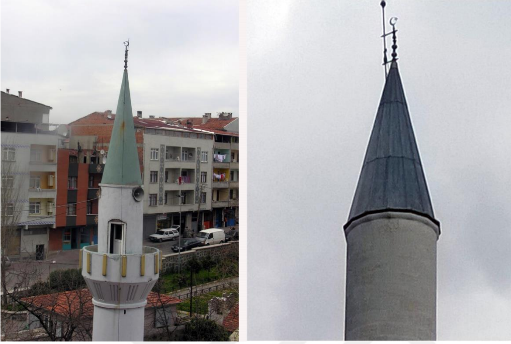
Şekil 5.17 : Sinan Paşa Camisi minare külahı uygulama öncesi ve sonrası durumu (Ö.E.a.).
