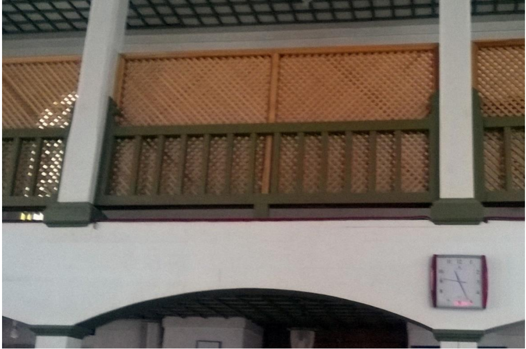
Şekil 5.40 : Sinan Paşa Camisi mahfil katı korkulukları uygulama sonrası durumu (Ö.E.a.).
