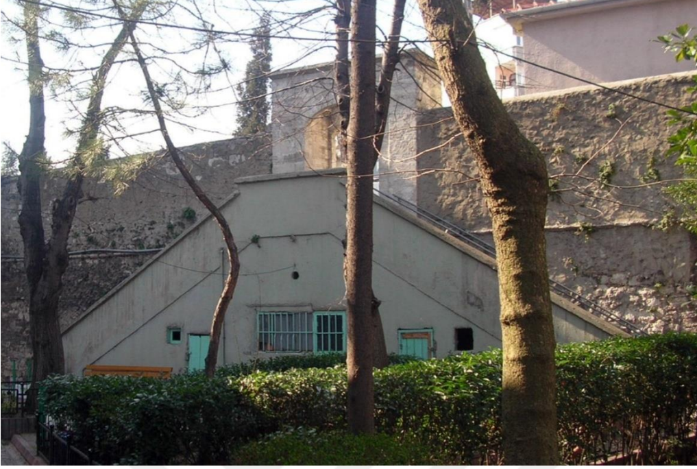
Şekil 5.45 : Sinan Paşa Camisi avlu merdivenleri uygulama öncesi durumu (Ö.E.a.).
