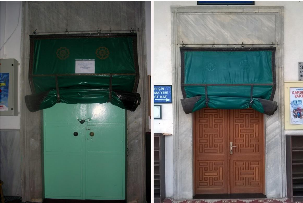
Şekil 5.22 : Sinan Paşa Camisi harim kapısı uygulama öncesi ve sonrası durumu (Ö.E.a.).
