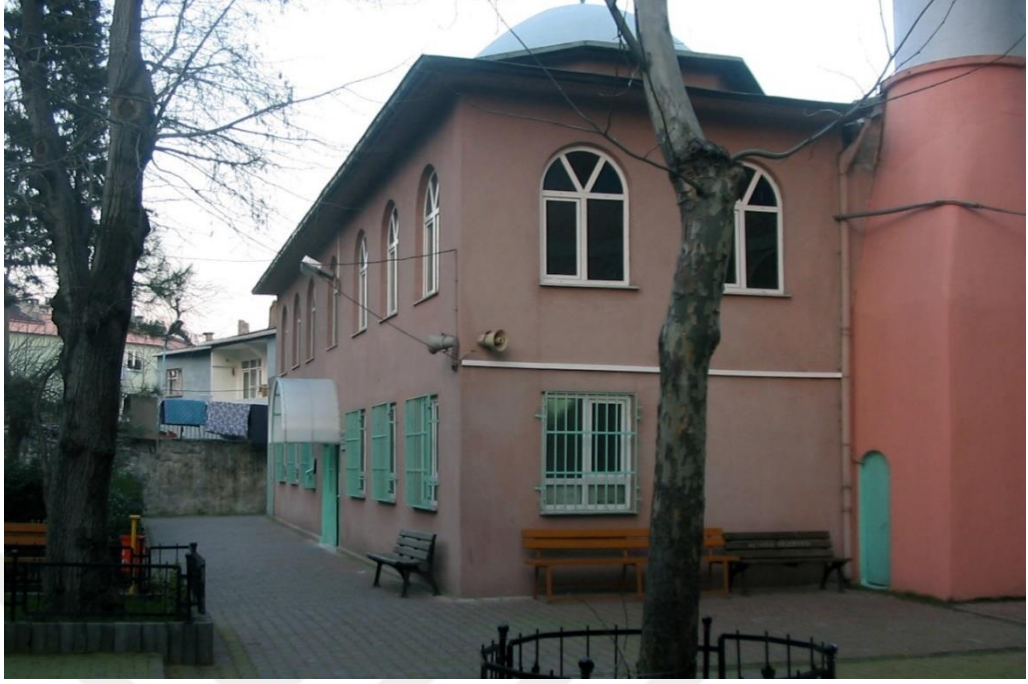
Şekil 5.23 : Sinan Paşa Camisi son cemaat yeri uygulama öncesi durumu (Ö.E.a.).
