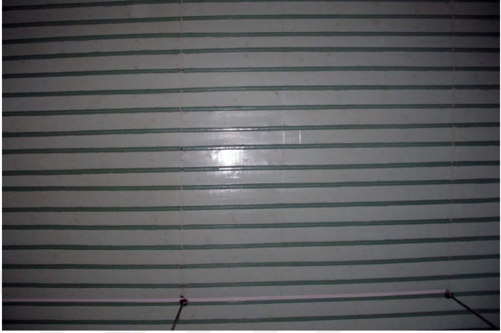
Şekil 5.31 : Sinan Paşa Camisi tavan kaplaması uygulama öncesi durumu (Ö.E.a.).
