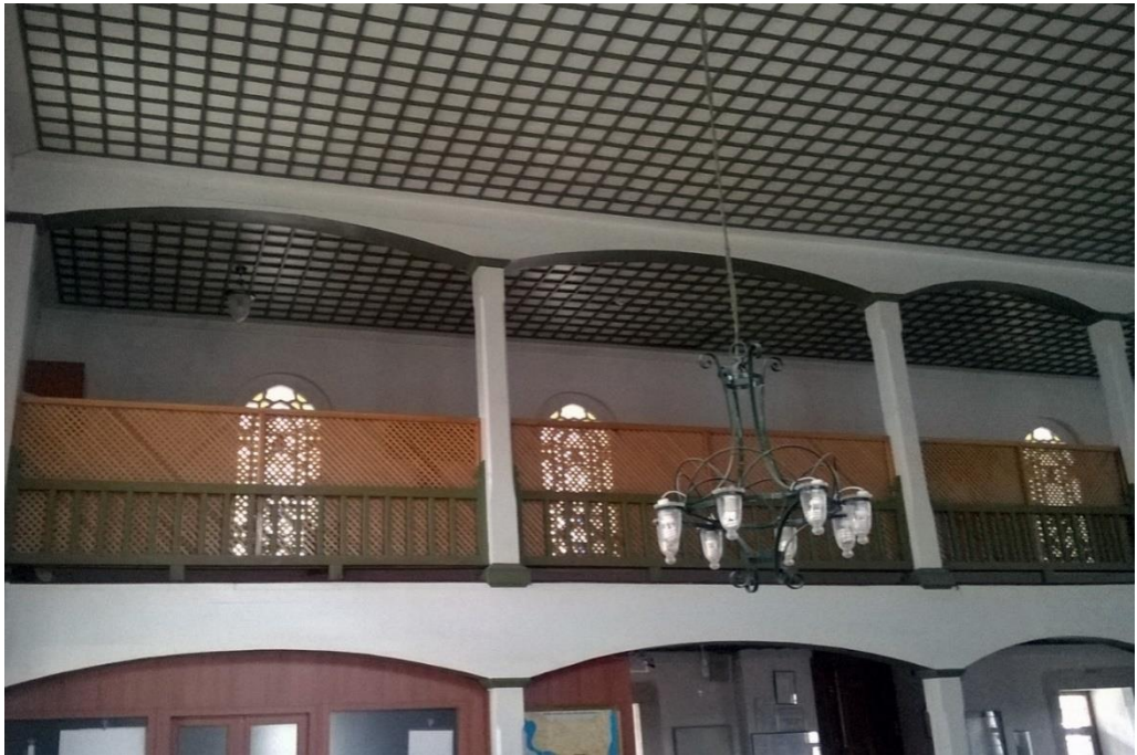
Şekil 5.28 : Sinan Paşa Camisi mahfil katı uygulama sonrası durumu (Ö.E.a.).
