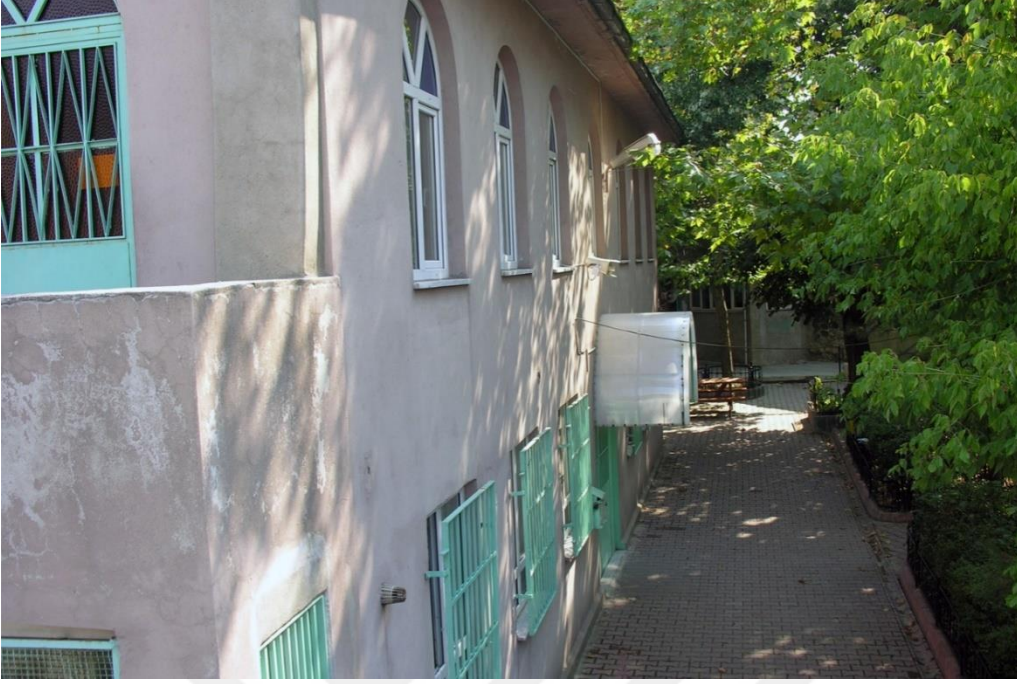
Şekil 5.25 : Sinan Paşa Camisi son cemaat yeri uygulama öncesi durumu (Ö.E.a.).
