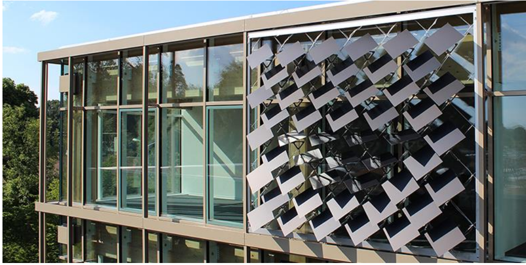
Şekil 4.26 Doğal kaynaklar evi güney cephe genel görünümü (Url-27).
