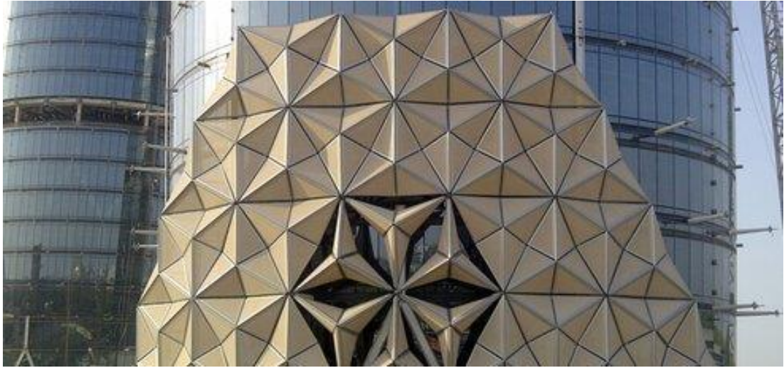
Şekil 4.13 Birimlerin birbirinden bağımsız olarak güneşe uyarlanan pozisyonlarının cephedeki görünümü (Url-17).
