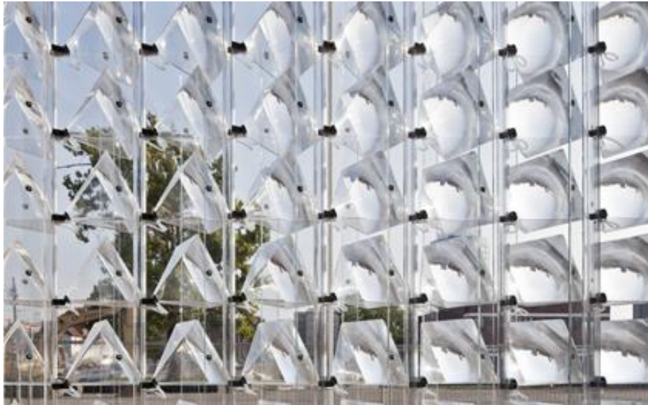
Şekil 4.8 Entegre konsantre güneş cephesi (Url-15).
