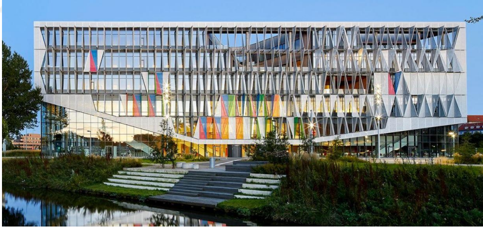
Şekil 4.19 Henning Larsen's Üniversite binası genel görünümü (Url-24).
