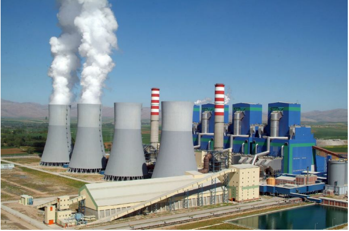
Şekil 1.4. Afşin-Elbistan Termik Santrali B ünitesi
