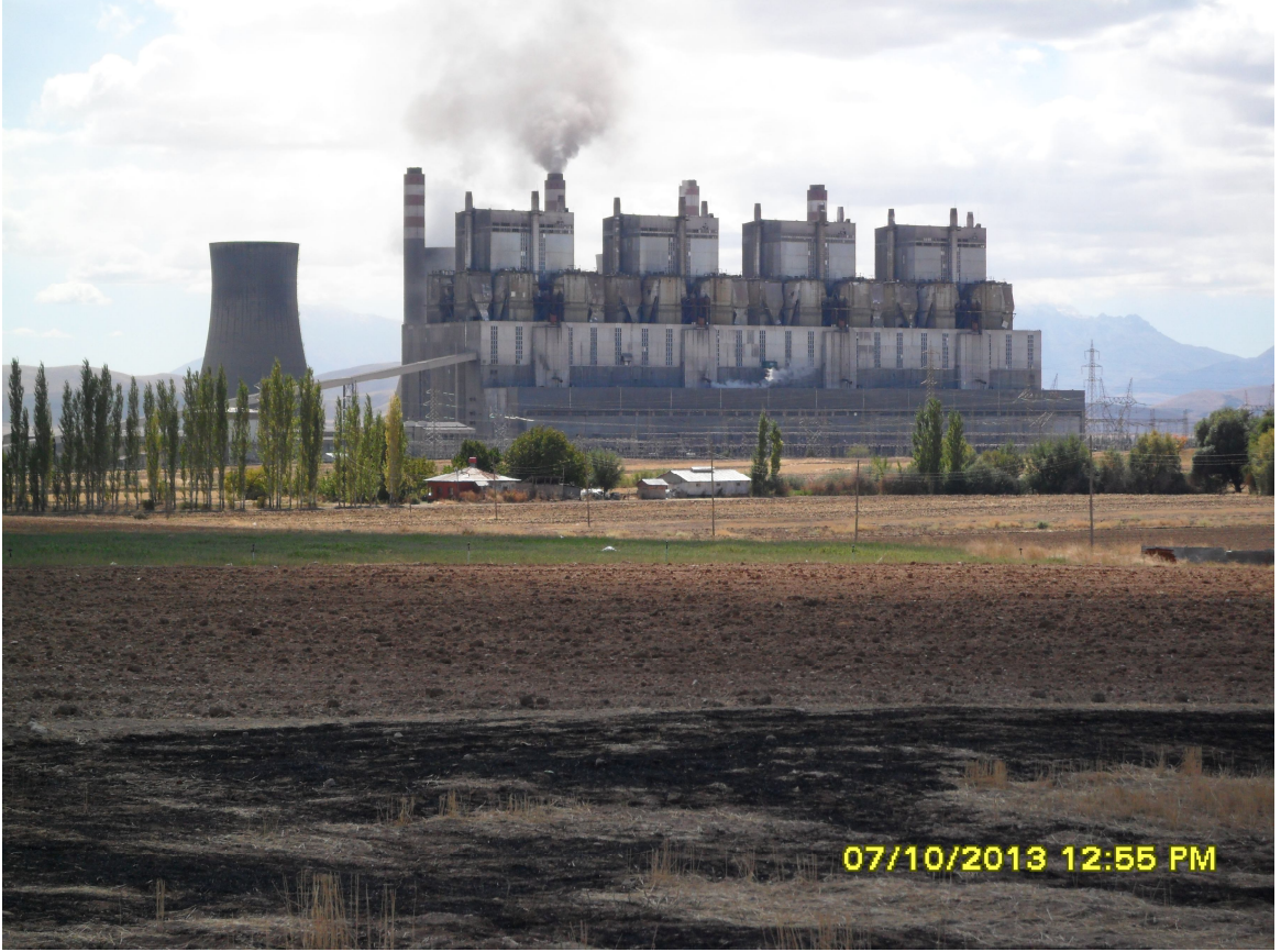
Şekil 1.3. Afşin-Elbistan Termik Santrali A ünitesi
