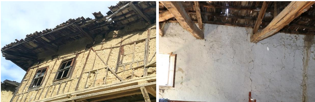
Şekil 3.101 : (Solda) 127 ada, 26 parseldeki konutun kaplamasız saçak altı ve (Sağda) 101 ada, 257 parseldeki konutun saçak oluşturmak amacıyla dışarı çıkan bırakma kirişi ve mertekleri (Turğut, 2018).
