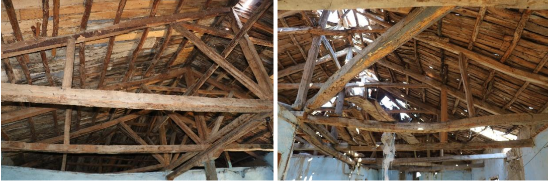
Şekil 3.100 : (Solda) 130 ada, 2 parseldeki ve (Sağda) 123 ada, 100 parseldeki konutun ahşap çatı sistemi (Turğut, 2018).
