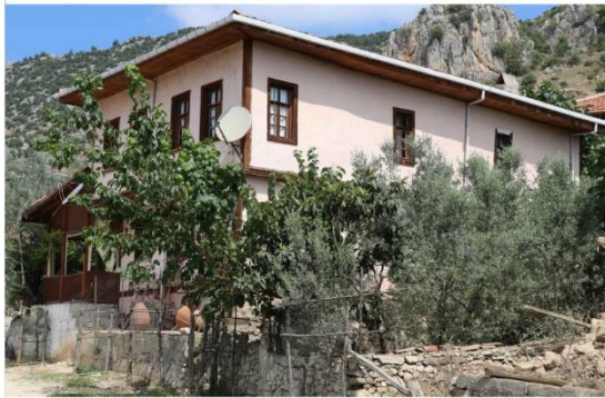
GÜNEY ve DOĞU CEPHESİ 101 ADA-225 PARSEL
