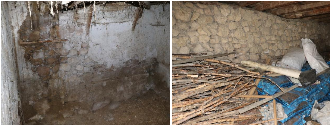
Şekil 3.87 : (Solda) 124 ada, 28 parsel ve (Sağda) 123 ada, 34 parselin toprak altında kalan cephelerinde görülen yığma moloz taş duvarlar (Turğut, 2018).
