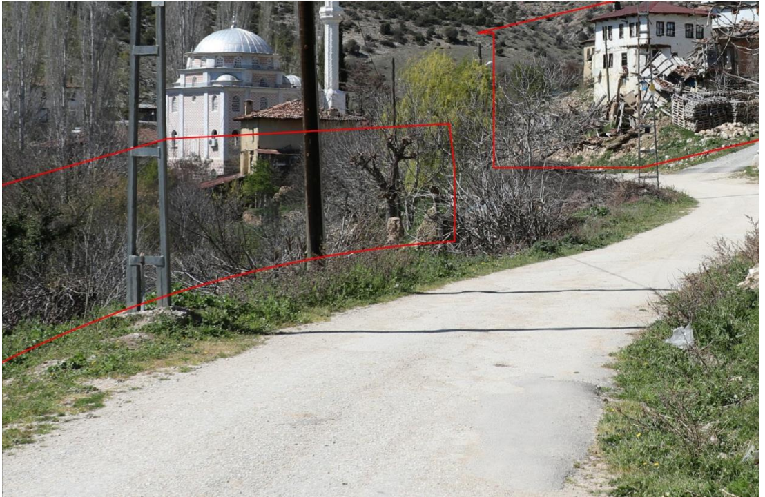
Şekil D.10 : (Solda) 123 ada, 29 parselde ve (Sağda) 129 ada, 5 parselde yer alan konutlara ait güncel fotoğraf (Turğut, 2019).
