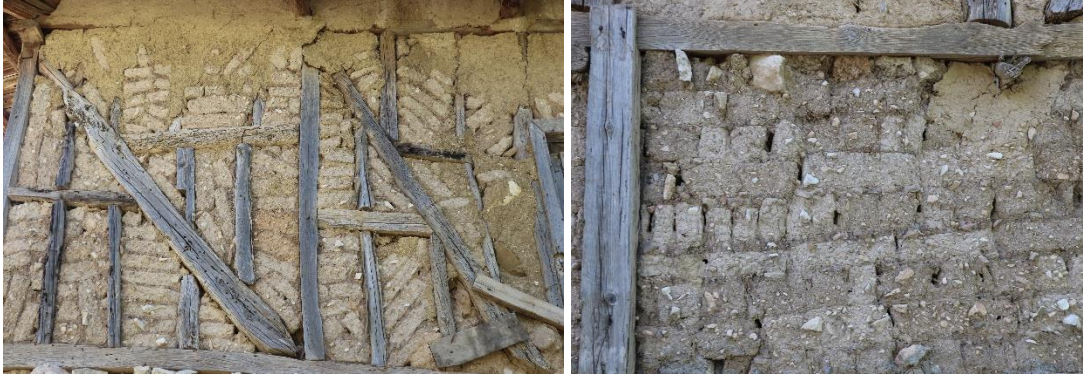
Şekil 3.104 : (Solda) 123 ada, 33 parseldeki konutta kerpicin kullanımı (Turgüt, 2018).
