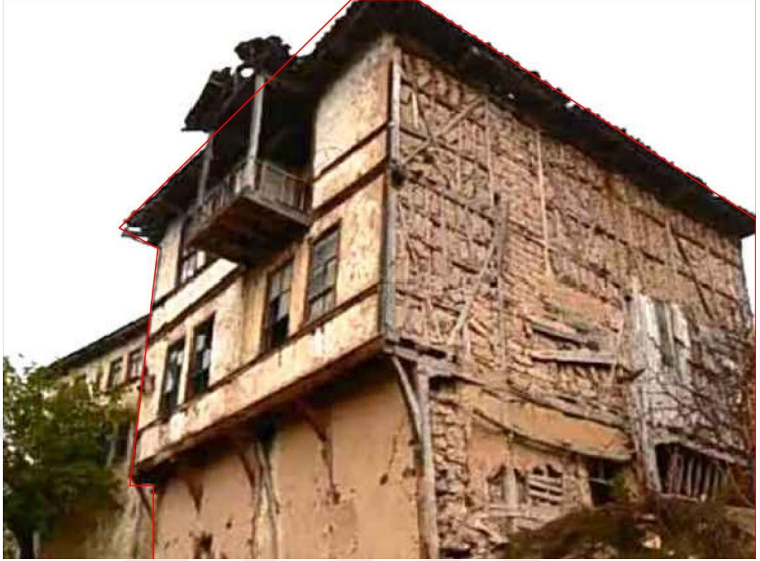
Şekil D.13 : 101 ada, 259 parselde yer alan konuta ait fotoğraf (URL 21).
