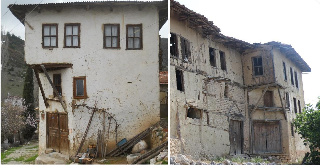
Şekil 3.64 : (Solda) 130 ada, 2parsel ve (Sağda) 101 ada, 192 parselde bulunan konutlarda görülen pahlı köşe çıkmalar (Turğut, 2018).
