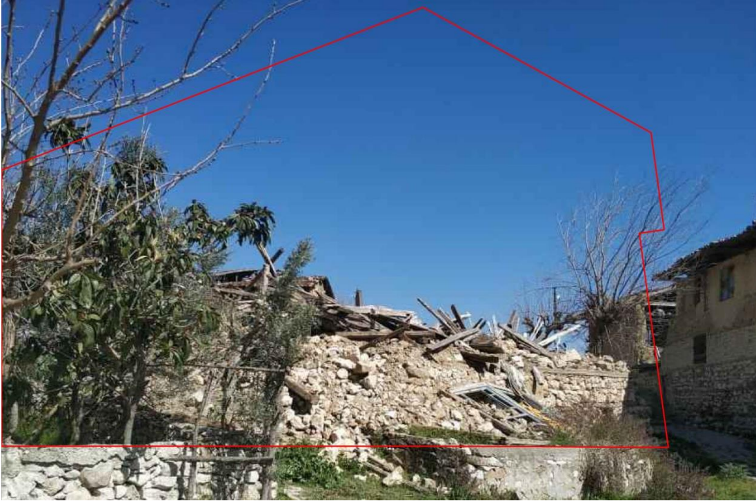
Şekil D.4 : 127 ada, 6 parselde yer alan konuta ait güncel fotoğraf (Turğut, 2019).
