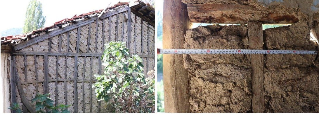
Şekil 3.105 : (Solda) 101 ada, 225 parselde ve (Sağda) 123 ada, 100 parseldeki konutlarda kerpiç tuğla kullanımı (Turğut, 2018).
