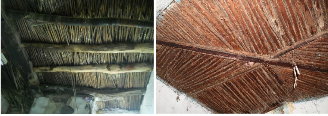
Şekil 3.95 : (Solda) 127 ada,26 parselde ve (Sağda) 124 ada, 28 parselde bulunan konutun döşeme kirişi üzerindeki malzemeler (Turğut, 2018).
