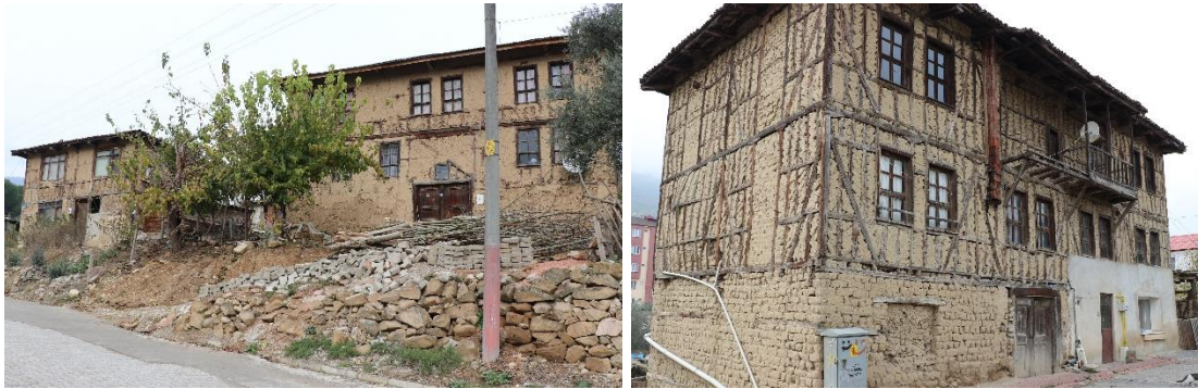
Şekil 2.16 : Bayırköy’de bulunan kerpiç dolgu hımış yapılar (Turğut,2018).
