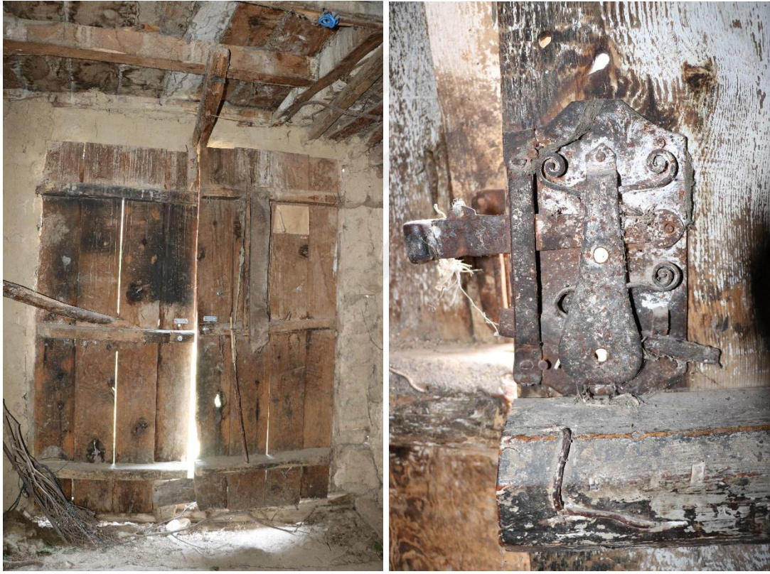
Şekil 3.73 : (Solda) 101 ada, 246 parselde bulunan çift kanatlı dış kapının ahşap kilit mekanizması ve 124 ada, 28 parseldeki kapının metal kilidi (Turğut, 2018).
