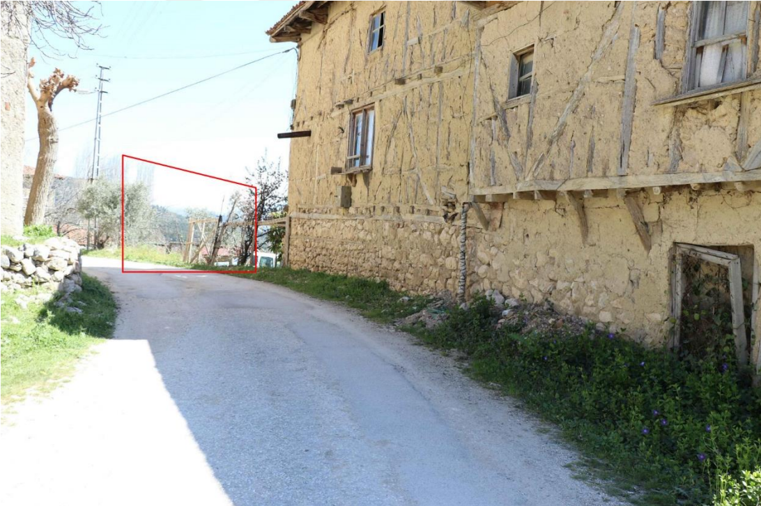
Şekil D.20 : 101 ada, 35 parsel ile 101 ada, 96 parsel arasında yer alan yapıya ait güncel fotoğraf (Turğut, 2019).
