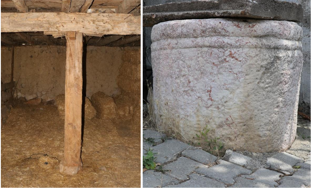
Şekil 3.85 : (Solda) 123 ada, 100 parselde bulunan ana dikmenin altındaki tek parça taş ve (Sağda) 128 ada, 2 parselin önündeki kuyu (Turğut, 2018).
