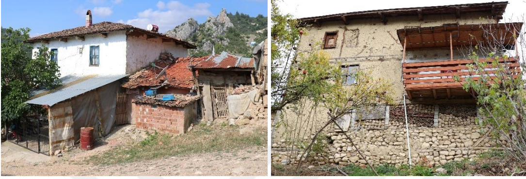
Şekil 4.16 : (Solda) 132 ada, 8 parseldeki konuta eklenen depo yapıları ve (Sağda) 123 ada, 34 parseldeki konuta eklenen balkon ile yapıların kütle etkisinde meydana gelen değişim (Turğut, 2018).
