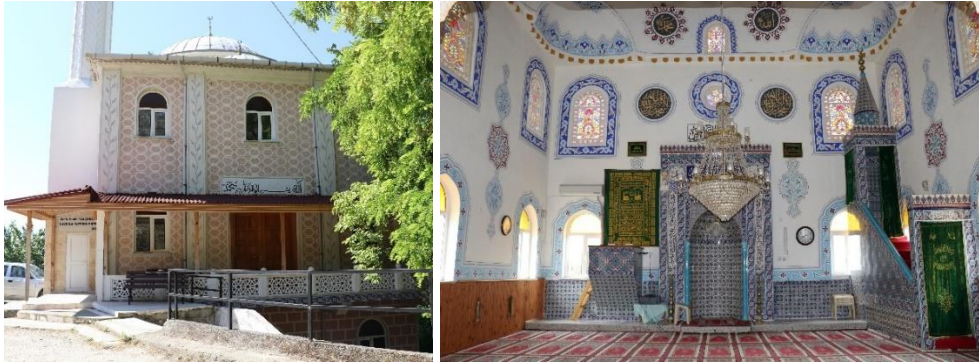
Şekil 3.9 : (Solda) 123 ada, 6 parselde bulunan batonarme karkas caminin dışından ve (Sağda) içinden görünüm (Turğut,2018).
