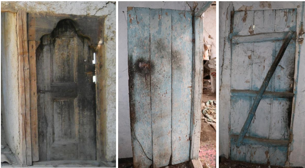
Şekil 3.75 : (Solda) 127 ada, 25 parselde ve (Ortada ve sağda) 124 ada, 28 parselde bulunan çakma iç kapılar (Turğut, 2018).
