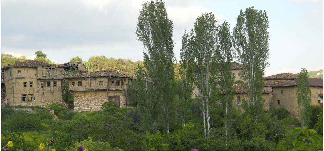
Şekil 3.61 : Günöören köyü geleneksel mimari dokusunun görünümü (Turğut, 2018).
