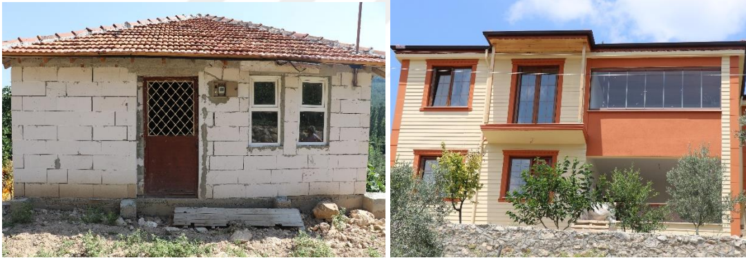
Şekil 5.2 : (Solda) 128 ada, 3 parselde betonarme döşeme+yığma gaz beton ile ve (Sağda) 101 ada, 181 parselde betonarme karkas sistemle inşa edilmiş yapılar (Turğut, 2018).
