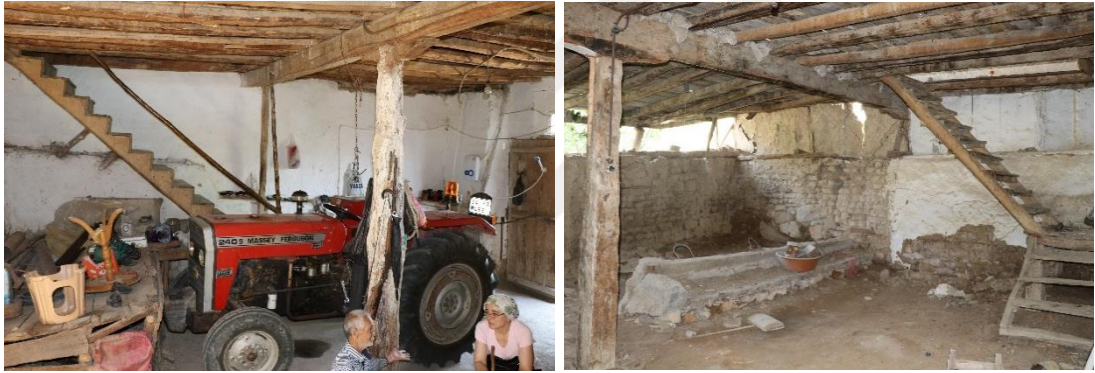
Şekil 3.40 : (Solda) 101 ada, 244 parselde zeminine beton dökülmüş ve (Sağda) 101 ada, 225 parselde zemini sıkıştırılmış toprak kaplı taşlık mekanı (Turgüt, 2018).
