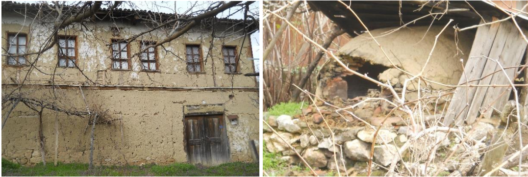
Şekil 3.16 : (Solda) 113 ada, 143 parselde bulunan yığma taş+yığma kerpiç+ahşap karkas yapım sistemine sahip konut ve (Sağda) bahçesinde bulunan yığma taş üzerine yığma tuğla ile kubbe formunda inşa edilen fırın (Turğut,2018).
