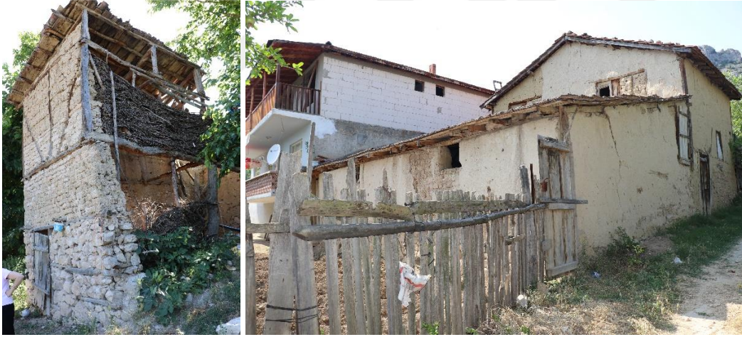
Şekil 3.15 : (Solda) 101 ada, 258 parselde ve (Sağda) 126 ada, 6 parselde bulunan depo yapıları (Turğut,2018).
