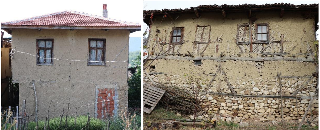
Şekil 4.19 : (Solda) 127 ada, 7 parseldeki ve (Sağda) 123 ada, 33 parseldeki konutta briket ve kerpiç malzeme ile kapatılan kapı ve pencere boşlukları (Turğut, 2018).
