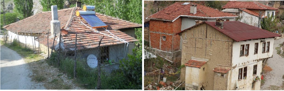
Şekil 4.21 : (Solda) 124 ada, 1 parselde çatı formu bozulan konut ve (Sağda) muhdes çatı kaplama malzemesi kullanılan konutlar (Turğut, 2018).
