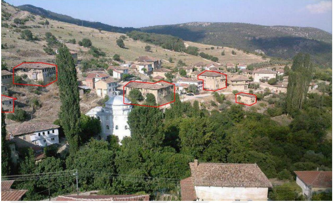
Şekil D.21 : Soldan sağa 101 ada, 226 parsel; 101 ada, 218 parsel; 129 ada, 3-5 parsel; 127 ada, 6 parsel ve 123 ada, 29 parselde yer alan yapılara ait fotoğraf (URL 20).
