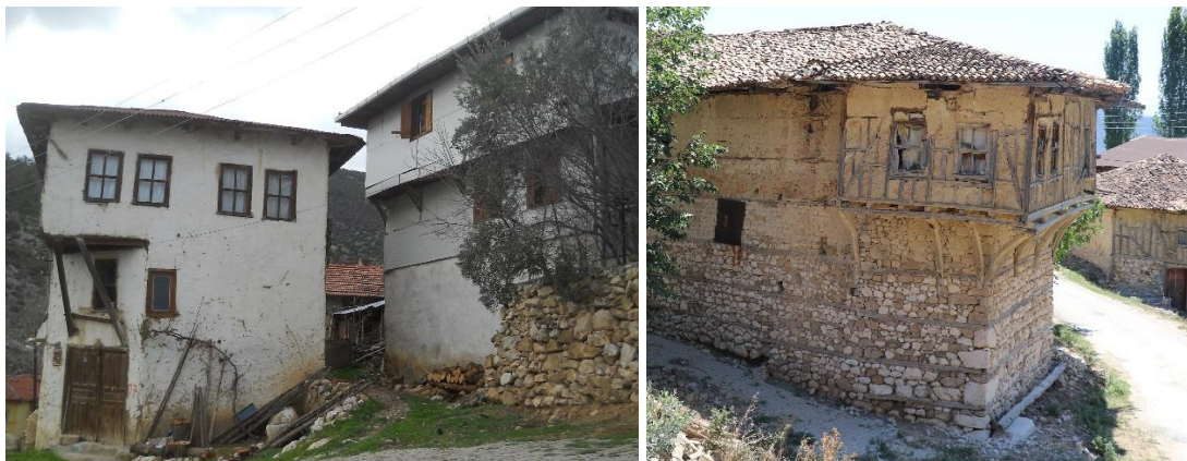
Şekil 3.35 : Üst katlarında çıkma bulunan yapılardan görünüm (Turğut, 2018).
