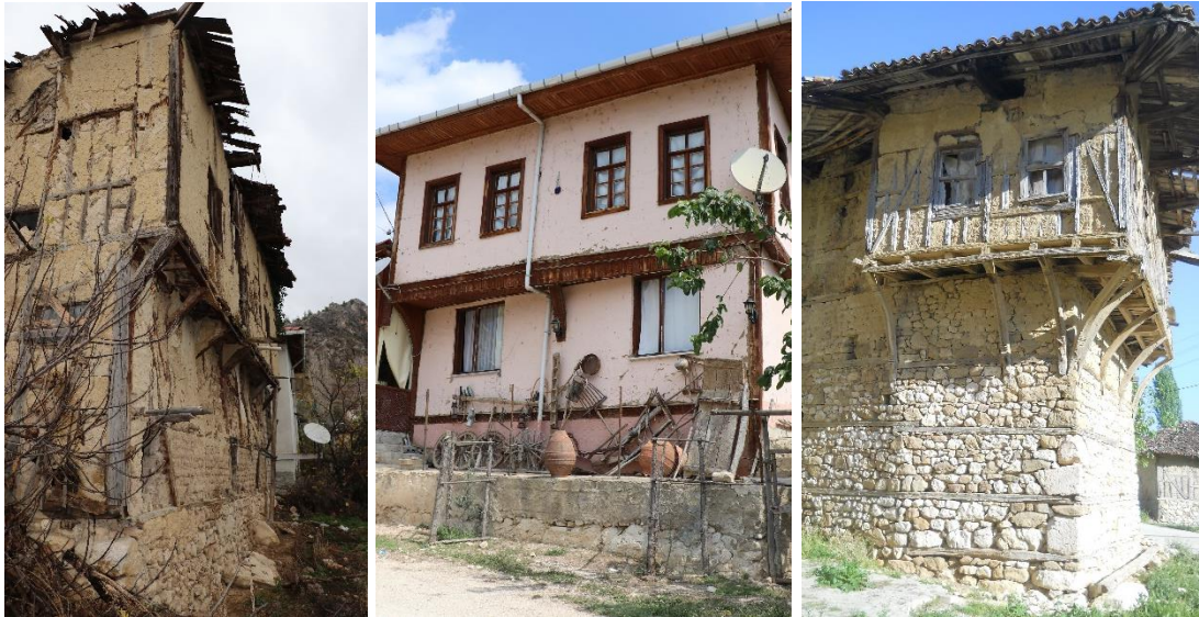
Şekil 3.63 : (Solda) 124 ada, 28 parsel, (Ortada) 128 ada, 2 parsel ve (Sağda) 127 ada, 26 parselde bulunan konutların çıkmaları (Turğut, 2018).
