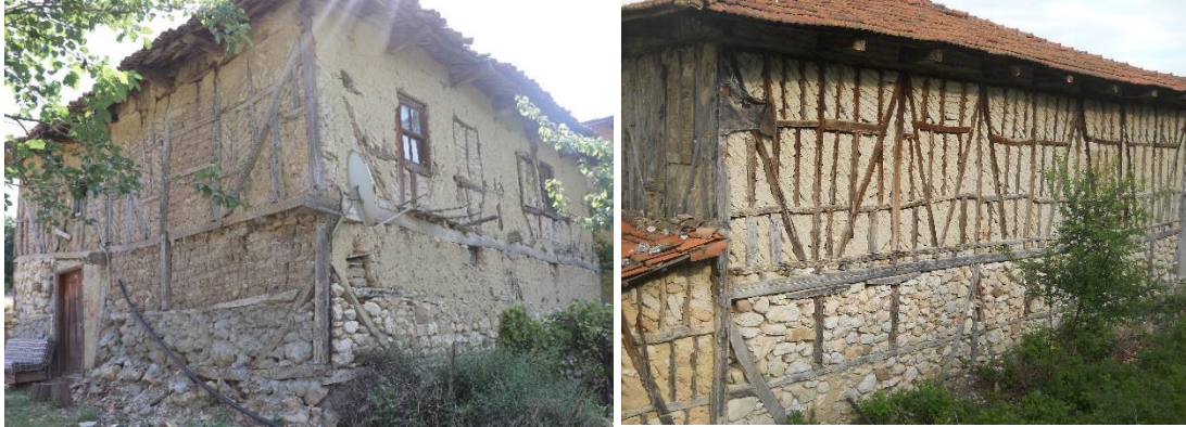
Şekil 3.62 : (Solda) 123 ada, 33parsel ve (Sağda) 101 ada, 235 parselde bulunan konutların dış duvarları (Turğut, 2018).
