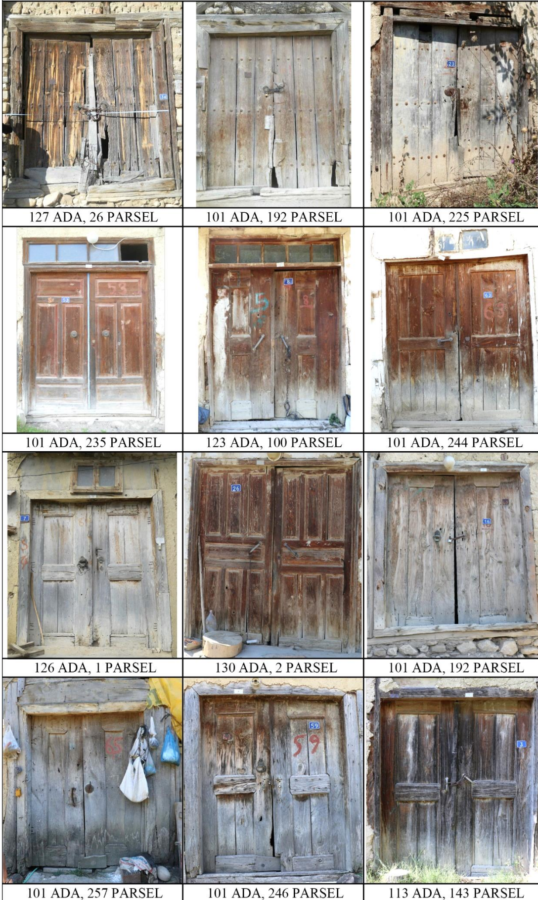
Şekil 3.78 : Günüören köyünde bulunan dış kapı örnekleri (Turğut,2018).
