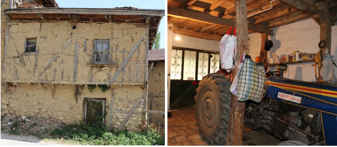
Şekil 4.6 : (Solda) 123 ada, 35 parselde yol seviyesinin altında kalmış ve (Sağda) 123 ada, 96 parselde motorlu taşıt için değiştirilmiş giriş kapısı (Turğut, 2018).
