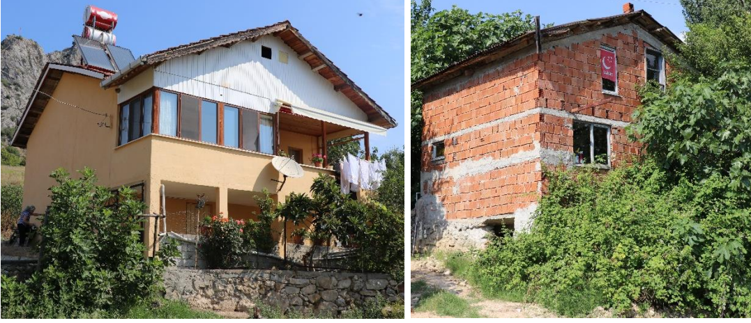
Şekil 4.8 : (Solda) 101 ada, 187 parselde betonarme karkas sistemle ve (Sağda) 113 ada, 142 parselde betonarme döşeme+yığma tuğla ile inşa edilmiş yapılar (Turğut, 2018).
