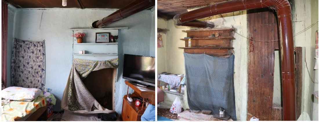
Şekil 3.53 : (Solda) 130 ada, 2 parsel ve (Sağda) 101 ada, 244 parselde ocağa bağlanan soba boruları (Turğut, 2018).
