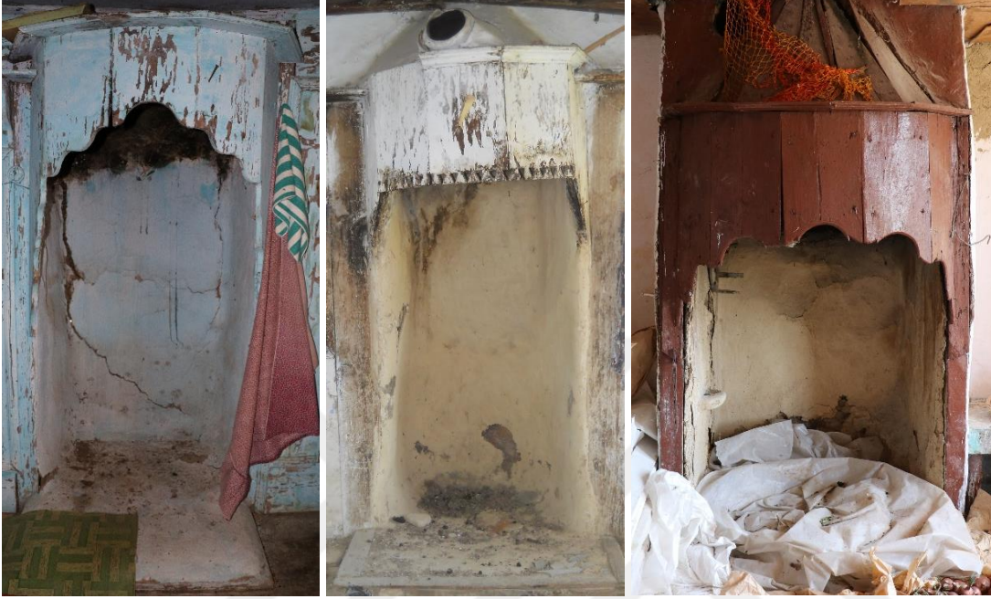
Şekil 3.51 : (Solda) 123ada, 34 parsel, (Ortada) 127 ada, 26 parsel ve (Sağda) 101 ada, 246 parselde bulunan ahşap yaşmak detayları (Turğut, 2018).
