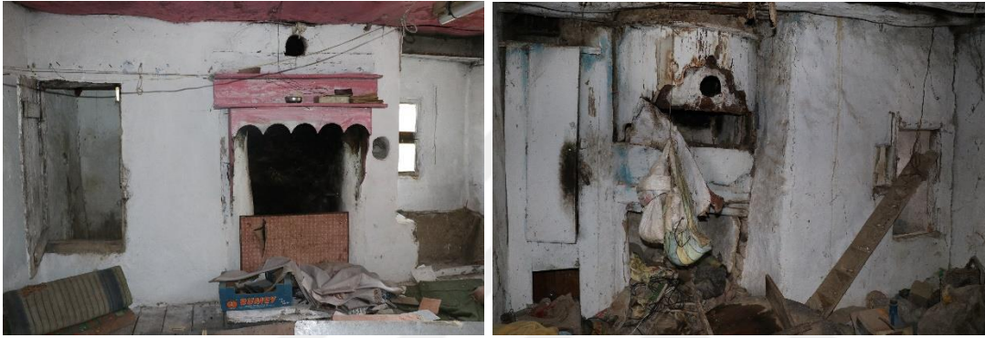
Şekil 3.47 : (Solda) 123 ada, 102 parseldeki odanın ocak ve gusülhanesi ve (Sağda) 124 ada, 28 parseldeki odanın ocak, gusülhane ve dolabı (Turğut, 2018).
