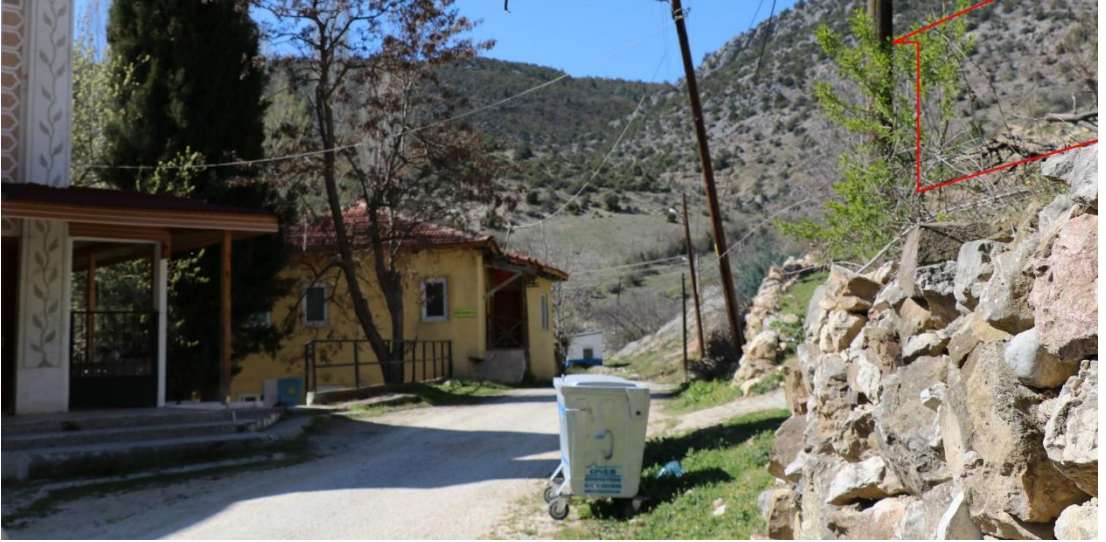
Şekil D.18 : 101 ada, 226 parselde yer alan konuta ait güncel fotoğraf (Turğut, 2019).
