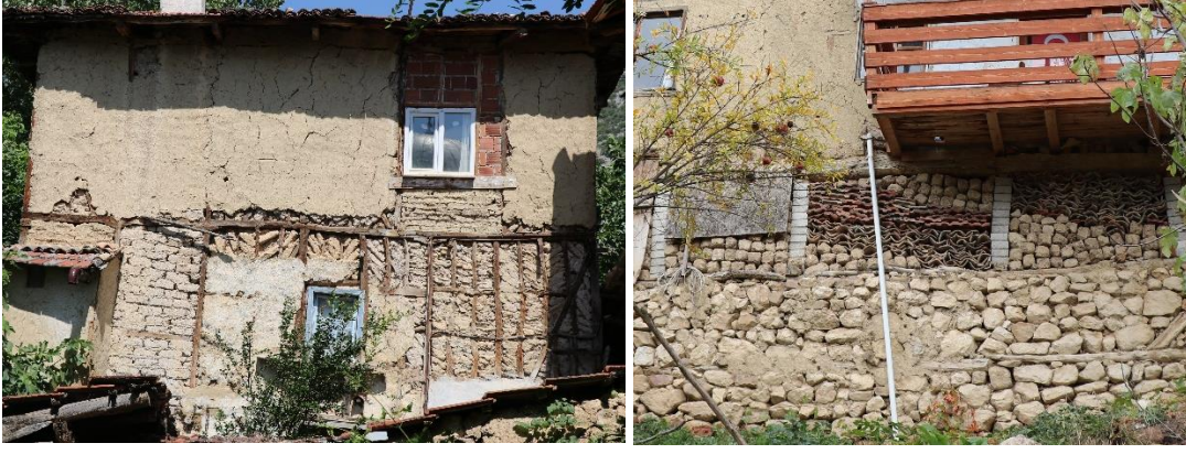
Şekil 4.20 : (Solda) 123 ada, 2 parseldeki ve (Sağda) 123 ada, 34 parseldeki konutta alaturka, marsilya kiremit, tuğla ve kerpiç tuğla ile tümlenmesi (Turğut, 2018).
