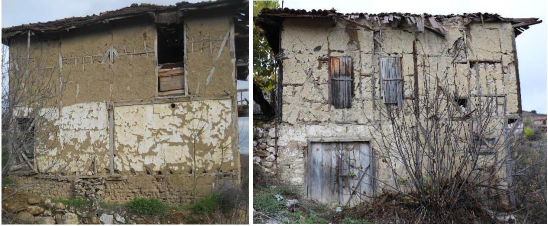
Şekil 4.25 : (Solda) 130 ada, 2 parseldeki ve (Sağda) 124 ada, 28 parseldeki konutların dökülmüş çamur sıvalı cepheleri (Turğut, 2018).
