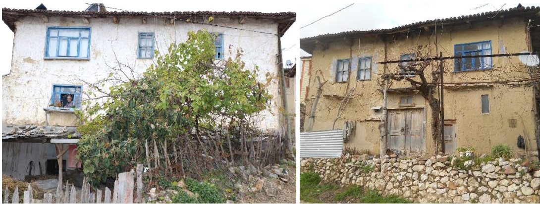
Şekil 4.17 : (Solda) 123 ada, 96 parseldeki ve (Sağda) 126 ada, 1 parseldeki konutta pencerelerin genişletilmesiyle değişen dolu-boş oranı (Turğut, 2018).
