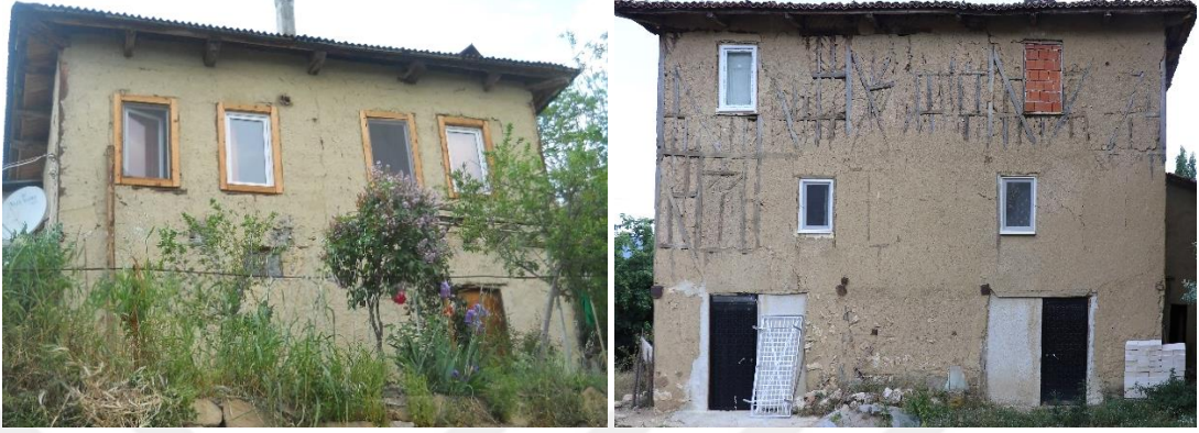
Şekil 4.18 : (Solda) 101 ada, 241 parseldeki konutta kullanılan pvc pencere ve (Sağda) 127 ada, 21-22 parseldeki konutta kullanılan pvc pencere ve demir kapı (Turğut, 2018).
