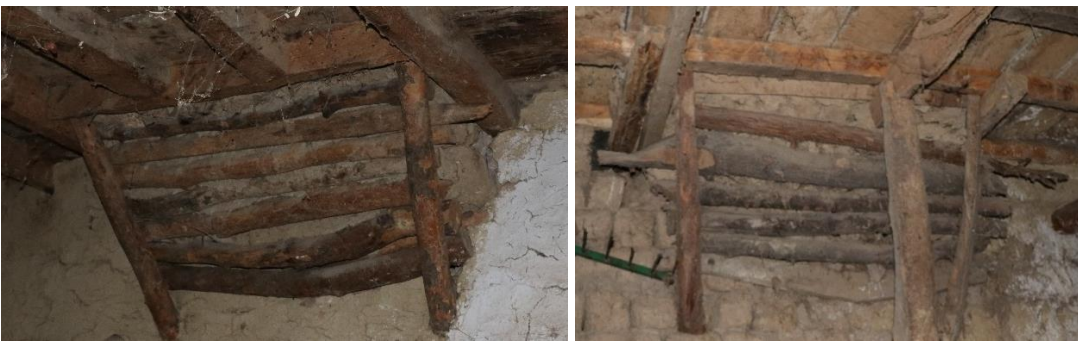
Şekil 3.48 : (Solda) 101 ada, 257 parsel ve (Sağda) 123 ada, 96 parseldeki ocakların altında bulunan destekler (Turğut, 2018).
