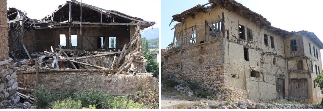
Şekil 5.5 : 101 ada, 192 parselde bütünleme yapılması öngörülen yapının ön ve arka cephesinden görünümü (Turğut, 2018).
