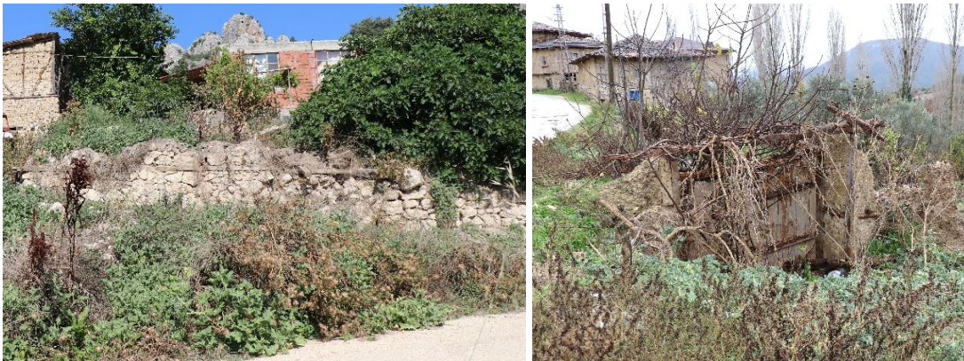
Şekil 3.3 : (Solda) Kalıntı olarak nitelendirilen 101 ada, 259 parseldeki taş temel ve (Sağda) 123 ada, 29 parseldeki duvar parçası (Turğut,2018).
