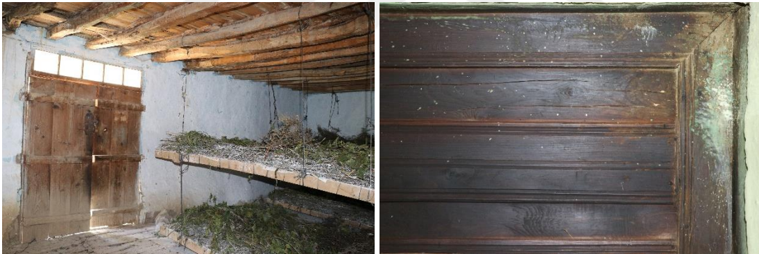
Şekil 3.96 : (Solda) 123 ada,100 parseldeki konutun sofasında döşeme kirişlerine asılan kerevetler ve (Sağda) 101 ada, 244 parseldeki konutta görülen pasalı tavan (Turğut, 2018).
