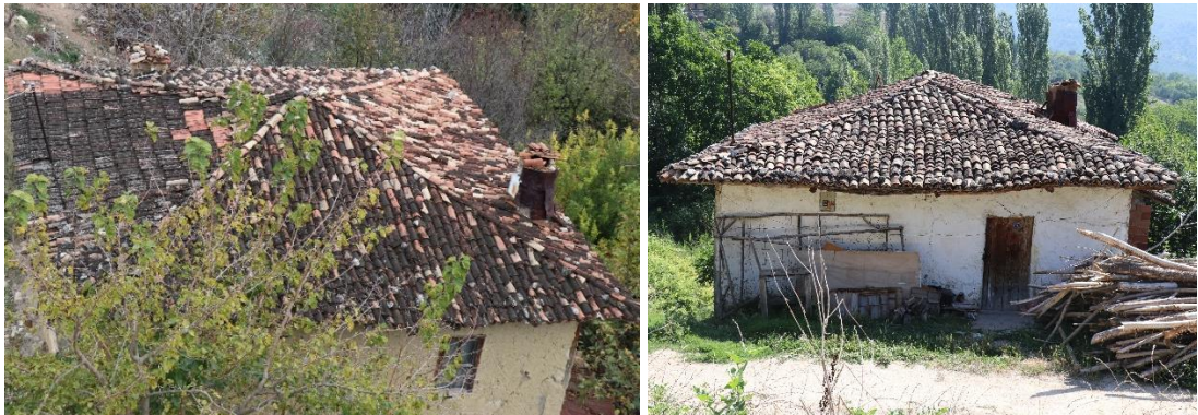
Şekil 3.80 : (Solda) 123 ada, 102 parsel ve (Sağda) 124 ada, 40 parseldeki yapıların çatı kaplama malzemeleri (Turğut, 2018).
