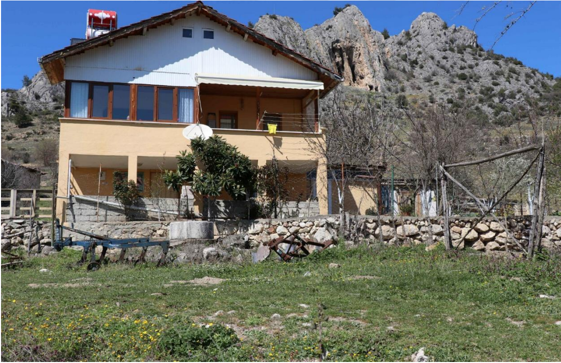
Şekil D.8 : 101 ada, 187 parselde yer alan konuta ait güncel fotoğraf (Turğut, 2019).
