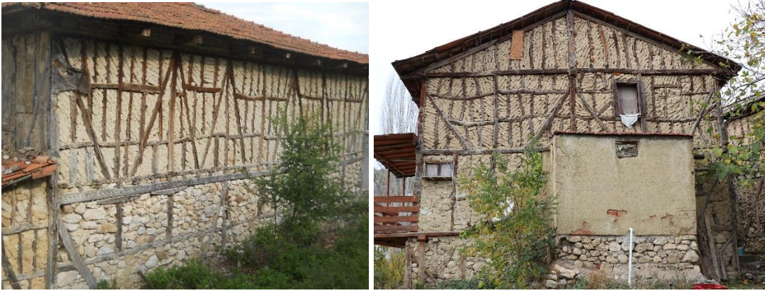
Şekil 3.89 : (Solda) 101 ada, 235 parsel ve (Sağda) 123 ada, 34 parselde bulunan konutlarda görülen ahşap karkas sistem (Turğut, 2018).
