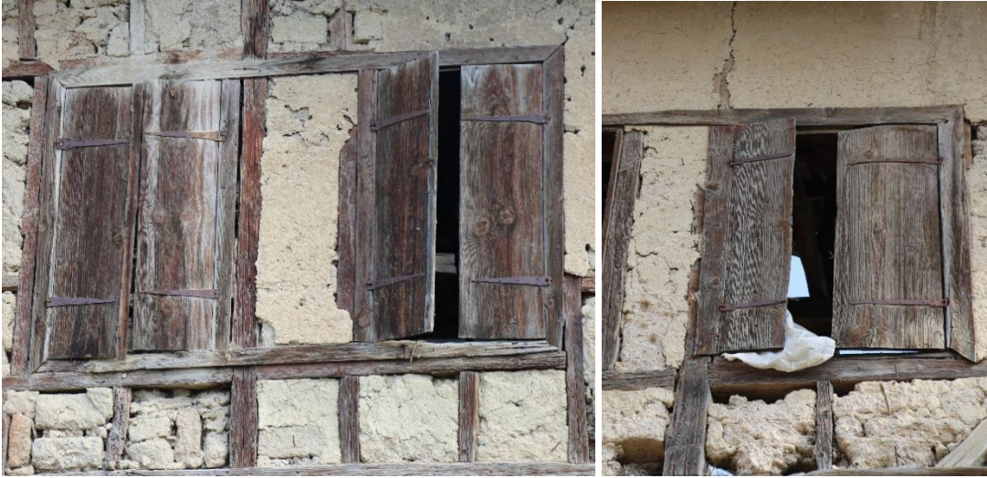
Şekil 3.67 : (Solda) 127 ada, 26 parsel ve (Sağda) 101 ada, 192 parselde bulunan ahşap kapaklar (Turğut, 2018).
