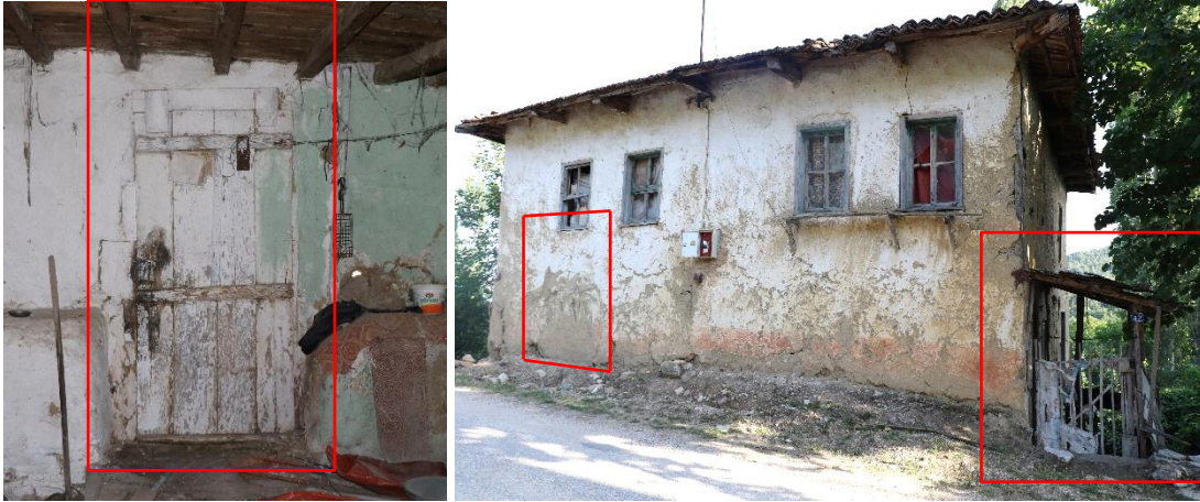
Şekil 4.9 : 123 ada, 102 parselde bulunan konutun kapatılan kapısı ve yan cepheye alınan girişi (Turğut, 2018).
