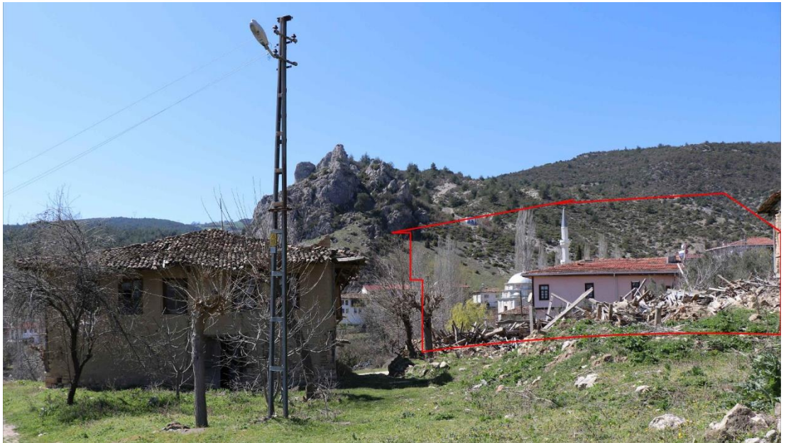
Şekil D.2 : 127 ada, 6 parselde yer alan konuta ait güncel fotoğraf (Turğut, 2019).
