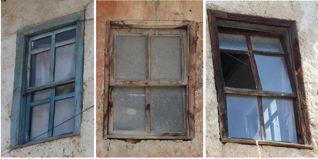
Şekil 3.65 : (Solda) 123 ada, 96 parsel, (Ortada) 129 ada, 4 parsel ve (Sağda) 101 ada, 225 parselde bulunan konutların giyotin pencereleri (Turğut, 2018).
