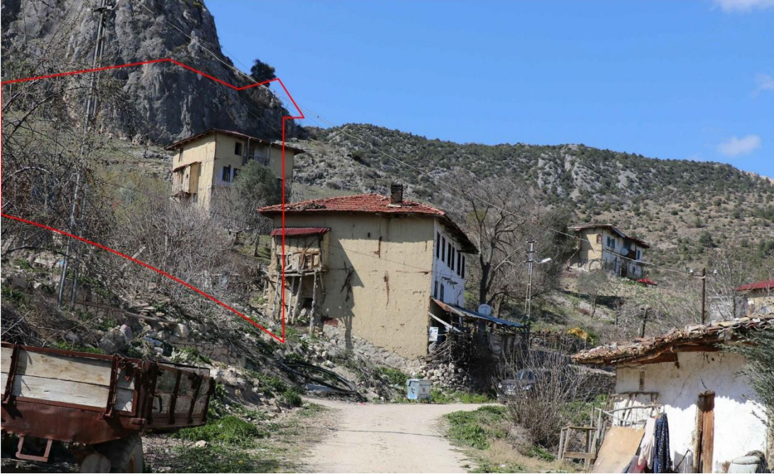
Şekil D.12 : 101 ada, 259 parselde yer alan konuta ait güncel fotoğraf (Turğut, 2019).
