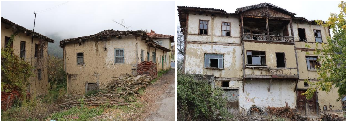
Şekil 2.20 Sarmaşık köyünde bulunan kerpiç dolgulu hımış yapılar (Turğut,2018).
