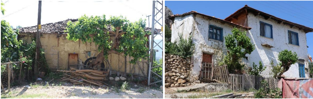
Şekil 3.7 : (Solda) 124 ada, 28 parsel ve (Sağda) 132 ada, 2parsel önlerindeki dut ağaçları (Turgüt,2018).
