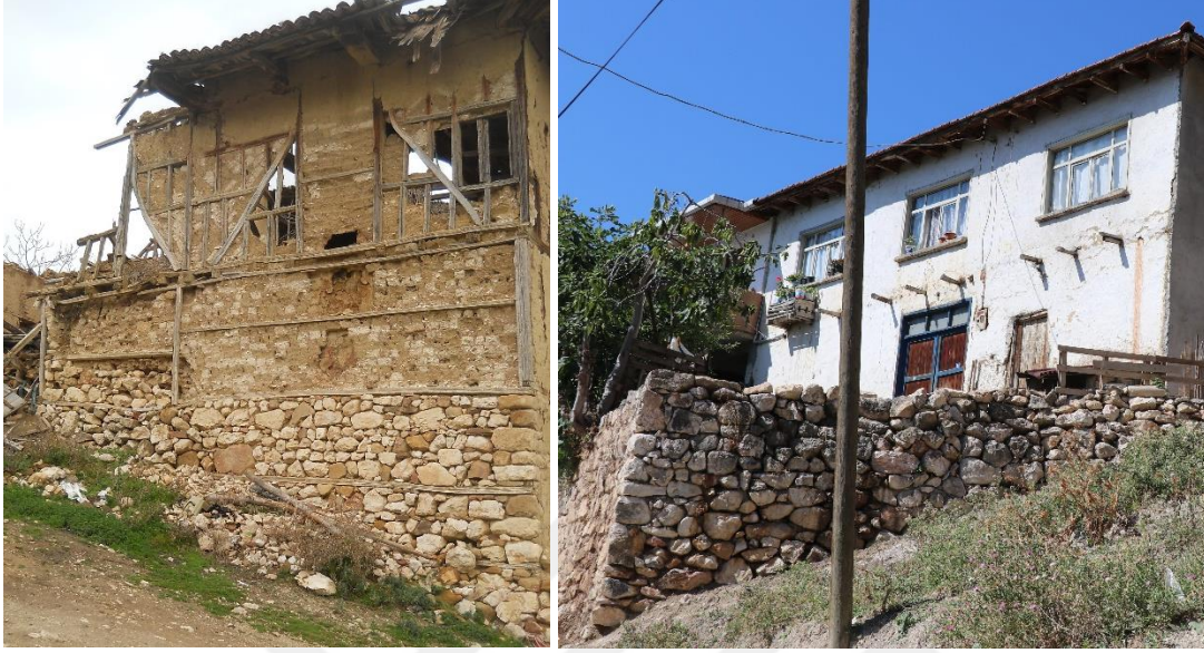
Şekil 3.103 : (Solda) 101 ada, 192 parseldeki konutun zemin kat duvarında ve (Sağda) 101 ada 254 parselde konut dışında taş kullanımı (Turğut, 2018).
