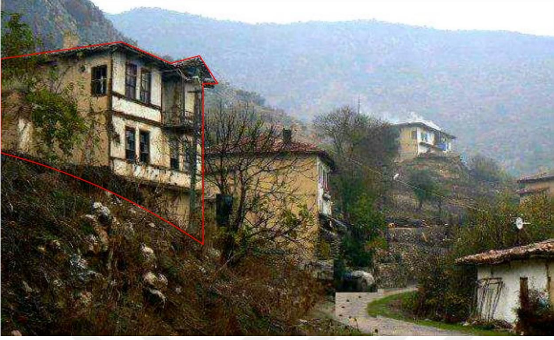
Şekil D.11 : 101 ada, 259 parselde yer alan konuta ait fotoğraf (URL 21).
