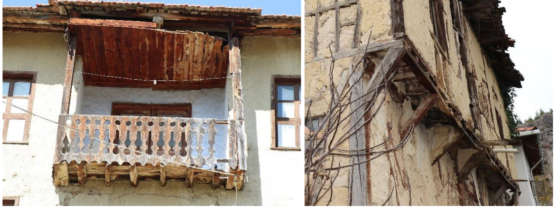
Şekil 3.98 : (Solda) 101 ada, 235 parseldeki konutta görülen konsol ve (Sağda) 124 ada, 28 parseldeki konutta görülen payandalı çıkma (Turğut, 2018).
