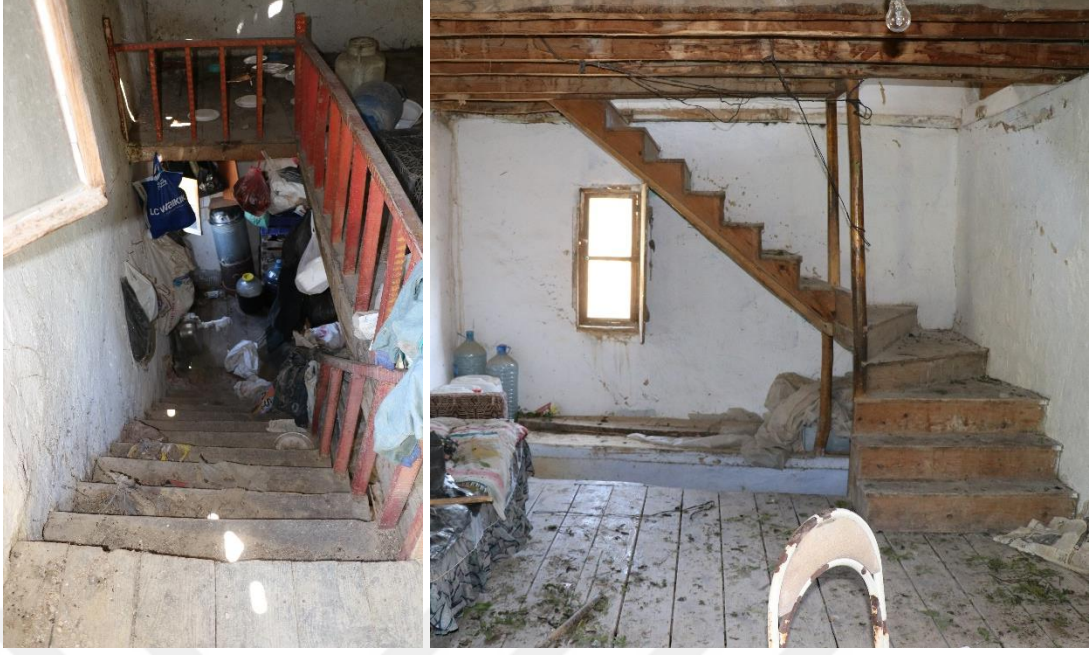
Şekil 3.43 : (Solda) 101 ada, 257 parselde ve (Sağda) 101 ada, 246 parselde birinci kat ile ikinci kat arasında bulunan merdivenler (Turğut, 2018).
