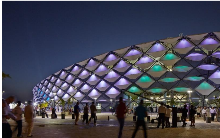
Şekil 3.4 Stadyumun dış kabuğundaki-cephe kaplamasındaki membran doku örneği
