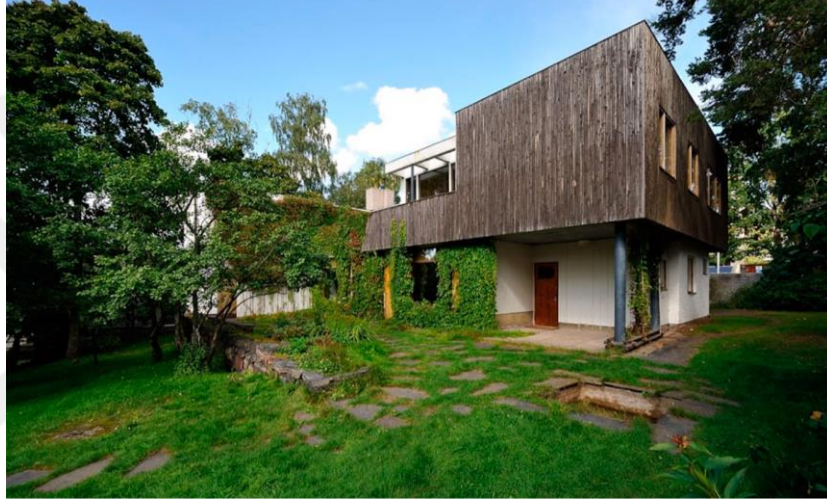
Şekil 5.30 Aalto Evi'ndeki iç içe geçmiş gibi görünen kotlar arasında gezinen iki ana kübik biçimdeki kütlelerin dışarıdan genel görünümü.
