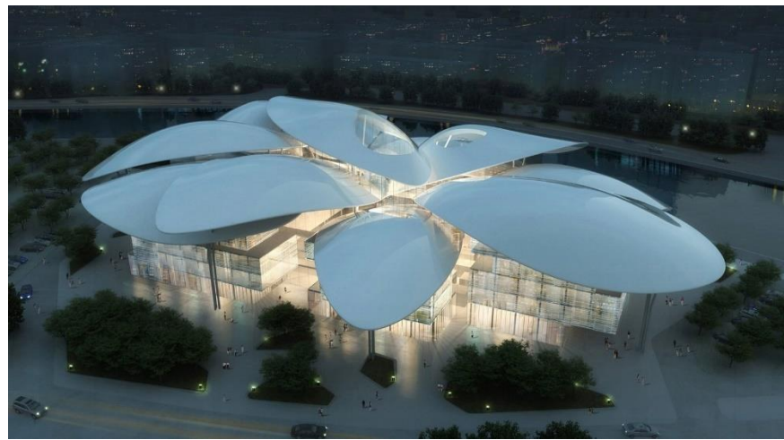
Resim 4.14: Tiflis Kamu Hizmet Binası, Gürcistan, 2012, Dorian ve Massimiliano Fuksas, URL-26
