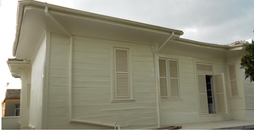
Resim D.10 Abdullah Erten Konağı – 1 kat arka cephe ahşap kepenkli giyotin pencereler (Nihan Polatdemir Fotoğraf Arşivinden)
