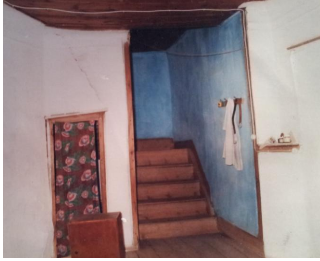
Resim 3.29 Çeşmeli Konak - Restorasyon öncesi katlara çıkan merdivenler, tavan ve zemin döşemeleri (Tufan Atalayman Fotoğraf Arşivinden)
