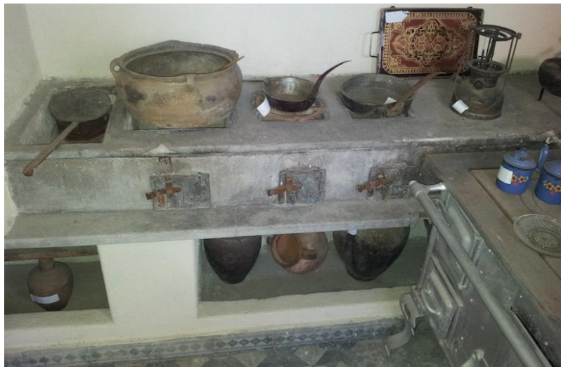
Resim 3.47 Hocaazade Konađı – Dökme mozaik taş ile yapılmış odun ocađı (Nihan Polatdemir Fotoğraf Arşivinden)
