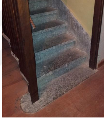
Resim 3.30 Hocasade Konağı – Bodrum kattan zemin kata çıkan dökme mozaik merdiven (Nihan Polatdemir Fotoğraf Arşivinden)
