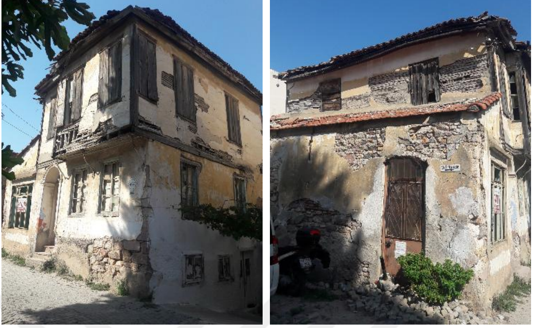
Resim 2.1 Ayvalık Cumhuriyet Caddesi – Geleneksel Türk Evi özelliği taşıyan kagir yapı, az eğimli bir parselde inşa edilmiş avlulu konut örneği (Nihan Polatdemir Fotoğraf Arşivinden)
