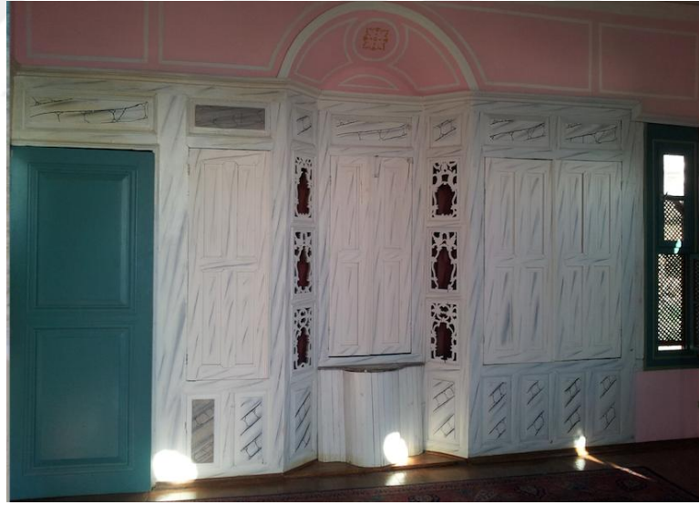
Resim 4.32 Abdullah Efendi Konağı – Bir odanın duvarından gömme dolap örneği (Nihan Polatdemir Fotoğraf Arşivinden)
