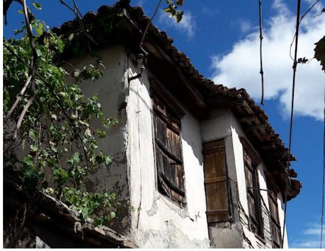
Resim 2.11 Altınoluk Siraodalar Caddesi 3. Sokak – Altı kaplamasız saçak örneği (Nihan Polatdemir Fotoğraf Arşivinden)
