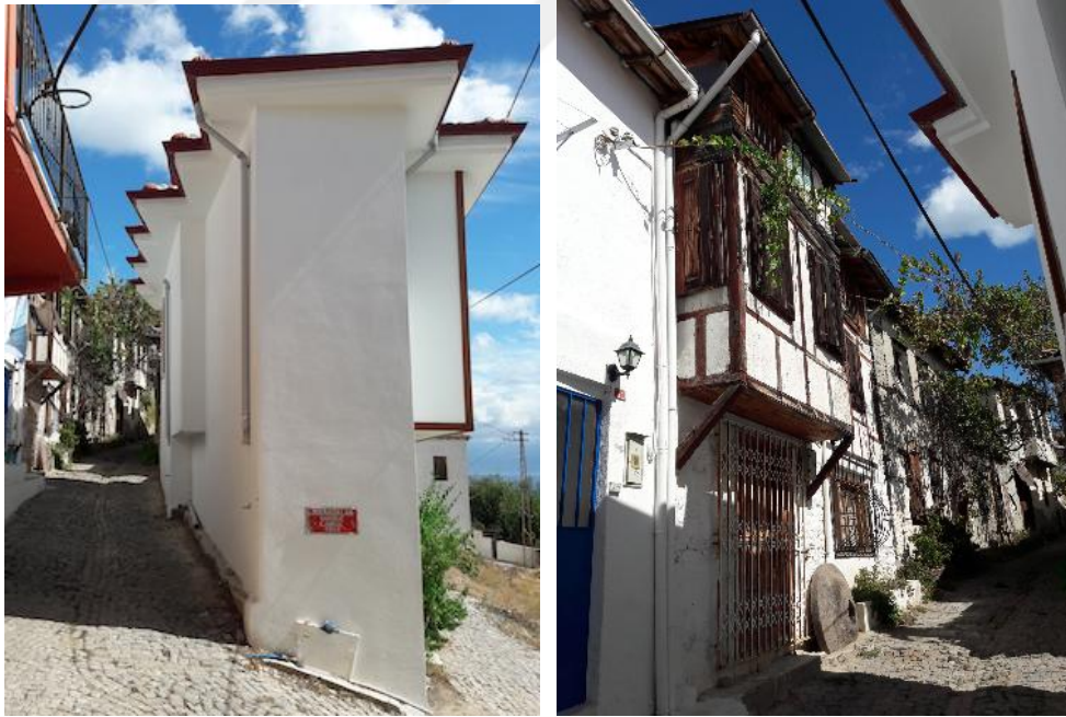
Resim 2.4 Altınoluk Sıraodalar Caddesi – Eğimli arazide bitişik nizamda inşa edilmiş Geleneksel Türk Evleri, sağ sıradaki evler eğimden dolayı çift girişli, asma katlı (Nihan Polatdemir Fotoğraf Arşivinden)
