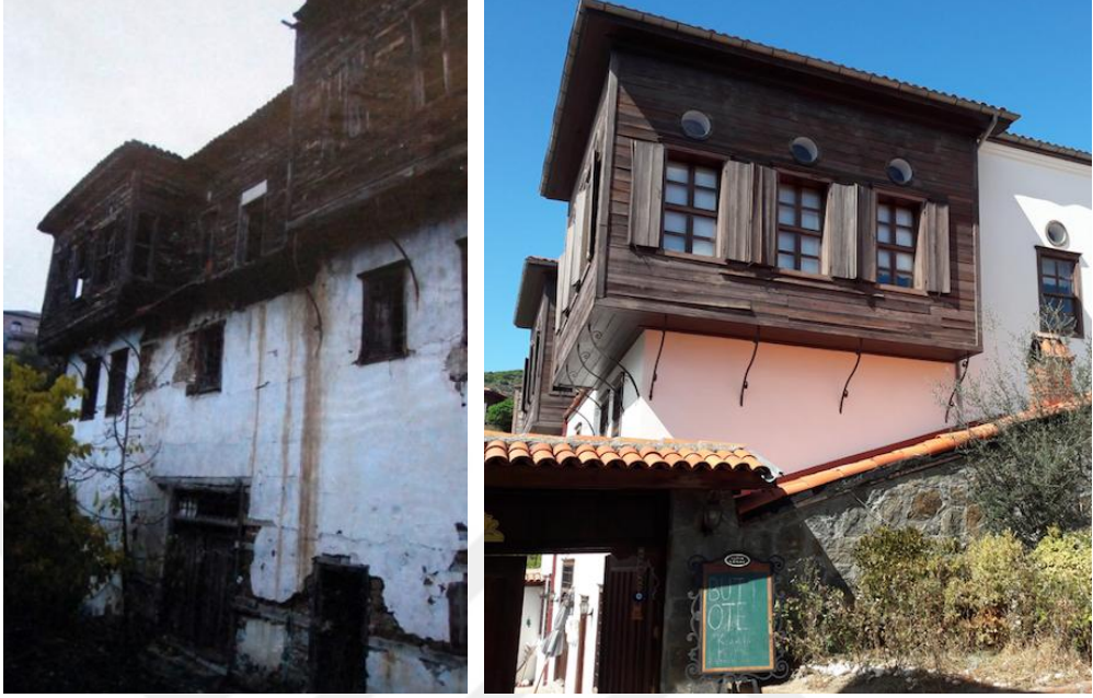
Resim C.3 Dülger İsmail Konağı – Restorasyon öncesi ve sonrası cephe görünüşü (Soldaki Fotoğraf Edremit Belediyesi İmar ve Şehircilik Müdürlüğü Arşivi, Sağdaki Fotoğraf Nihan Polatdemir Arşivi)
