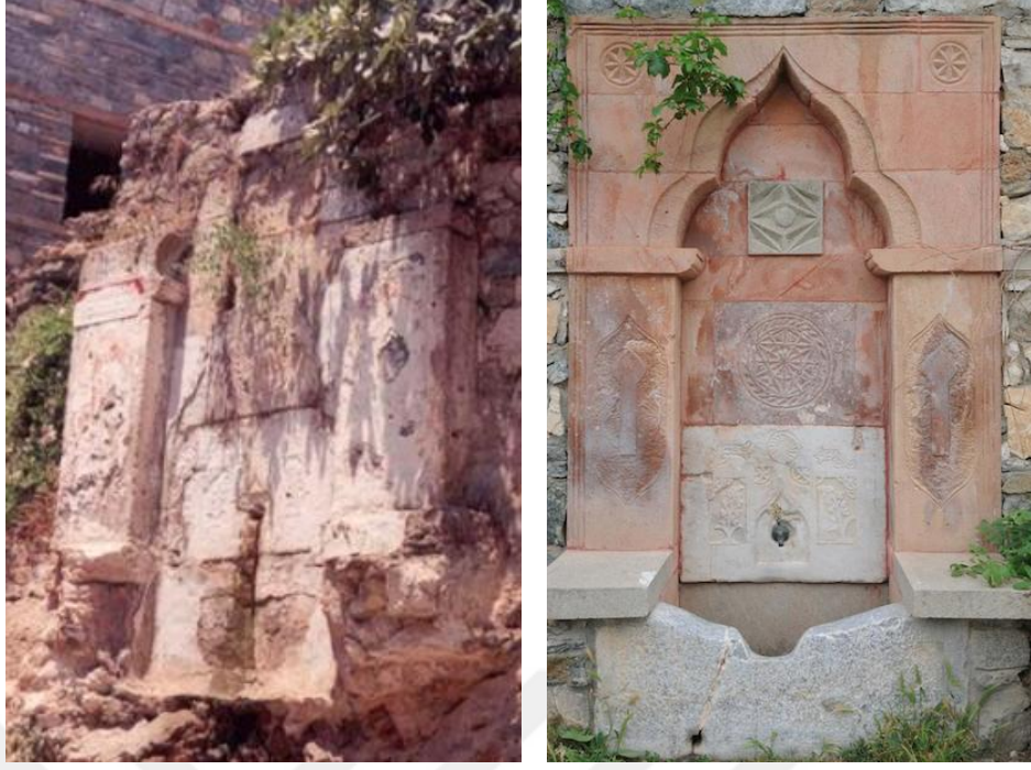
Resim B.16 Çeşmeli Konak – Restorasyon öncesi ve sonrası bahçe duvarında bulunan çeşme (Soldaki Fotoğraf Tufan Atalayman Fotoğraf Arşivi, Sağdaki Fotoğraf Nihan Polatdemir Fotoğraf Arşivi)
