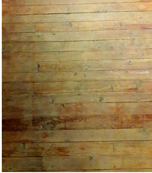
Resim 3.15 Hocasade Konağı – Katlarda ahşap zemin detayı (Nihan Polatdemir Fotoğraf Arşivinden)
