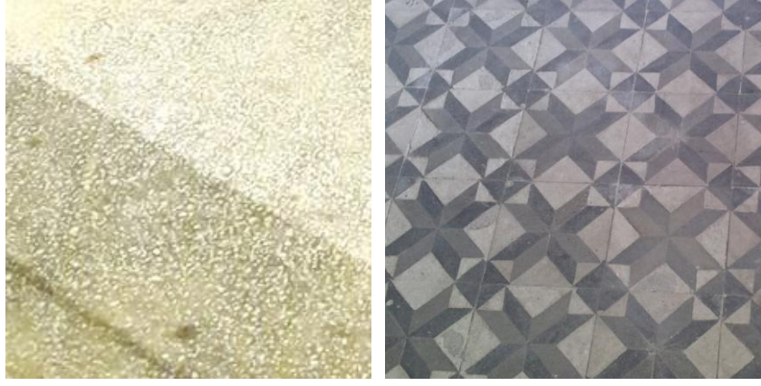
Resim 3.16 Hocasade Konađı – Bodrum kat dökme mozaik ve karo mozaik döşeme (Nihan Polatdemir Fotoğraf Arşivinden)
