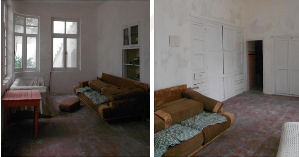
Resim D.8 Abdullah Erten Konağı – Bahçedeki taşlık bölümüne sonradan eklenen müştemilat (Nihan Polatdemir Fotoğraf Arşivinden)
