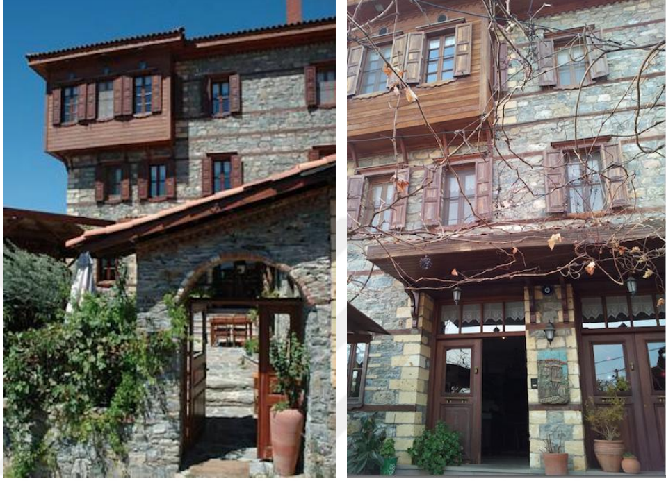
Resim B.4 Çeşmeli Konak – Restorasyon sonrası bahçe kapısı ve ana giriş kapıları (Nihan Polatdemir Fotoğraf Arşivinden)
