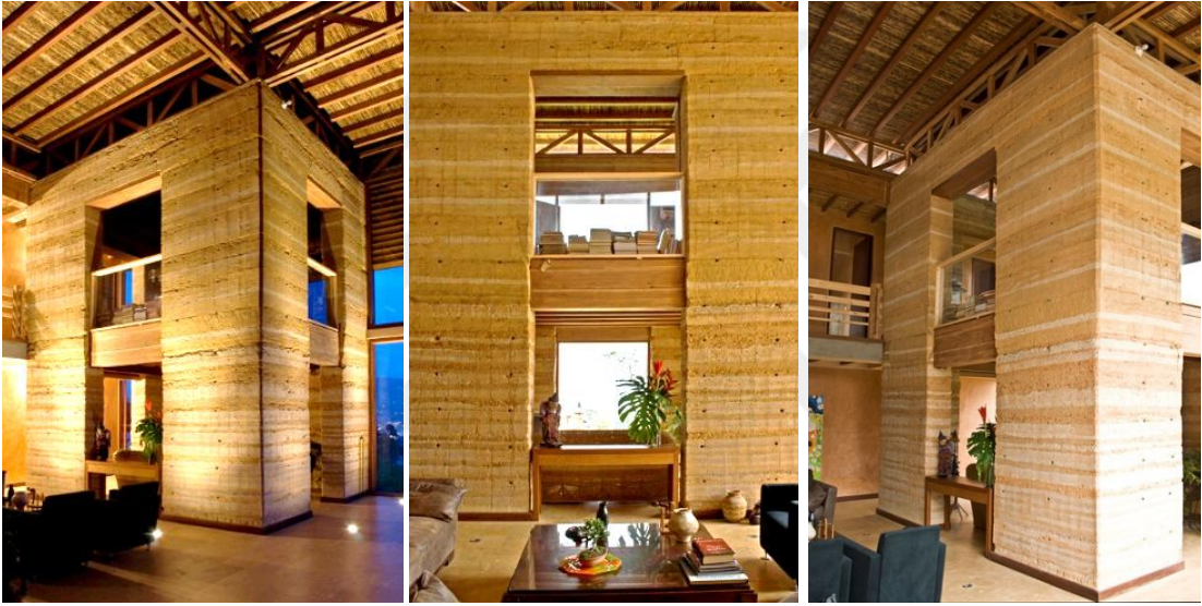
Resim 31. Kolombiya'da betonarme taşıyıcılı tapia pisada ile yapılmış konut (Fundación Tierra Viva, 2009)
