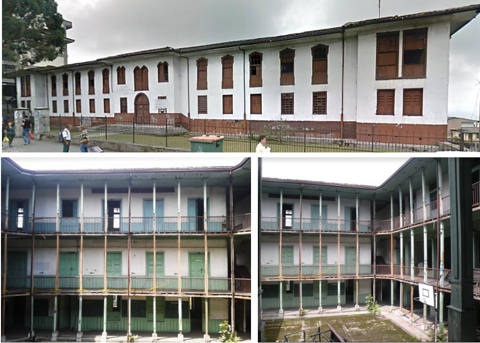
Resim 8. Kolombiya’da kerpiç dolgusuz toprak bahareque ile yapılmış okul (Google maps, 2017; Valencia, 2017)
