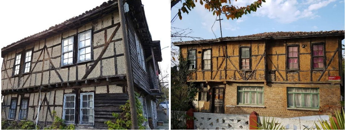
Resim 52. Şile, Akcakese köyünde hımış sistem ile yapılmış konut (Tokay, 2018)
