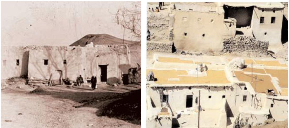
Resim 47. Anadolu'da yığma sistem ile yapılmış konutlar (Tuztaşı & Çobancaoğlu, 2006)
