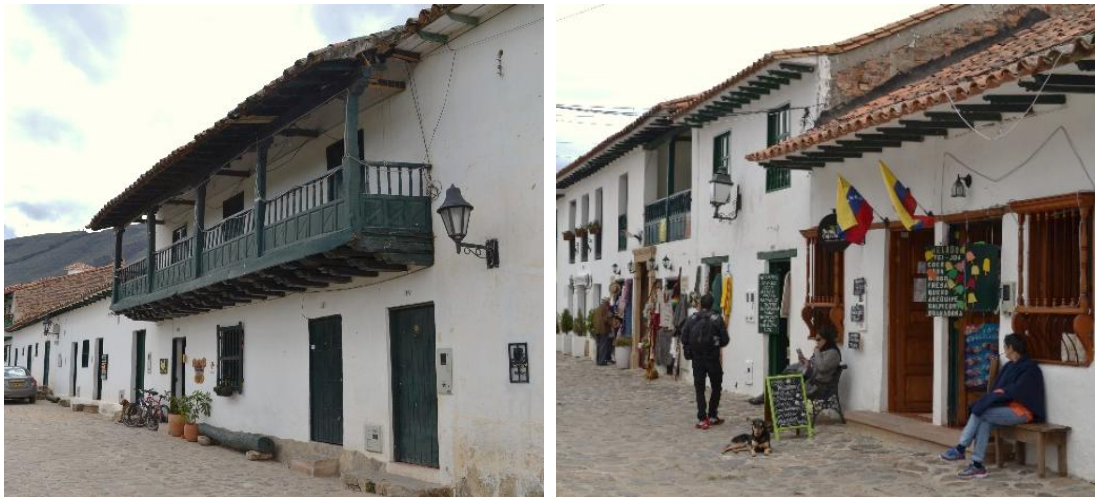
Resim 24. Kolombiya, Villa de Leyva'da kerpiç ile yapılmış konutlar (Leclercq, 2015)
