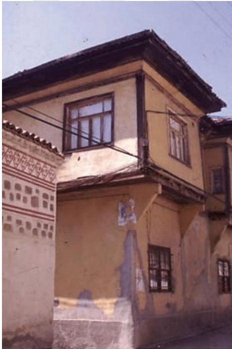
Şekil 137. Amasya'da hımsı sistem ile yapılmış konut (Çobancaoğlu, 1998)
