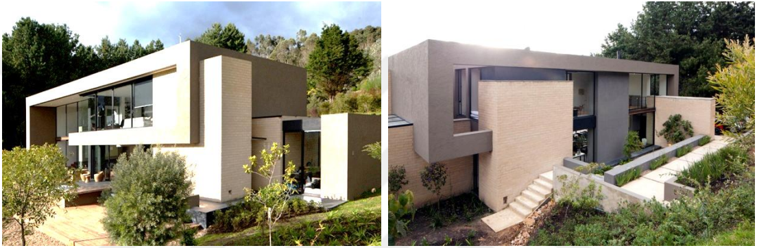
Resim 34. Kolombiya'da betonarme taşıyıcılı tapia pisada ve kerpiç ile yapılmış konut (Pérez, 2018)
