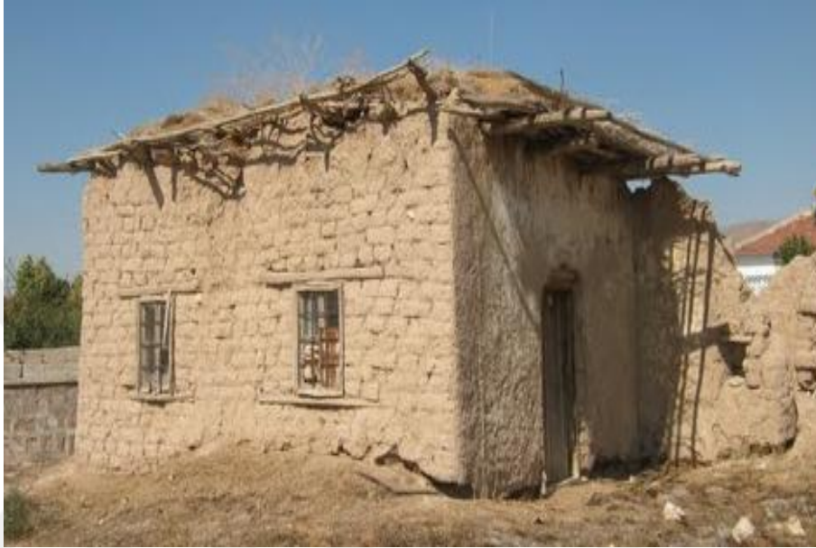
Resim 46. Anadolu'da yığma sistem ile yapılmış konutlar (Bakıtaş, 2011)
