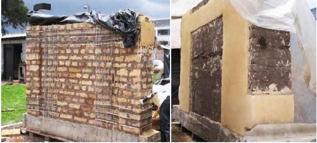
Resim 43. Çelik tel örgü ile güçlendirme (AIS, 2000)
