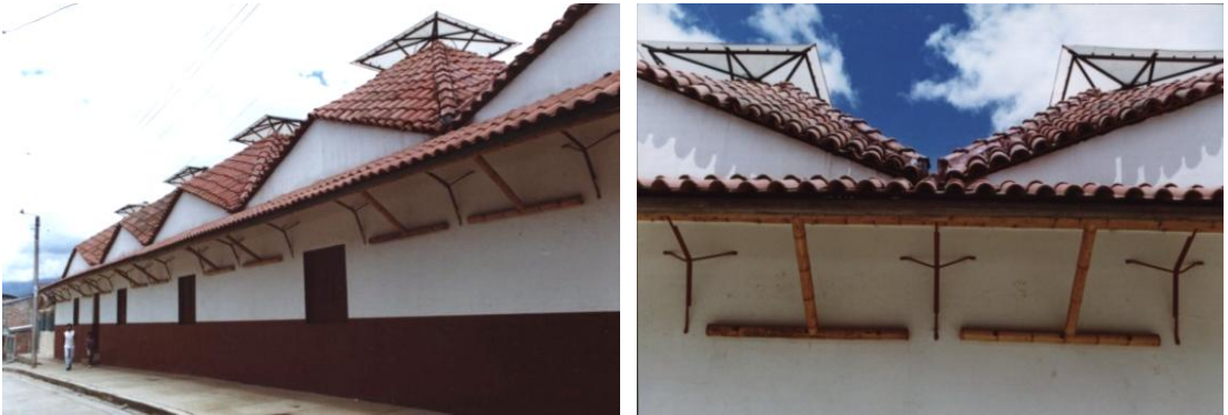
Resim 21. Kolombiya'da çağdaş çimento bahareque ile yapılmış bina ve saçaklı çatısı (Muñoz, 2002)
