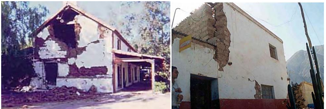
Resim 40. Depremden etkilenen toprak bahareque yapılar (AIS, 2000)
