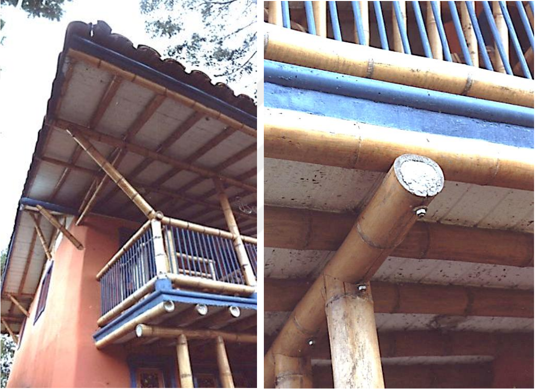
Resim 20. Kolombiya'da çağdaş çimento bahareque ile yapılmış konut, balkon ( solda ) ve çimento ile güçlendirilmiş çıkması ( sağda ) detaylar (Muñoz, 2002)
