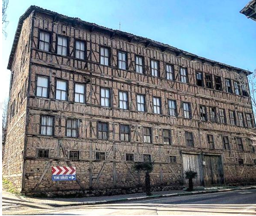
Resim 50. Bursa'da hımiş sistem ile yapılmış bina (Ekspermanzaralari, 2019)
