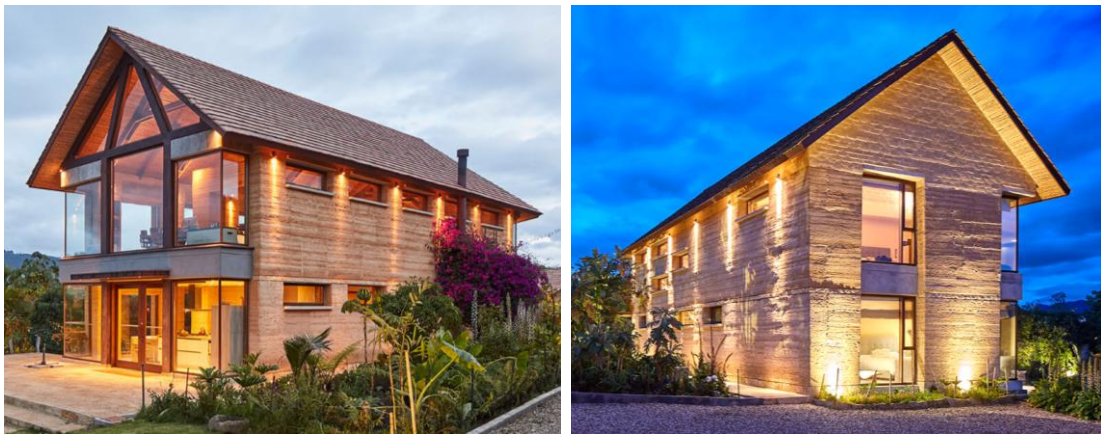
Resim 32. Kolombiya'da betonarme taşıyıcılı tapia pisada ile yapılmış konut (Valbuena, 2018)
