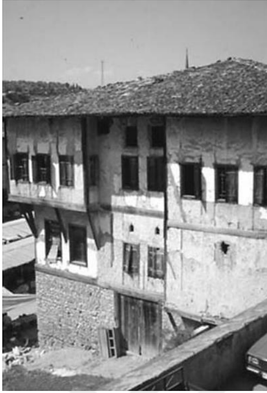
Şekil 136. Sivas'da hımsı sistem ile yapılmış konut (Çobancaoğlu, 1998)
