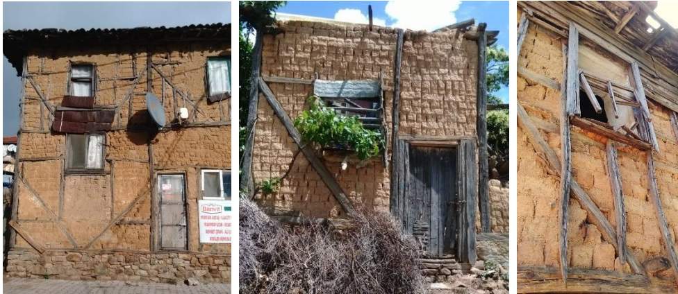
Resim 54. Erdek / Balıkesir, Yukarıyapıcı köyünde hımış kerpiç blok dolgulu sistem ile yapılmış bina (Tokay, 2016)
