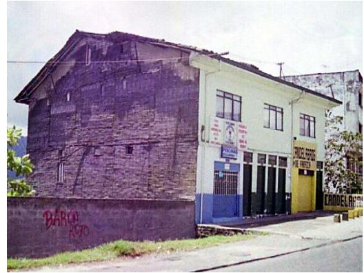
Resim 12. Kolombiya'da çimento bahareque ile yapılmış konut (Google maps, 2019; Galindo, 2011)
