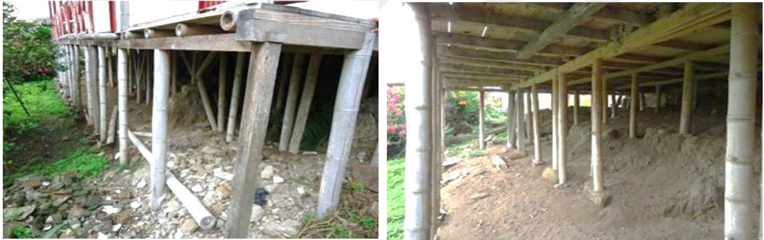
Resim 37. Çimento kirişi kullanılmadan bambu dikmeler ile yapılmış temel (Pineda Uribe, 2017)
