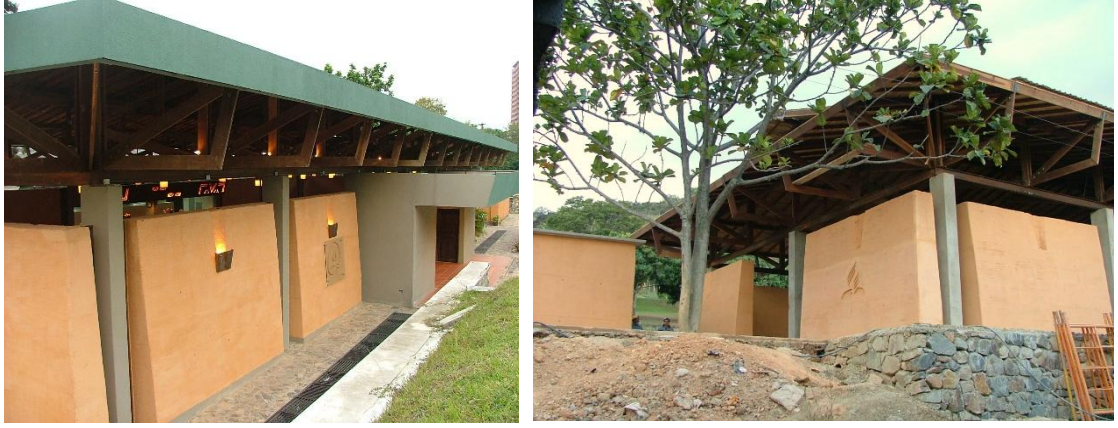
Resim 33. Kolombiya'da betonarme taşıyıcılı tapia pisada ile yapılmış okul (Fundación Tierra Viva, 2009; 2017)
