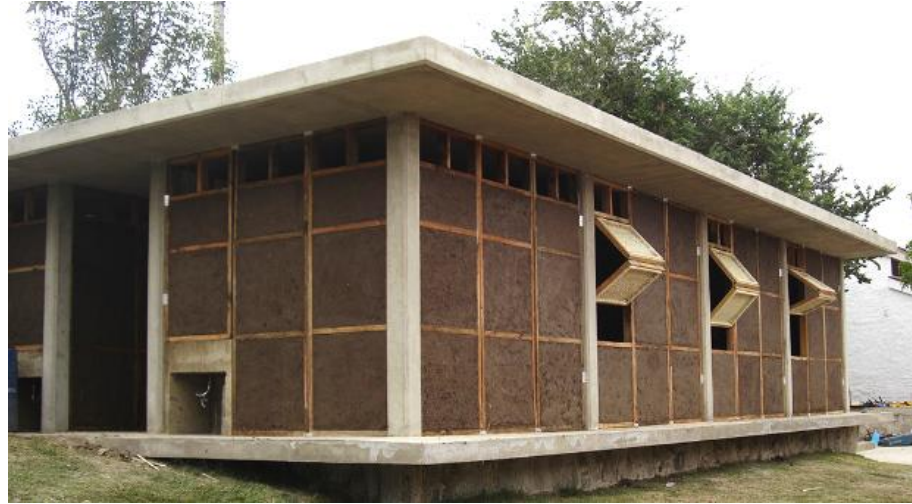
Resim 5. Betonarme taşıyıcılı bahareque ile yapılmış konut (Bravo, Hernández & Martínez, 2015)
