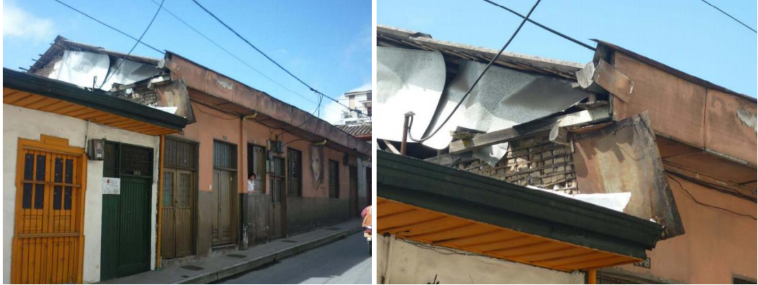
Resim 6. Kâgir cephe ve bahareque ile yapılmış konut (Galindo, 2011)
