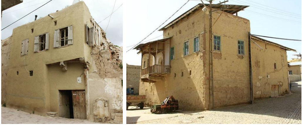
Resim 49. Malatya, Darende'de karma sistem ile yapılmış konut (Bahçeci, 2017)
