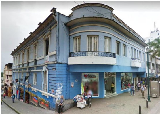
Resim 12. Kolombiya'da çimento bahareque ile yapılmış konut (Google maps, 2019; Galindo, 2011)
