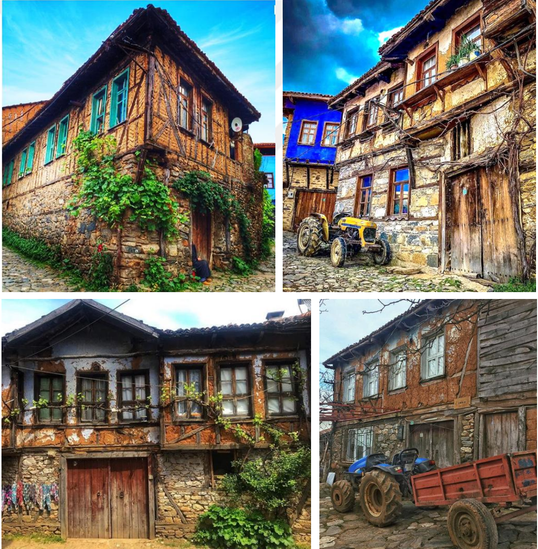
Resim 51. Bursa, Cumalıkzık'ta hımış taş ve kerpiç blok dolgulu ile yapılmış konutlar (Ticmglobal, Byrabiakaya, Enesdunya, Vildanin, 2019)
