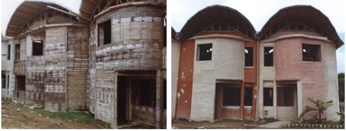
Resim 19. Kolombiya'da sıvadan önce ( solda ) ve sıvalı ( sağda ) çağdaş toprak bahareque ile yapılmış konut (Muñoz, 2002)
