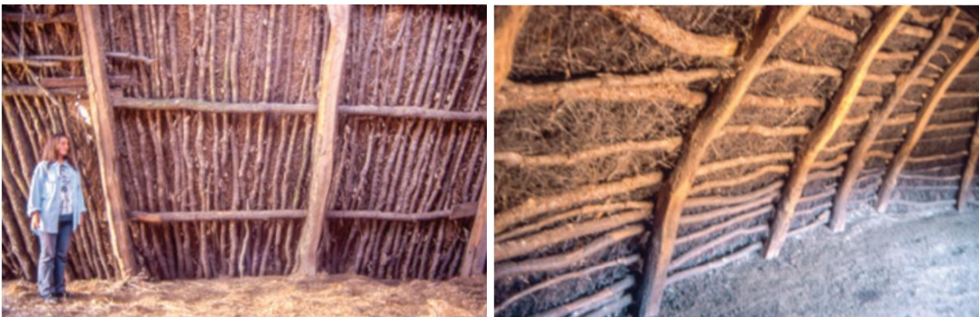
Resim 56. “V” kesitli samanlık duvarı ( solda ) “U” kesitli samanlık duvarı ( sağda ) (Eres, 2013)
