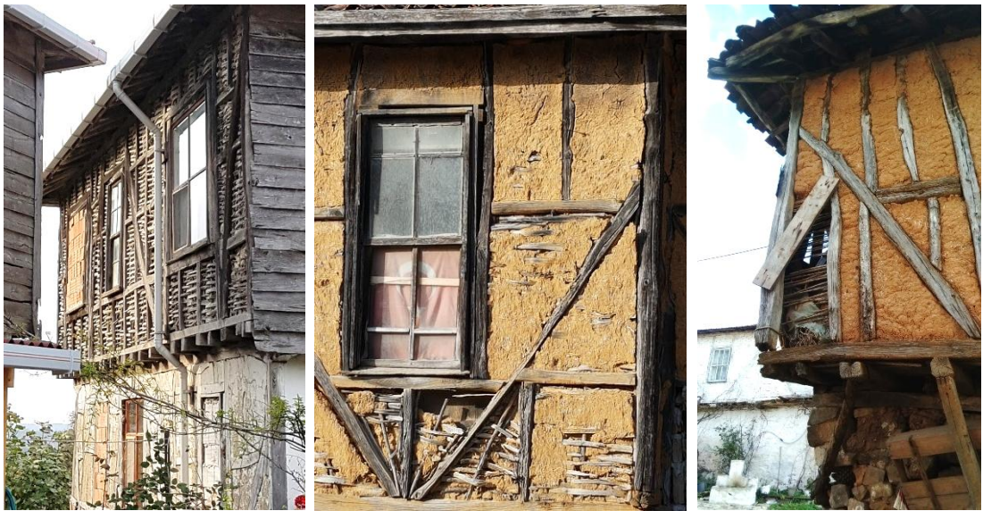
Resim 53. Şile’de, hımiş sisteminde yapılmış ahşap iskelet örnekleri (Tokay, 2016)
