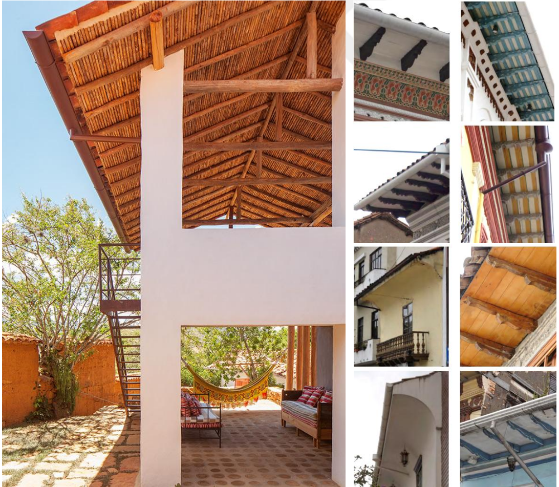
Resim 28. Tapia pisada ve kerpiç konutlardan çatı ( solda ) (Pérez, 2017) ve saçak örnekleri ( sağda ) (Rakotomamonjy, 2015)
