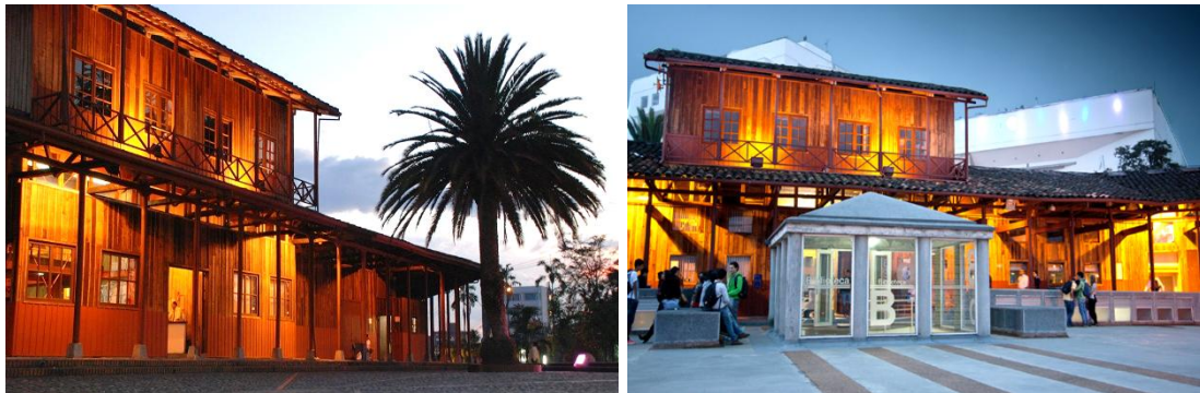
Resim 10. Kolombiya'da ahşap bahareque ile yapılmış eski teleferik istasyonu (RCN Radio, 2017; The Colombian Way, 2013)
