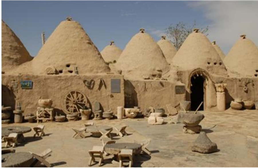
Resim 45. Şanlıurfa, Harran ilçesinde masif kerpiç sistem ile yapılmış konutlar ( http://urfahaber24.com , 2012)
