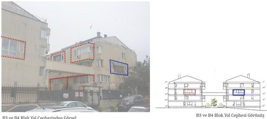
B3 ve B4 Blok Yol Cephesinden Görşel
