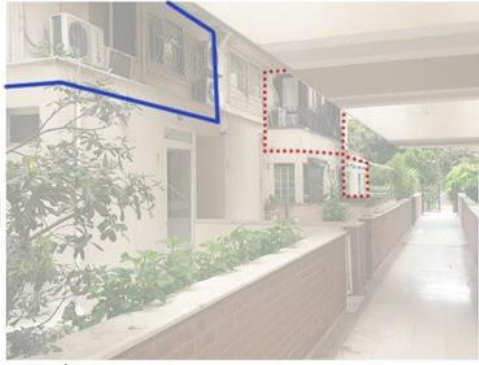
C1 Blok İç Bahçe Cephesi
