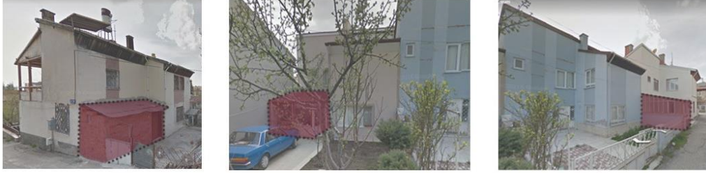
Şekil 4.138 Çorum Binevler Konut Sitesi, T Tipolojisinde Konut Birimine Eklenen Depo Birimine Dair Örnekler
