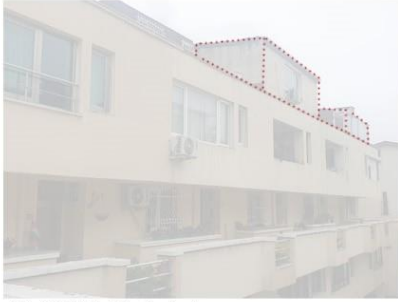
B3-B4 Blok İç Avlu Cephesi
