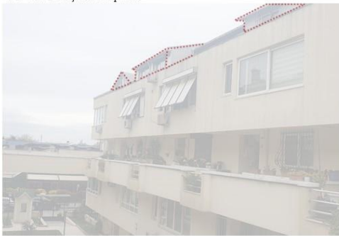
B3-B4 Blok İç Avlu Cephesi
