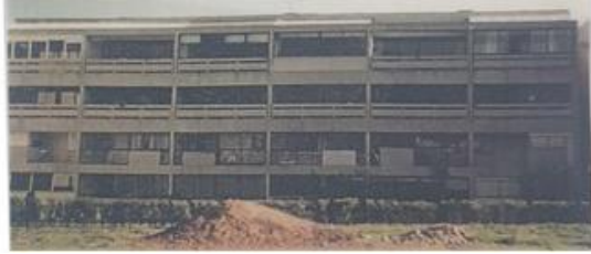
Şekil 4.67 Yeşilköy Toplu Konut Sitesi, Yapım Aşamasına Ait Fotoğraf
