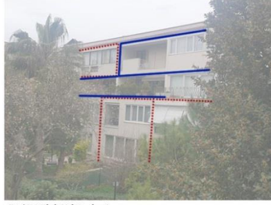
B1/ B2 Blok Yol Cephesi
