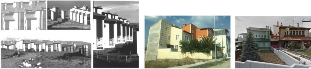
Şekil 4.147 Çorum Binevler Konut Sitesi, Yapım Aşamasından Sonra Çekilen Fotoğraflar
