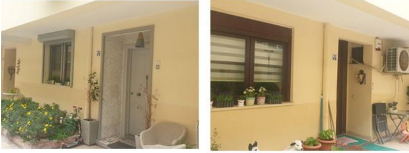
Şekil 4.89 Yeşilköy Toplu Konut Sitesi, B3 Blokta Yan Yana Bulunan İki Dairenin Giriş Bölümünün Farklı Kurguları ( Fotoğraflar: Melike Yenice)
