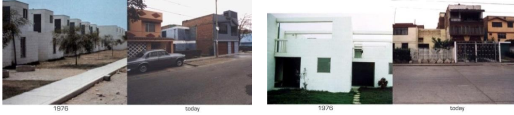
Şekil 3.60 Previ 1976 yılı ve günümüze ait cephe görselleri-2
