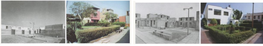
Şekil 3.59 Previ 1976 yılı ve günümüze ait cephe görselleri-1
