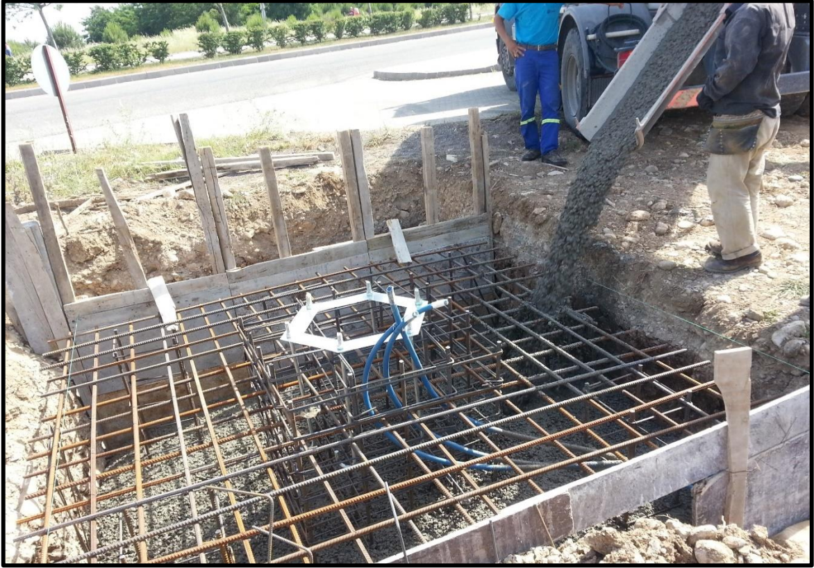
Şekil 4-50. Güneş takip sistemi temel çalışmaları
