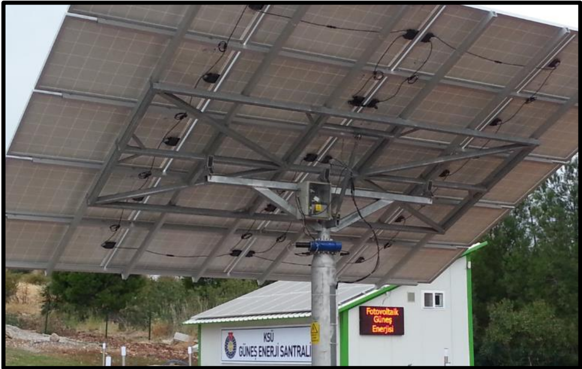
Şekil 4-47. Güneş takip sistemi mekanizması
