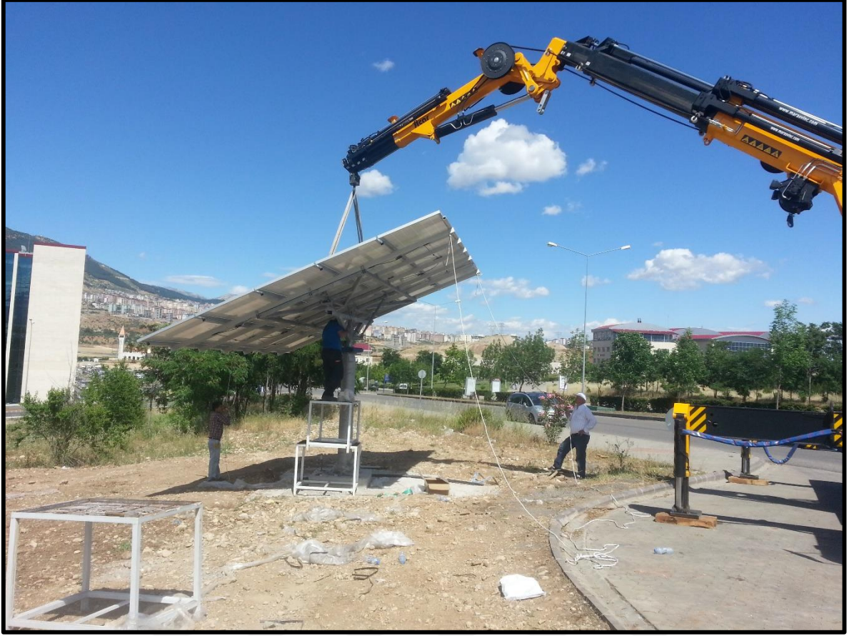
Şekil 4-51. Güneş takip sistemi montajı
