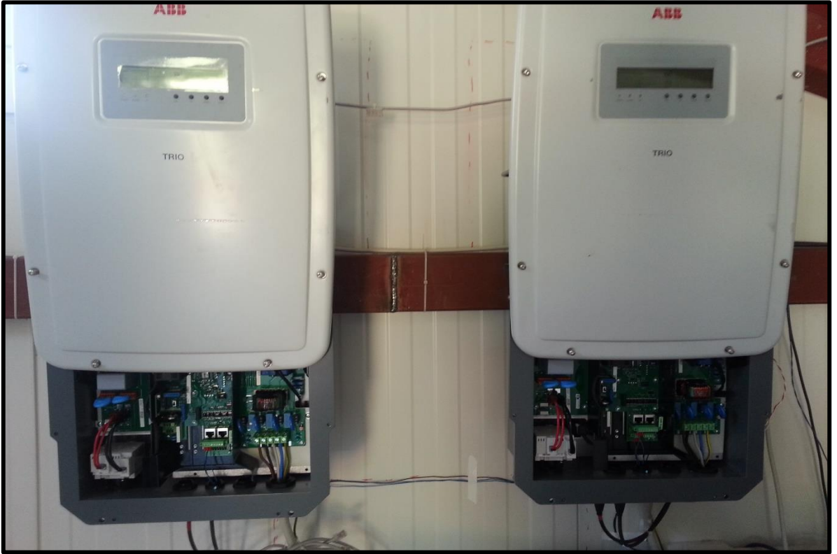
Şekil 4-54. İnvörtör montajı
