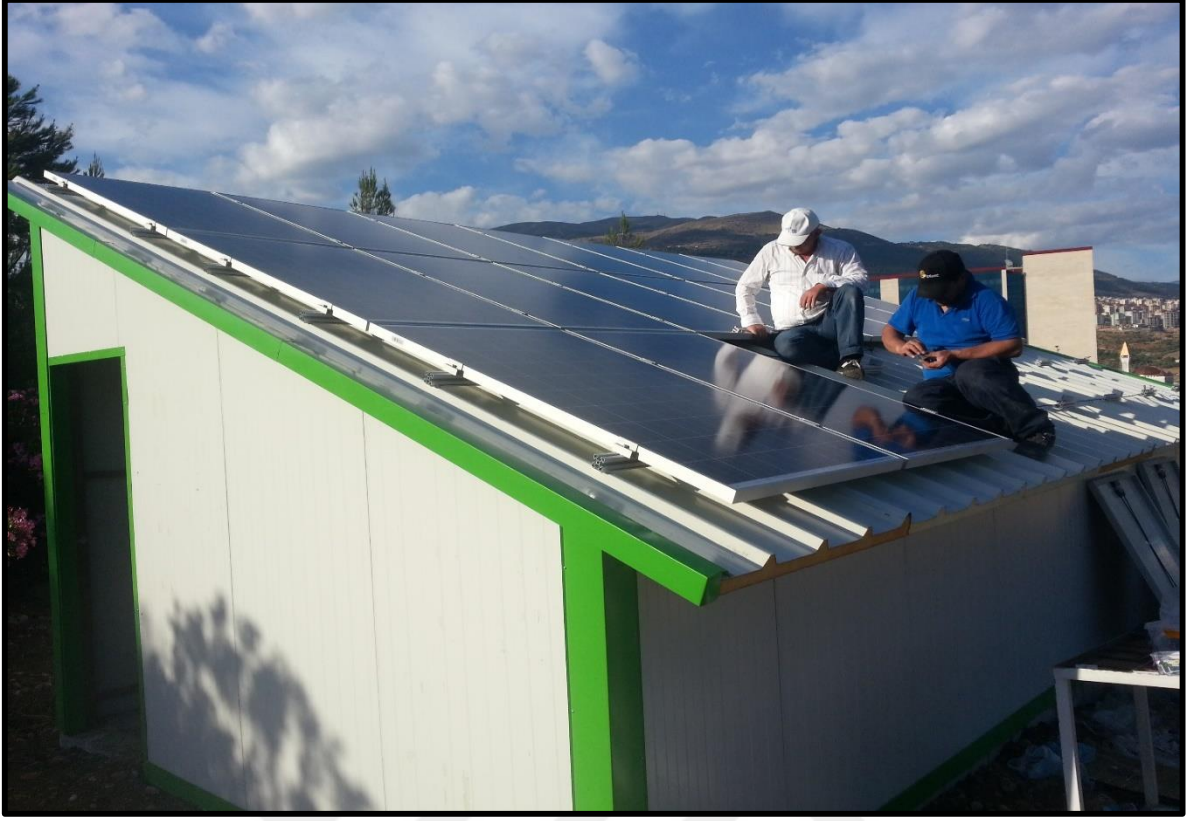
Şekil 4-53. Sabit çatı sistemi panel montajı
