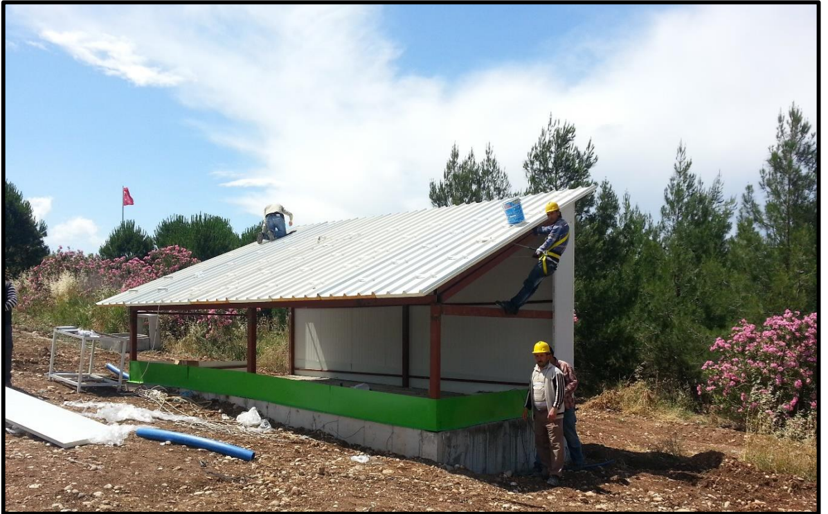
Şekil 4-52. Sabit çatı sistemi bina inşaatı
