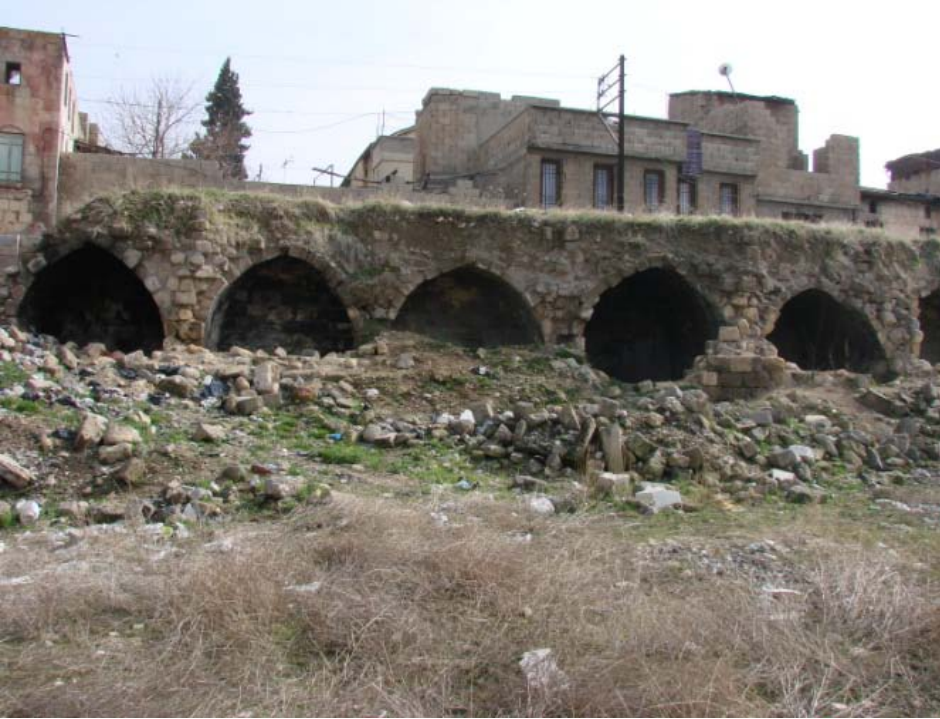
Şekil 4.10 Avlu Doğu Cephesi Görünüşü
