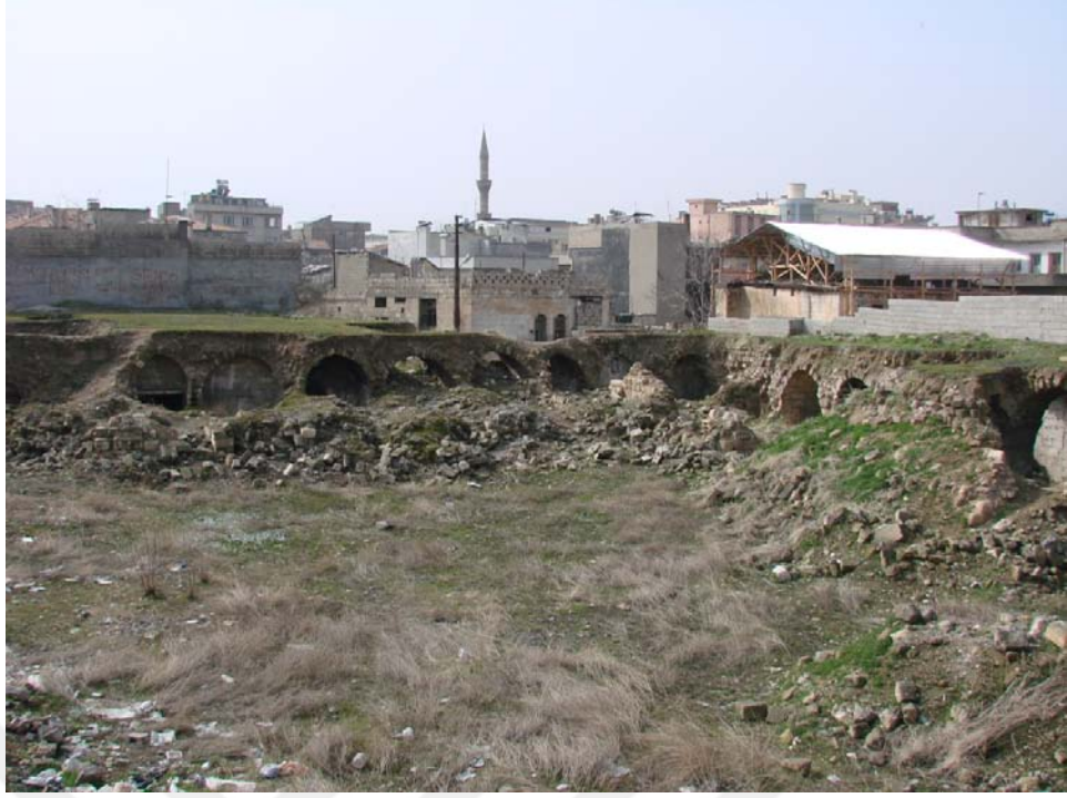
Şekil 4.11 Avlu Güney Cephesi Görünüşü
