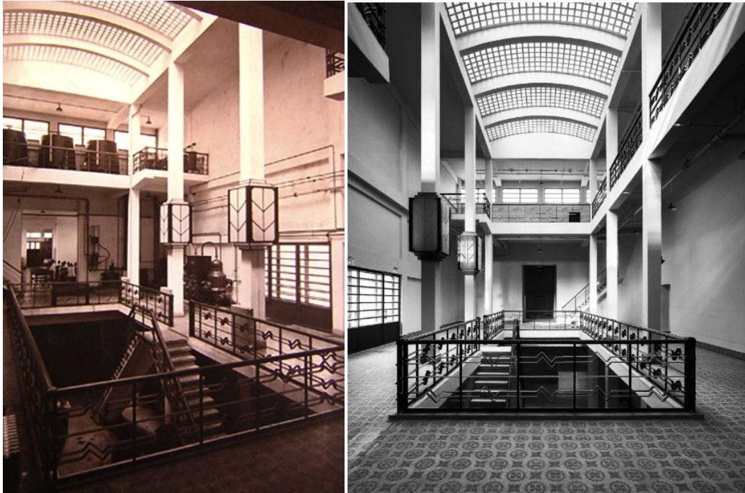
Şekil 2.2 Mecidiyeköy Likör Fabrikası Restorasyon Çalışmaları Öncesi (Url-7)
