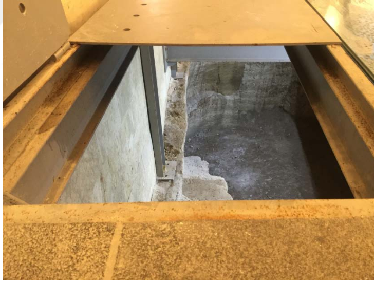
Şekil 4.34 Döşeme Kotunun Altında Ambar Görünüşü
