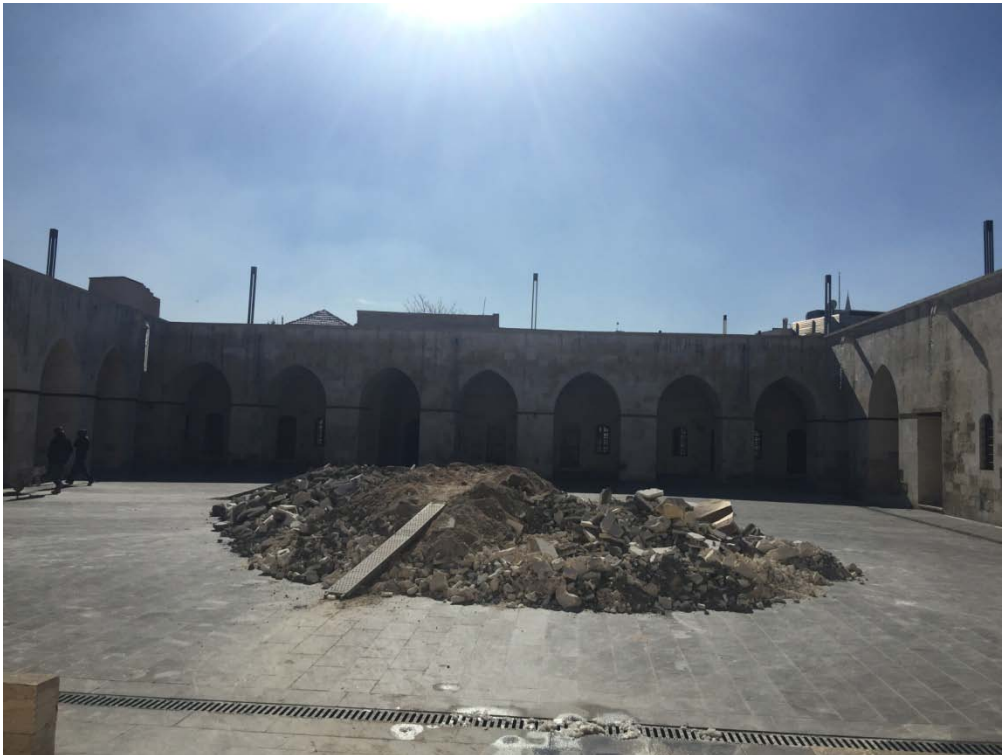
Şekil 4.32 Restorasyon Sonrası Hışvahan Avlu Görünüşleri
