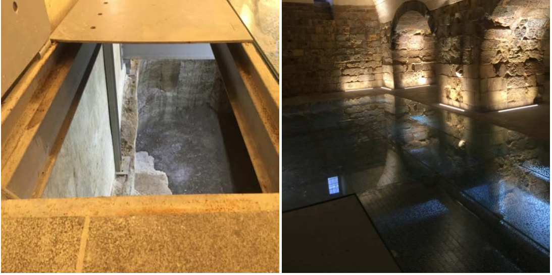
Şekil 4.76 Döşeme Kotunun Altında Ambar Görünüşü
