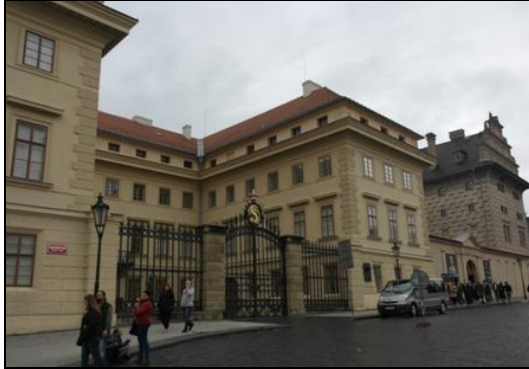
Şekil 4.51: Salmovský Sarayı binası görünüşü SA)
