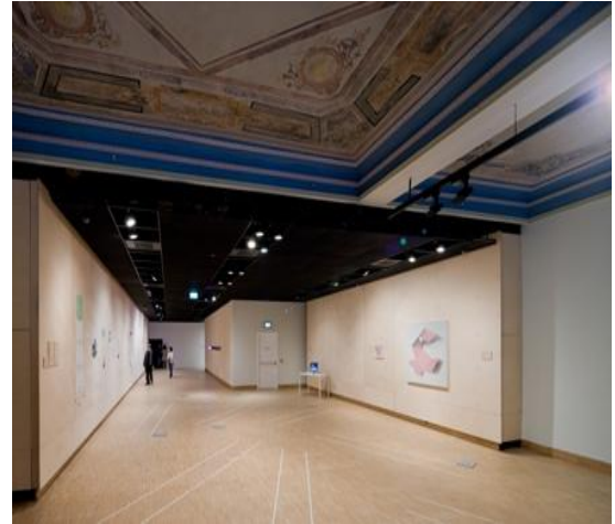
Şekil 3.52: Salt Beyoğlu binası korunmuş tavan süslemesi(IB)
