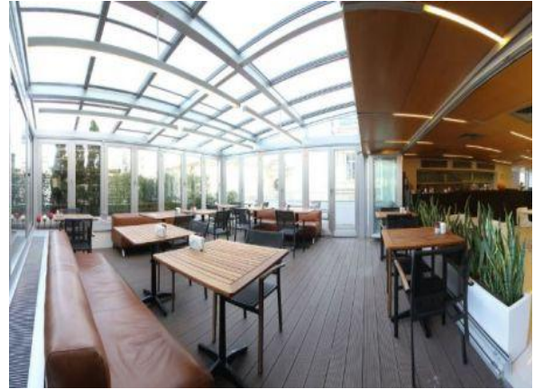
Şekil 3.57: Akbank Sanat çatı katı ahşap deck parke(SA)
