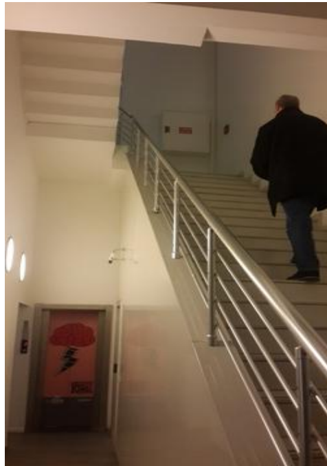
Şekil 3.32: Akbank Sanat merdiven kovası(SA)
