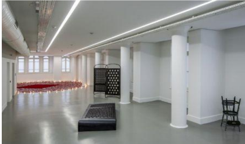
Şekil 3.63: Arter (epoksi yer döşemesi)(SA)
