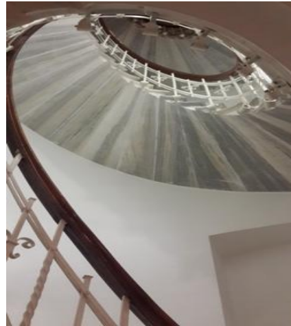
Şekil 2.22: Arter binası korunmuş merdiven kovası(SA)
