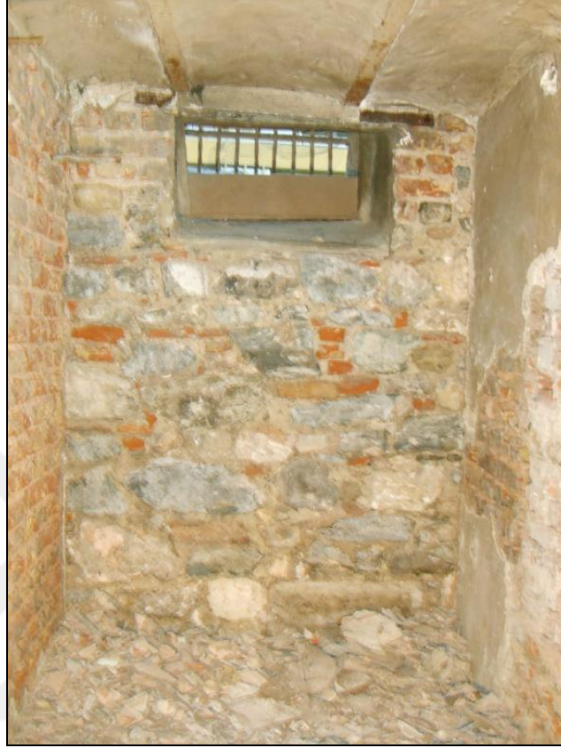
Şekil 2.4: Nejat Eczacıbaşı Binası yeniden işlevlendirilirken, volta döşeme (BS)
