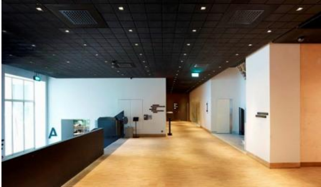
Şekil 3.74: Salt Beyoğlu siyah metal asma tavana gömülü fancoil sistemi ve menfez kapakları(CE)
