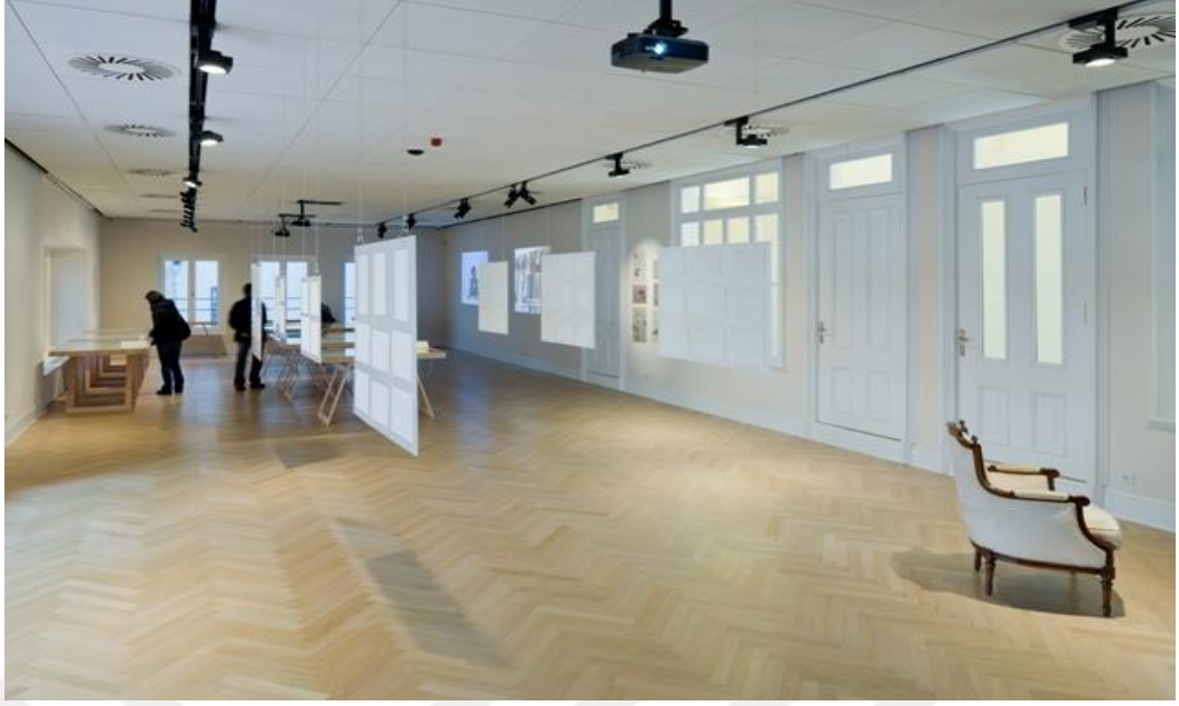
Şekil 3.75: Salt Galata alçıpan asma tavana gömülü fancoil sistemi ve paslanmaz menfez kapakları(İB)
