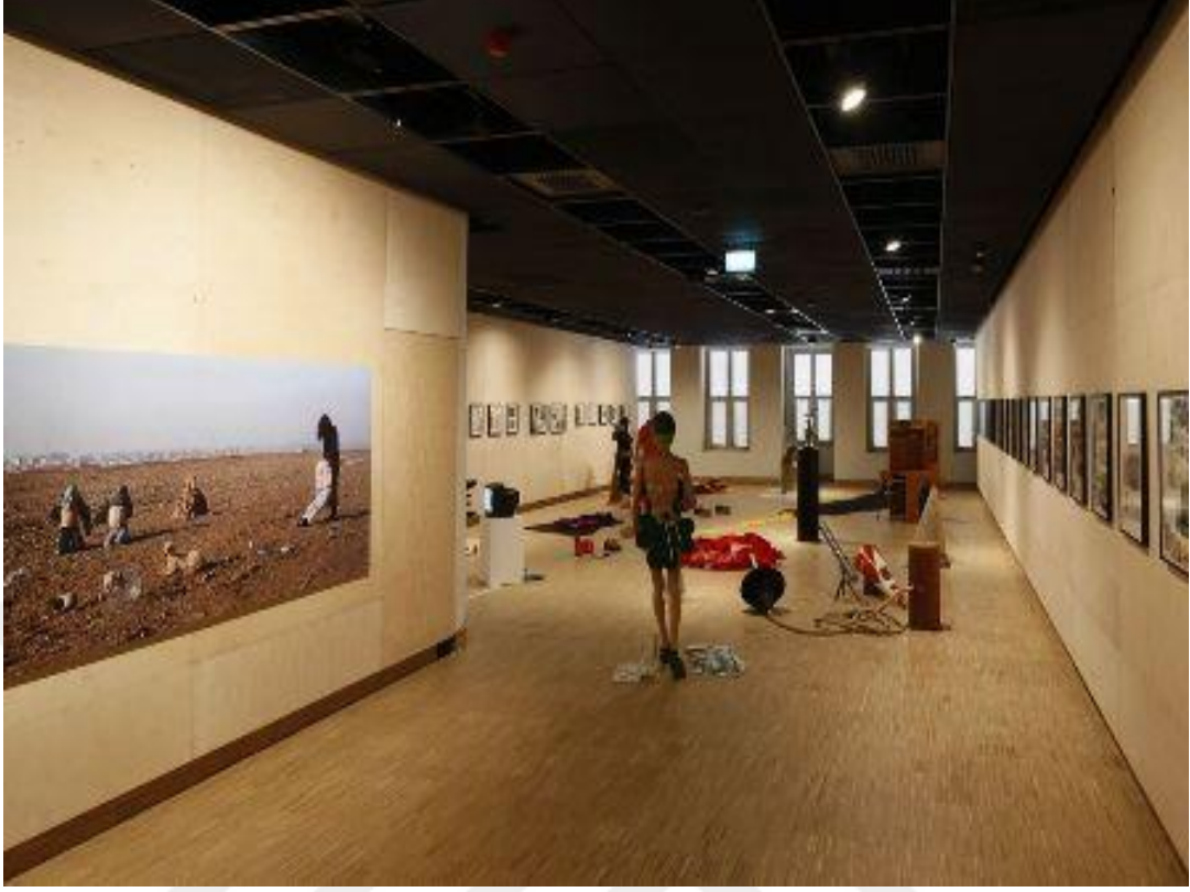
Şekil 3.42: Salt Beyoğlu Sergi Salonunda fin su kontrastı bölücü panolar ana bina çerperinden arkasında tesisat koridoru bırakacak şekilde ( 90 cm) önde oluşturulmuştur(IB)
