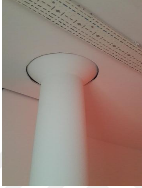
Şekil 3.86: Arter binası taşıyıcı çelik kolonları (SA)
