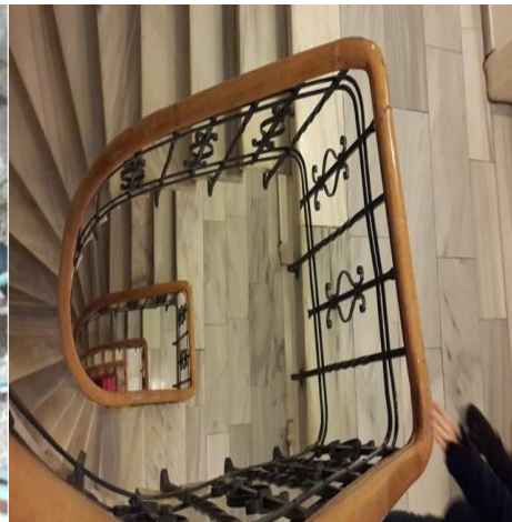
Şekil 3.82: Yenilenmiş Merdiven kovası Marmara mermeri merdiven basmağı, ferforje korkuluk ve masif meşe küpeşte (SA)
