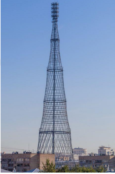
Şekil 4.1 : Shukhov Kulesi (görünüş).
