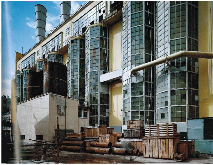
Şekil 4.26 : Moskova Enerji Santrali Kazan Binası.
